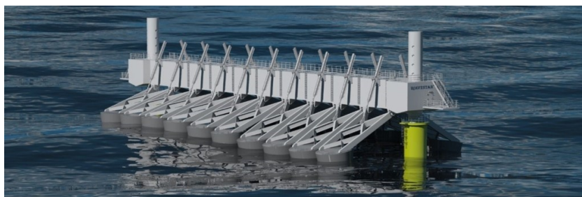
Figura 2.4 – WEC do tipo absorvedor pontual (Wave Star). Adaptado de [32].
