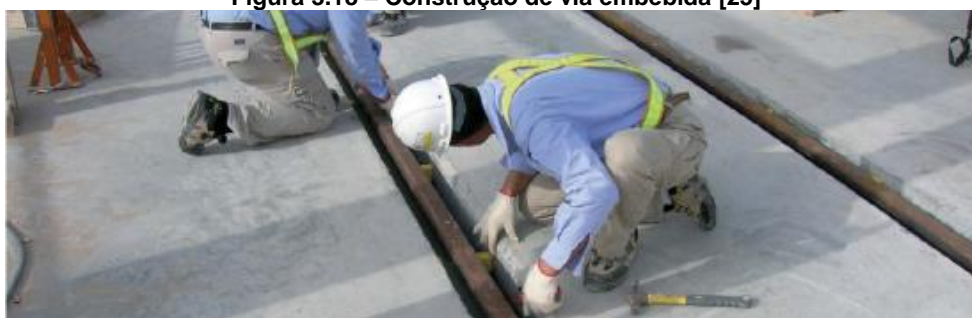
Figura 3.19 – Colocação do carril em via embebida [15]
