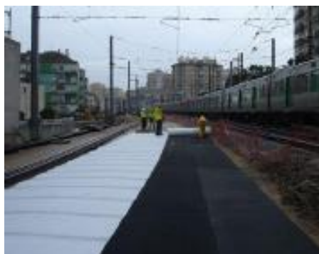
Figura 6.10 – Colocação de uma manta de balastro em via balastrada [6]
