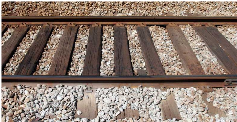
Figura 3.7 – Travessas de madeira [11]
