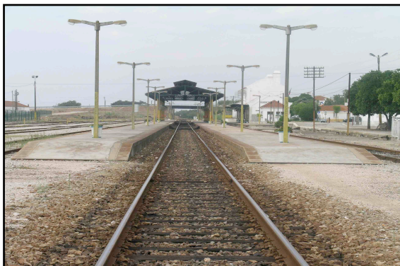
Figura 3.29 - Plataformas de Passageiros e Coberturas
