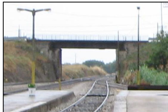
Figura 3.30 - Passagem Superior Rodoviária
