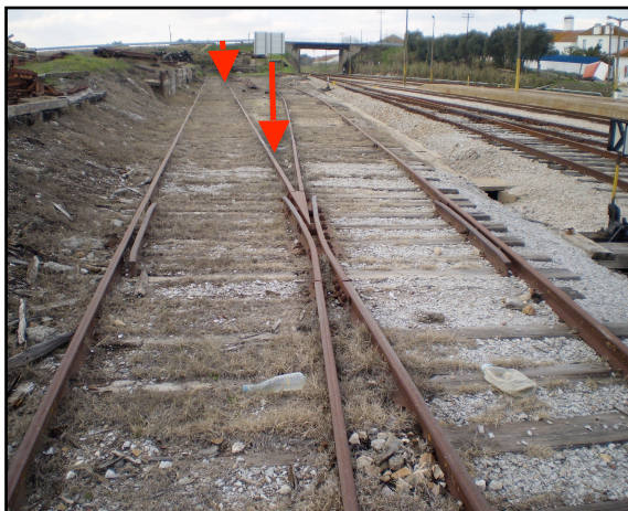
Figura 3.22 - Localização dos ensaios PDL e das trincheiras 1 e 2
