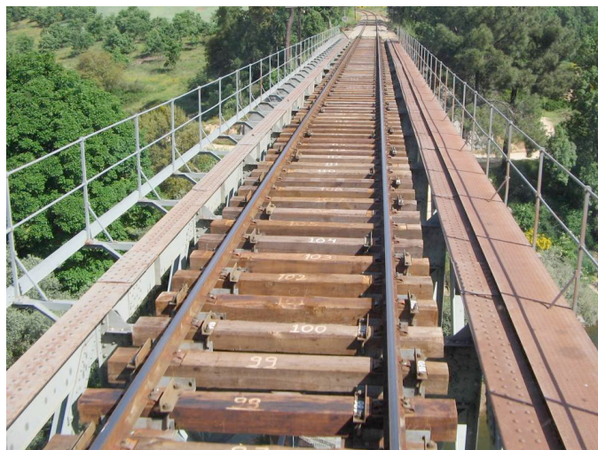
Figura 2.15 - Travessas de Madeira em ponte metálica [Martins, 2009]
