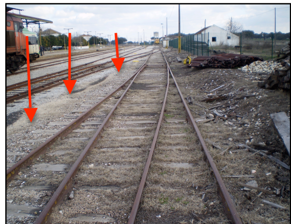
Figura 3.23 - Localização dos ensaios PDL e das trincheiras 3, 4 e 5
