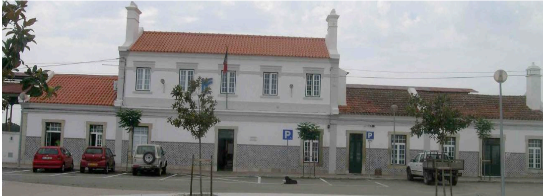
Figura 3.12 - Edifício de Passageiros e Largo da Estação de Casa Branca
