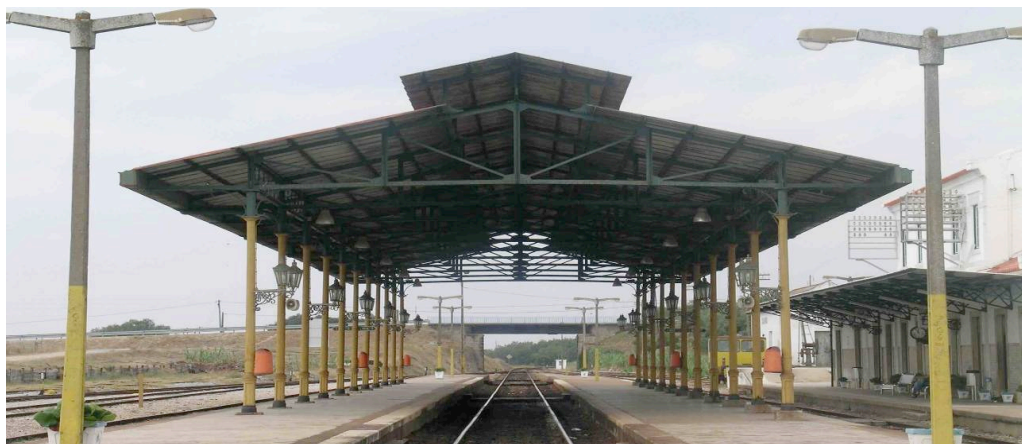
Figura 3.13 - Coberturas das Plataformas de Passageiros da Estação de Casa Branca
