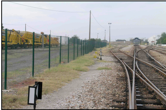
Figura 3.27 - Vedação da infra-estrutura
