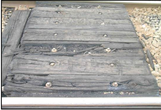
Figura 3.4 - Passagem de peões danificada
