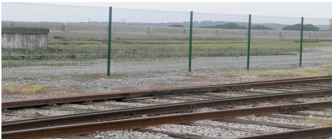
Figura 3.14 - Vedação na Estação de Casa Branca
