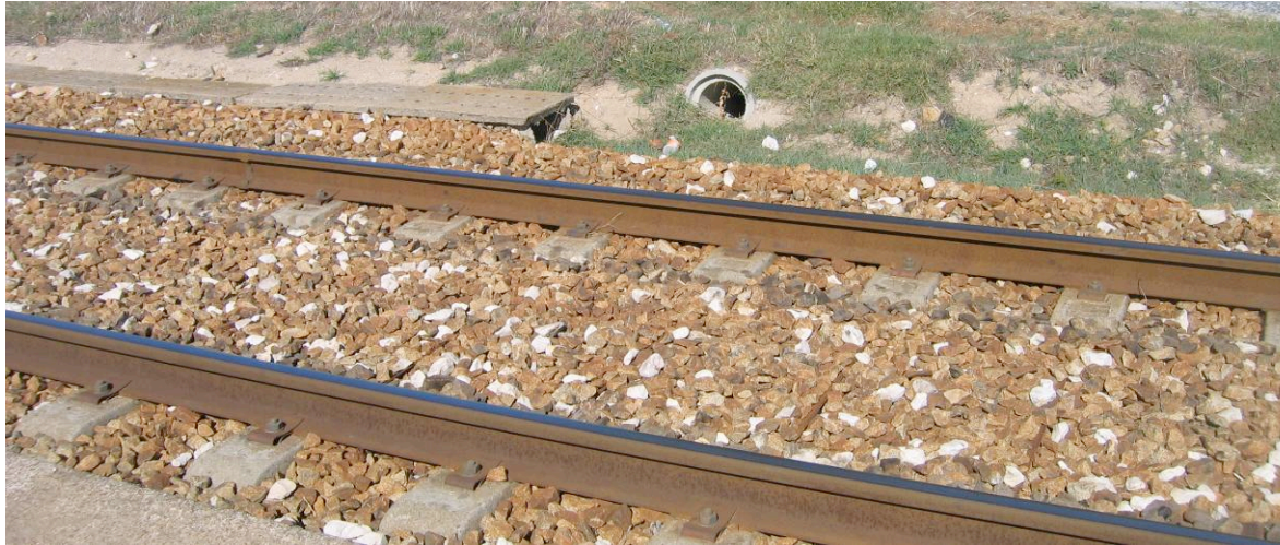
Figura 2.17 - Via com Travessas Bi-bloco de betão [Martins, 2009]
