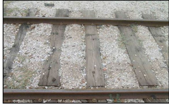
Figura 3.5 - Travessas de madeira
