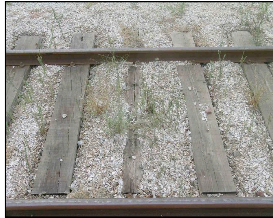
Figura 3.11 - Travessas encastradas no solo
