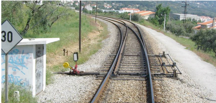
Figura 2.18 - Aparelho de Mudança de Via [Martins, 2009]
