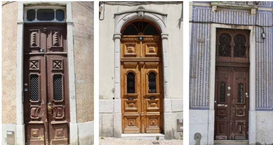
Figura 3.14 - Portas características dos edifícios "Gaioleiros"
