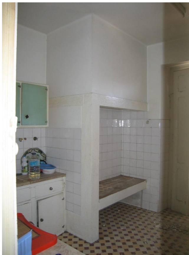
Figura 5.15 - Chaminé de uma das cozinhas (Fonte: Atelier Appleton & Domingos)
