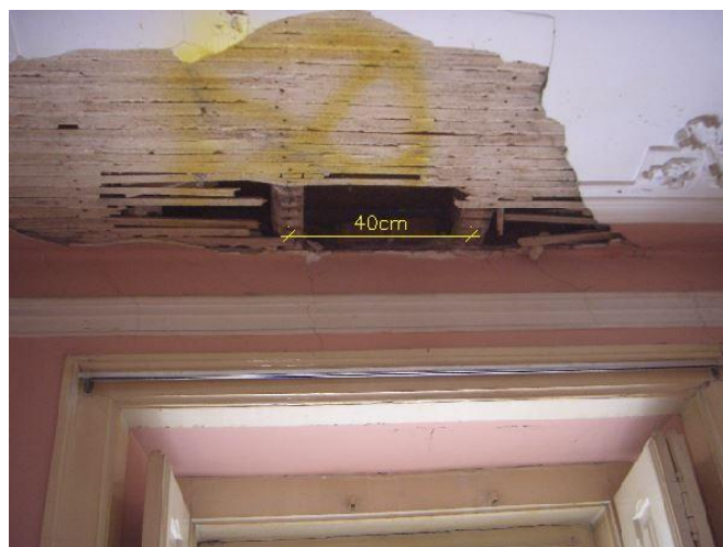
Figura 5.11 - Espaço entre vigas de um dos pavimentos (fonte: Fonte: Atelier Appleton & Domingos)
