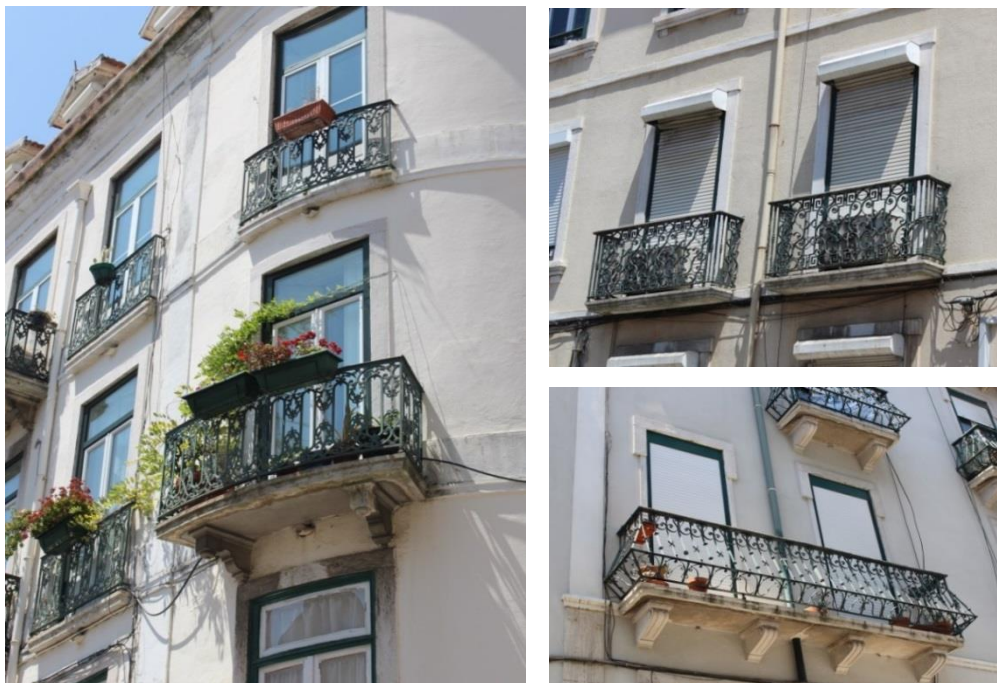
Figura 3.13 – Varandas dos edifícios “Gaioleiros”
