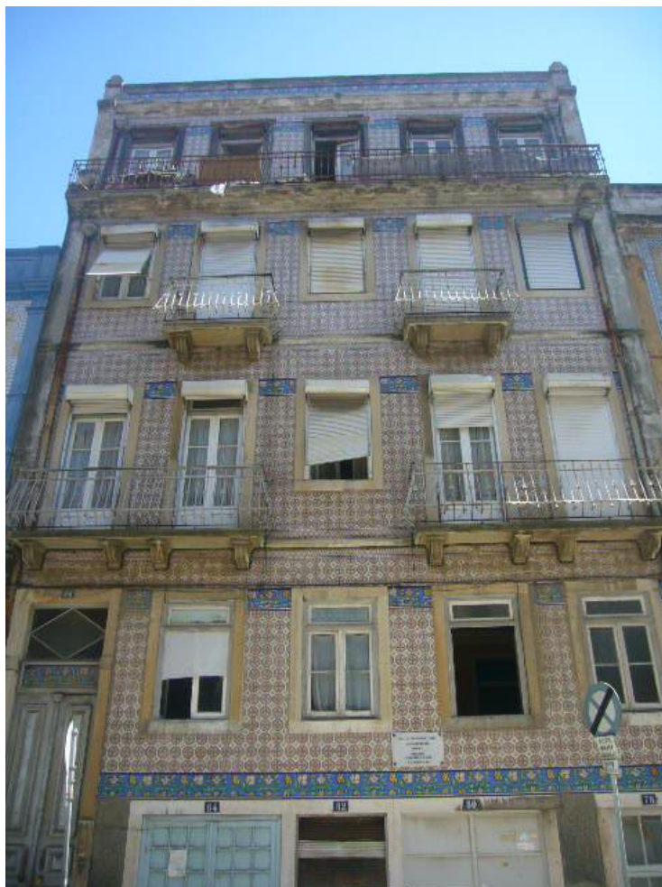
Figura 5.3 – Fachada principal do edifício em estudo (Fonte: Atelier Appleton & Domingos)
