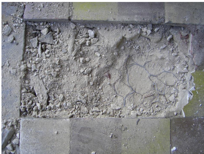
Figura 5.12 - Revestimento do pavimento de uma das cozinhas do edifício (Fonte: Atelier Appleton & Domingos)
