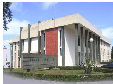
Oliveira de Frades (Viseu / Coimbra) Arq. Maria Otilia dos Santos Inaugurado em 1987 Cobertura inclinada
