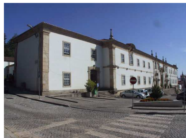
Gouveia (Seia / Coimbra) Edifício adaptado
