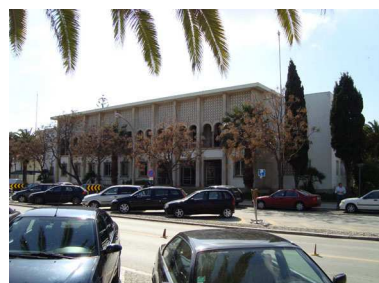
Lagos (Portimão / Évora) Arq. Luís Amoroso Lopes Inaugurado em 10/05/1969 Cobertura plana
