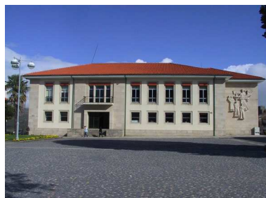
Montalegre (Chaves / Porto) Arq. Raul Rodrigues Lima Inaugurado em 17/05/1970 Cobertura inclinada
