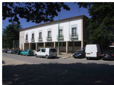
Miranda do Douro (Bragança / Porto) Arq. Leonardo de Castro Freire Inaugurado em 07/03/1966 Cobertura inclinada
