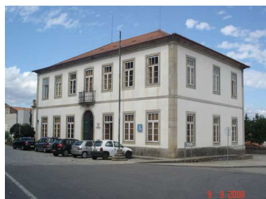
Mondim de Basto (Vila Real / Porto) Edifício adaptado
