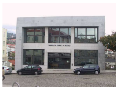
Melgaço (Viana do Castelo / Porto) Arq. Cristina Santos Inaugurado em 28/06/2002 Cobertura plana
