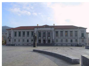
Guimarães (Guimarães / Porto) Arq. Luís Benavente Inaugurado em 24/06/1960 Cobertura inclinada
