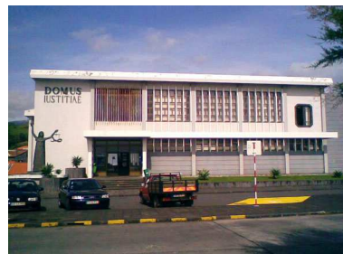
Horta (Angra do Heroísmo / Lisboa) Arq. Jorge de Albuquerque Inaugurado em 21/01/1990 Cobertura inclinada
