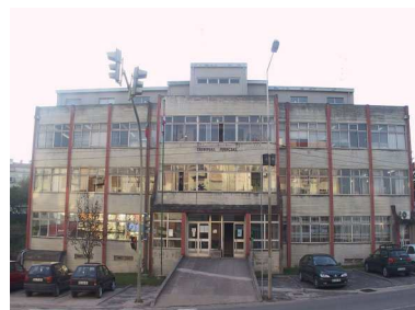
Oliveira do Bairro (Anadia / Coimbra) Edifício adaptado
