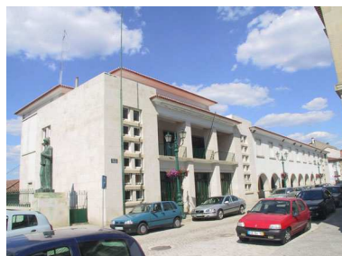
Mirandela (Mirandela / Porto) Arq. Carlos Chambers Ramos Inaugurado em 08/03/1964 Cobertura inclinada
