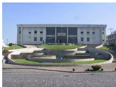
Paredes (Paredes / Porto) Arq. Januário Godinho de Almeida Inaugurado em 11/11/1986 Cobertura plana
