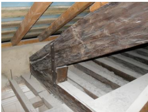
Figura 12: Assentamento de asna em parede (edifício da rua Duques de Bragança, Lisboa, 2009)
