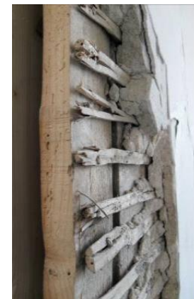
Figura 08: Corte de tábua costaneira, fasquias em arco de castanho e argamassa de envolvimento
