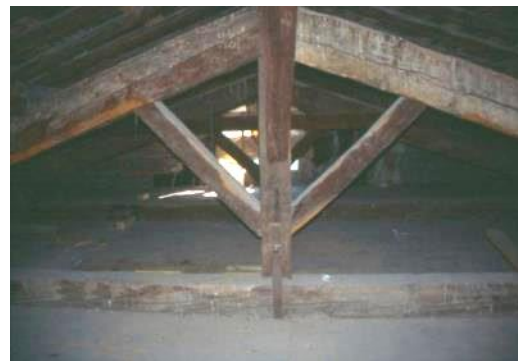
Figura 13: Parte central: pendural, linha, pernas e escoras (edifício em Mafra, 2008)
