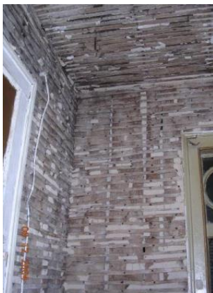
Figura 06: Fasquiado em paredes e tetos (edifício da travessa dos Mestros, Lisboa, 2004)
