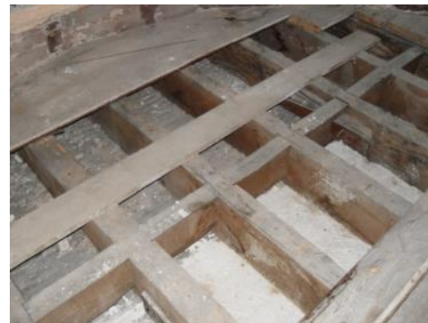
Figura 10: Estrutura de pavimento, após ter sido retirado o soalho (palacete Ribeiro da Cunha, Lisboa, 2010)
