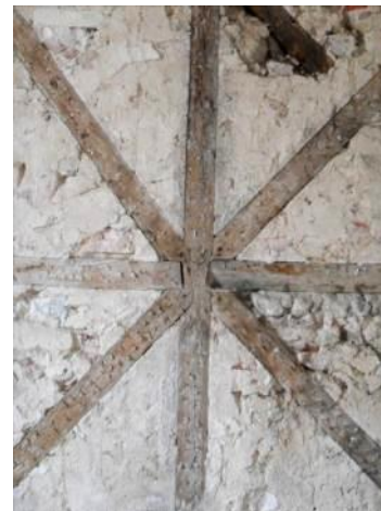
Figura 03: Pormenor de madeiramentos lascados em frontal (edifício da rua Duques de Bragança, Lisboa, 2009)
