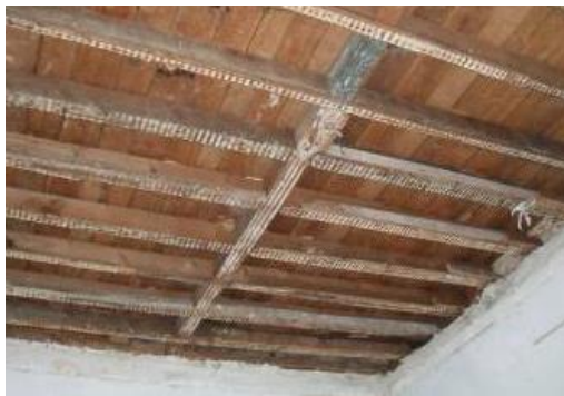
Figura 09: Estrutura de pavimento, após ter sido retirado o teto (edifício da rua Duques de Bragança, Lisboa, 2009)
