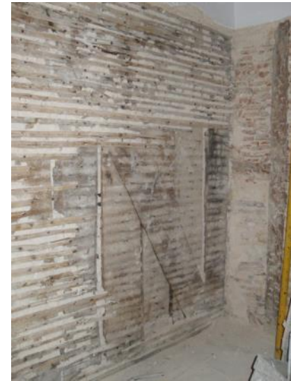
Figura 05: Tabique simples, em que se distinguem as costaneiras e uma aspa (edifício da rua Duques de Bragança, Lisboa, 2009)
