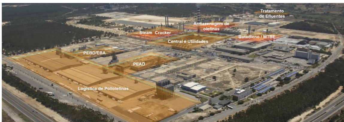
Figura 1 - Complexo Petroquímico de Sines
