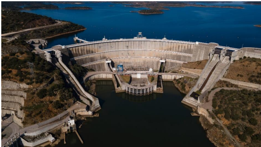
Figura 3.10 – Exemplo da barragem de Alqueva como hídrica de bombagem (Agência Lusa, 2024).
