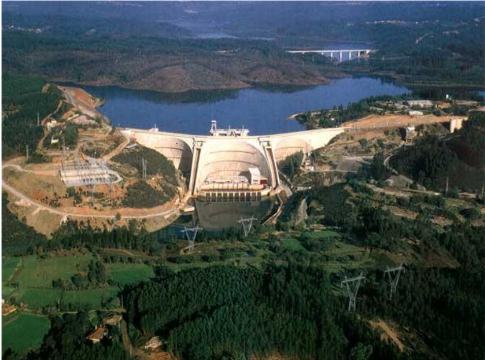
Figura 2.9 – Central de bombagem situada em Aguieira [76].
