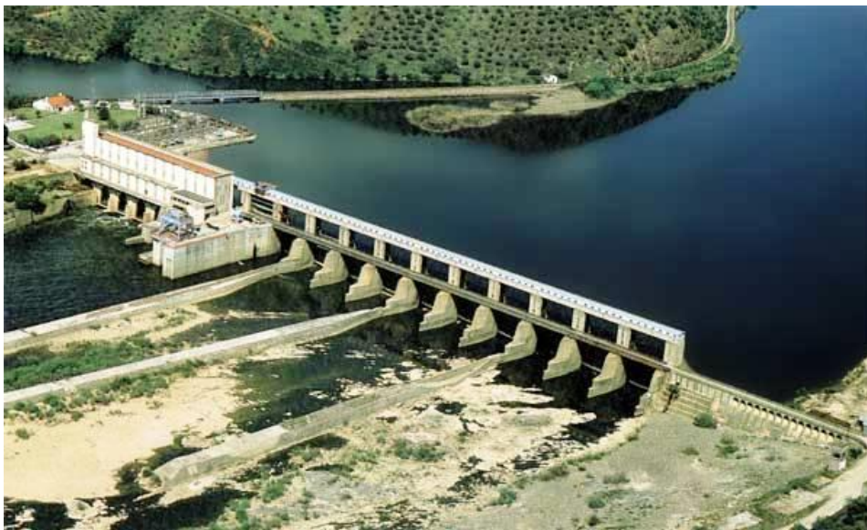
Figura 2.5 – Central de fio de água situada em Belver [76].
