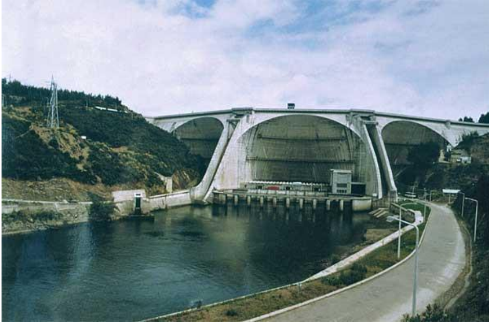
Figura 2.8 – Central de bombagem situada em Aguieira [76].
