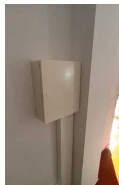
Figura 5 - Quadro elétrico desprovido de sinalética regulamentada.
