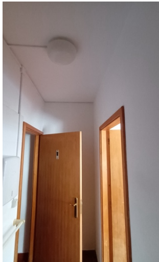
Figura 3 - Número de extintor insuficientes.
