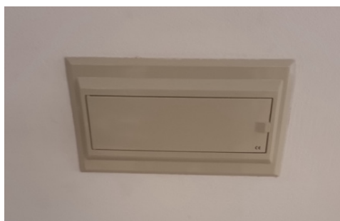
Figura 5 - Quadro elétrico desprovido de sinalética regulamentada.
