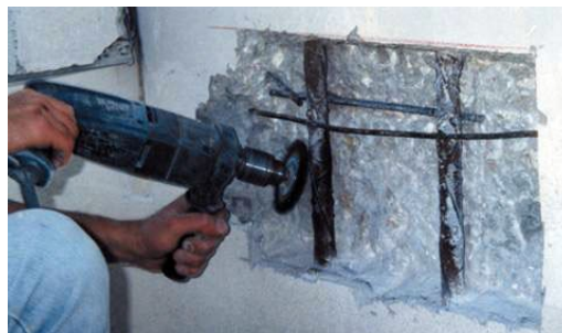
Figura 54 - Escovagem mecânica das armaduras [21].
