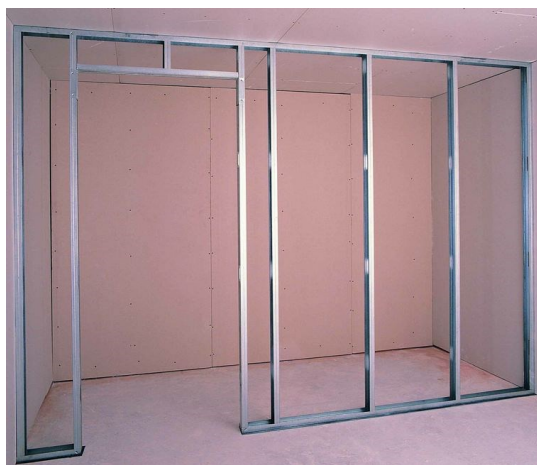
Figura 59 - Estrutura interna de perfis metálicos [26].
