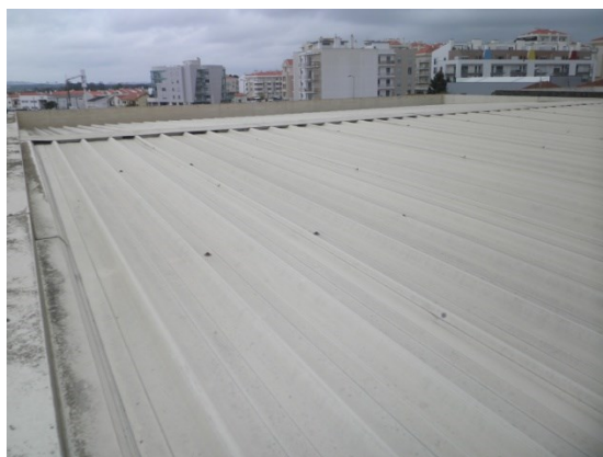
Figura 10 - Chapas metálicas da cobertura [4].
