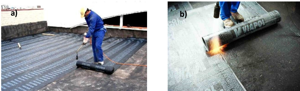
Figura 45 – a) Aplicação das telas betuminosas [41] ; b) Pormenor da soldadura com o maçarico [41].
