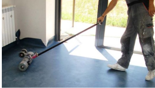
Figura 73 - Aplicação do rolo metálico [31].
