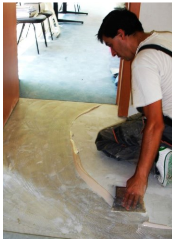
Figura 72 - Aplicação da cola na base de assentamento [31].
