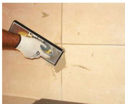
Figura 83 - Aplicação do material de preenchimento das juntas com a talocha de borracha [33].
