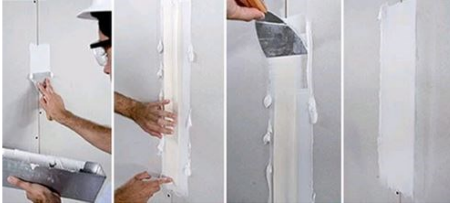
Figura 68 - Aplicação da banda de remate de juntas [29].
