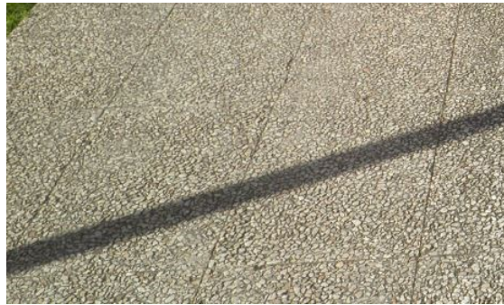
Figura 17 - Pavimento exterior de lajetas de betão [4].
