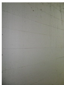
Figura 30 - Betão à vista [4].
