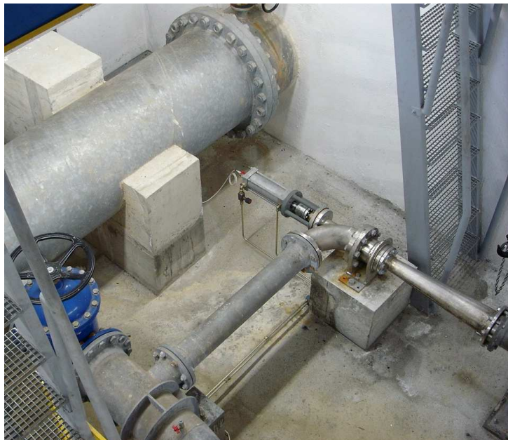
Fig. 8-4 – Pormenor da válvula reguladora de pressão.
