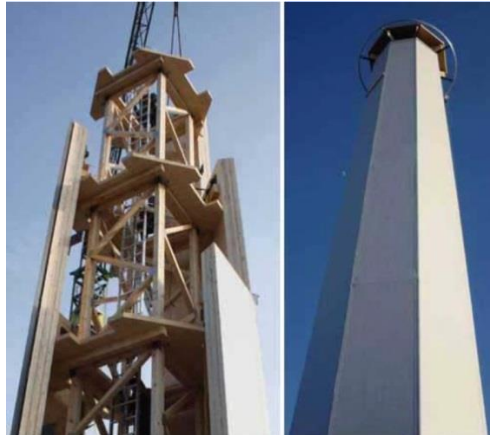
Figura 57 – Montagem de uma torre de madeira pela empresa Timber Tower na Alemanha. Fonte: [49]
