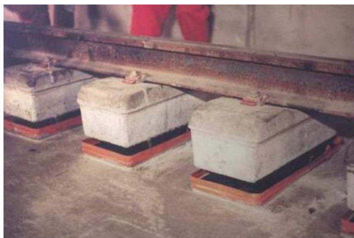
Figura 72 - Substituição de Elementos em via Stedef [53]
