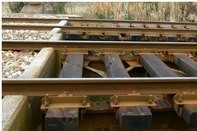
Figura 90 - Transição entre via balastrada e ponte metálica [19]
