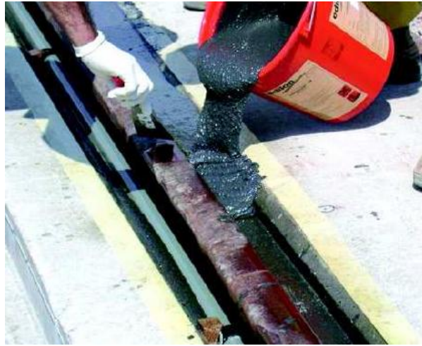
Figura 83 - Carril Embebido - Aplicação de resina [45]
