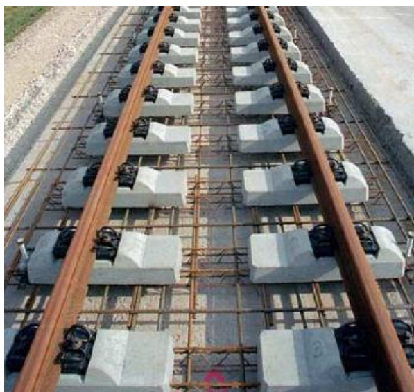
Figura 68 - Sistema Rheda 2000® - via em construção [50]
