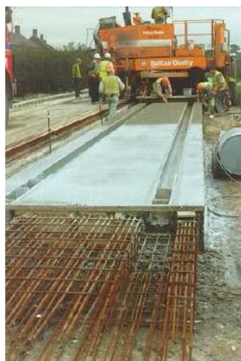
Figura 82 - Sulco na laje para posterior instalação do carril [57]
