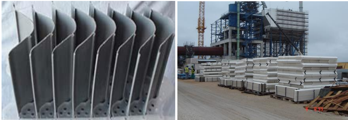
Figura 20 - Separadores de gotas utilizados durante a construção da torre
