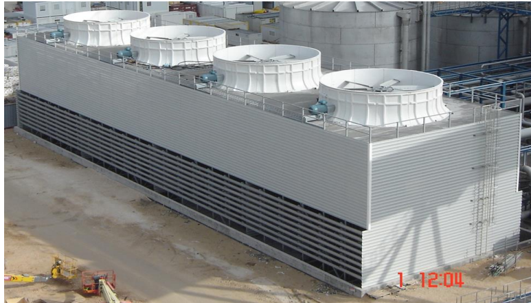
Figura 18 – Persianas de entrada de ar numa torre de escoamento cruzado (Fonte – Material fornecido por ESINDUS S.A.) [5]
