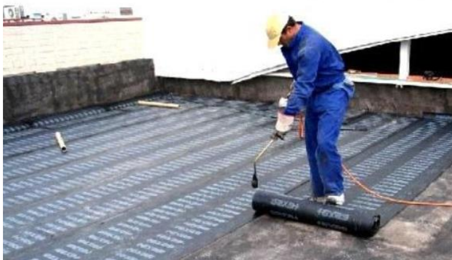
FIGURA 4.18 – APLICAÇÃO TELAS IMPERMEABILIZAÇÃO NA PORTARIA
