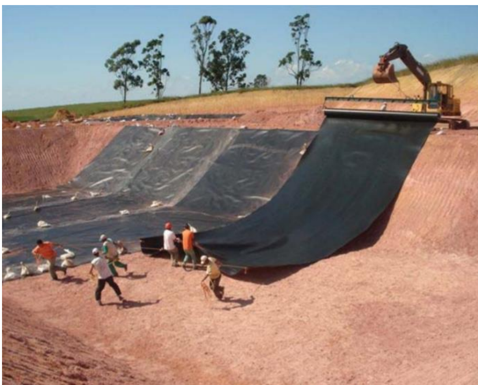
FIGURA 4.3 – COLOCAÇÃO DA GEOMEMBRANA NO TALUDE E BASE [1]
