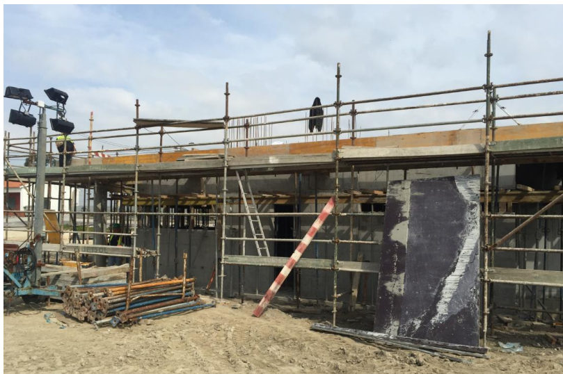
FIGURA 4.13 – COFRAGEM DOKA (PORTARIA A)
