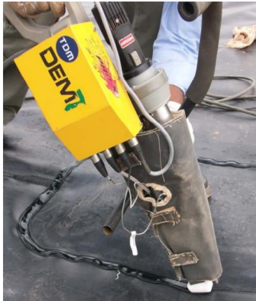
FIGURA 4.5 – UNIÃO POR EXTRUSÃO [1]
