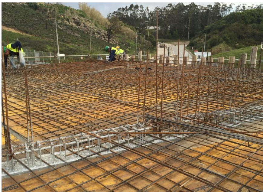
FIGURA 4.14 – VISTA GERAL DAS COFRAGENS E ARMADURAS, ANTES DOS TRABALHOS DE BETONAGEM
