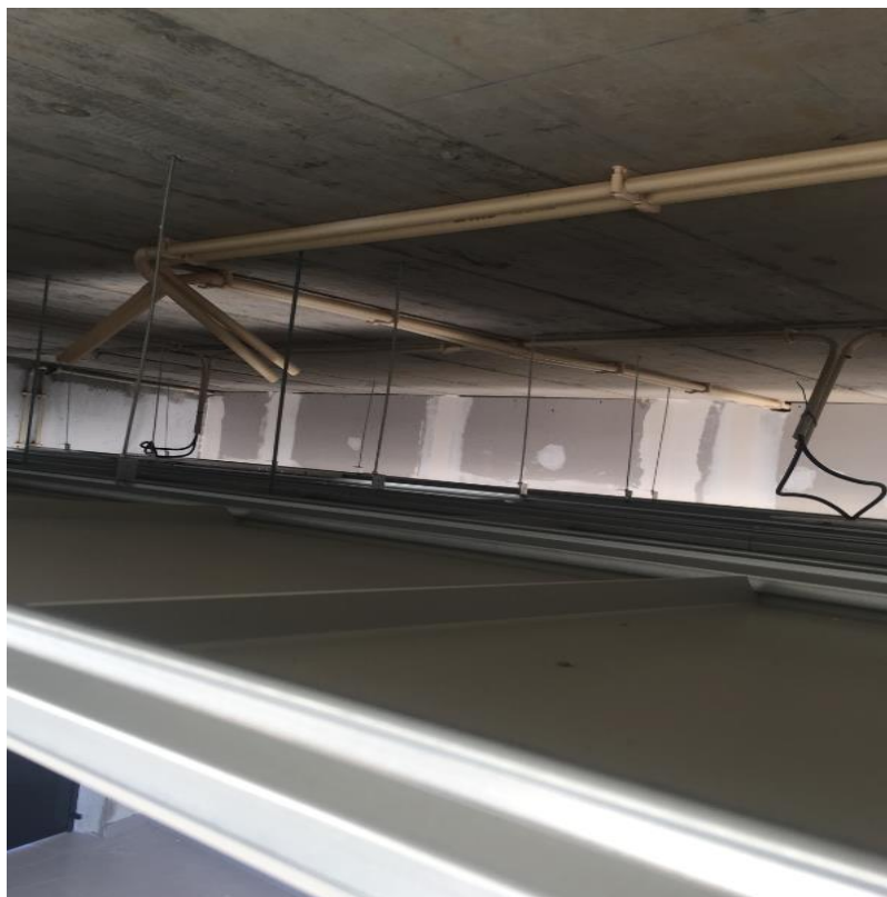
FIGURA 4.19 – EXEMPLO DE FIXAÇÃO DO TETO EM PLADUR
