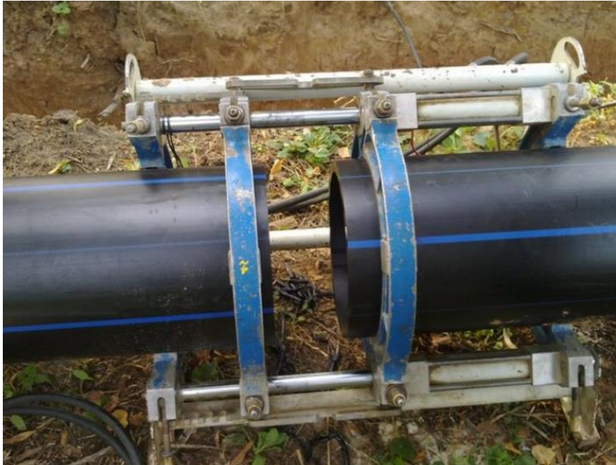
FIGURA 4.11 – EXEMPLO DE SOLDADURA DE TUBO PEAD DO TIPO TOPO-A-TOPO
