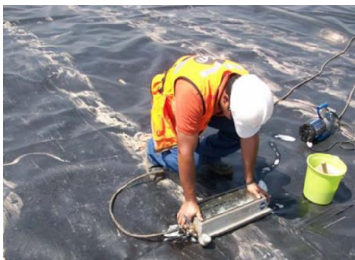
FIGURA 4.6 – ENSAIO DE VÁCUO [1]
