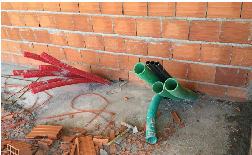
FIGURA 4.20 – INSTALAÇÕES ELÉTRICAS E TELECOMUNICAÇÕES
