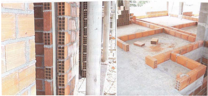
FIGURA 4.15 – ALVENARIA DE TIJOLO
