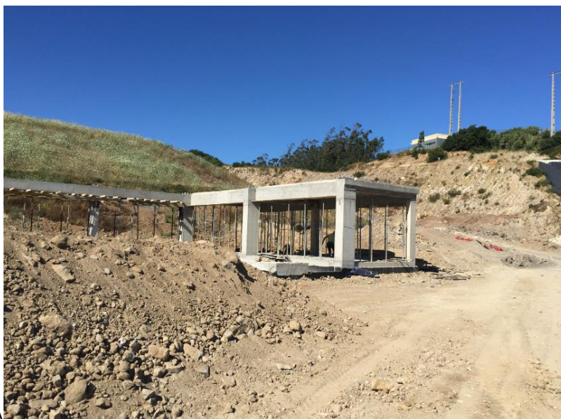
FIGURA 4.12 – ESTRUTURA EM BETÃO ARMADO DA PORTARIA
