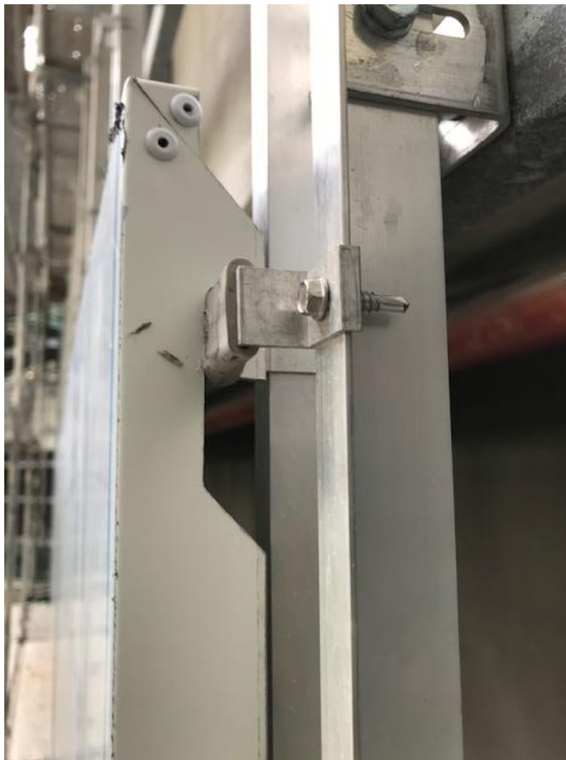
Figura 7.17 – Encaixe da cassette (Fonte: Arquivo Próprio)
