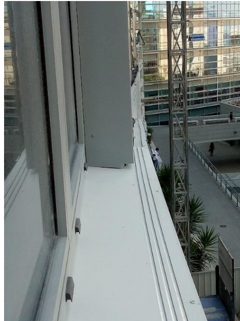
Figura 7.21 – Remate Inferior com os três rasgos (Fonte: Arquivo Próprio)
