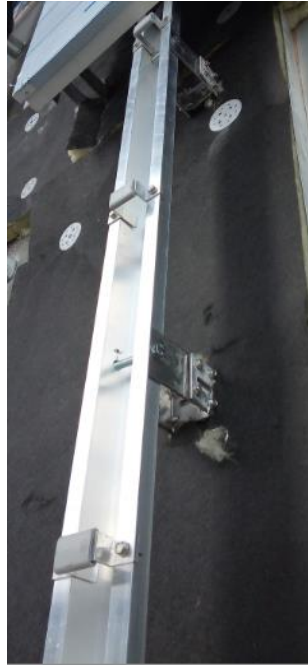
Figura 7.12 – Montagem perfil ómega (Fonte: Arquivo Próprio)
