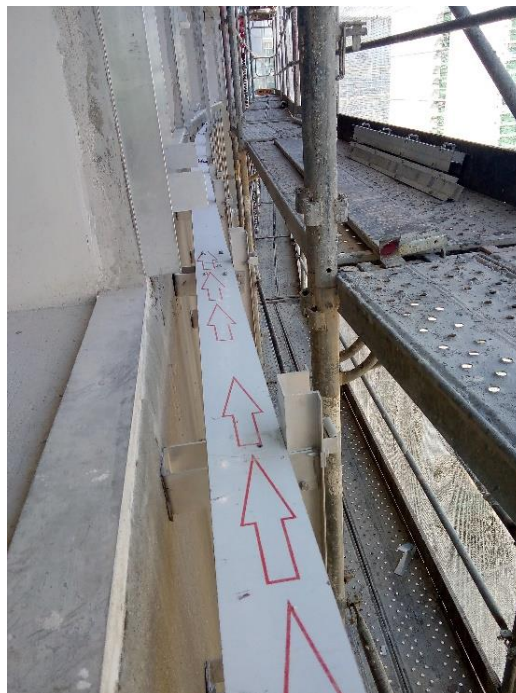
Figura 7.13 – Moldes para montagem do perfil ómega (Fonte: Arquivo Próprio)
