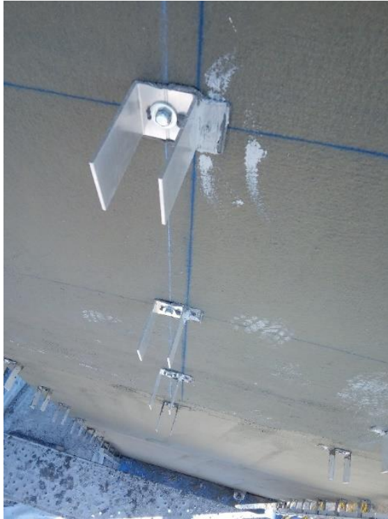
Figura 7.7 – Exemplo de uma peça em “U” de amarração (Fonte: Arquivo Próprio)
