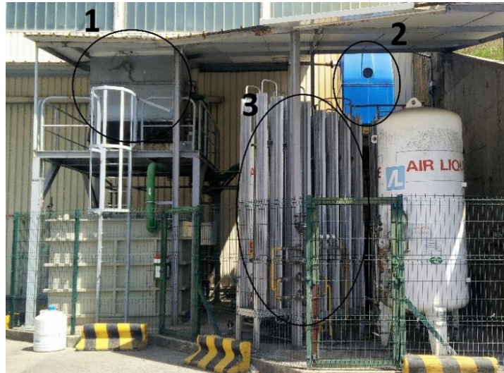
Figura 10. Constituintes exteriores dos fornos.
