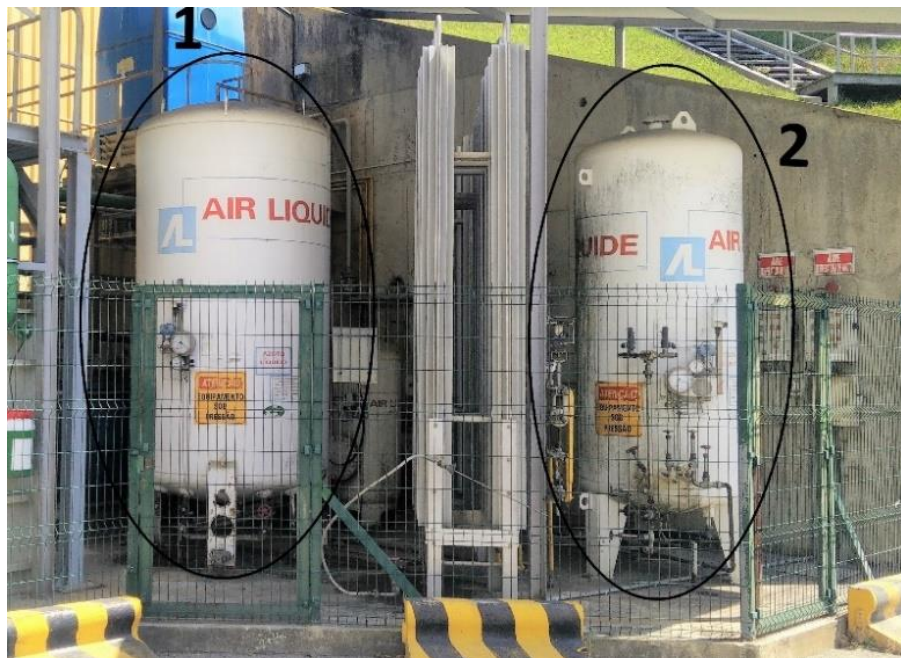
Figura 9. Constituintes exteriores dos fornos.
