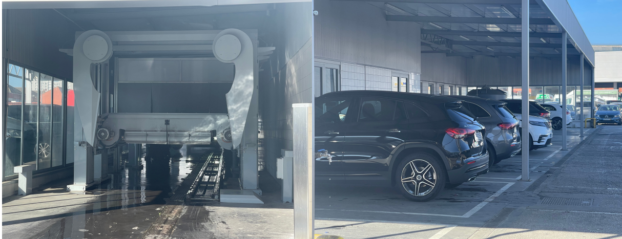
Figura 3.16 Zona de lavagem.
