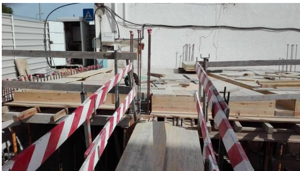
Figura 3.59 - Execução da cofragem de laje e vigas do piso 0
