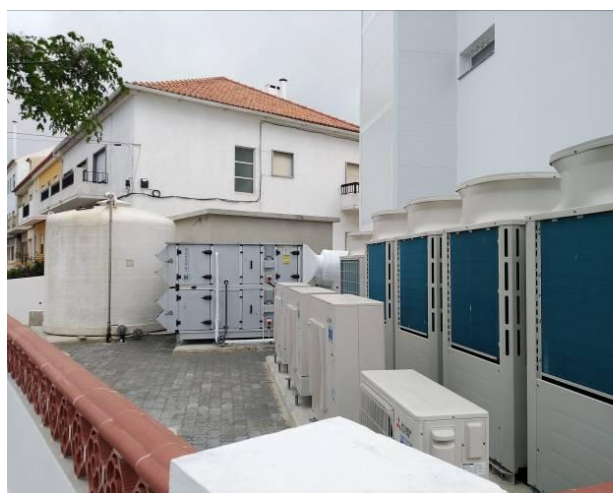
Figura 5.10 - Aspecto final da zona técnica
