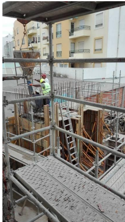
Figura 3.72 - Execução de betonagem dos pilares e da caixa do elevador do piso 0
