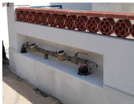
Figura 4.110 - Novo local do contador – instalação da rede de águas
