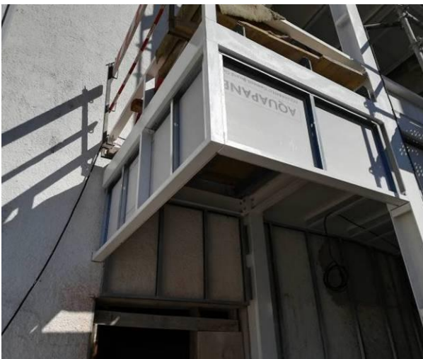
Figura 3.142 - Execução de revestimento da estrutura das rampas metálicas
