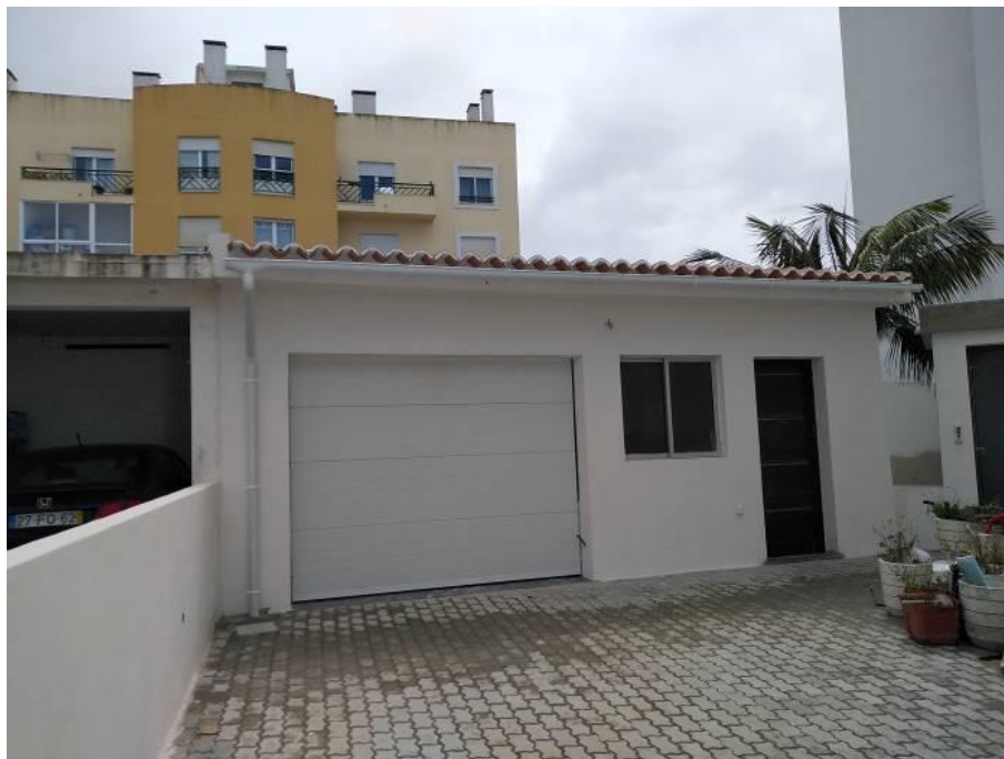
Figura 5.31 - Aspecto final da garagem após intervenção
