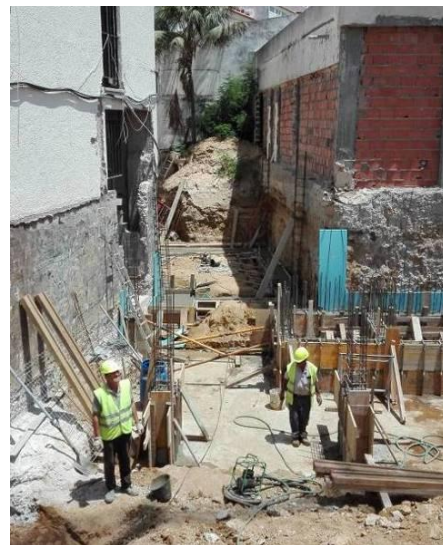
Figura 3.37 - Execução de fundações - torre do elevador e da zona de expansão
