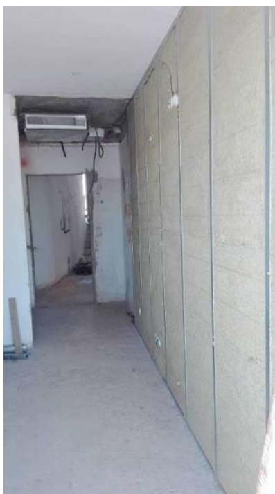
Figura 4.455 - Colocação de lã mineral
