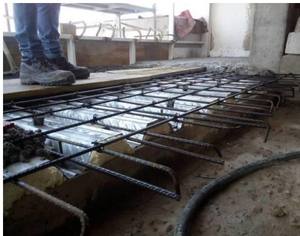
Figura 4.230 - Ampliação do piso 2 e 3 no alçado sudoeste - montagem de chapa colaborante
