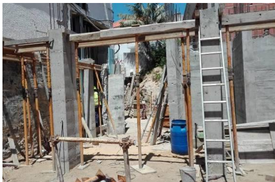
Figura 3.55 - Execução de pilares do piso -1 após a descofragem
