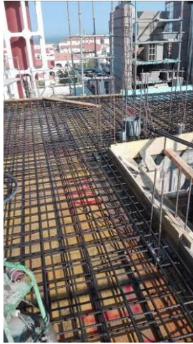
Figura 3.96 - Execução da cofragem, armadura da laje do piso 4
