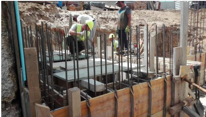
Figura 3.48 – Execução do poço dos elevadores – preparação e após a betonagem
