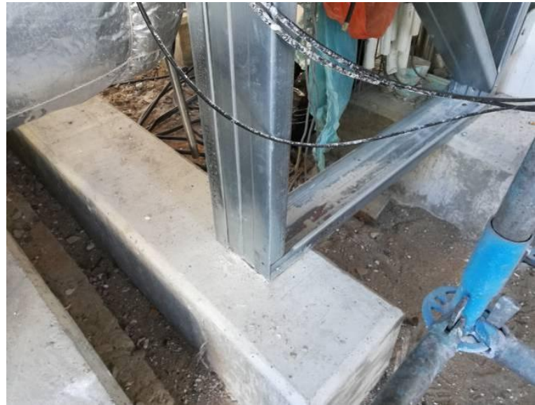
Figura 4.90 - Apoio da estrutura metálica em maciços de betão armado
