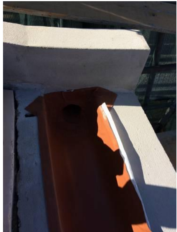
Figura 4.191 - Execução de caleira interior
