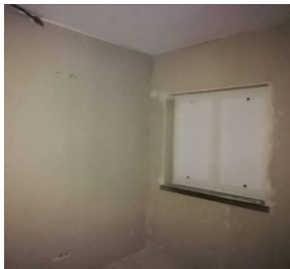
Figura 4.151 - Colocação de placas de gesso cartonado
