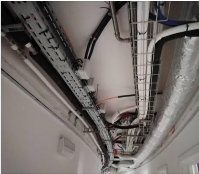
Figura 4.100 - Passagem de esteira de electricidade e ITED nos corredores
