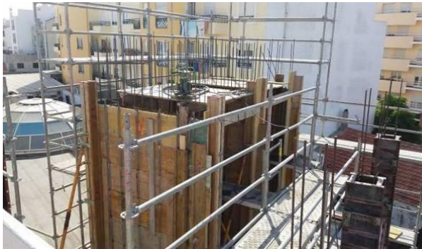
Figura 3.87 - Execução da cofragem, armadura e betonagem dos pilares e caixa do elevador do piso 2
