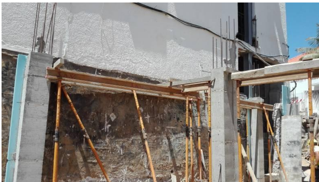
Figura 3.58 – Execução da cofragem de laje e vigas do piso 0
