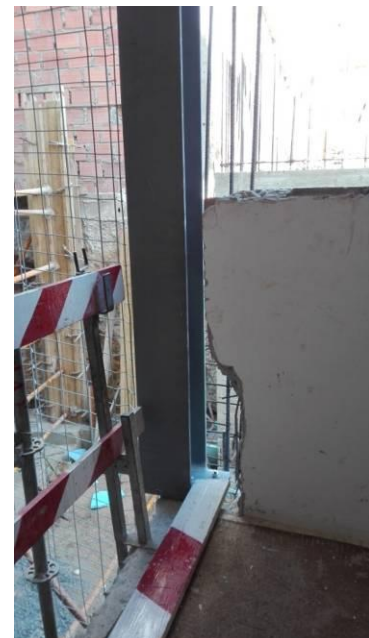
Figura 4.10 - Execução do reforço com pilares metálicos
