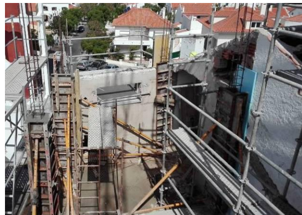
Figura 4.211 - Zona de acesso da torre de elevador ao edifício existente – execução da armadura, cofragem e betonagem dos pilares
