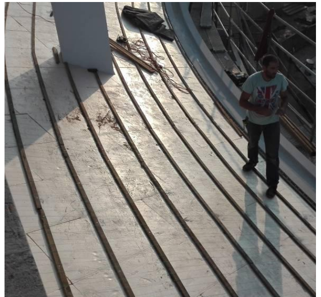
Figura 4.181 - Colocação do isolamento térmico
