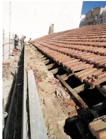
Figura 5.54 - Beneficiação da cobertura dos edifícios vizinhos
