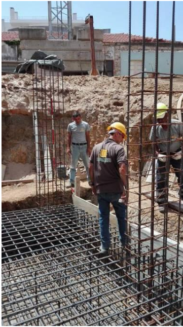
Figura 3.32 - Execução da armadura – sapata torre do elevador
