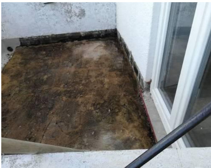
Figura 4.195 - Após a retirada do pavimento
