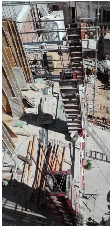
Figura 3.81- Execução da armadura e cofragem dos pilares do piso 1
