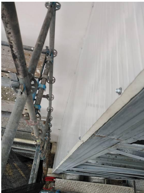
Figura 4.91 - Revestimento de estrutura
