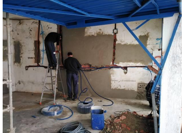
Figura 5.28 - Instalação eléctrica e iluminação da garagem
