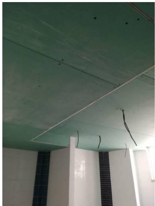
Figura 4.460 - Execução de isolamentos nos tectos entre pisos
