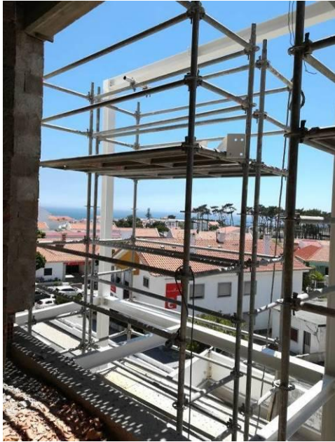
Figura 4.224 - Ampliação do piso 2 e 3 no alçado sudoeste - montagem de pilares e vigas
