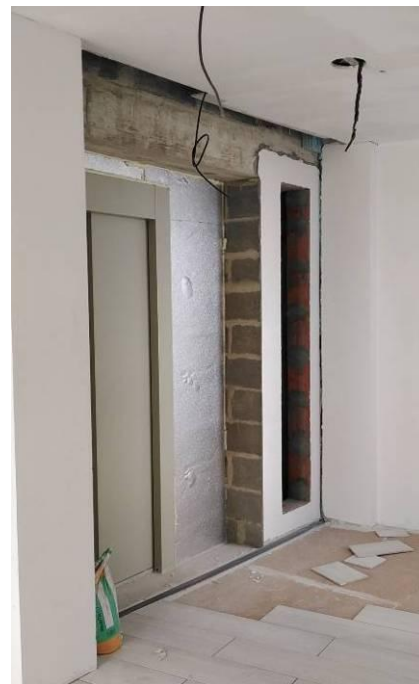
Figura 3.177 - Montagem dos elevadores portas nos pisos
