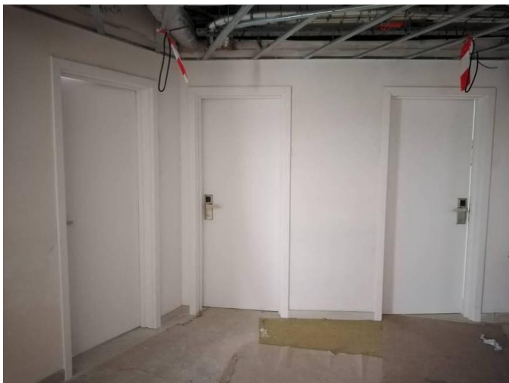
Figura 4.60 - Aspecto final após montagem de portas
