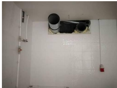
Figura 4.125 - Instalação das condutas do AVAC
