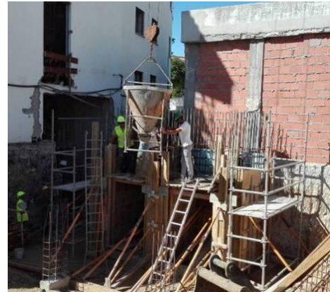
Figura 3.54 - Execução da caixa de elevadores do piso -1 – execução da betonagem
