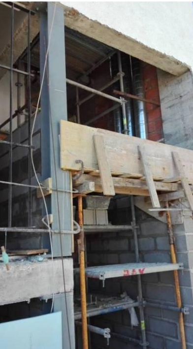
Figura 4.15 - Execução de alvenaria e vigas
