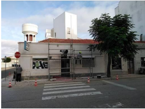
Figura 5.58 - Beneficiação de fachada lateral e principal dos edifícios vizinhos acabamento final
