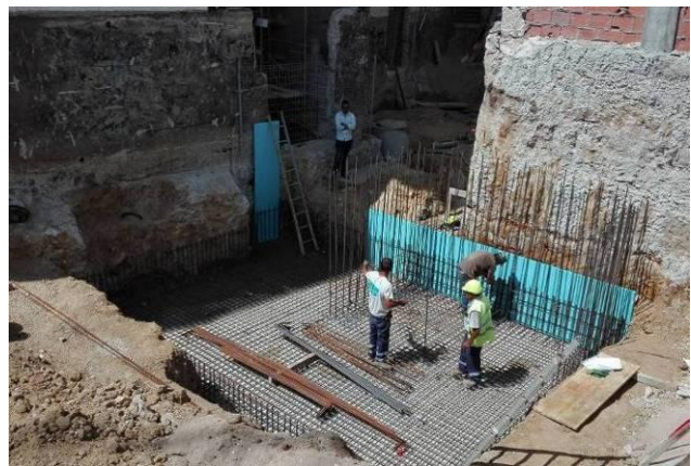
Figura 3.31 - Execução da armadura – sapata da torre do elevador
