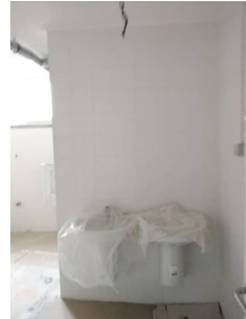
Figura 4.163 - Balneário masculino no piso -1
