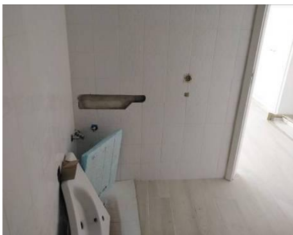
Figura 4.176 - Aspeto final da IS do quarto 301
