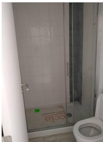
Figura 4.157 - Aspecto final após aplicação do azulejo
