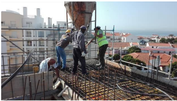
Figura 3.98 - Execução da betonagem da laje do piso 4
