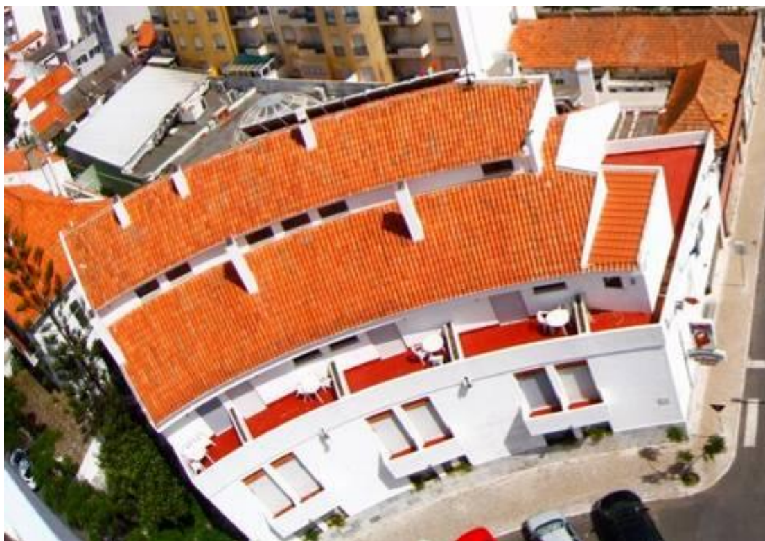
Figura 2.39 – Cobertura do edifício da residencial Búzio [CMSines,2018]
