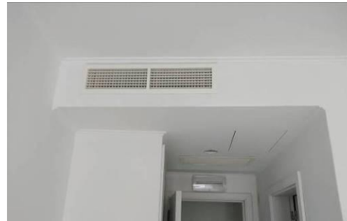
Figura 4.129- Aspecto final após fecho de tectos e montagem das grelhas
