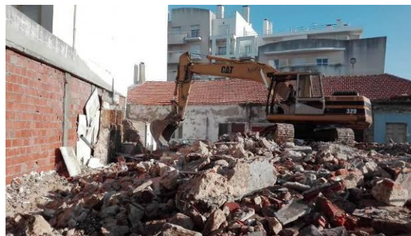
Figura 3.10 – Execução da demolição com o apoio de meios mecânicos
