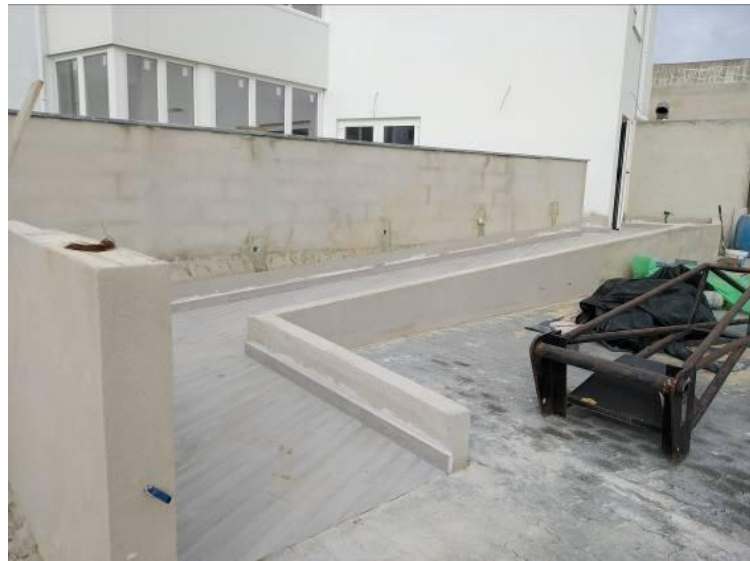
Figura 5.40 - Execução da rampa de acesso à torre do elevador
