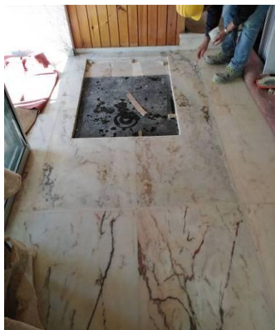
Figura 4.52 - Aplicação do capeamento e revestimentos em pedra mármore branco
