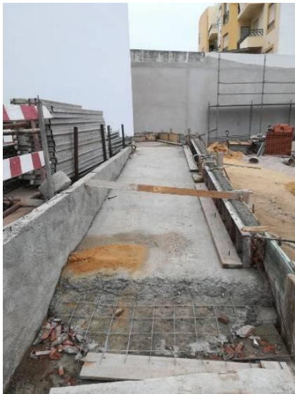
Figura 5.39 - Execução da rampa de acesso à torre do elevador
