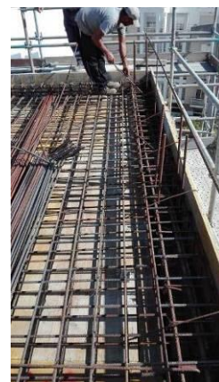
Figura 3.106- Execução da armadura da laje de cobertura
