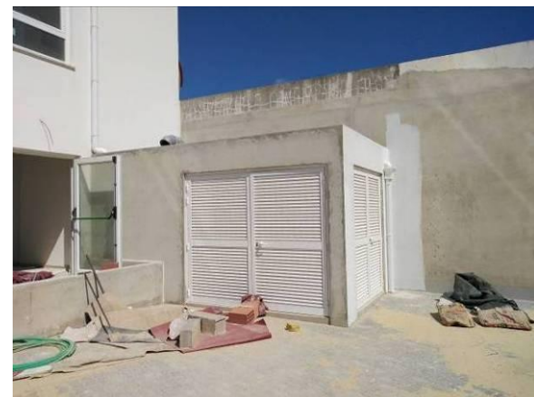
Figura 5.72 - Execução do edifício do gerador – após montagem e portas
