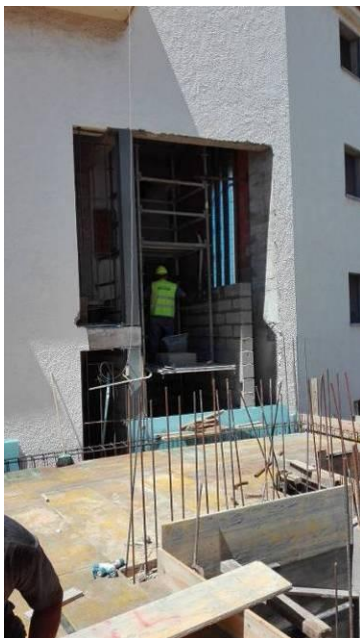
Figura 4.8 - Execução do reforço com pilares metálicos
