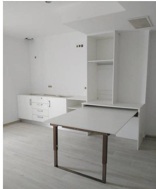
Figura 4.78 - Preparação das instalações para cozinha do quarto 205
