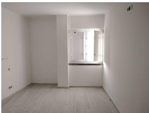
Figura 4.152 - Aspecto final após colocação das placas de gesso e do barramento
