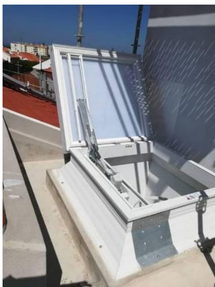
Figura 4.446 - Acesso à cobertura do piso 3 e 4
