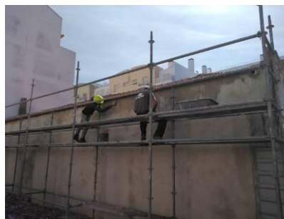
Figura 5.56 - Beneficiação de fachada posterior dos edifícios vizinhos – enchimento
