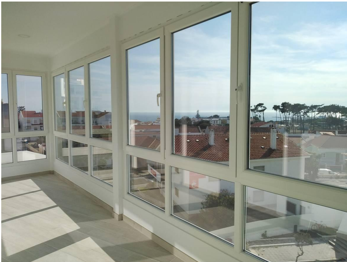
Figura 4.205 - vista panorâmica – ampliação piso 3
