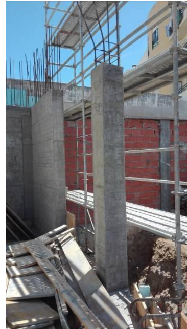
Figura 3.74 - Execução da descofragem dos pilares e da caixa do elevador do piso 0
