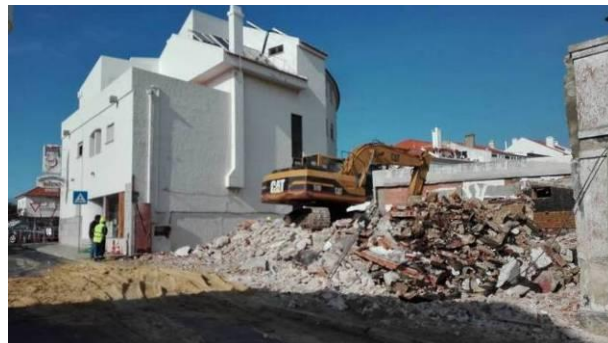
Figura 3.8 – Execução da demolição com o apoio de meios mecânicos
