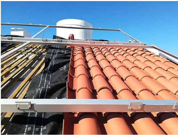
Figura 4.186 - Colocação da tela impermeabilizante e da telha
