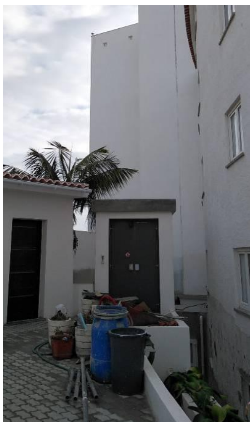
Figura 5.23 - Aspecto final do monta-cargas
