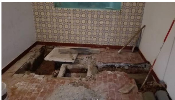
Figura 4.107 - Execução de nova rede de esgotos – Ligação de novos balneários e lavandaria – Piso -1
