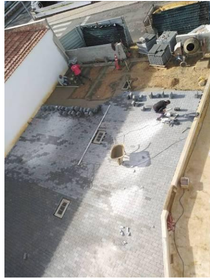
Figura 5.48 - Colocação do pavê
