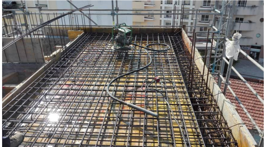
Figura 3.97 - Execução da cofragem, armadura da laje do piso 4
