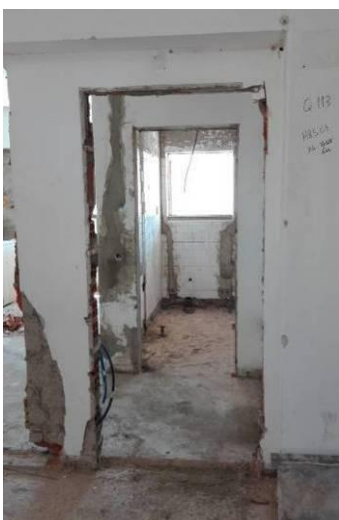
Figura 4.58 - Portas após retiradas
