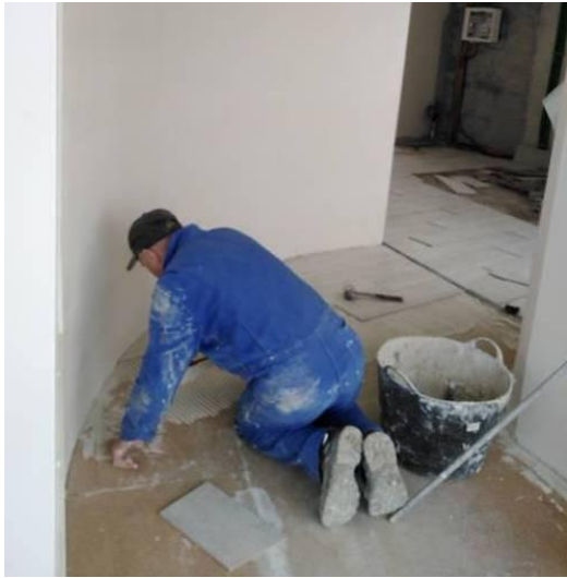
Figura 4.25 - Colocação da cortiça
