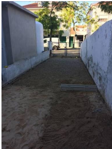
Figura 5.34 - Execução de enrocamento
