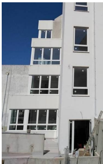
Figura 3.144 - Aspecto final da estrutura das rampas metálicas
