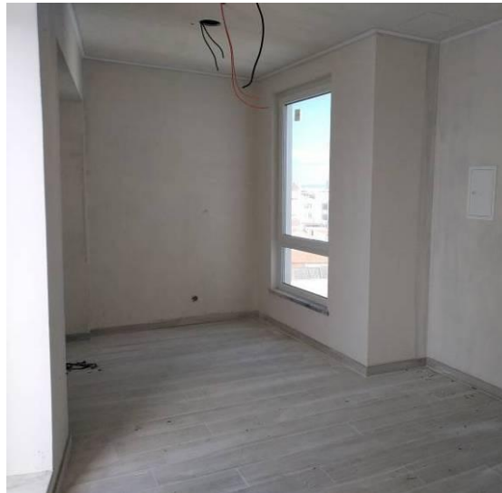
Figura 3.123 - Quadro eléctrico parcial – aspecto final no piso 4
