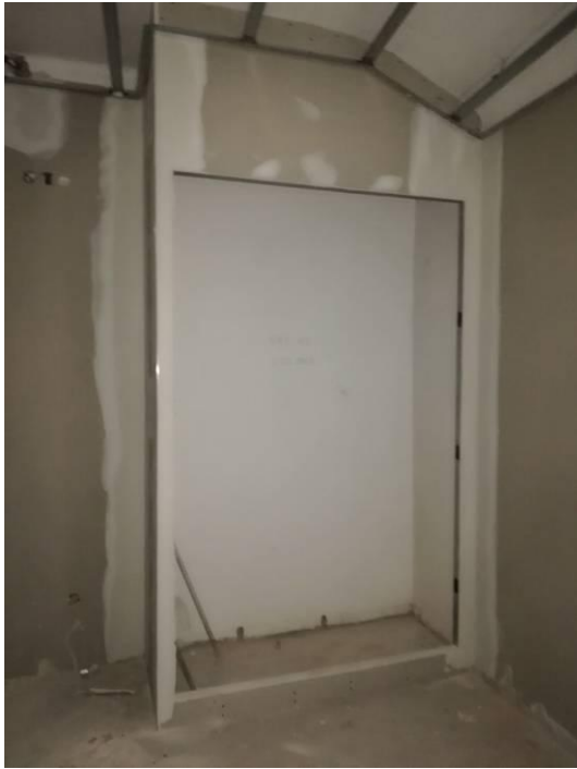
Figura 4.68 - Execução de estruturas exteriores dos roupeiros
