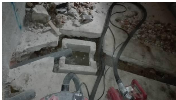
Figura 4.108 - Execução de nova rede de esgotos – Ligação de novos balneários e lavandaria – Piso -1
