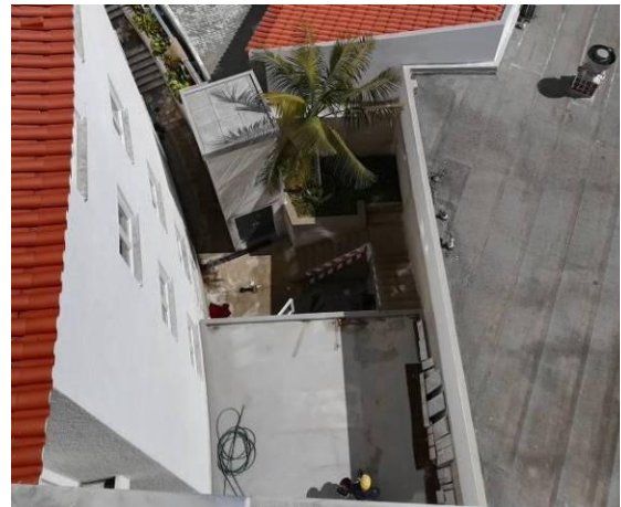
Figura 4.438 - Execução de escadas de acesso e cobertura da zona de ampliação
