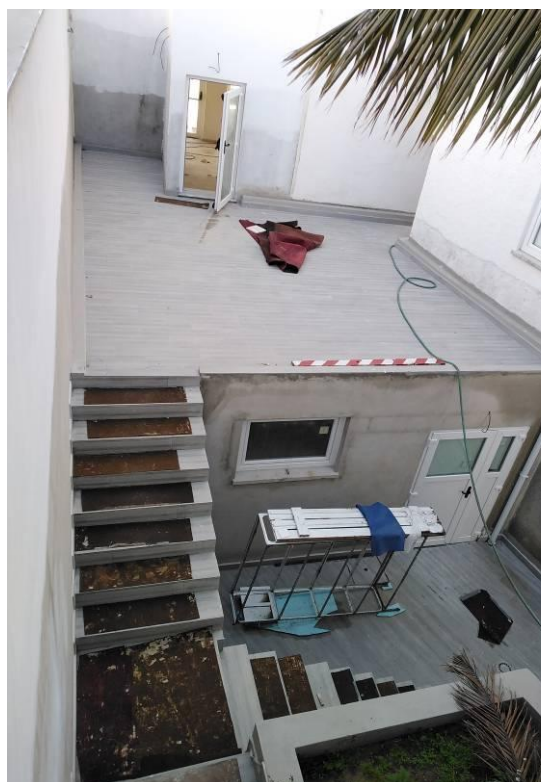
Figura 4.442 - Aspecto final da escada e cobertura da zona de ampliação
