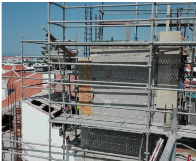
Figura 4.17 - Execução do último piso
