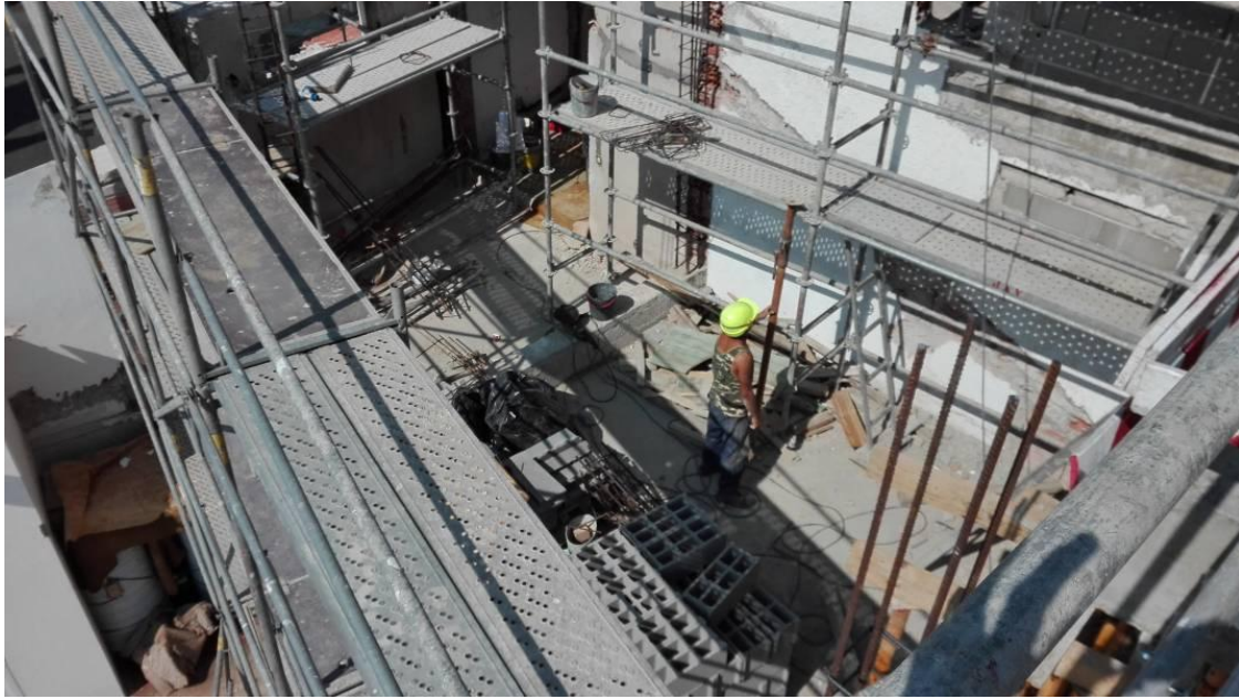
Figura 4.207 - Zona de acesso da torre de elevador ao edifício existente
