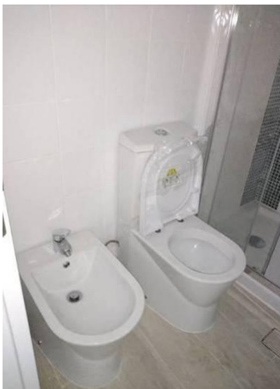
Figura 4.40 - Instalação das loiças
