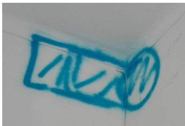
Figura 4.122 - Marcação de carotes/janelas para passagem de instalações do AVAC
