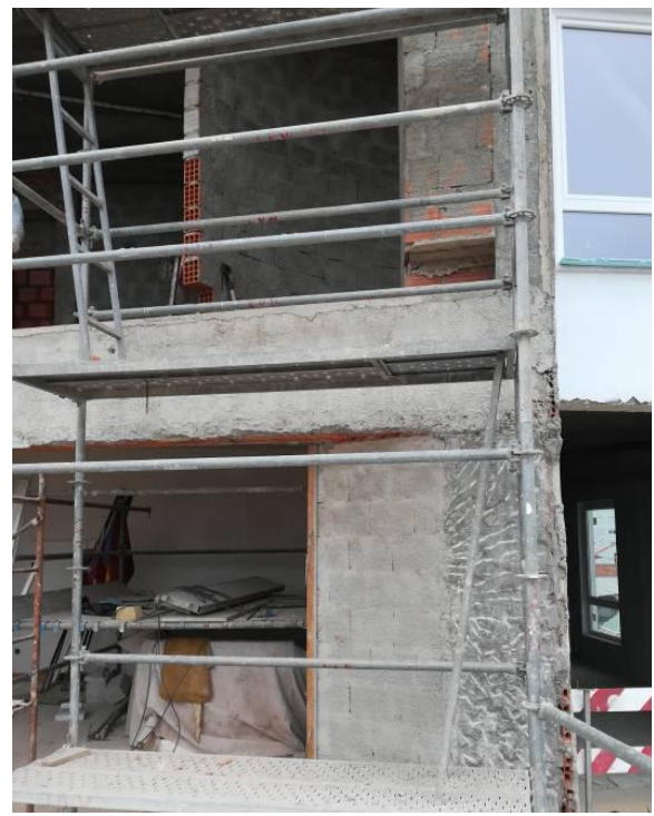
Figura 4.221 - Ampliação do piso 2 e 3 no alçado sudoeste - aspeto antes da montagem da estrutura metálica
