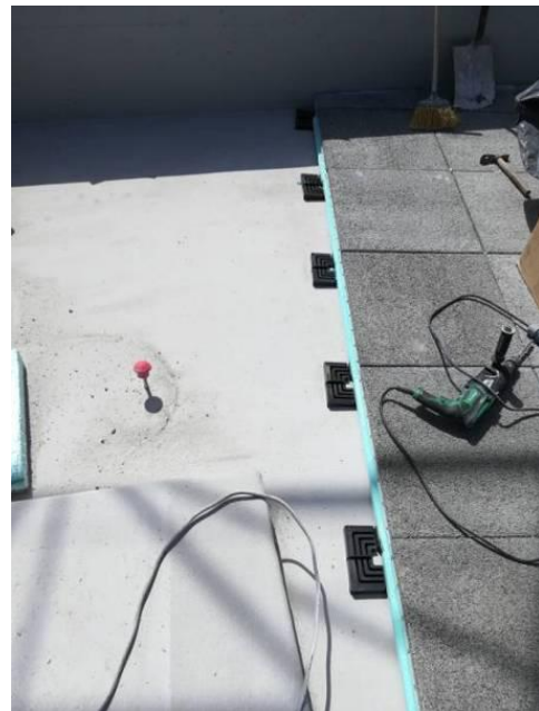
Figura 3.185 - Aplicação de lajetas térmicas
