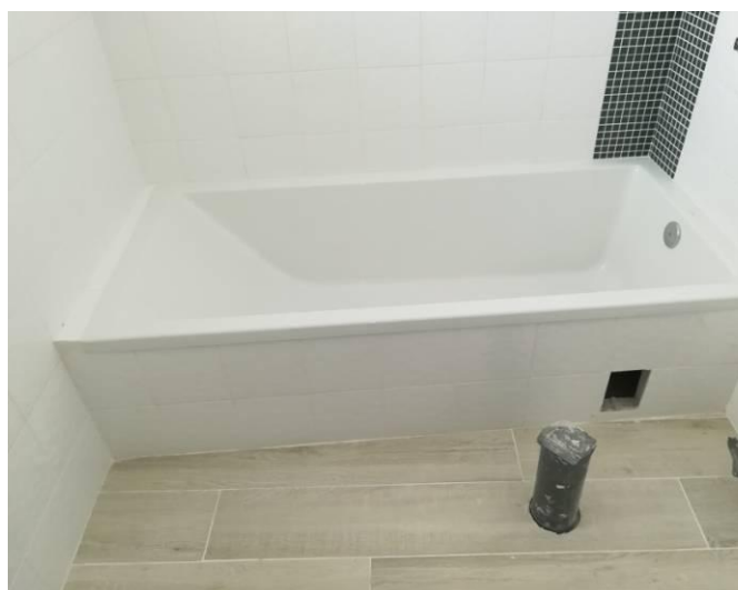
Figura 4.43 - Instalação das banheiras
