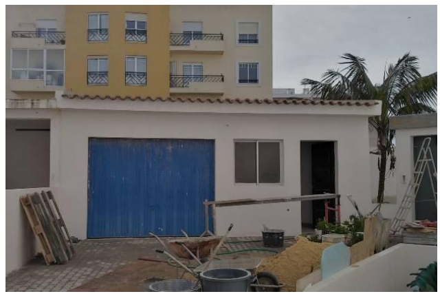
Figura 5.30 - Reparação de paredes exteriores da garagem
