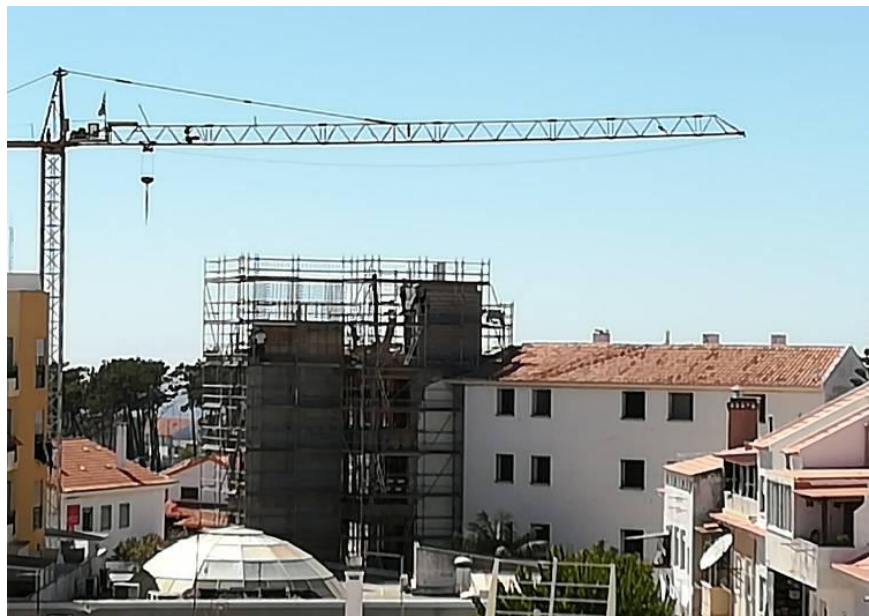
Figura 3.101 - Execução da cofragem, armadura dos pilares e caixa do elevador do piso 4
