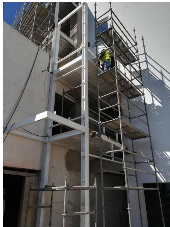
Figura 3.139 - Execução de estrutura das rampas metálicas
