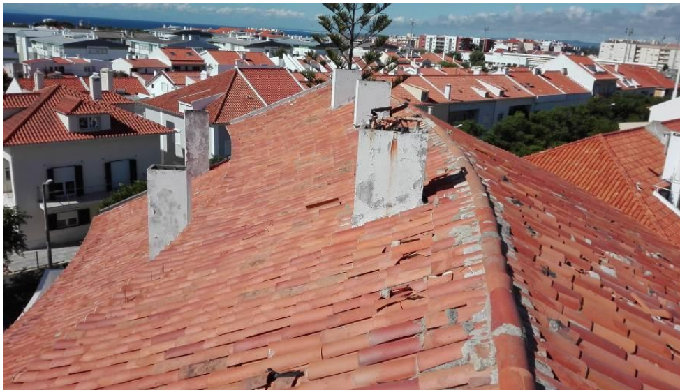
Figura 4.177 - Aspecto antes dos trabalhos
