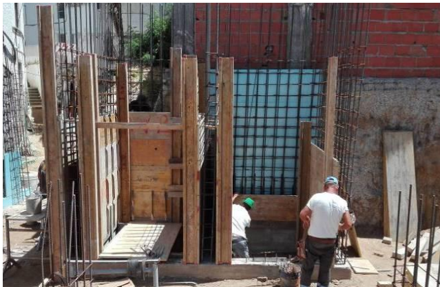
Figura 3.53 - Execução da caixa de elevadores do piso -1 – execução da cofragem
