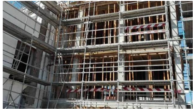
Figura 3.88 - Execução da cofragem, armadura e betonagem dos pilares e caixa do elevador do piso 2
