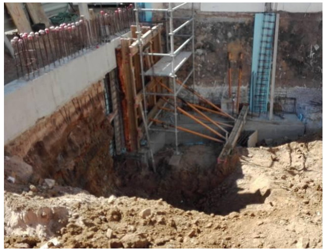
Figura 3.41 - Execução do muro de suporte de forma faseada e das fundações do piso -1
