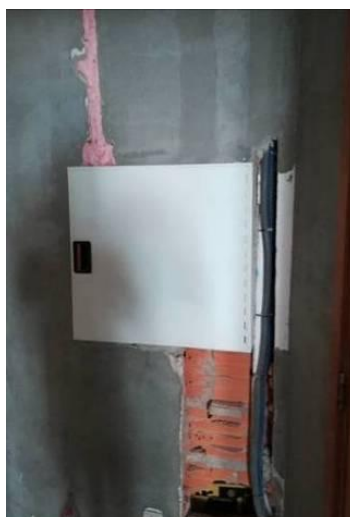
Figura 4.144 - Instalação dos carretéis - instalação
