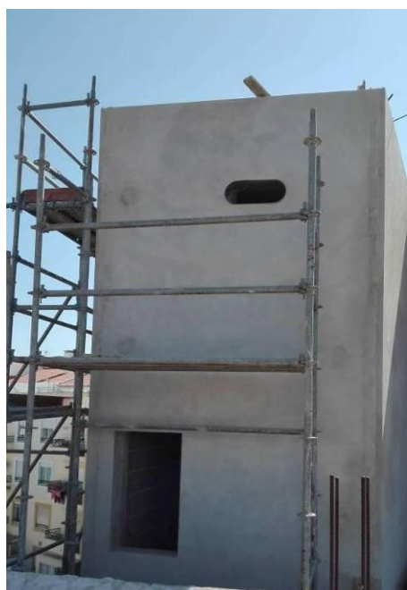
Figura 4.19 - Reboco exterior e aspecto final após reboco
