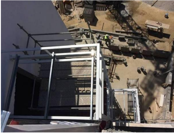
Figura 3.140 - Execução de estrutura das rampas metálicas [PC JAV Unip. Lda]
