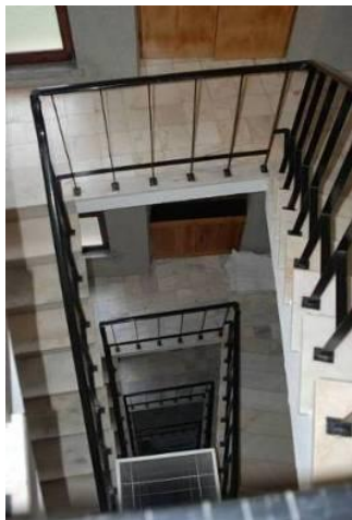
Figura 2.9 - Escadas de serviço
