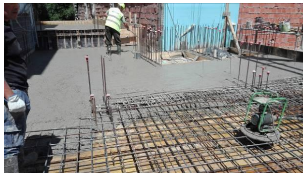
Figura 3.68 - Execução de betonagem de laje e vigas do piso 0
