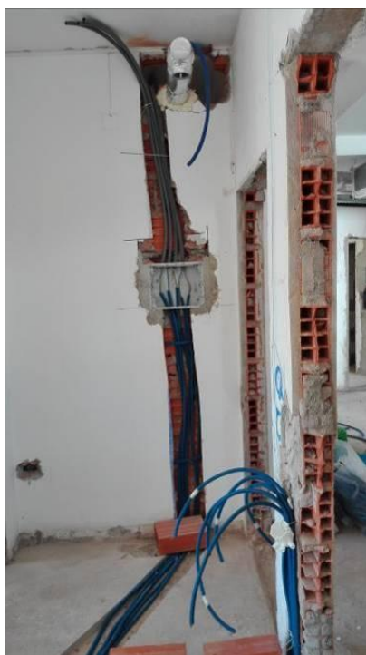
Figura 4.96 - Passagem de tubagem para as instalações eléctricas e ITED
