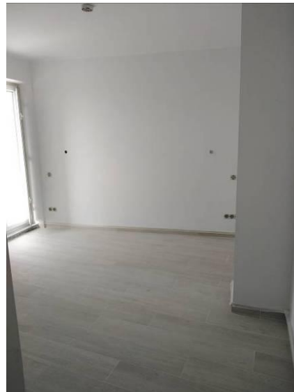
Figura 4.28 - Aspecto final dos pavimentos interiores
