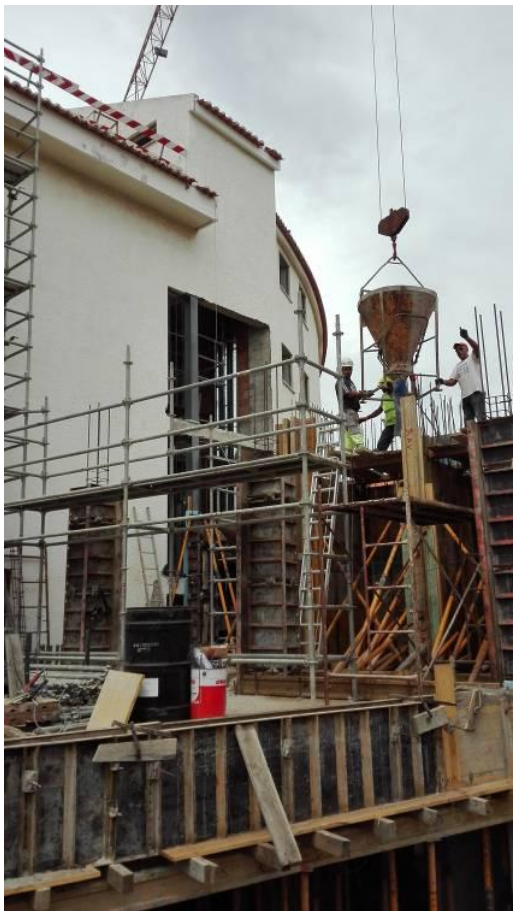
Figura 3.71 -Execução de betonagem dos pilares e da caixa do elevador do piso 0
