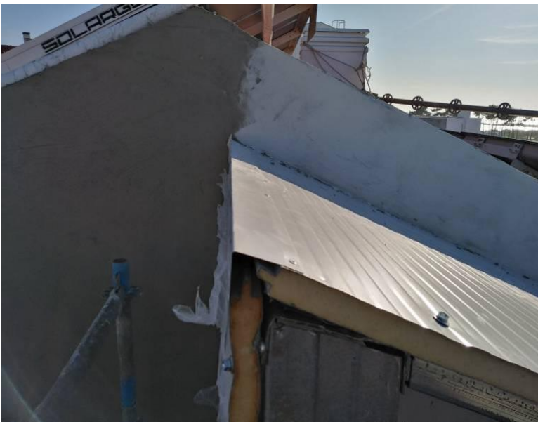
Figura 4.464 - Execução de sistema ETIC – zona de cobertura
