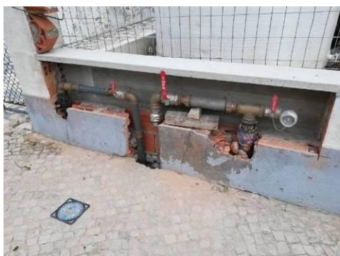
Figura 4.109 - Novo local do contador – instalação da rede de águas
