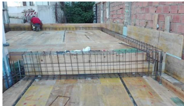
Figura 3.62 - Execução da cofragem de laje e vigas do piso 0
