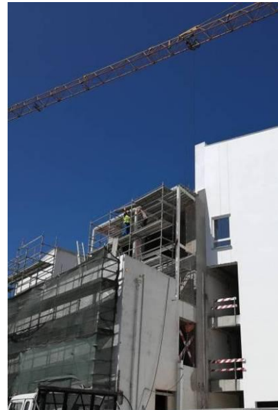
Figura 4.228 - Ampliação do piso 2 e 3 no alçado sudoeste - montagem da chapa colaborante
