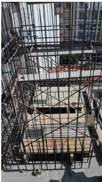
Figura 3.100 - Execução da armadura da caixa do elevador do piso 4
