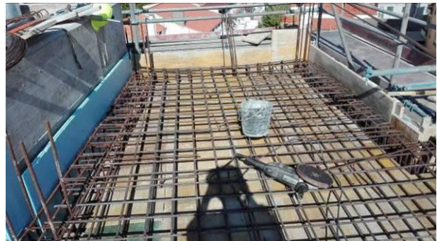
Figura 3.104 - Execução da cofragem, armadura da laje de cobertura
