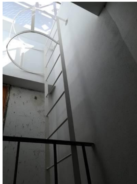
Figura 4.445 - Escadas interiores na caixa da escada de serviço no piso 3
