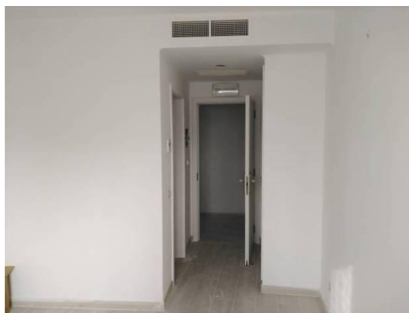
Figura 4.153 - Aspecto final após colocação das placas de gesso e do barramento
