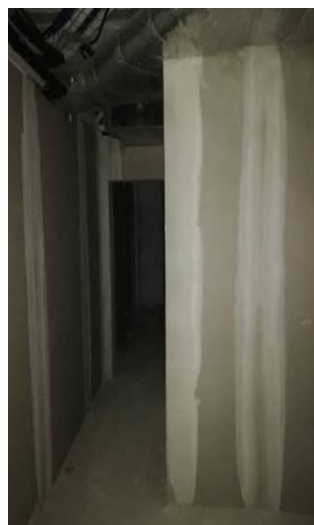
Figura 4.150 - Colocação de placas de gesso cartonado
