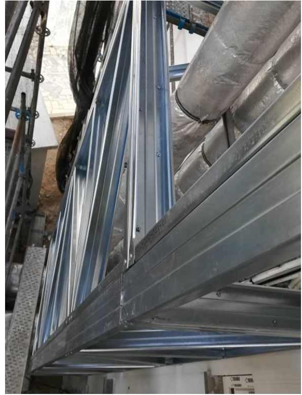
Figura 4.88 - Estrutura metálica em LSF
