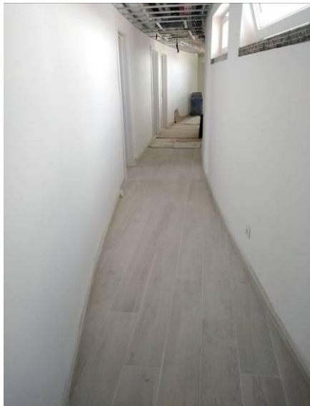
Figura 4.27 - Aspecto final dos pavimentos interiores
