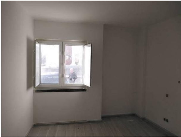
Figura 4.47 - Aspecto final após montagem das caixilharias em PVC
