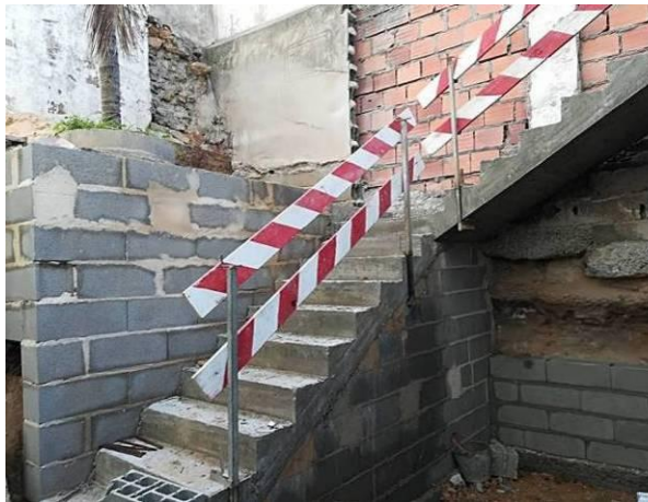
Figura 4.437 - Execução de escadas de acesso e cobertura da zona de ampliação
