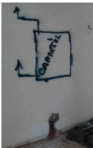
Figura 4.143 - Instalação dos carretéis – marcação
