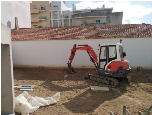
Figura 5.43 - Aterro e compactação do terreno para atingir cotas de trabalho no parque de estacionamento
