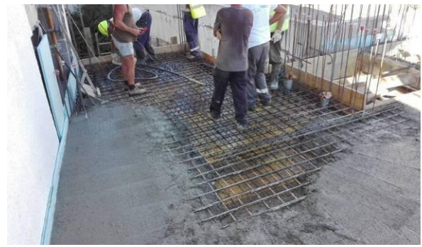
Figura 3.79 - Execução da armadura e betonagem de laje e vigas do piso 1
