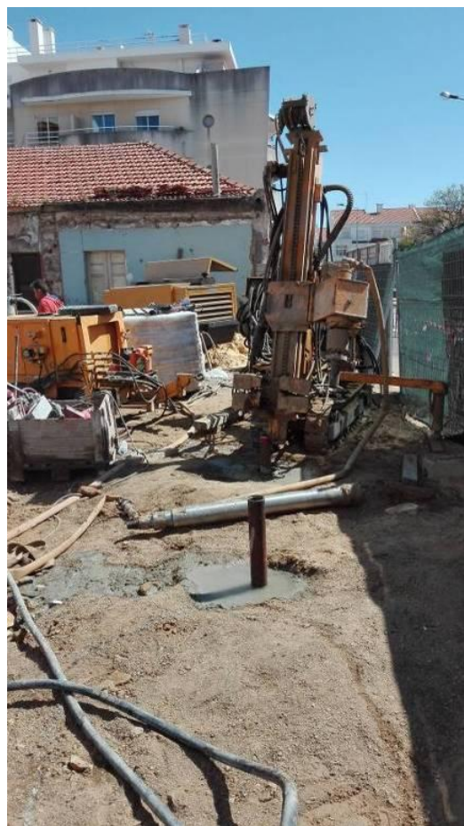
Figura 3.19 - Execução das microestacas
