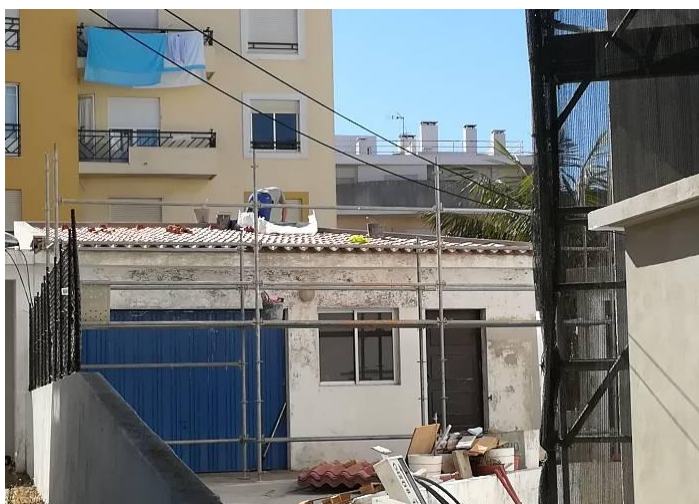
Figura 5.25 - Execução de nova cobertura da garagem
