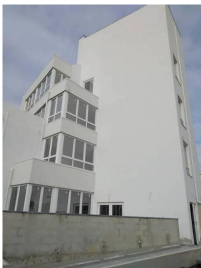
Figura 3.154 – Aspecto final após as pinturas exteriores
