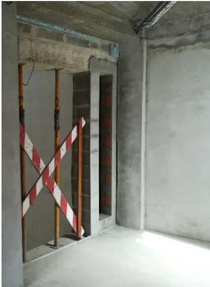
Figura 3.174 - Frente de caixas antes da montagem
