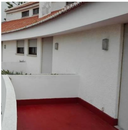
Figura 4.194 - Aspecto inicial do pavimento
