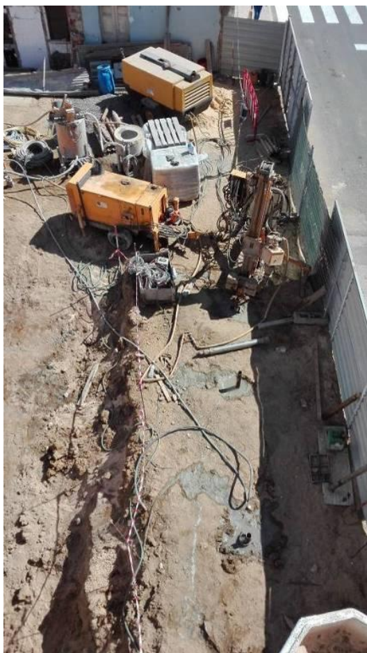
Figura 3.18 - Execução das microestacas
