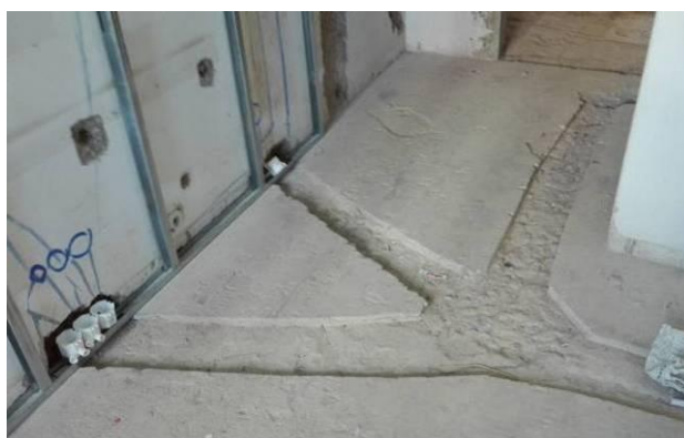
Figura 4.95 - Abertura de roços para as instalações eléctricas e ITED
