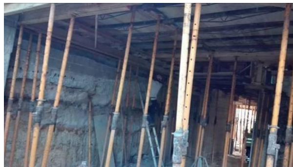
Figura 3.66 - Execução da betonagem (Escoramento) de laje e vigas do piso 0
