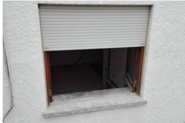
Figura 2.26 – Pormenor do reboco tipo tirolês nas paredes exteriores
