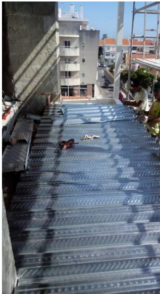
Figura 4.226 - Ampliação do piso 2 e 3 no alçado sudoeste - montagem da chapa colaborante
