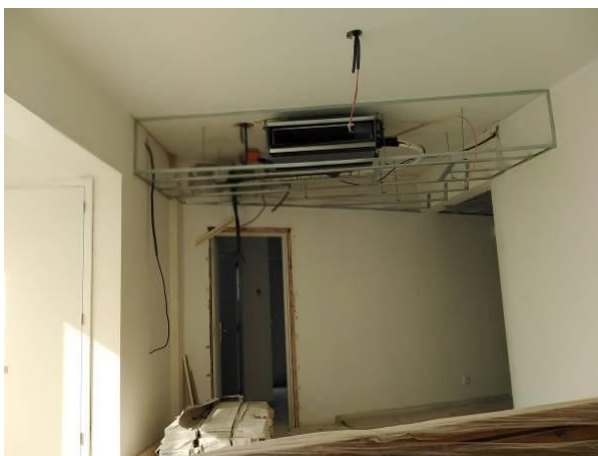
Figura 4.147 - Aspecto final de paredes interiores após barramento
