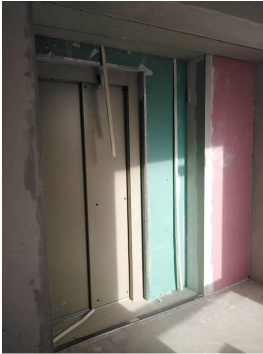
Figura 3.178 - Trabalhos de acabamento após montagem de elevadores – colocação de placas de gesso cartonado
