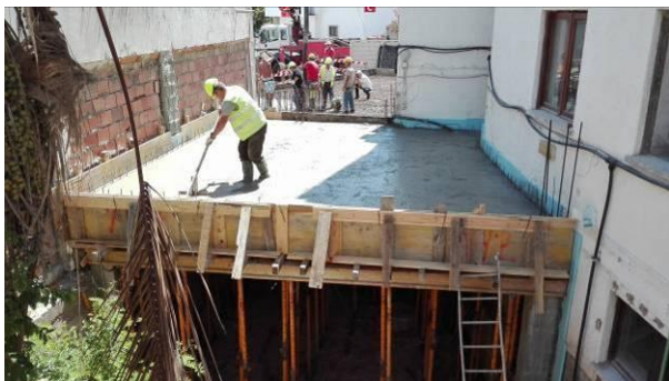
Figura 3.67 - Execução de betonagem de laje e vigas do piso 0
