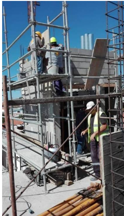
Figura 4.16 - Execução de alvenaria e vigas
