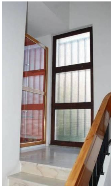
Figura 2.12 - Caixa de elevador existente vista pela caixa de escada
