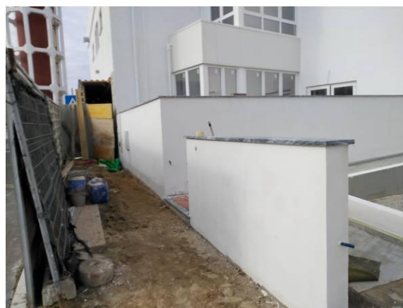
Figura 3.167 - Capeamentos no terraço frontal da torre do elevador em mármore cinza
