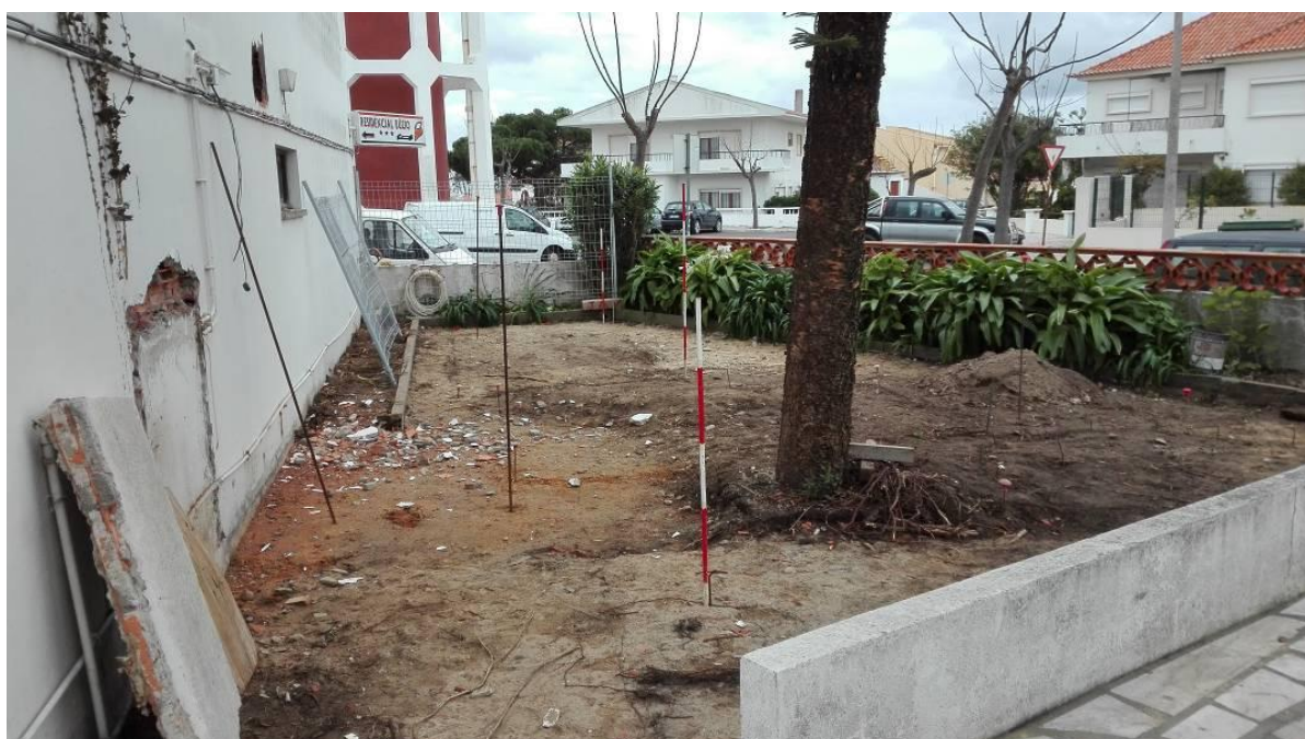
Figura 5.2 - Limpeza e marcação da implantação da zona técnica
