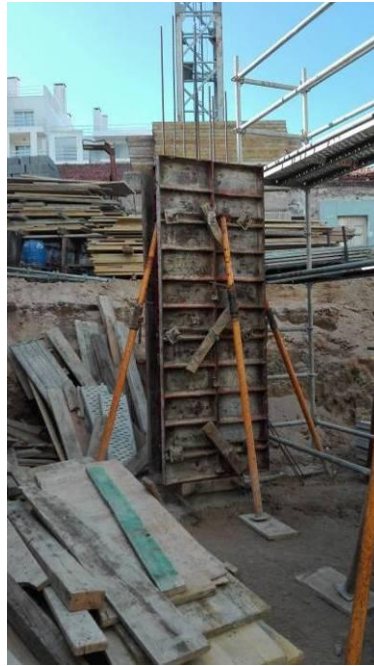
Figura 3.51 – Execução dos pilares do piso -1 – execução da cofragem
