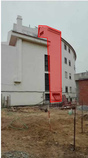
Figura 2.11 - Caixa de elevador existente vista pelo exterior
