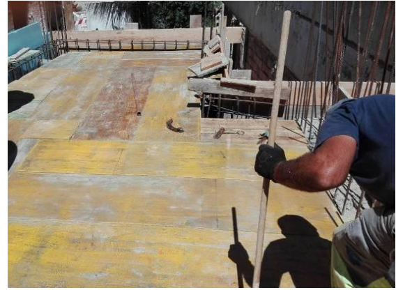
Figura 3.77 - Execução da cofragem de laje e vigas do piso 1
