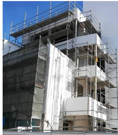
Figura 3.143 - Execução de revestimento exterior da estrutura das rampas metálicas
