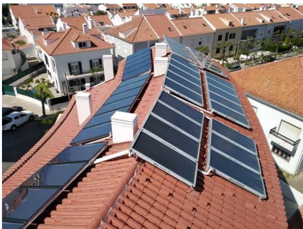
Figura 4.192 - Aspecto final da cobertura
