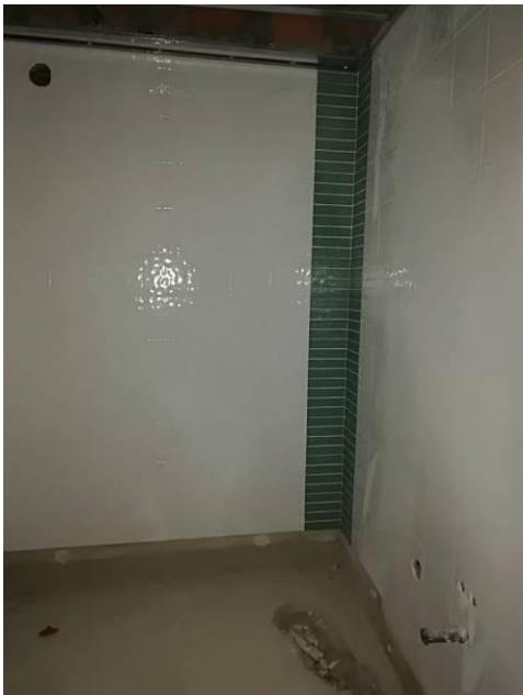
Figura 4.23 - Aplicação de impermeabilização nas instalações sanitárias
