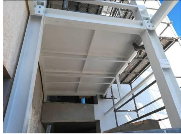
Figura 3.141 - Execução de estrutura das rampas metálicas
