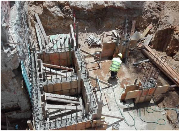
Figura 3.38 - Execução das fundações - torre do elevador
