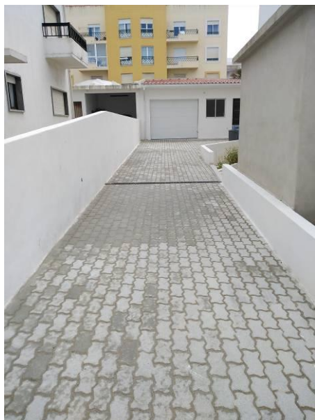
Figura 5.36 - Aspecto final do acesso à garagem e ao monta-cargas
