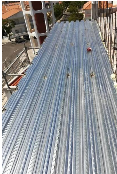
Figura 4.227 - Ampliação do piso 2 e 3 no alçado sudoeste - montagem da chapa colaborante
