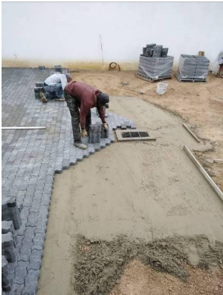
Figura 5.47 - Colocação do pavê
