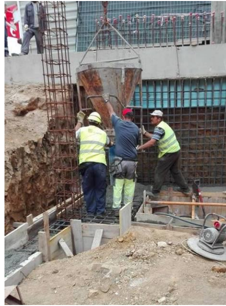
Figura 3.44 - Execução do muro de suporte de forma faseada e fundações do piso -1
