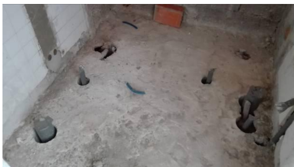
Figura 4.105 - Execução de nova rede de esgotos – IS dos Quartos – Vista superior
