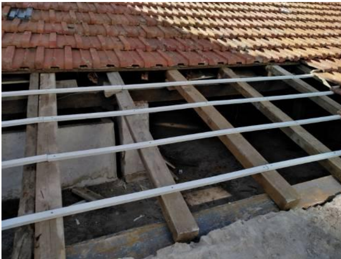
Figura 5.53- Beneficiação da cobertura dos edifícios vizinhos
