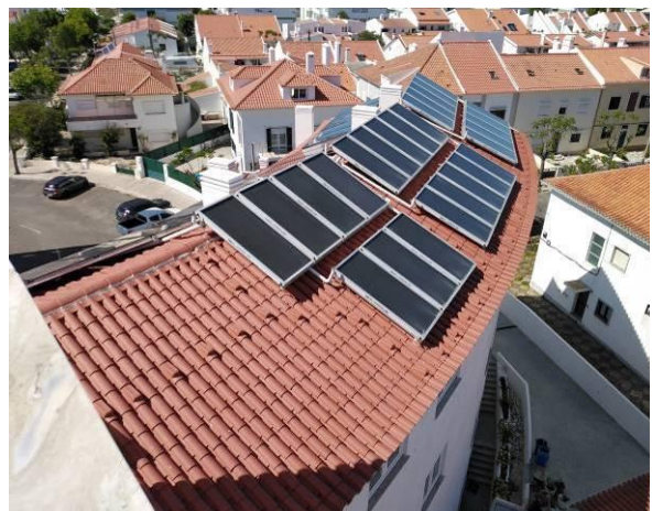
Figura 4.193 - Aspecto final da cobertura
