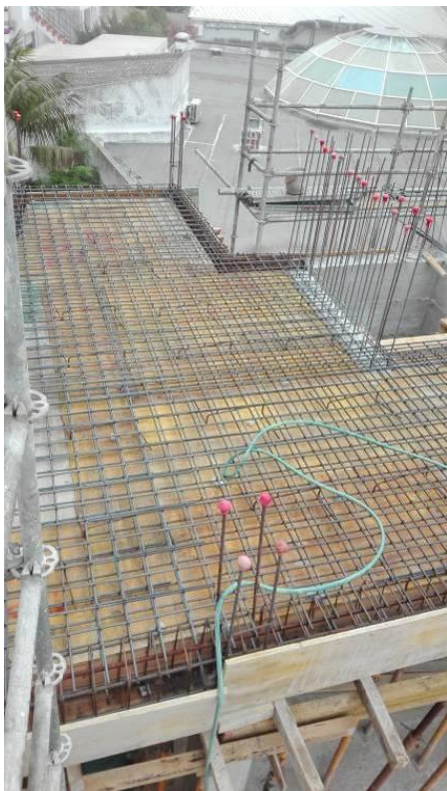
Figura 3.84 - Execução da armadura da laje e vigas do piso 2
