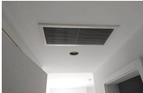
Figura 4.128 - Aspecto final após fecho de tectos e montagem das grelhas
