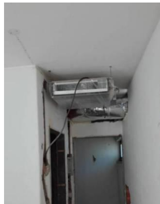
Figura 4.127- Instalação das máquinas de AVAC em quartos
