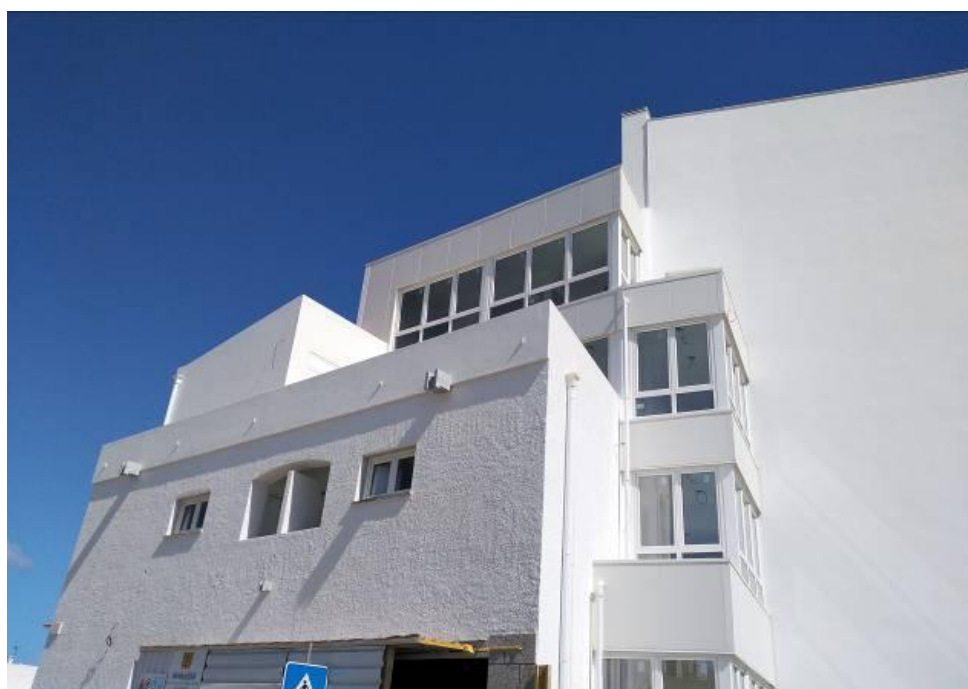
Figura 4.231 - Aspecto final da ampliação
