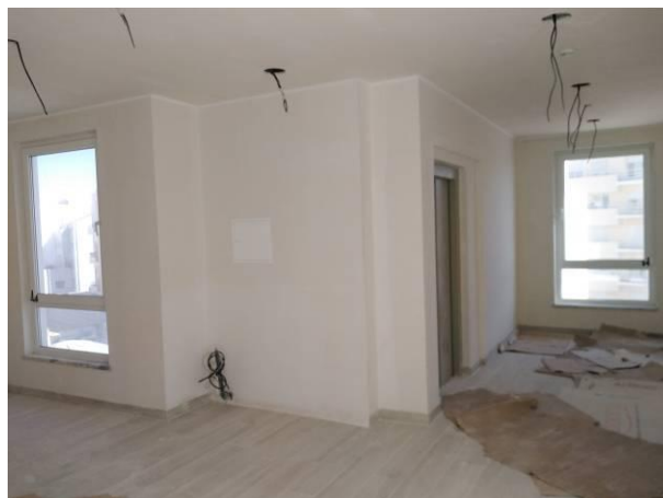
Figura 3.150 - Acabamento final após barramento de placa de gesso cartonado
