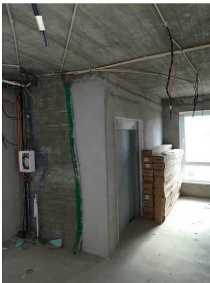
Figura 3.120 - Iluminação e quadro eléctricos parciais – passagem de cabos e colocação de caixas
