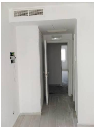
Figura 4.103 - Aspecto final após acabamento de tomadas e quadro parcial de quartos
