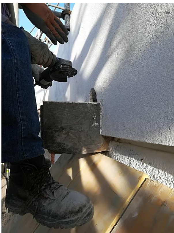
Figura 4.467 - Remoção das gárgulas
