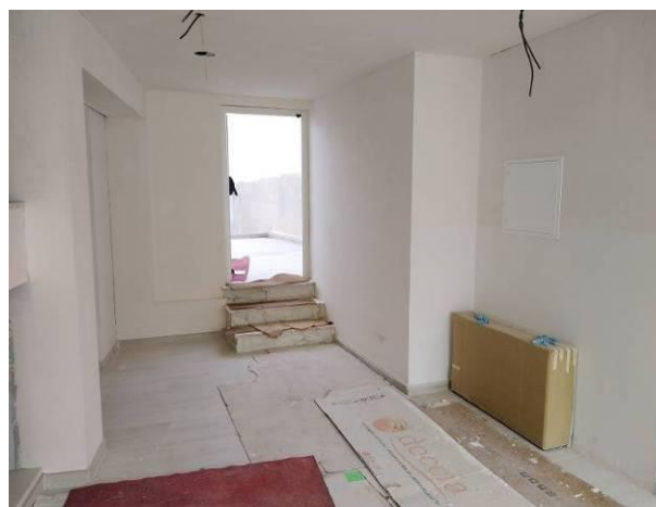
Figura 3.119 - Sistema de AVAC – equipamento de pavimento no piso 0 – aspecto final
