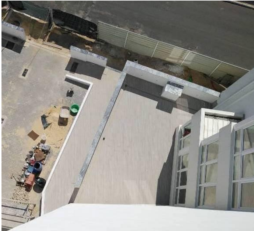
Figura 3.190 - Aspecto final do pátio e rampa de acesso no piso 0 da torre do elevador
