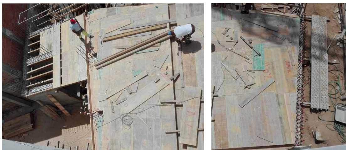
Figura 3.60 -Execução da cofragem de laje e vigas do piso 0
