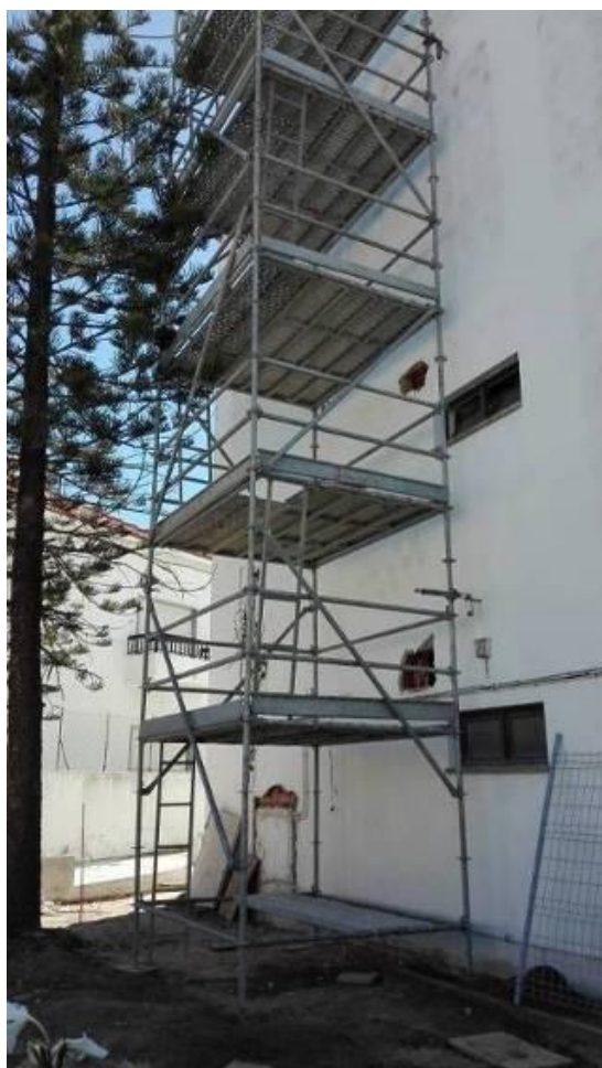
Figura 4.85 - Abertura de janelas e montagem de condutas
