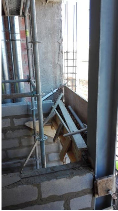
Figura 4.12 - Execução de alvenaria em blocos de betão nos vários pisos
