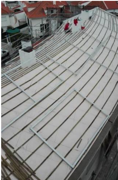
Figura 4.180 - Colocação do isolamento térmico
