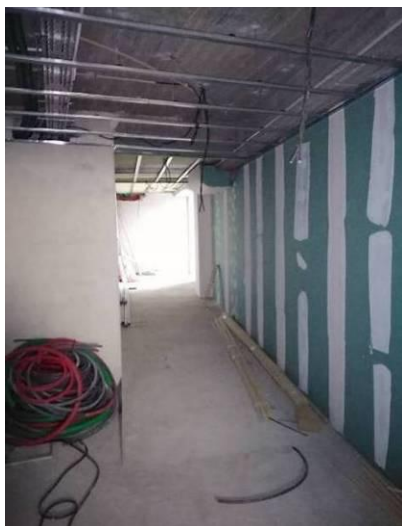
Figura 3.160 - Execução das paredes entre a torre de elevador e o edifício existente – colocação de placas de gesso cartonado
