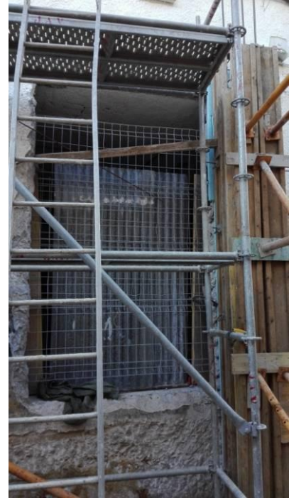
Figura 4.13 - Execução de alvenaria em blocos de betão nos vários pisos
