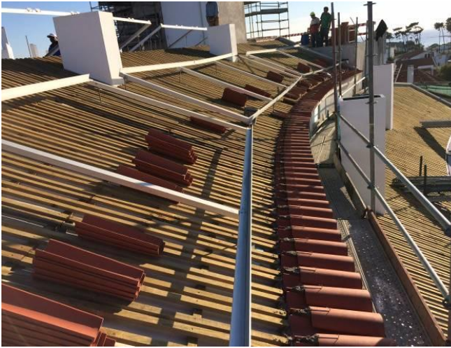
Figura 4.184 - Execução do beirado
