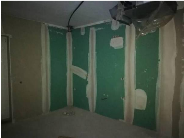
Figura 4.457 - Aplicação das placas de gesso cartonado
