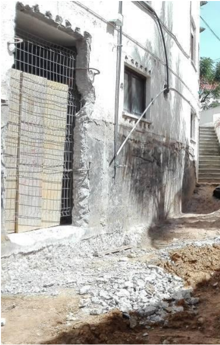
Figura 2.23 – Pormenor da parede em betão armado no piso -1
