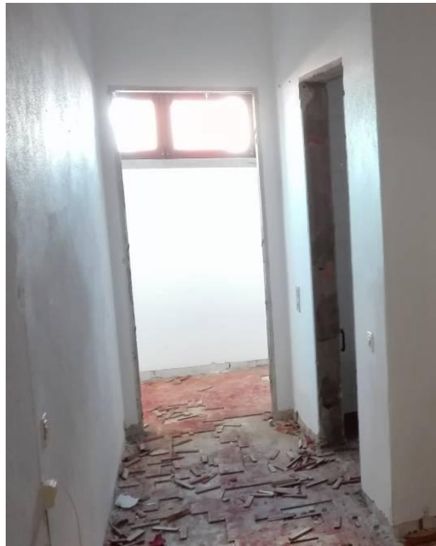
Figura 4.22 - Retirada de tapetes e tacos do corredor e dos quartos
