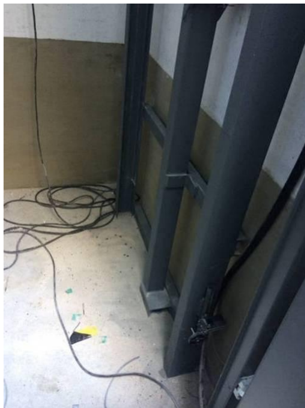
Figura 5.22 - Montagem do equipamento elevatório
