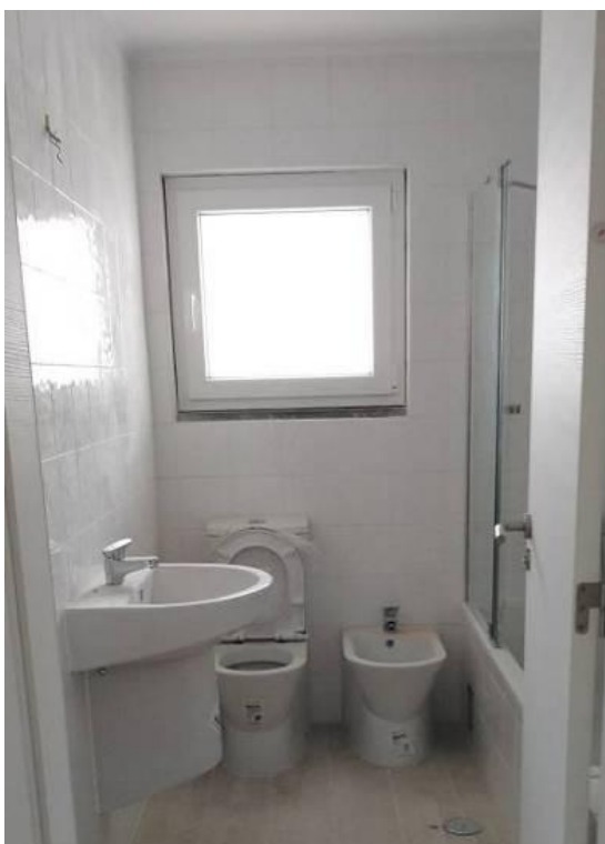
Figura 4.41 - Instalação das loiças
