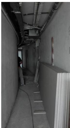
Figura 4.149- Colocação de placas de gesso cartonado
