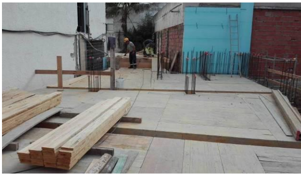
Figura 3.61 - Execução da cofragem de laje e vigas do piso 0
