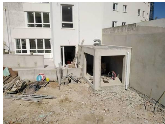
Figura 5.70 - Execução da estrutura do edifício do gerador
