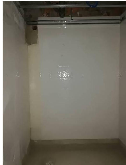
Figura 4.24 - Aplicação de impermeabilização nas instalações sanitárias
