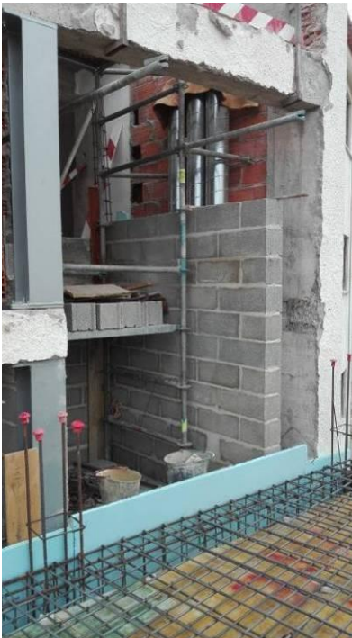
Figura 4.14 - Execução de alvenaria e vigas
