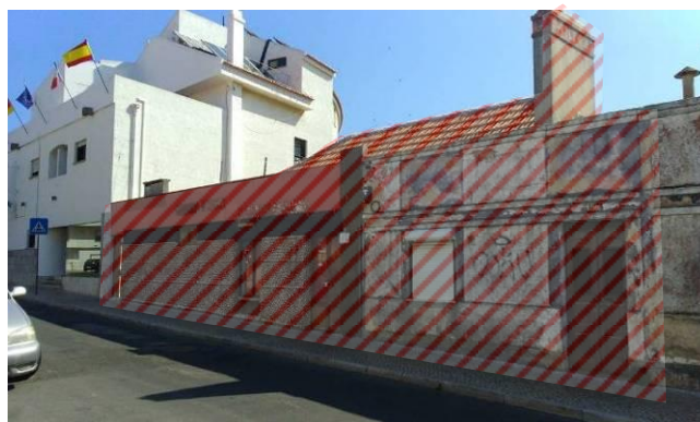
Figura 3.6 – Zona a demolir no alçado oeste
