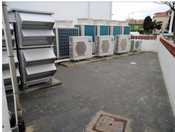
Figura 5.6 - Aspecto final na zona técnica
