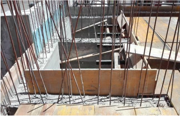
Figura 3.76 -Execução da cofragem de laje e vigas do piso 1
