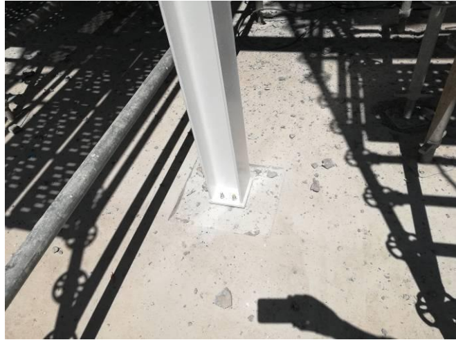
Figura 4.225 - Ampliação do piso 2 e 3 no alçado sudoeste - montagem de pilares e vigas
