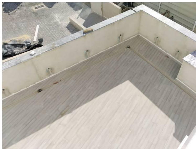
Figura 3.152 - Assentamento do pavimento cerâmico no exterior da torre de elevador
