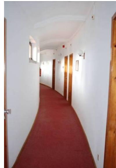
Figura 2.16 - Corredor do piso 3
