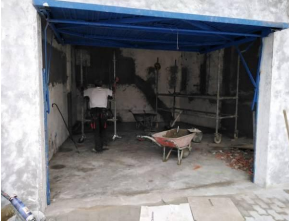
Figura 5.27- Reparação de paredes interiores
