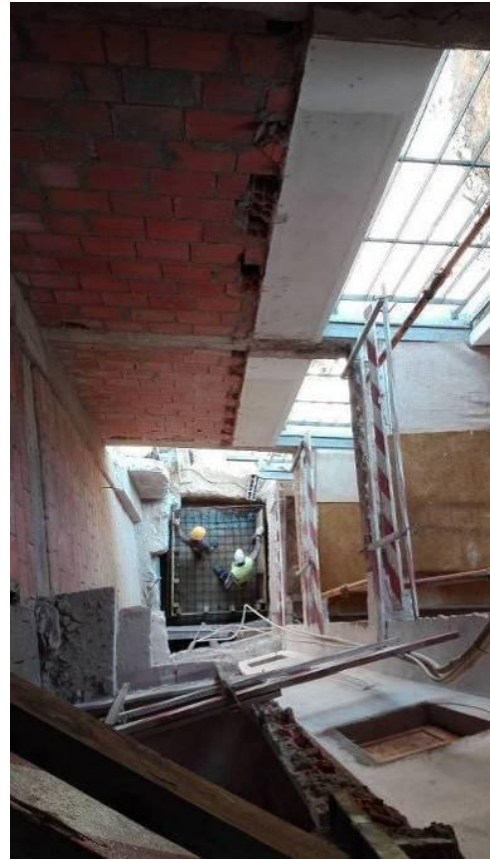
Figura 4.7 - Execução da caixa de elevador no edifício existente – cofragem e armadura do poço do elevador
