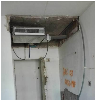
Figura 4.126 - Instalação das máquinas de AVAC em quartos
