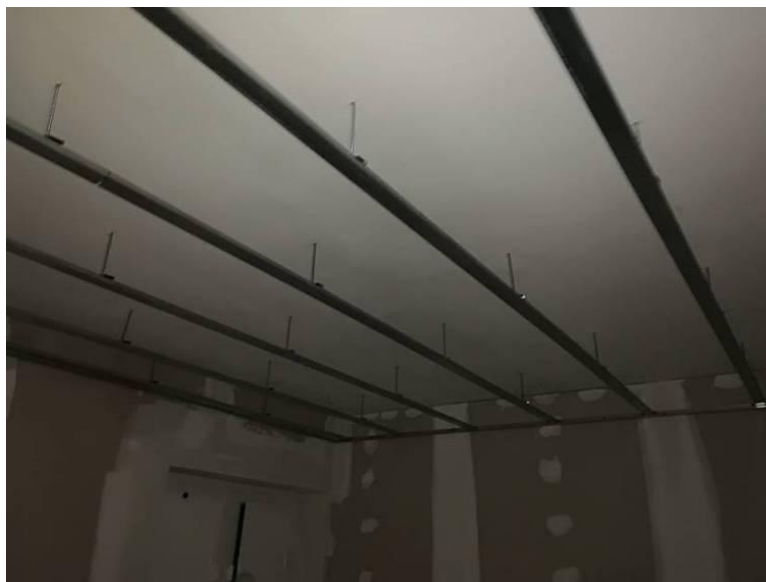
Figura 4.82 - Colocação da estrutura – Execução dos tetos falsos
