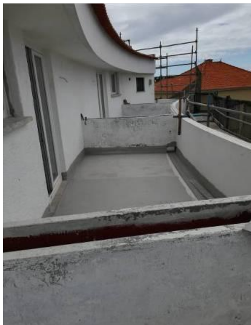
Figura 4.196 - Aplicação da impermeabilização nos terraços
