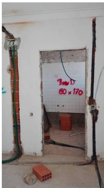
Figura 4.97 - Passagem de tubagem para as instalações eléctricas e ITED
