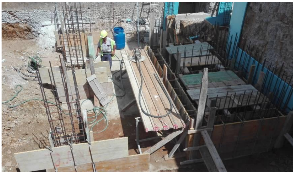
Figura 3.47 - Execução do poço dos elevadores – Fase de colocação e armação de armadura e cofragens concluídas
