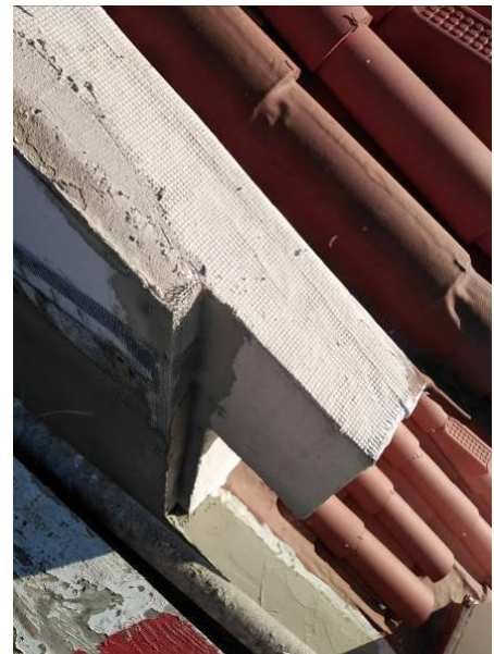
Figura 4.465 - Execução de sistema ETIC – zona de cobertura
