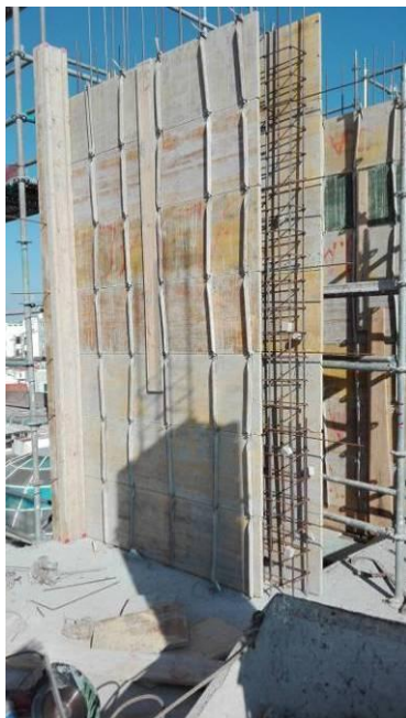
Figura 3.91 - Execução da cofragem, armadura da caixa do elevador do piso 3
