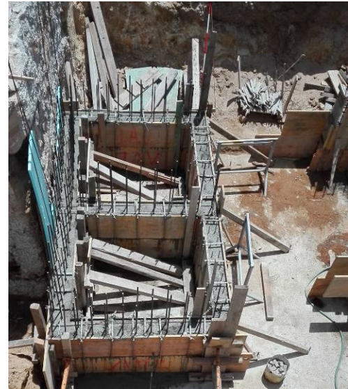
Figura 3.49 – Execução do poço dos elevadores – preparação e após a betonagem
