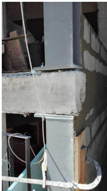
Figura 4.9 - Execução do reforço com pilares metálicos
