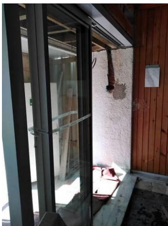
Figura 4.53 - Montagem da porta automática
