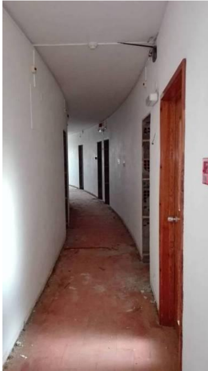
Figura 4.21 - Retirada de tapetes e tacos do corredor e dos quartos
