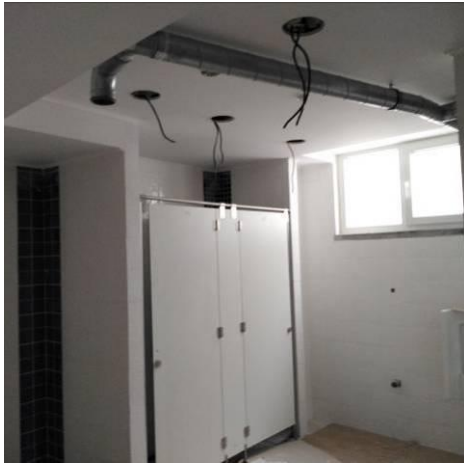
Figura 4.161 - Balneário masculino no piso -1
