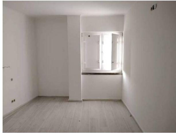
Figura 4.48 - Aspecto final após montagem das caixilharias em PVC – demonstração dos veda-luz fechados
