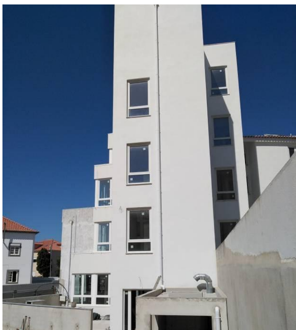
Figura 3.181 - Aspecto final da caixilharia em PVC - lado exterior e interior na torre do elevador
