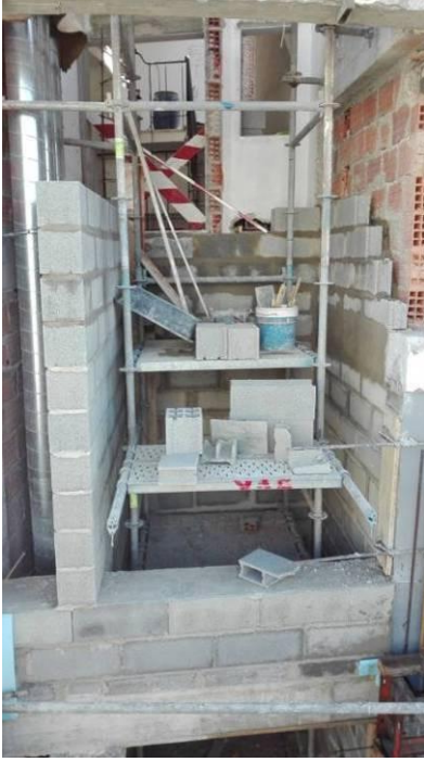
Figura 4.11 - Execução de alvenaria em blocos de betão nos vários pisos
