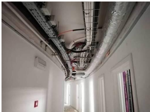
Figura 4.124 - Instalação das condutas do AVAC
