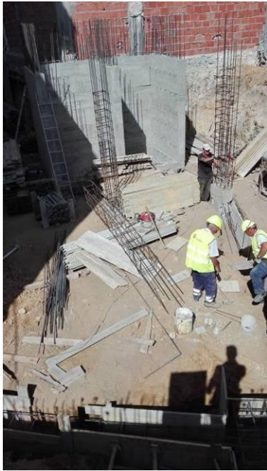
Figura 3.50 -Execução dos pilares do piso -1 – execução da armadura
