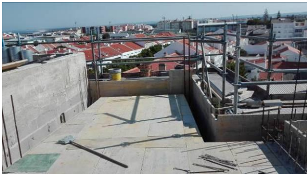
Figura 3.103- Execução da cofragem, armadura da laje de cobertura
