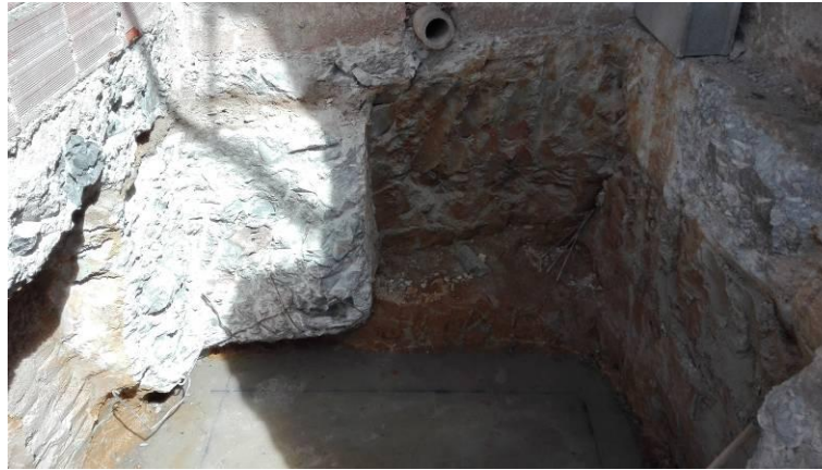
Figura 2.24 – Pormenor da sapata de betão no piso -1
