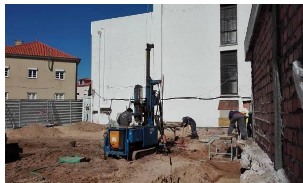
Figura 3.13 – Execução das sondagens
