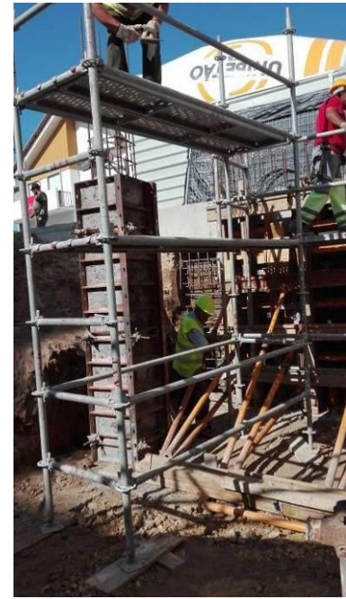
Figura 3.52 – Execução dos pilares do piso -1 – execução da betonagem
