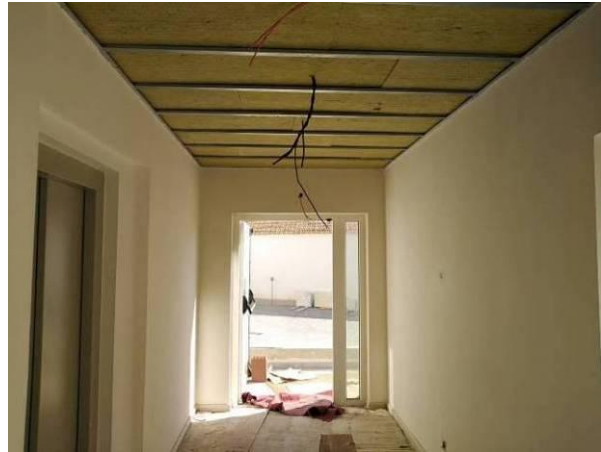
Figura 3.157 - Acabamento após finalização do barramento fino
