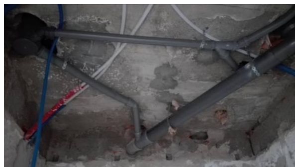
Figura 4.106 - Execução de nova rede de esgotos – IS dos Quartos – Vista inferior
