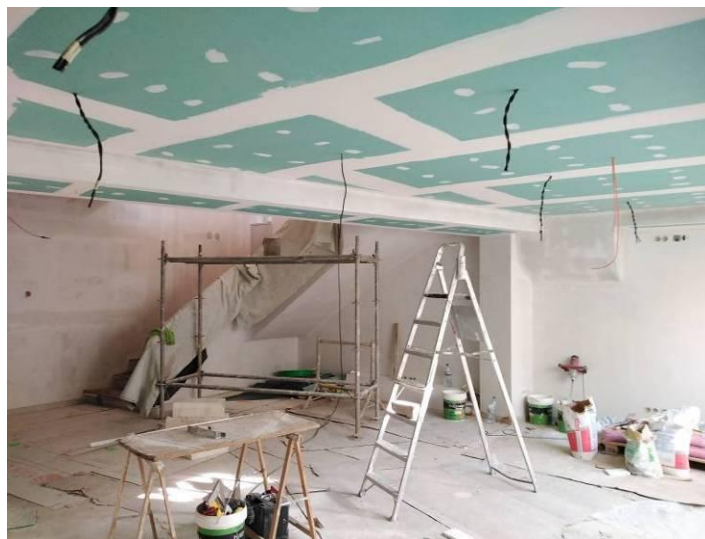
Figura 4.84 - Colocação de placas de gesso cartonado hidrófugo no Piso -1
