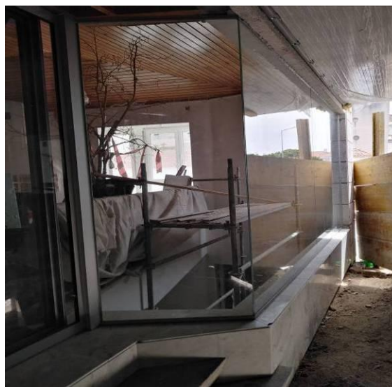
Figura 4.56 - Aspecto final do painel visto pelo exterior
