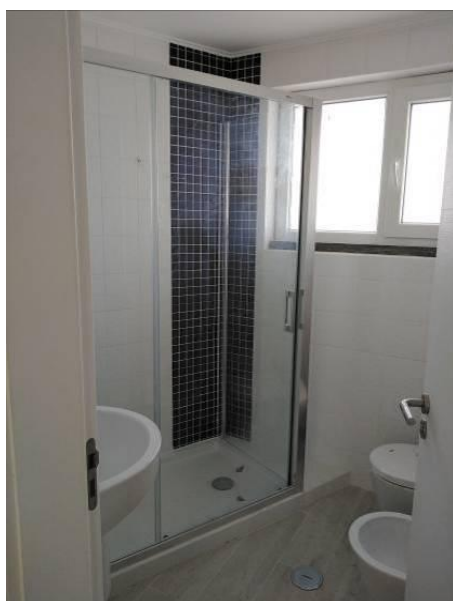
Figura 4.156 - Aspecto final após aplicação do azulejo
