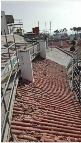
Figura 4.178 - Retirada da cobertura em telha cerâmica
