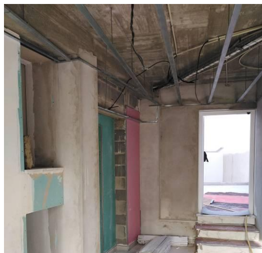
Figura 3.148 - Colocação da estrutura – execução dos tectos falsos
