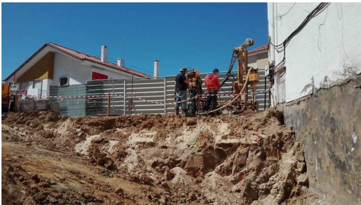
Figura 3.17- Execução das microestacas
