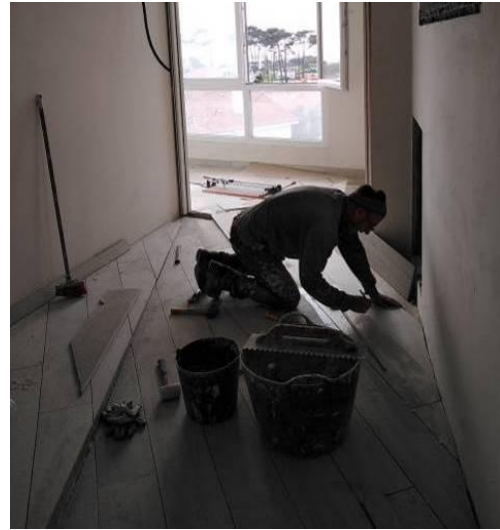
Figura 4.26 - Colocação do pavimento cerâmico no interior
