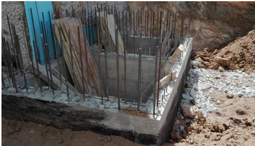
Figura 3.50 - Execução do poço dos elevadores - Fase após a descofragem
