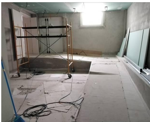
Figura 4.441 - Aspecto final da rampa para acesso à lavandaria
