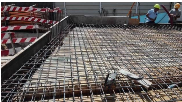
Figura 3.63 - Execução da armadura de laje e vigas do piso 0
