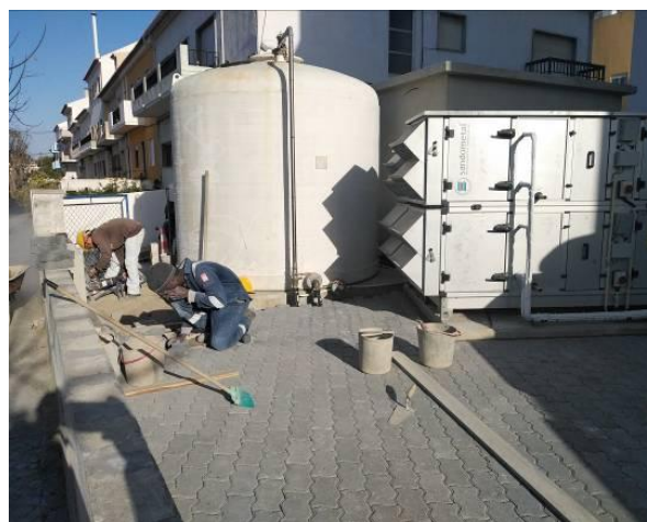
Figura 5.4 - Aplicação do enrocamento e pavê na zona técnica
