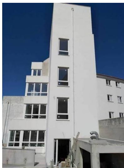
Figura 3.155 - Aspecto final após as pinturas exteriores
