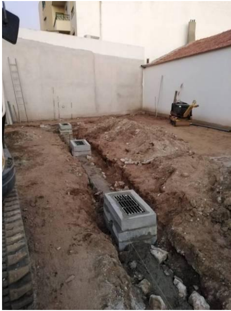
Figura 5.41 - Execução da rede de drenagem pluvial do estacionamento
