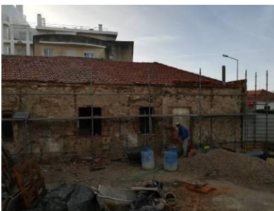
Figura 5.55 - Beneficiação de fachada posterior dos edifícios vizinhos – picagem
