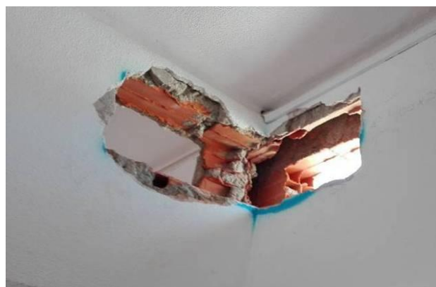
Figura 4.123 - Execução de carotes/janelas para passagem de instalações do AVAC
