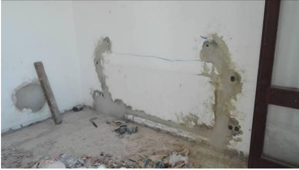
Figura 4.98- Fecho de roços para instalações eléctricas e ITED
