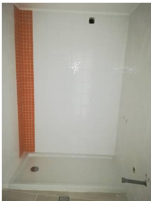
Figura 4.42 - Instalação das bases de duche
