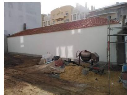
Figura 5.57 - Beneficiação de fachada posterior dos edifícios vizinhos – acabamento final
