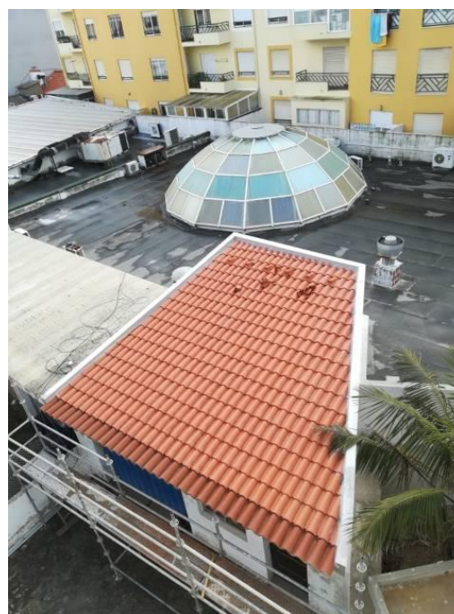
Figura 5.26- Execução de nova cobertura da garagem
