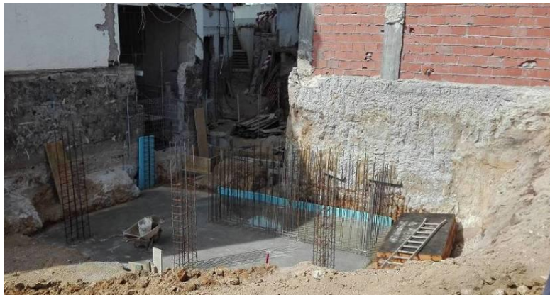
Figura 3.35 - Sapata torre do elevador após a betonagem
