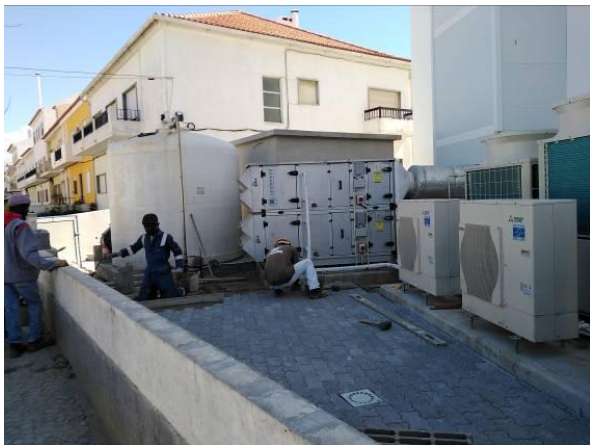
Figura 5.5 - Colocação de pavê na zona técnica
