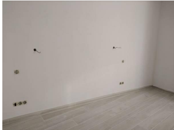
Figura 4.458 - Aspecto final após barramentos
