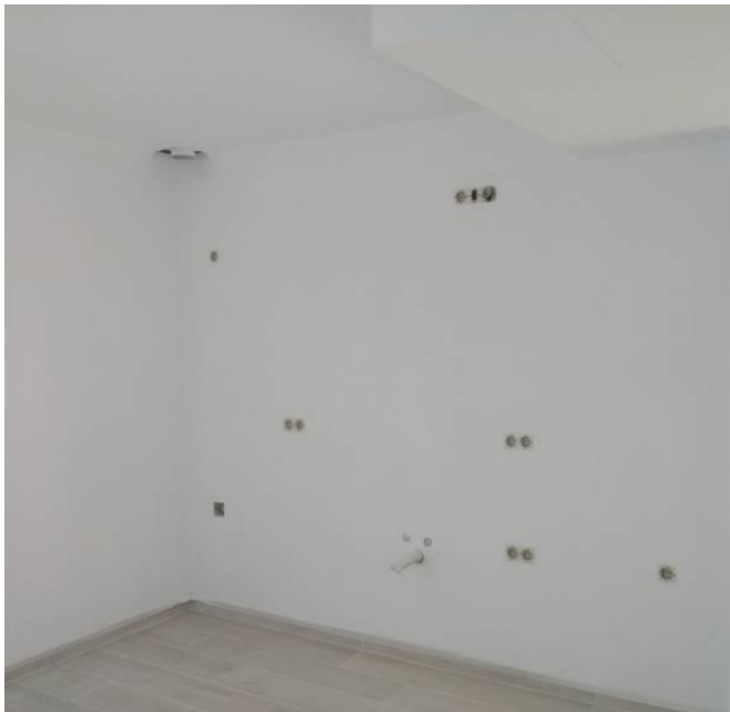
Figura 4.77 - Preparação das instalações para cozinha do quarto 205
