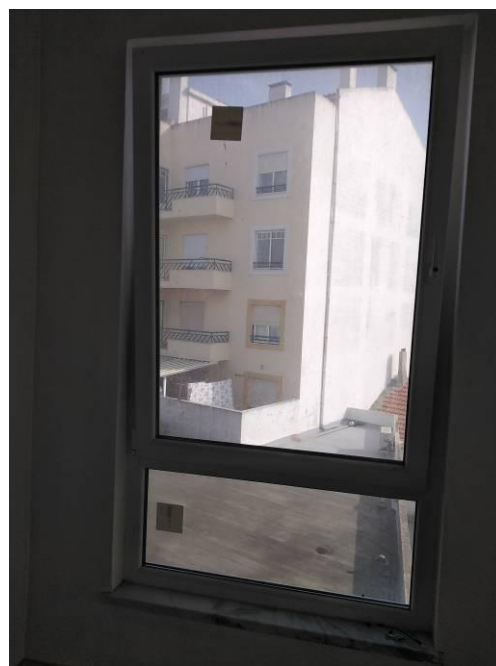
Figura 3.182 - Aspecto final da caixilharia em PVC - lado exterior e interior na torre do elevador
