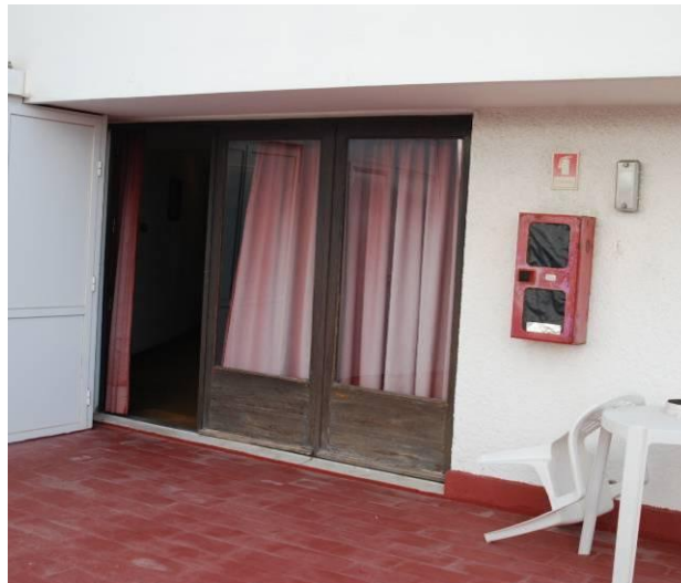
Figura 2.38 – Caixilharia exterior – Porta do terraço no piso 2
