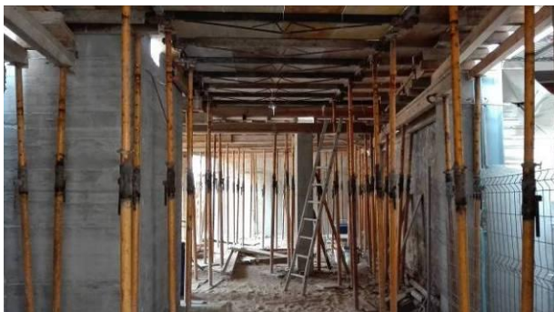
Figura 3.65 - Execução da betonagem (Escoramento) de laje e vigas do piso 0
