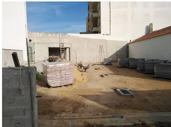
Figura 5.46 - Preparação de cotas para assentamento do pavê no parque de estacionamento
