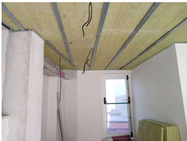
Figura 3.149 - Colocação da lã mineral
