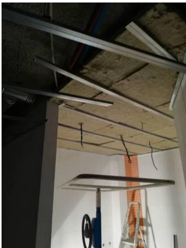
Figura 4.459 - Execução de isolamentos nos tectos entre pisos
