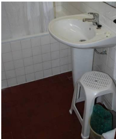
Figura 2.31 – Pavimentos das IS dos quartos em cerâmico
