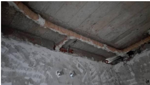
Figura 4.111 - Desativação da rede de águas existente
