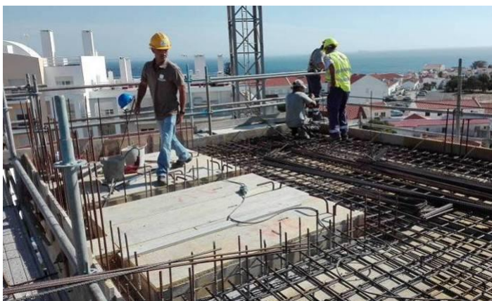
Figura 3.105 - Execução da cofragem, armadura da laje de cobertura
