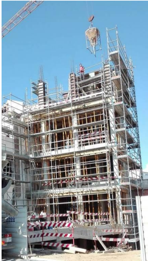
Figura 3.93 - Execução da cofragem, armadura e betonagem dos pilares e caixa do elevador do piso 3
