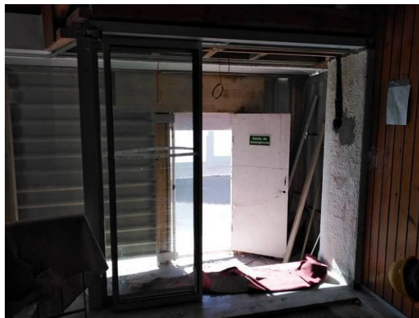
Figura 4.54 - Montagem da porta automática
