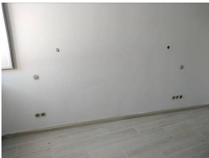
Figura 4.104- Aspecto final após acabamento de tomadas e quadro parcial de quartos
