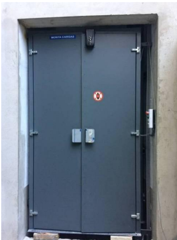
Figura 5.21- Montagem do equipamento elevatório
