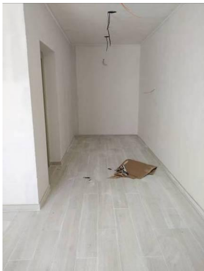
Figura 3.122 - Iluminação – aspecto final no piso 4
