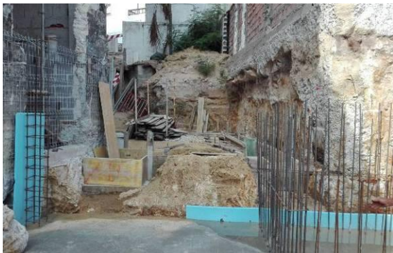
Figura 3.36 - Execução de fundações - torre do elevador e da zona de expansão
