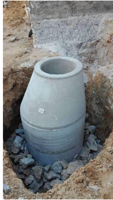
Figura 3.114 - Traçado da rede periférica e execução de poço drenante
