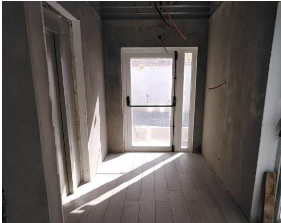
Figura 3.156 - Acabamento após finalização do reboco areado
