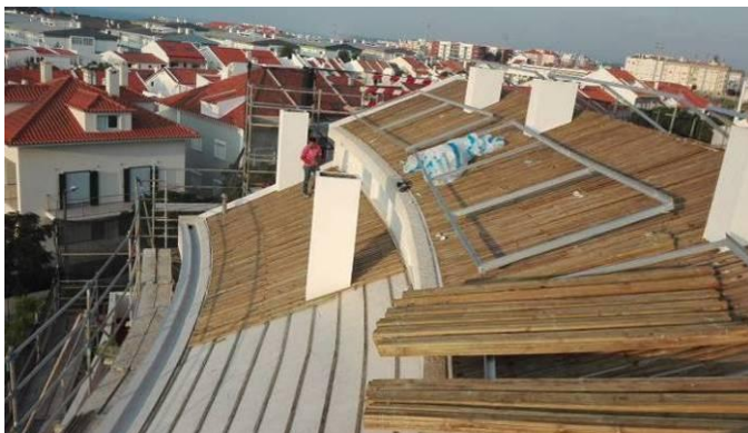
Figura 4.182 - Colocação do ripado e contra ripado
