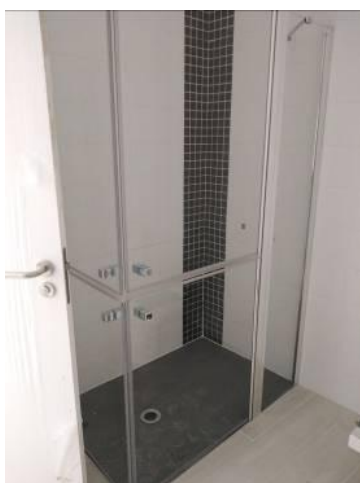
Figura 4.174 - Aspeto final da IS do quarto
