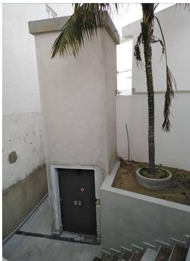
Figura 5.24 - Aspecto final do monta-cargas
