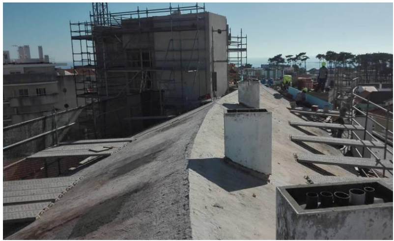
Figura 4.179 - Retirada da cobertura em telha cerâmica
