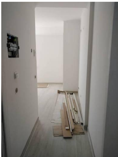
Figura 4.172 - Aspecto final da entrada do quarto 301
