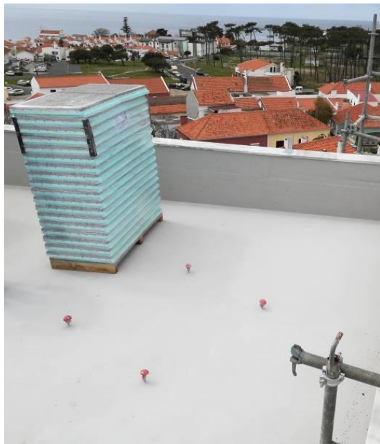
Figura 3.184 - Aplicação de impermeabilização
