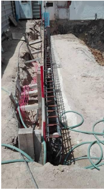
Figura 3.20 - Execução das microestacas e da viga de coroamento
