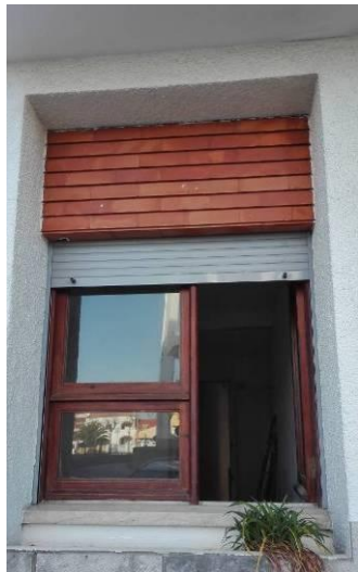
Figura 2.37 – Caixilharia exterior – Janela do piso 0
