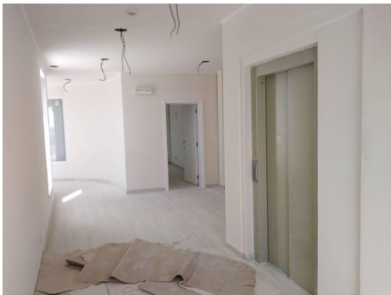
Figura 3.193 - Aspecto final do átrio dos elevadores no piso 3
