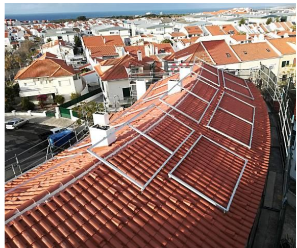
Figura 4.189 - Execução da cumeeira
