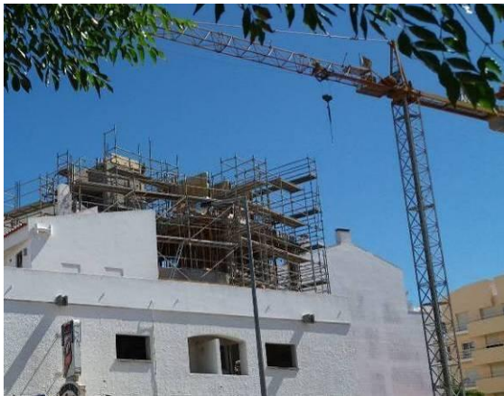
Figura 4.208 - Zona de acesso da torre de elevador ao edifício existente
