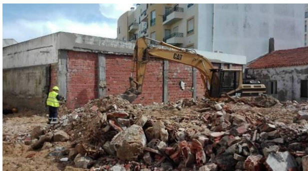
Figura 3.9 – Execução da demolição com o apoio de meios mecânicos
