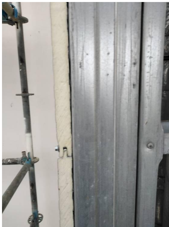
Figura 4.92 - Revestimento de estrutura
