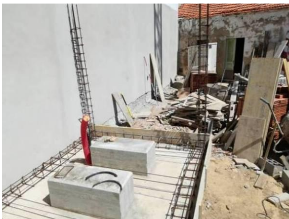
Figura 5.69 - Execução da estrutura do edifício do gerador
