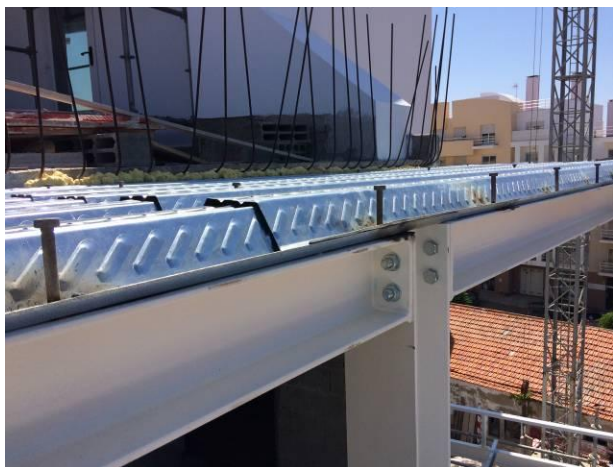
Figura 4.229 - Ampliação do piso 2 e 3 no alçado sudoeste - montagem de chapa colaborante
