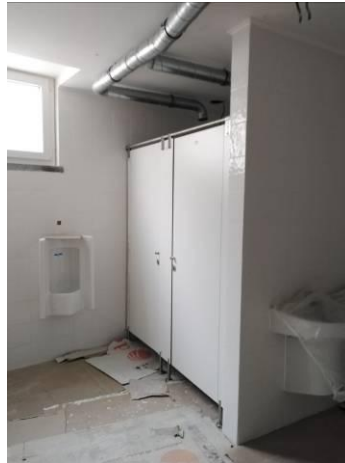
Figura 4.162 - Balneário masculino no piso -1
