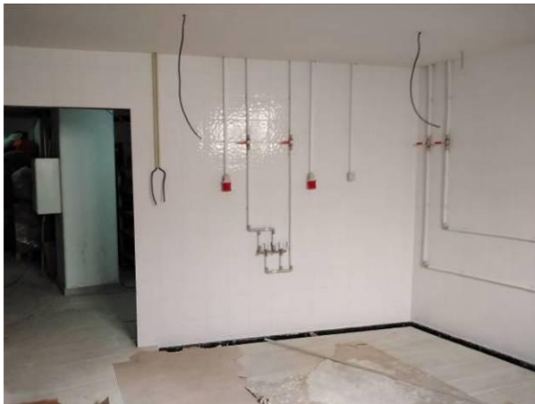
Figura 4.166 - Aspecto final da lavandaria
