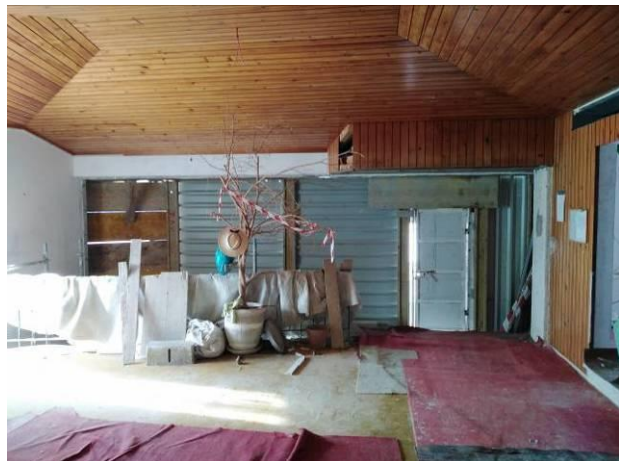
Figura 4.50 - Aspecto de porta principal e do painel de vidro antes da intervenção após retirada da porta e dos painéis de vidro
