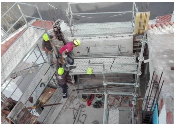
Figura 4.210 - Zona de acesso da torre de elevador ao edifício existente – execução da armadura, cofragem e betonagem dos pilares
