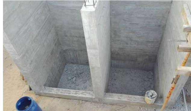
Figura 3.56 - Execução da caixa de elevadores no piso -1 após a descofragem
