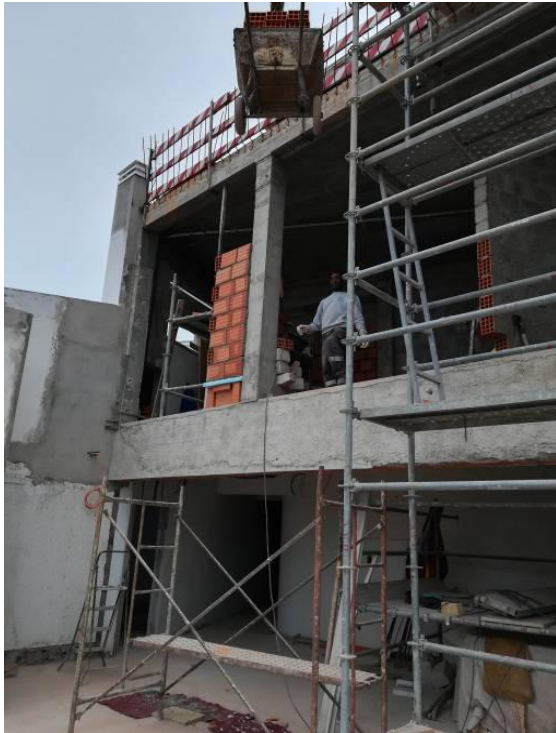
Figura 4.220 - Ampliação do piso 2 e 3 no alçado sudoeste - aspeto antes da montagem da estrutura metálica
