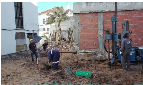
Figura 3.12 – Execução das sondagens
