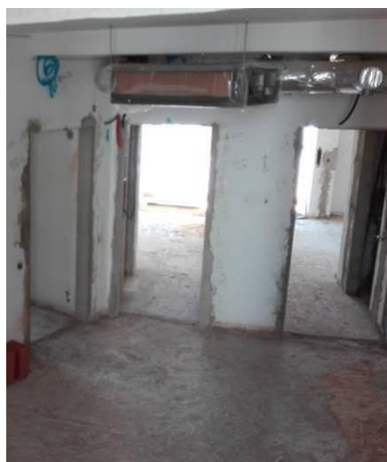
Figura 4.59 - Alargamento de ombreiras e vergas para receber novas portas
