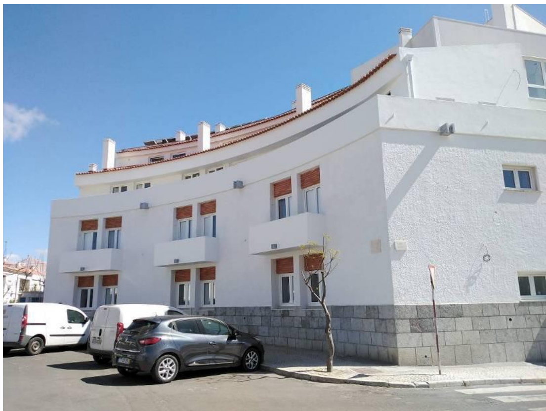
Figura 4.469 - Aspecto final após a intervenção nas gárgulas
