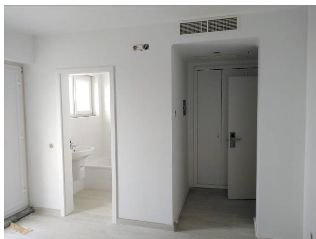
Figura 4.155 - Aspecto final após a pintura
