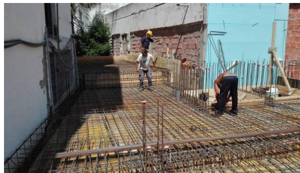
Figura 3.64 - Execução da armadura de laje e vigas do piso 0
