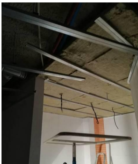
Figura 4.83 - Colocação de lâ mineral no Piso -1
