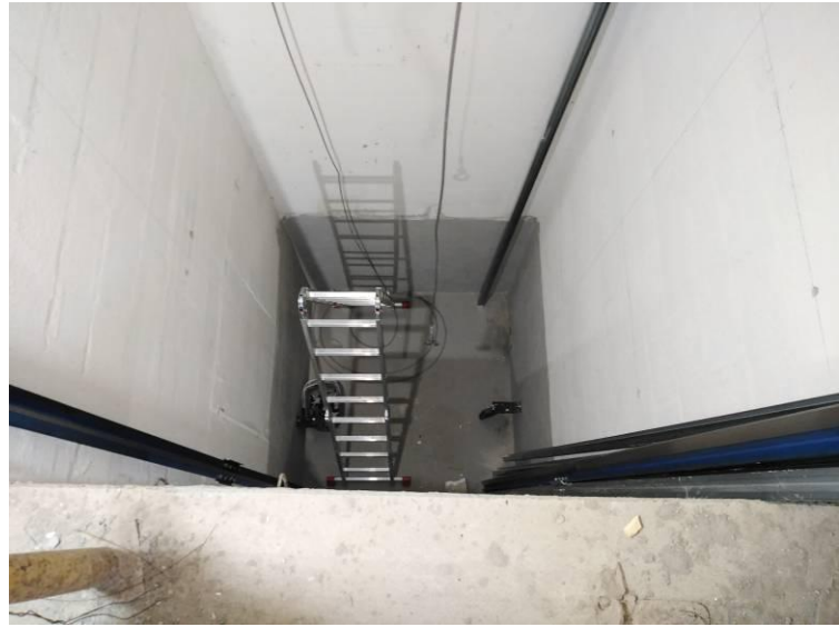
Figura 3.175 - Montagem dos elevadores- colocação de guias
