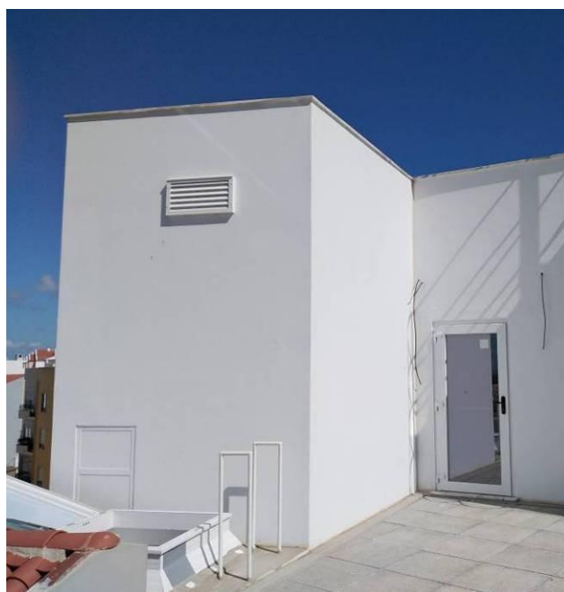
Figura 4.20 - Reboco exterior e aspecto final após pintura
