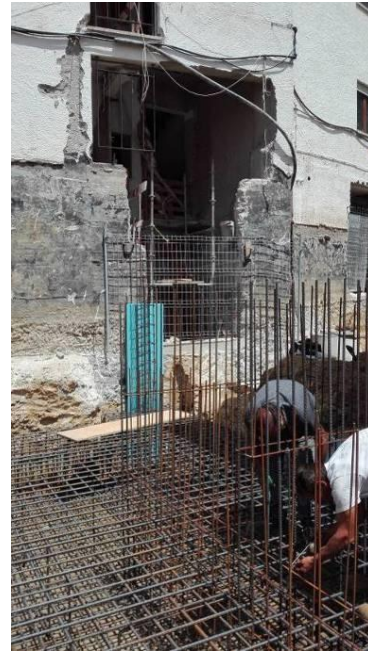
Figura 3.33 - Execução da armadura – sapata torre do elevador
