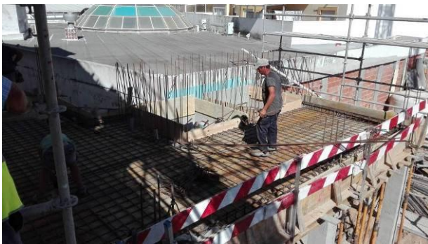
Figura 3.78 - Execução da armadura e betonagem de laje e vigas do piso 1
