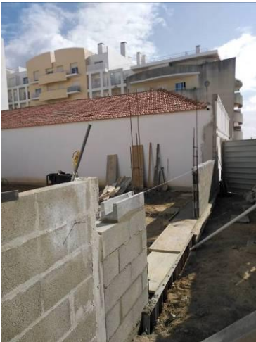
Figura 5.49 - Execução de alvenaria em blocos no muro exterior
