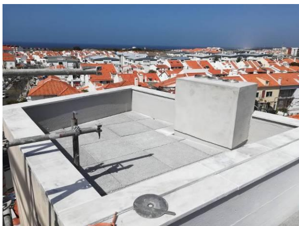
Figura 3.186 - Acabamento final do sistema
