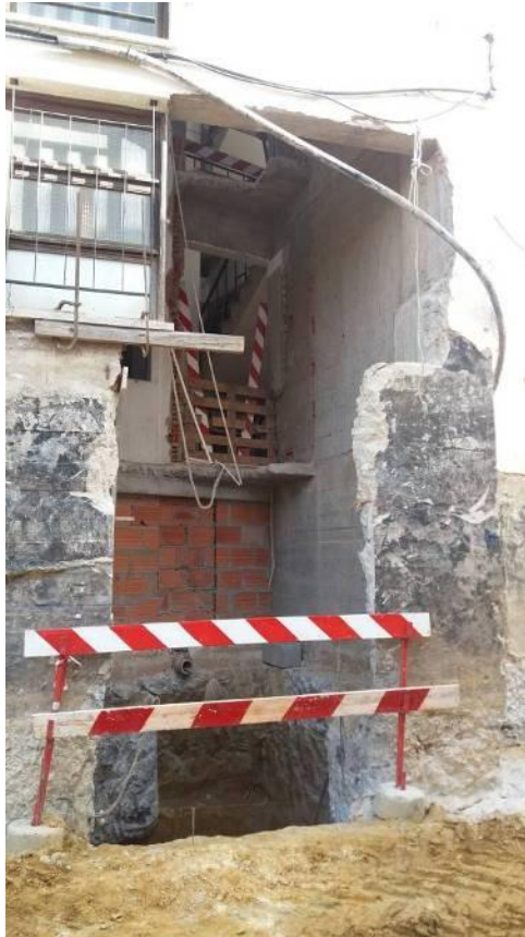
Figura 4.6- Execução da caixa de elevador no edifício existente – demolição da parede exterior, escavação do poço do elevador
