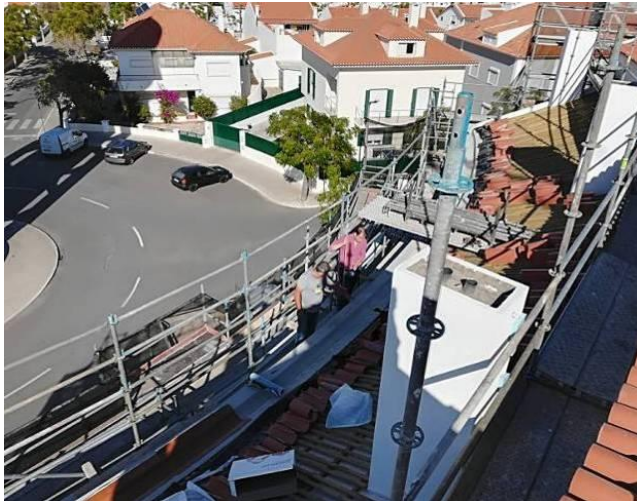
Figura 4.190 - Execução de caleira interior
