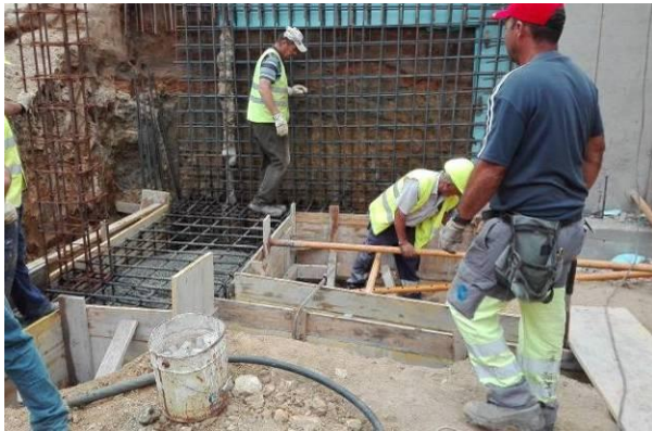
Figura 3.45 - Execução do muro de suporte de forma faseada e fundações do piso -1
