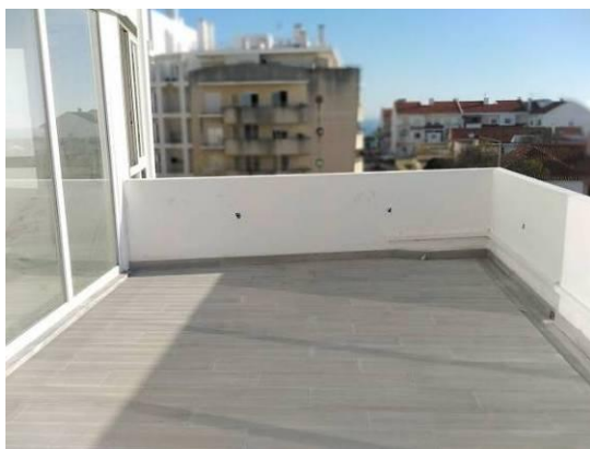
Figura 4.29 - Aspecto final dos pavimentos exteriores
