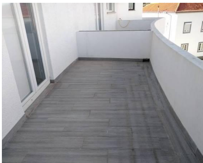
Figura 4.199 - Revestimento dos terraços em pavimento cerâmico
