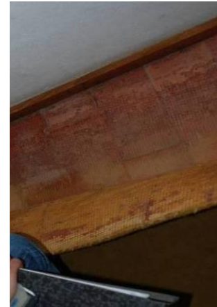
Figura 2.33 – Pavimentos dos corredores em alcatifa e tacos de madeira
