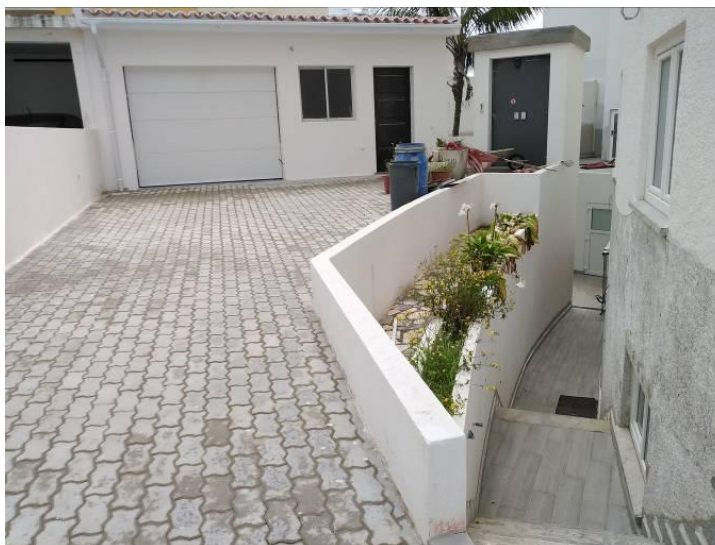
Figura 5.37 - Aspecto final do acesso à garagem e ao monta-cargas
