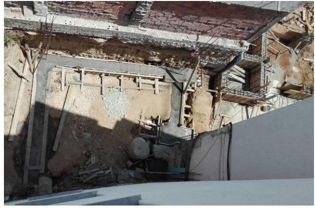
Figura 3.39 - Execução das fundações - da zona de expansão
