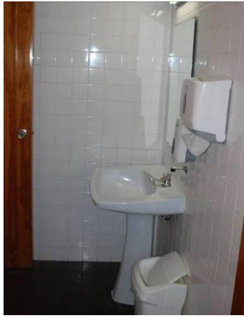
Figura 2.29 – Pavimentos IS masculina no piso -1
