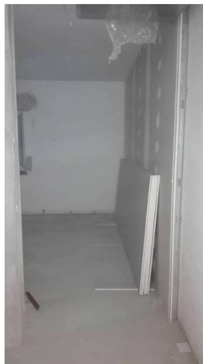
Figura 4.456 - Colocação de placas de gesso cartonado
