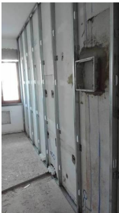
Figura 4.454 - Montagem de estrutura
