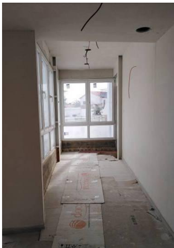
Figura 3.125 - Detectores de incêndio no tecto e iluminação de emergência – aspecto final
