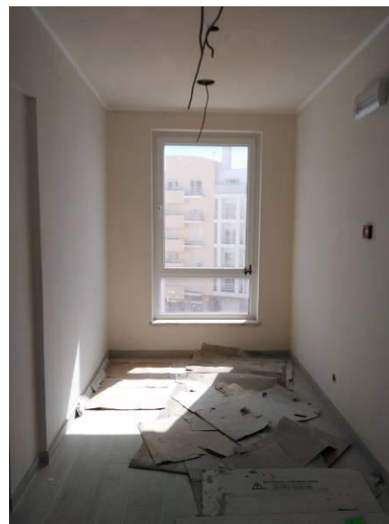
Figura 3.194 - Aspecto final do átrio dos elevadores no piso 3
