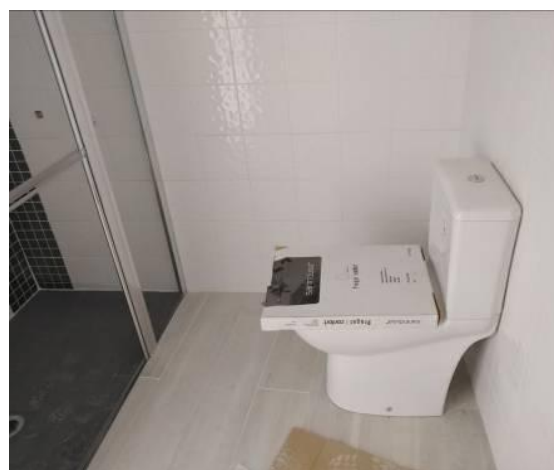
Figura 4.175 - Aspeto final da IS do quarto 301
