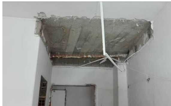
Figura 4.112 - Desativação da rede de águas existente
