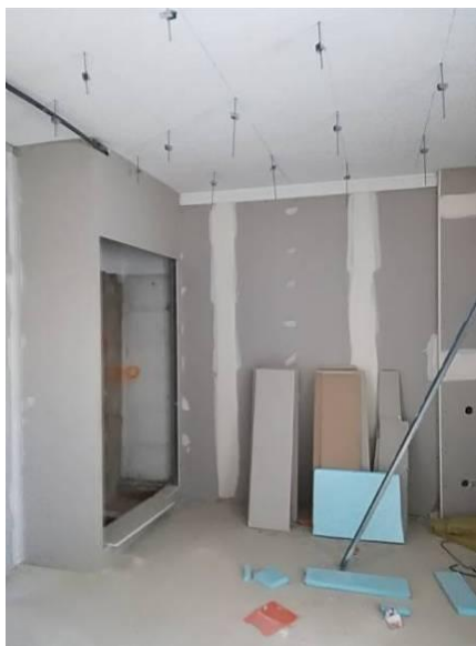
Figura 4.81 - Colocação da estrutura – Execução dos tetos falsos
