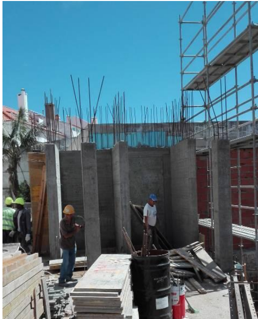
Figura 3.73 - Execução da descofragem dos pilares e da caixa do elevador do piso 0
