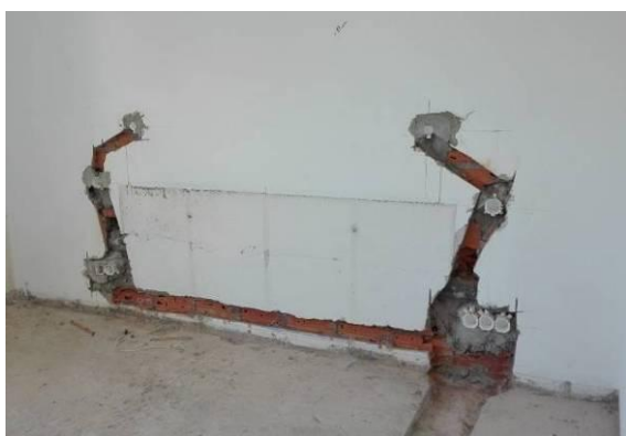
Figura 4.94 - Abertura de roços para as instalações eléctricas e ITED
