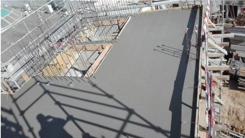
Figura 3.86 - Execução da betonagem da laje e vigas do piso 2
