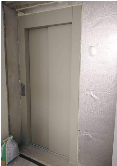
Figura 3.176 - Montagem dos elevadores – portas nos pisos
