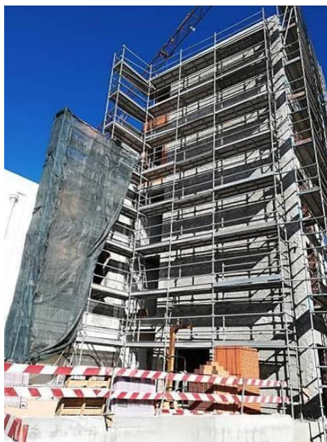
Figura 3.153 – Execução do reboco exterior
