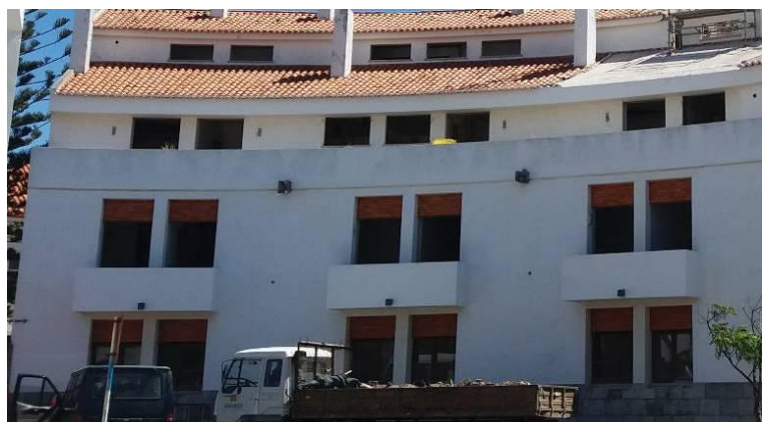
Figura 4.45 - Retirada das caixilhariias de madeira
