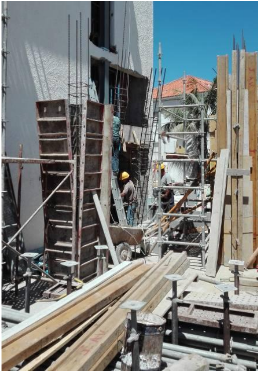
Figura 3.69 Execução de armadura e cofragem dos pilares do piso 0
