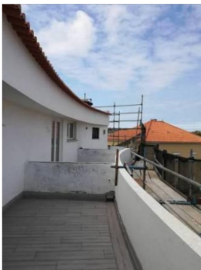
Figura 4.198 - Revestimento dos terraços em pavimento cerâmico
