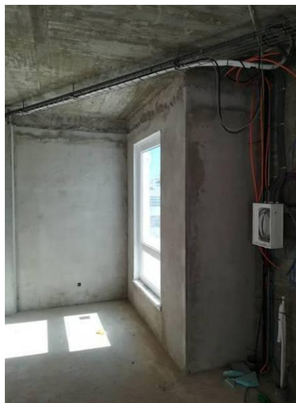
Figura 3.121 - Iluminação e quadro eléctrico parcial – passagem de cabos e colocação de caixas
