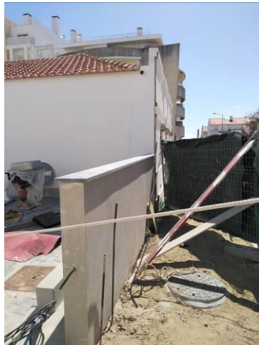
Figura 5.50 - Reboco e colocação de capeamento no muro exterior
