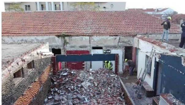
Figura 3.7 – Execução da demolição manual
