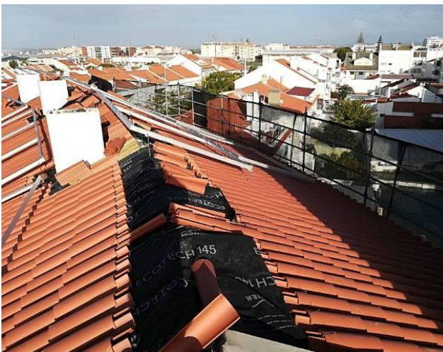
Figura 4.188 - Execução da cumeeira
