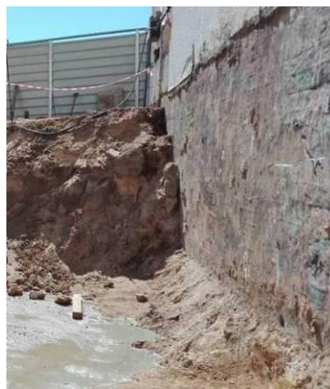
Figura 2.22 – Parede exterior do piso -1 em betão armado com a impermeabilização asfáltica
