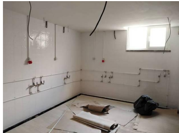
Figura 4.167 - Aspecto final da lavandaria
