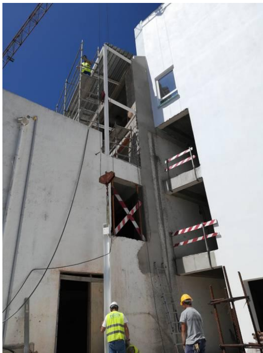
Figura 3.138 - Execução de estrutura das rampas metálicas
