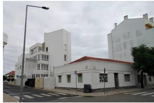
Figura 5.59 - Beneficiação de fachada lateral e principal dos edifícios vizinhos acabamento final
