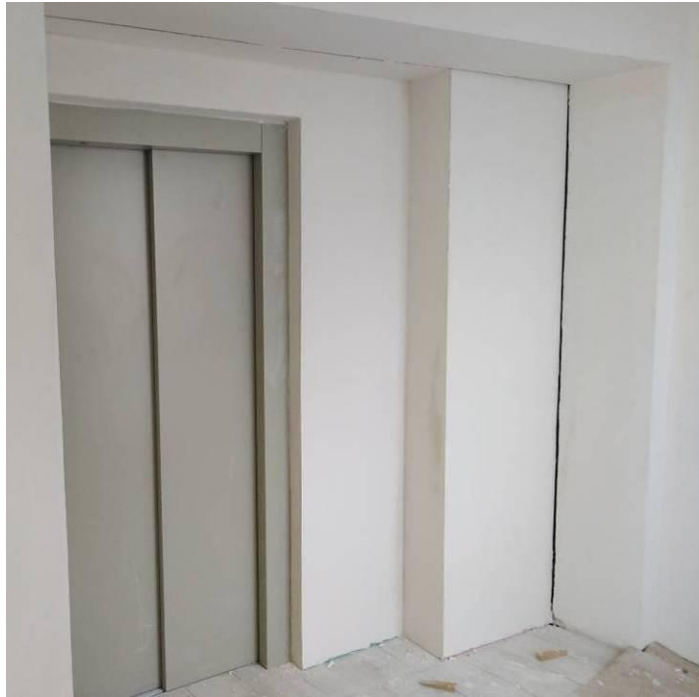
Figura 3.179 - Trabalhos de acabamento após montagem de elevadores – barramento de placas de gesso cartonado
