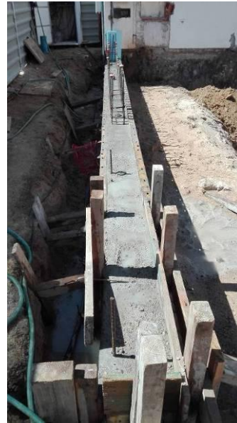
Figura 3.21 - Execução das microestacas e da viga de coroamento
