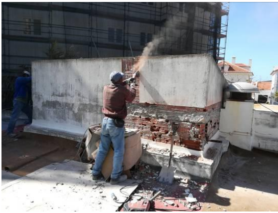
Figura 5.29- Reparação de paredes exteriores da garagem
