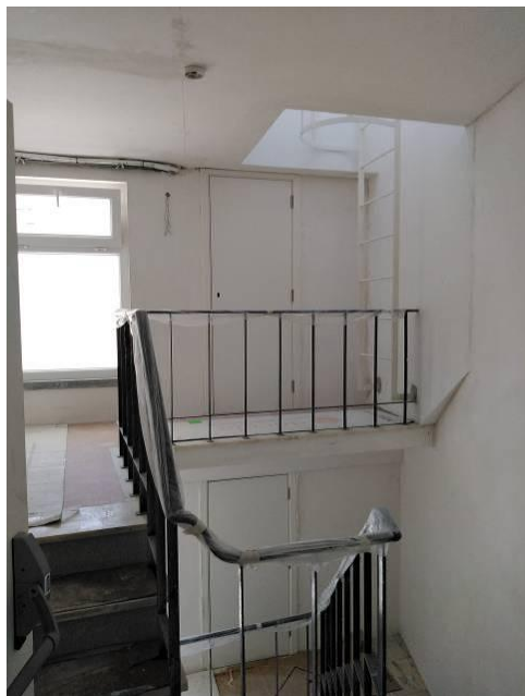
Figura 4.444 - Escadas interiores na caixa da escada de serviço no piso 3
