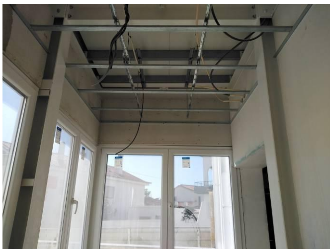
Figura 3.147 - Colocação da estrutura – execução dos tectos falsos
