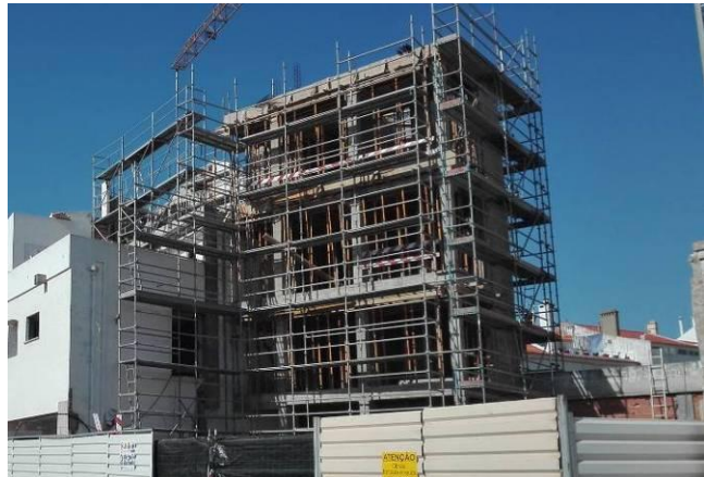
Figura 4.209 - Zona de acesso da torre de elevador ao edifício existente
