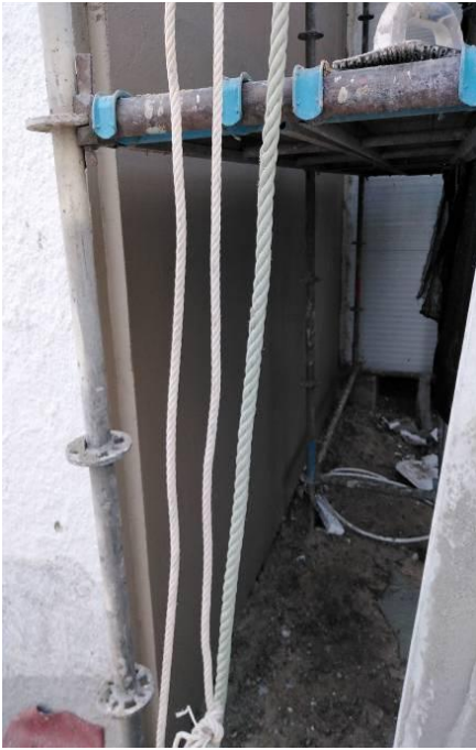
Figura 4.461 - Execução do sistema ETIC
