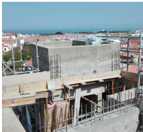
Figura 4.18 - Execução do último piso
