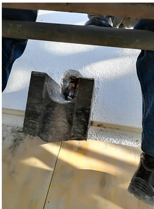
Figura 4.468 - Remoção das gárgulas
