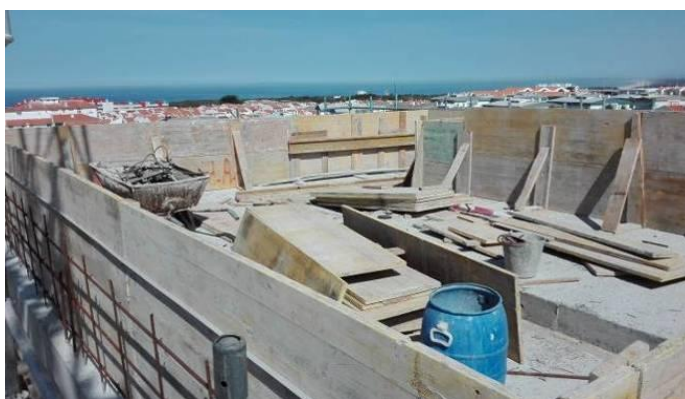
Figura 3.108 - Execução da platibanda da cobertura
