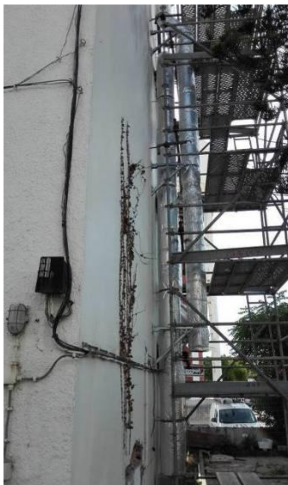
Figura 4.86 - Abertura de janelas e montagem de condutas
