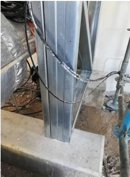
Figura 4.89 - Apoio da estrutura metálica em maciços de betão armado
