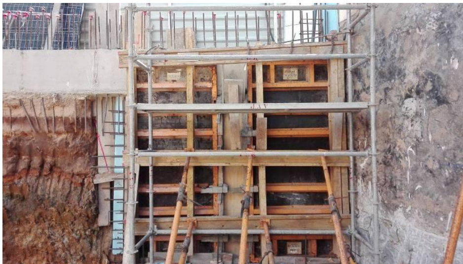
Figura 3.42 - Execução do muro de suporte de forma faseada
