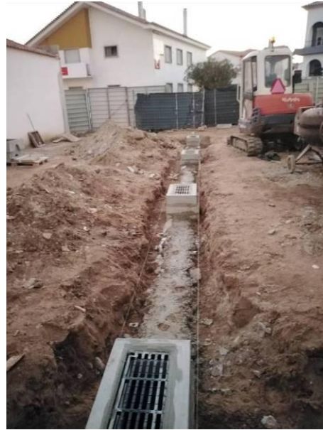
Figura 5.42 - Execução da rede de drenagem pluvial do estacionamento
