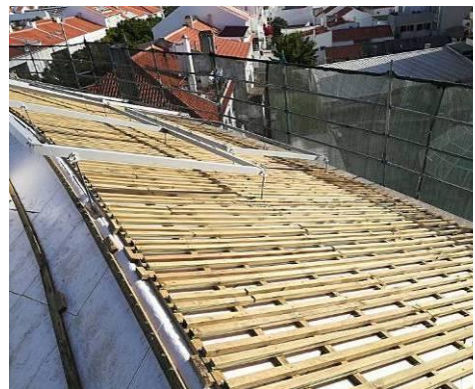
Figura 4.183 - Colocação do ripado e contra ripado
