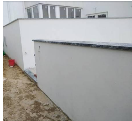
Figura 5.51 - Aspecto final do muro exterior do parque de estacionamento
