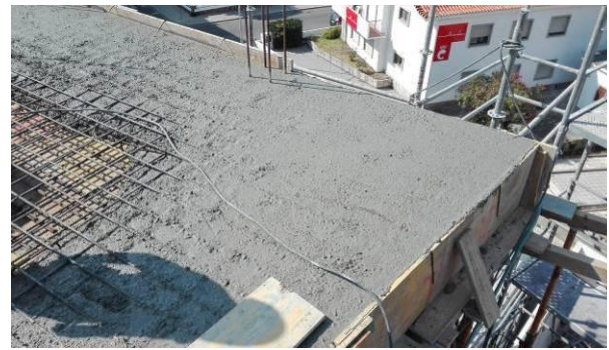
Figura 3.99 - Execução da betonagem da laje do piso 4
