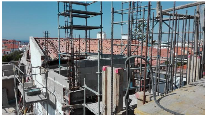
Figura 3.92- Execução da cofragem, armadura dos pilares e caixa do elevador do piso 3
