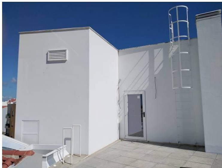
Figura 4.447 - Acesso à cobertura do piso 3 e 4
