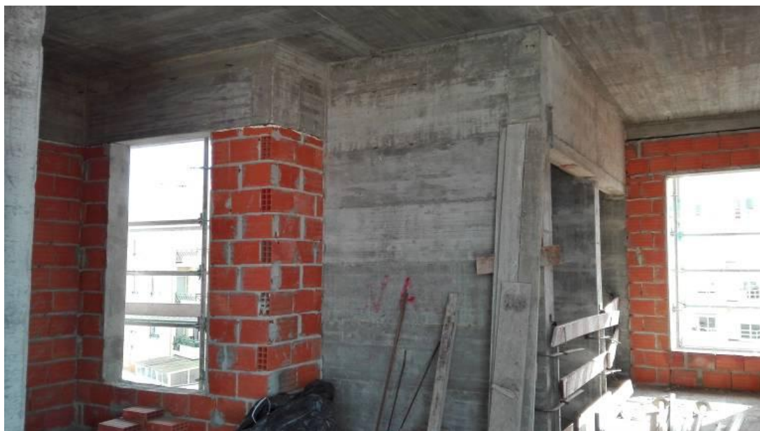
Figura 3.117 - Execução de paredes duplas
