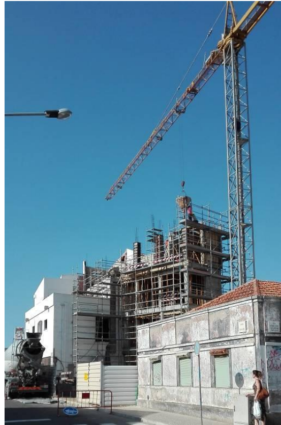
Figura 3.94 - Execução da cofragem, armadura e betonagem dos pilares e caixa do elevador do piso 3
