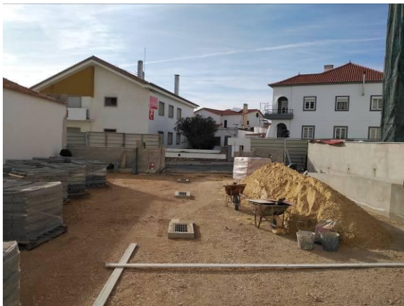
Figura 5.45 - Preparação de cotas para assentamento do pavê no parque de estacionamento
