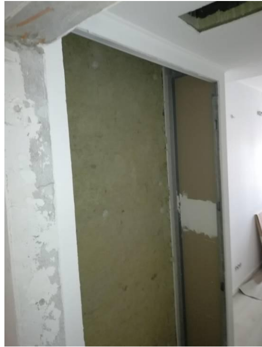
Figura 4.69 - Colocação de isolamento acústico
