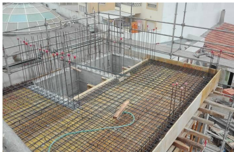
Figura 3.85 - Execução da armadura da laje e vigas do piso 2
