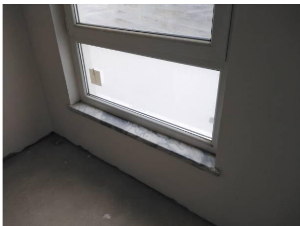
Figura 3.164 - Peitoris na torre do elevador em mármore branco
