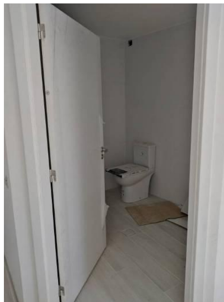
Figura 4.173 - Aspecto final da entrada da IS do quarto 301
