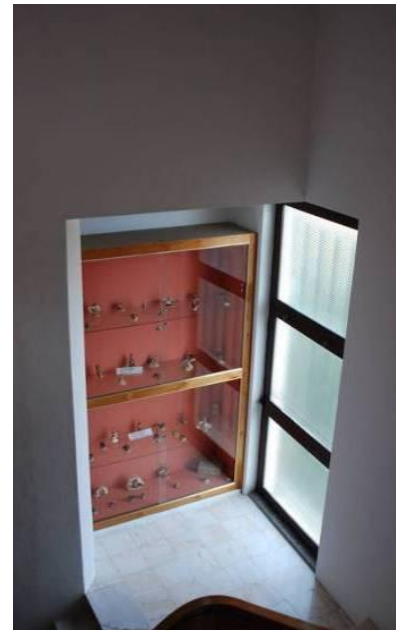
Figura 2.13 - Caixa de elevador existente vista pela caixa de escada
