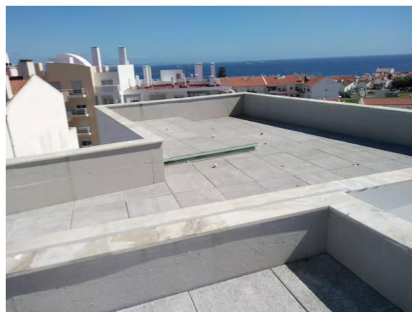
Figura 3.165 - Peitoris na cobertura da torre do elevador em mármore branco
