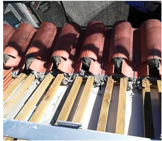
Figura 4.185 - Execução do beirado
