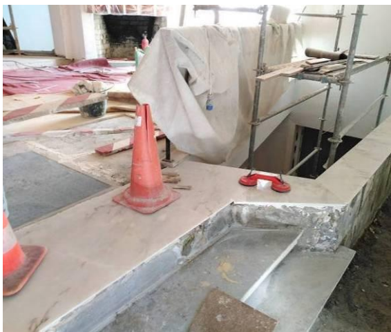
Figura 4.51 - Aplicação do capeamento e revestimentos em pedra mármore
