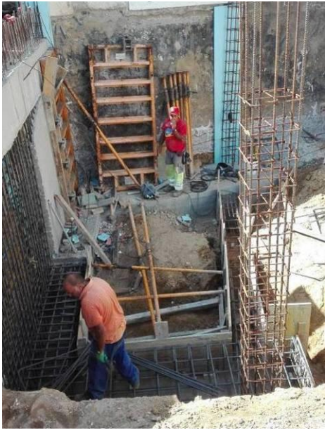
Figura 3.43 - Execução do muro de suporte de forma faseada e fundações do piso -1
