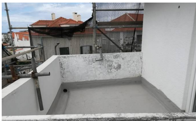
Figura 4.197 - Aplicação da impermeabilização nos terraços
