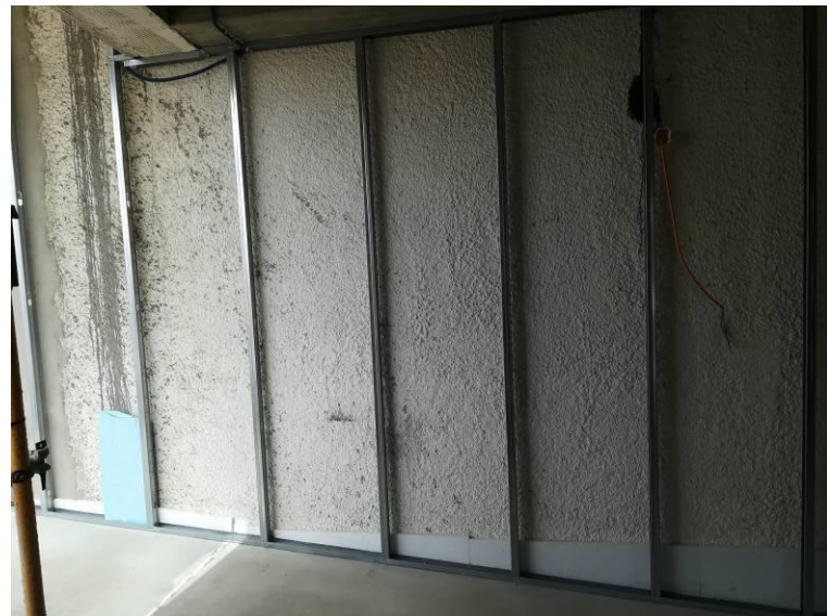
Figura 3.159 - Execução das paredes entre a torre de elevador e o edifício existente – montagem da estrutura
