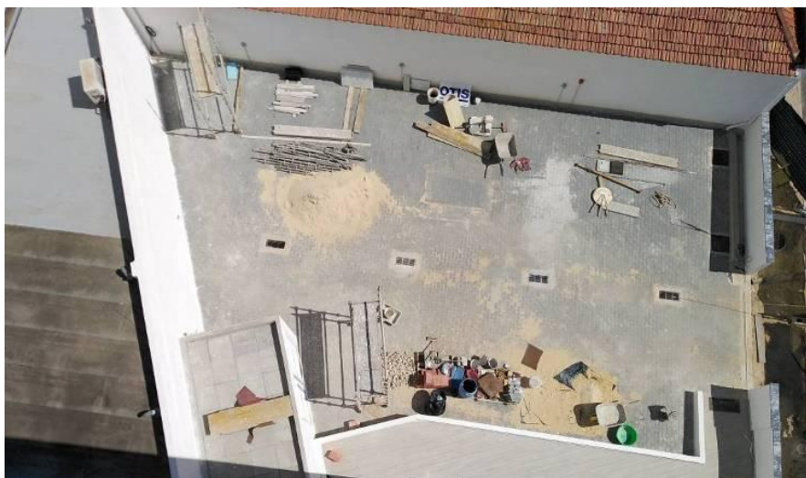
Figura 5.52 - Aspecto final do parque de estacionamento
