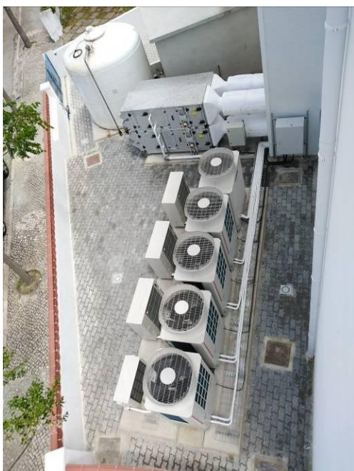
Figura 5.9 - Aspecto final da zona técnica
