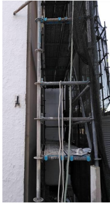
Figura 4.462 - Execução do sistema ETIC
