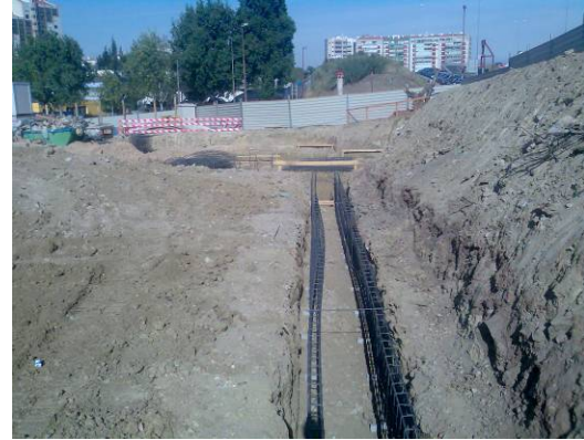
Fotografia 9 – Colocação de armadura dos muros guia
