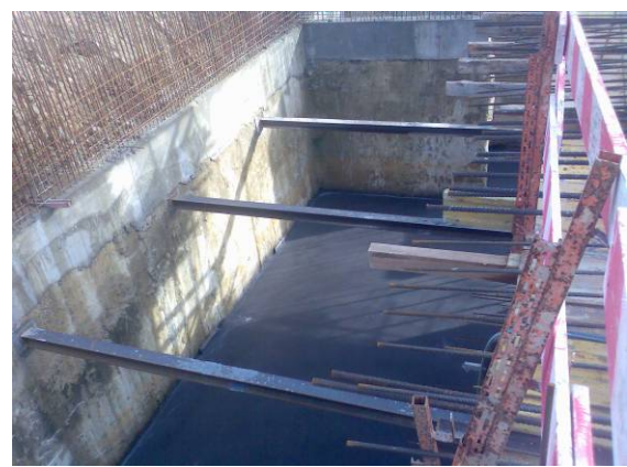
Fotografia 47 – Escoramento superior e laje já executada
