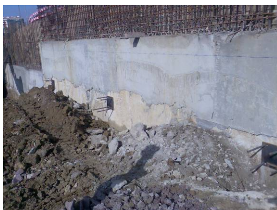
Fotografia 46 – Chumbadouro na parede moldada
