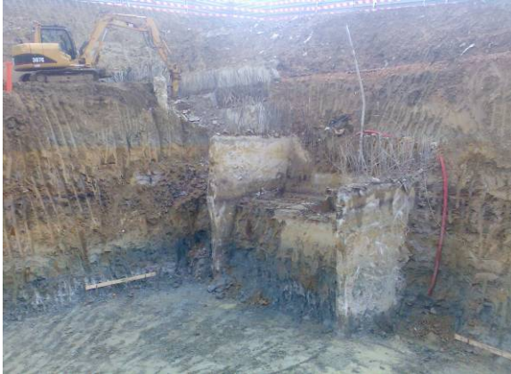
Fotografia 36 – Escavação do terreno
