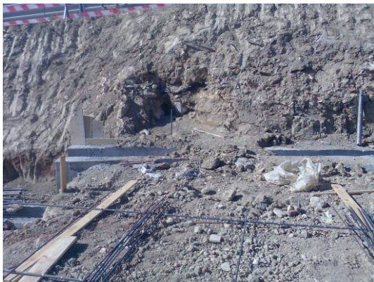
Fotografia 10 – Cofragem e betonagem dos muros guia
