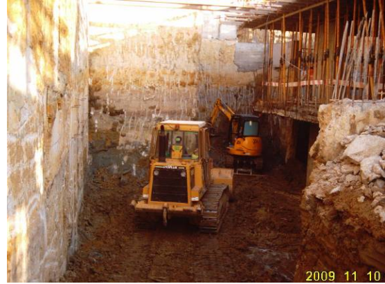
Fotografia 37 – Escavação para colocação de escoramento
