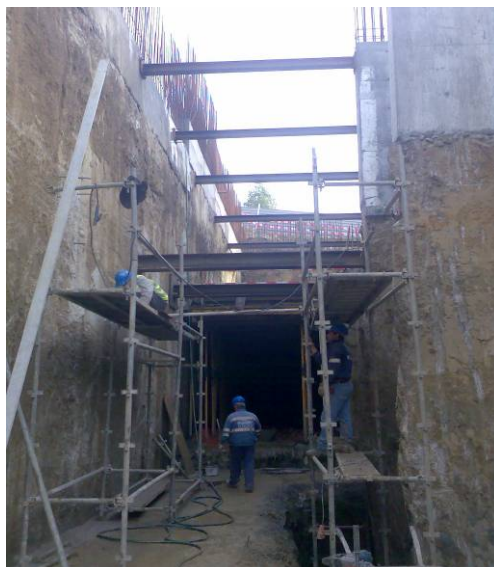
Fotografia 44 – Escoramento a dois níveis
