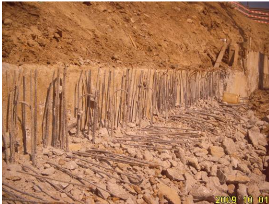
Fotografia 32 – Saneamento do topo das paredes
