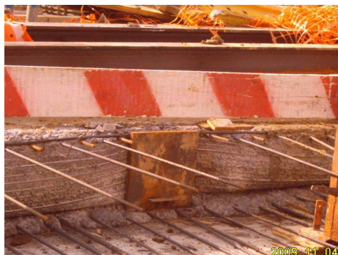
Fotografia 41 – Chumbadouro embebido na laje para apoio do escoramento
