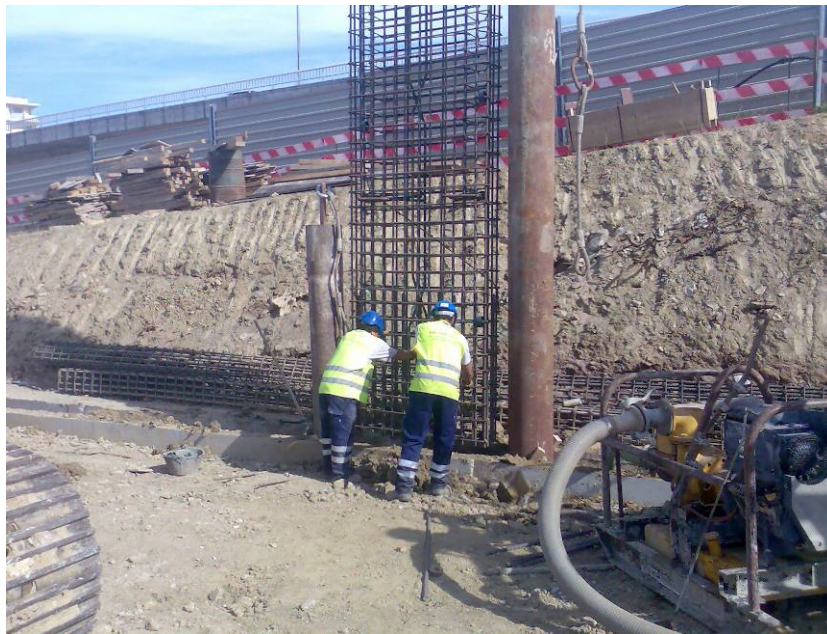
Fotografia 23 – Colocação de armaduras na barreta de arranque
