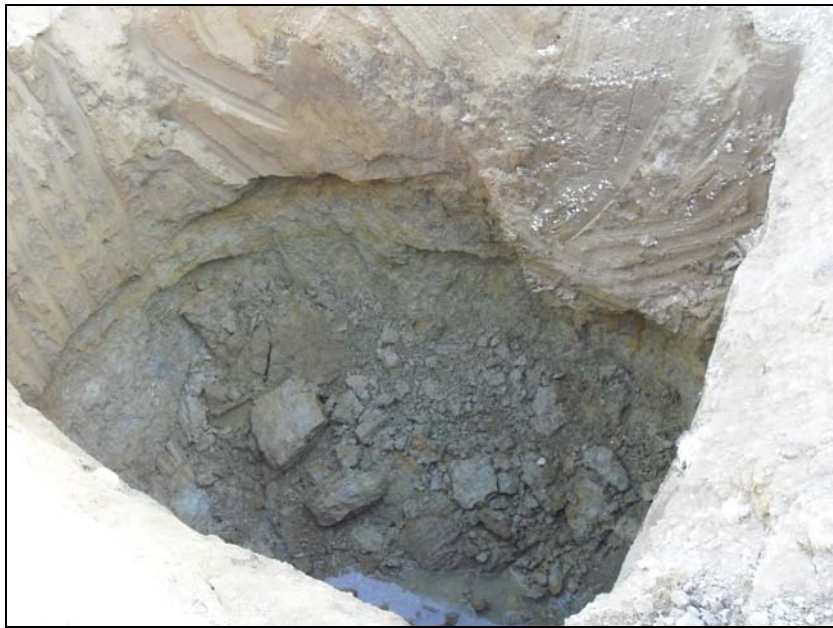
Fotografia 7 – Poço com 7 metros de profundidade após 24 horas
