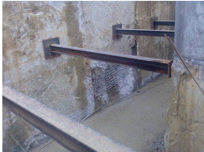
Fotografia 48 - Escoramento entre paredes moldadas
