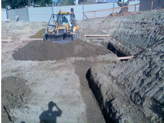
Fotografia 8 – Marcação e escavação de muros guia
