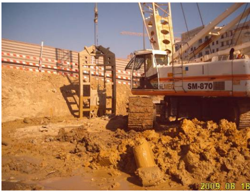
Fotografia 13 – Escavação para colocação armadura
