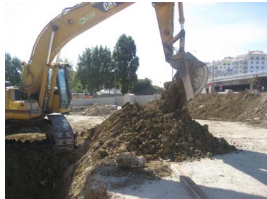
Fotografia 4 – Execução de prospecção
