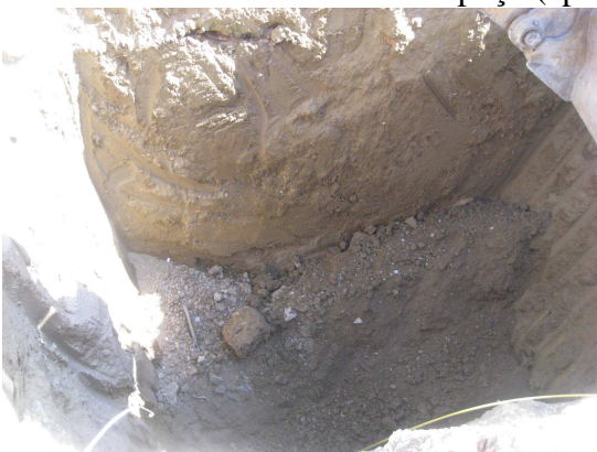
Poço a 7m de profundidade (abertura)
