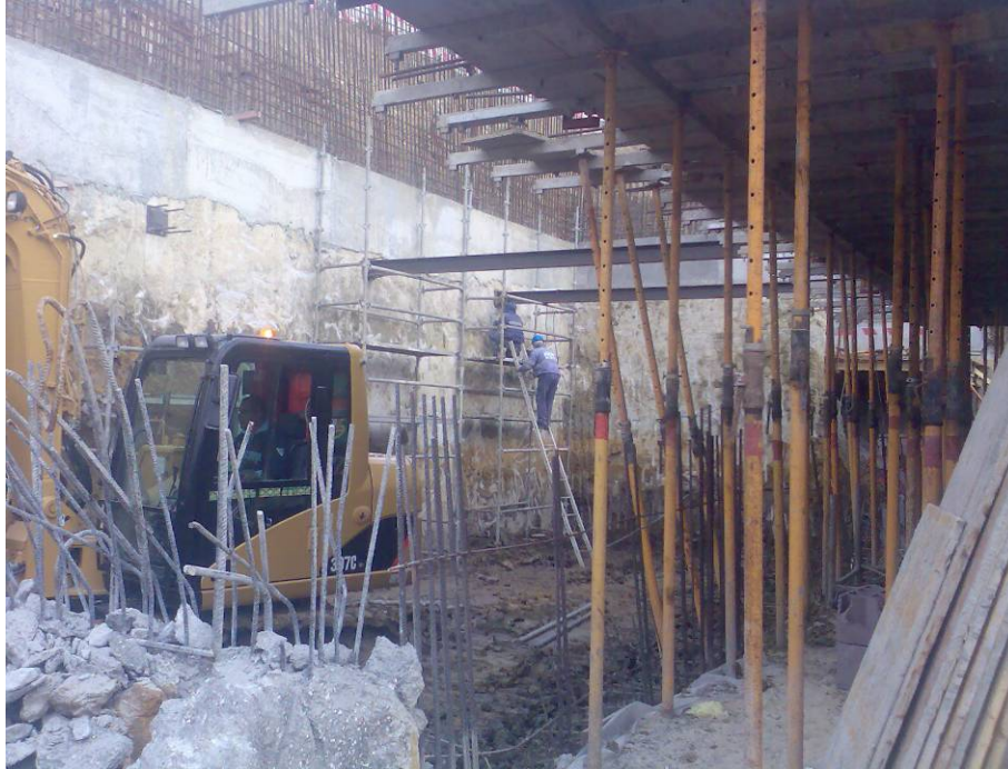
Fotografia 40 – Escavação e escoramento já colocado
