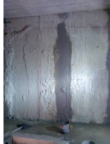
Fotografia 60 – Aplicação do tratamento químico da impermeabilização nas juntas das paredes moldadas
