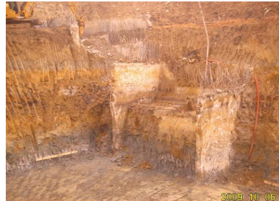
Fotografia 33 – Escavação do terreno
