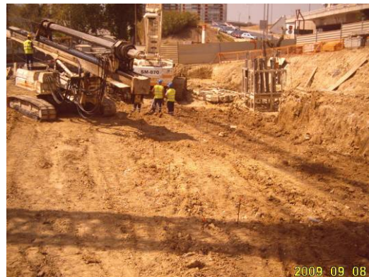
Fotografia 14 – Equipamento de perfuração (trado)
