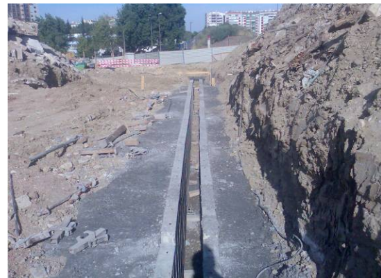
Fotografia 11 – Muros guia executados
