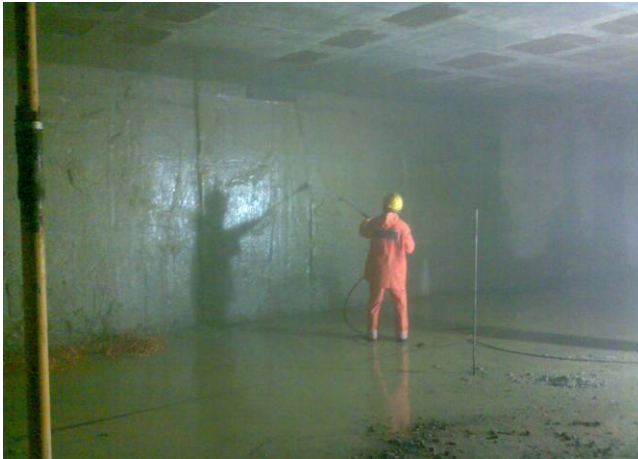
Fotografia 59 – Remoção de terra das paredes moldadas
