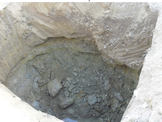
Poço a 7m de profundidade (após 24 horas)
