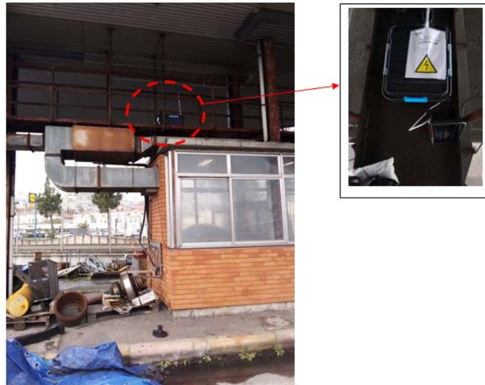
Figura 56 – Local de medição de som da primeira campanha (antiga portaria).
