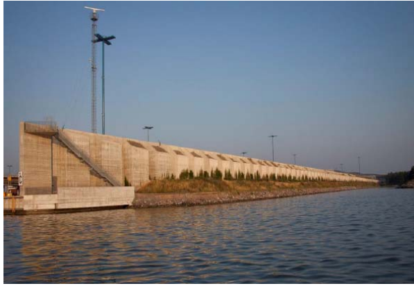
Figura 22 – Barreira de ruído no porto de Vuosaari (Helsínquia, Finlândia).
