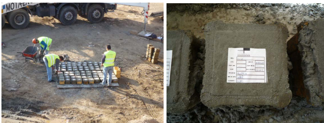
Figura 84 e 85: Provetes para Ensaio de Resistência à Compressão
