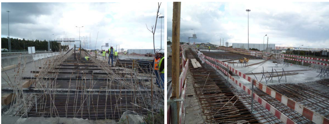
Figura 8 e 9: Passagem Inferior PI4A
