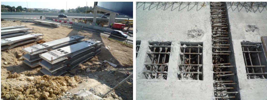
Figura 52 e 53: Lajes pré-fabricadas e ligação à estrutura metálica e entre si
