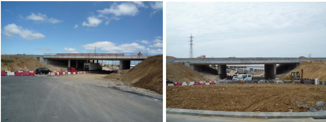
Figura 10 e 11: Passagem Inferior PI8A
