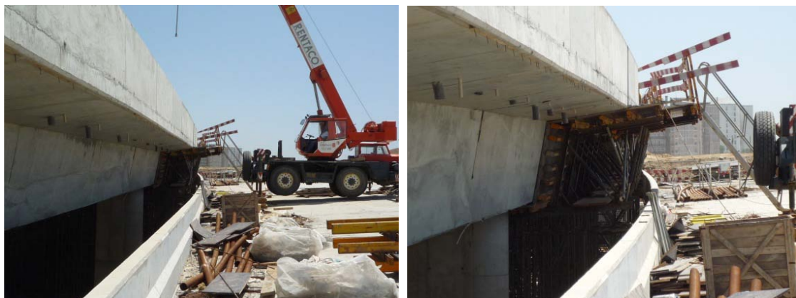
Figura 128 e 129: Cofragem sobreposta sobre o tabuleiro esquerdo do Viaduto do Molhapão
