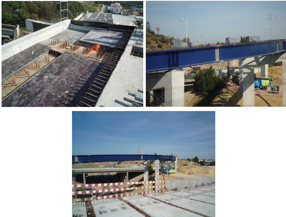
Figura 99, 100 e 101: Conectores metálicos nas longarinas e lajes pré-fabricadas
