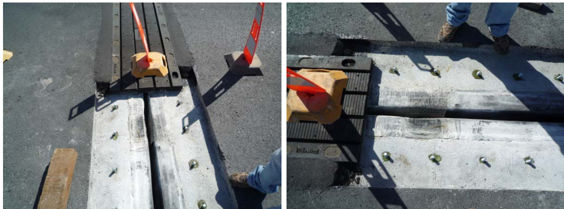
Figura 112 e 113: Chumbadouros e junta de dilatação
