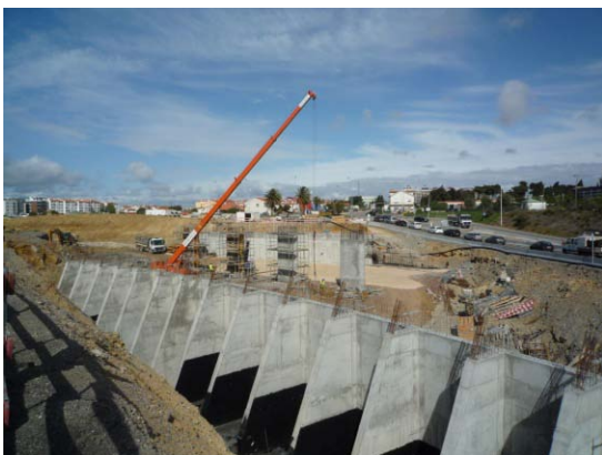
Montagem de cofragem nos pilares.
