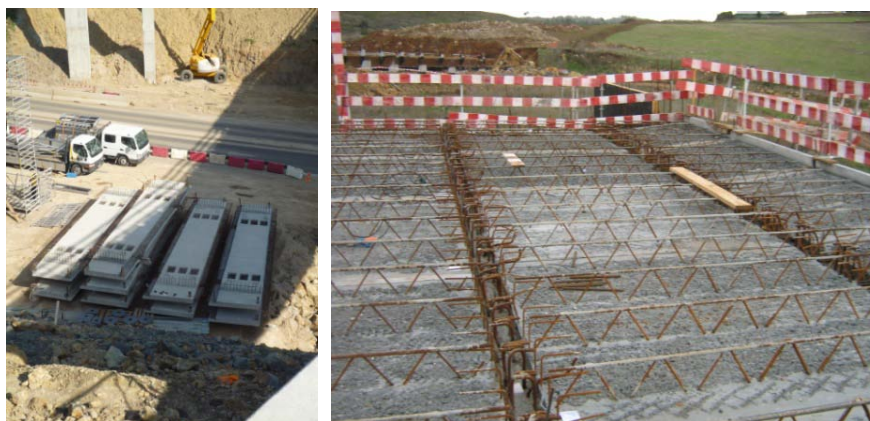
Figura 50 e 51: Lajes pré-fabricadas da Passagem Superior PS12E e pré-lajes do Viaduto do Telhal
