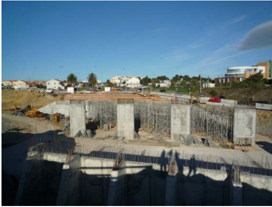
Montagem de cimbra ao solo para execução do tabuleiro.
