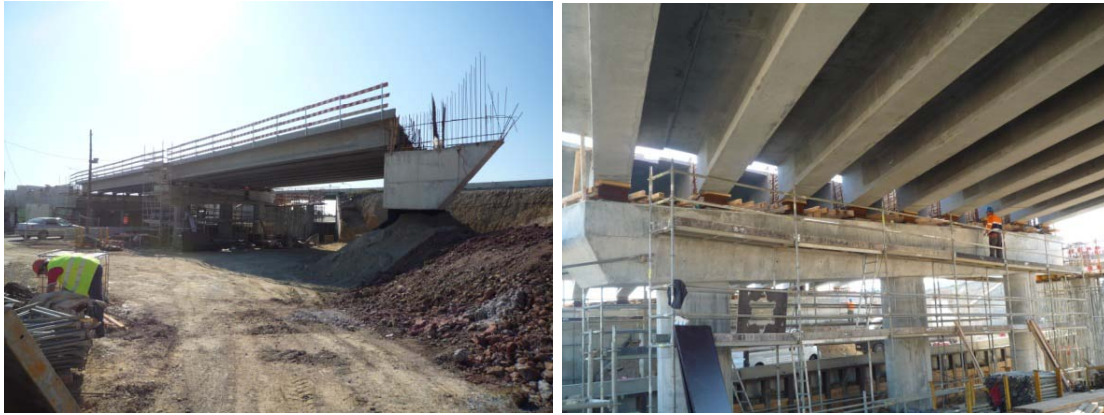
Figura 16 e 17: Passagem Inferior PI12A
