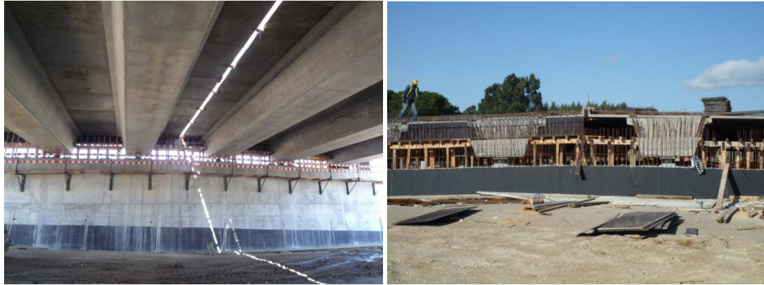
Figura 14 e 15: Passagem Inferior Pontão
