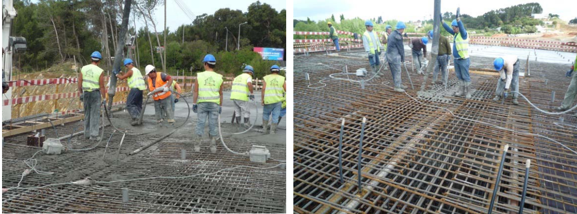
Figura 81 e 82: Betonagem e vibração do betão
