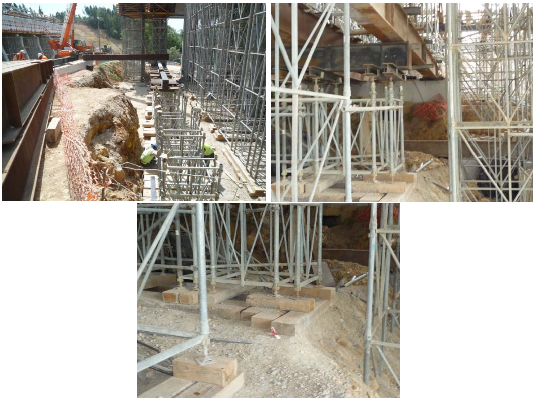
Figura 64, 65 e 66: Lintel em betão armado e sulipas
