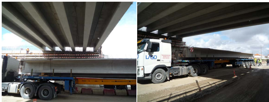
Figura 48 e 49: Vigas em T do tabuleiro da Passagem Inferior PI5
