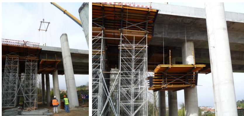
Figura 75 e 76: Descofragem com recurso a grua
