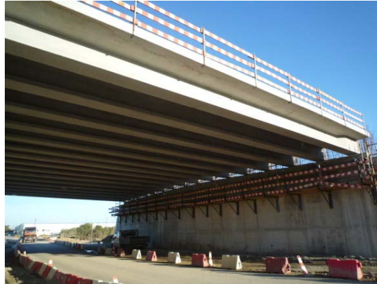
Figura 6: Passagem Inferior com tabuleiro pré-fabricado
