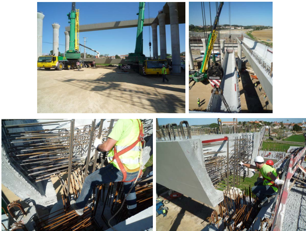
Figura 58, 59, 60 e 61: Colocação de vigas pré-fabricadas
