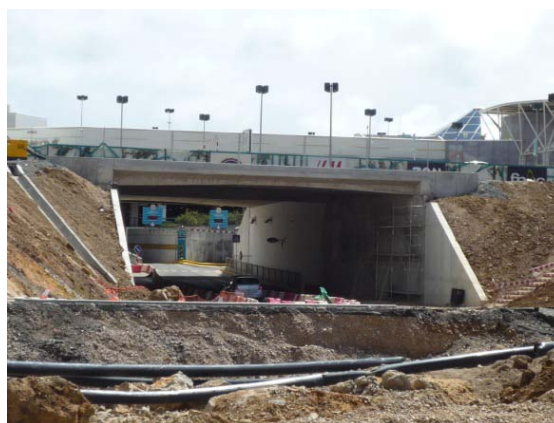
Figura 5: Passagem Inferior em pórtico betonada in situ
