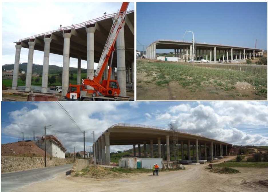
Figura 43, 44 e 45: Viaduto do Telhal
