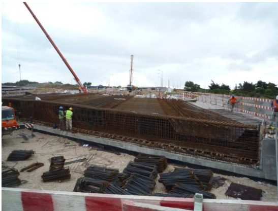
Colocação da armadura do tabuleiro.
