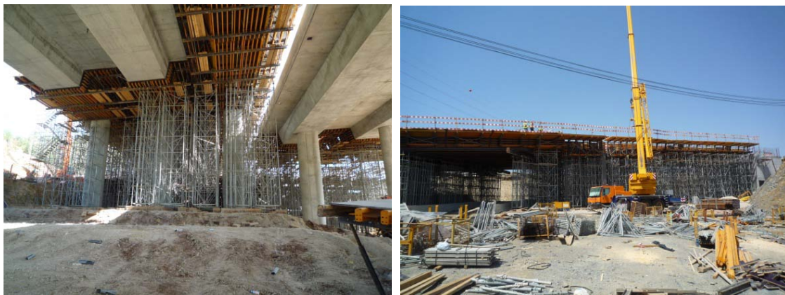
Figura 62 e 63: Cimbra ao solo e cofragem
