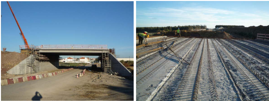
Figura 12 e 13: Passagem Inferior PI5
