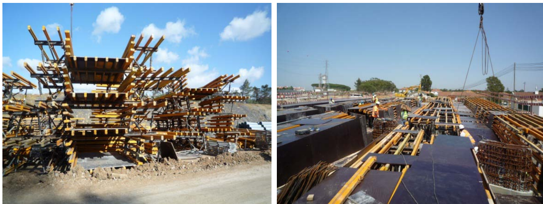
Figura 69 e 70: Painéis de cofragem pré-montados e fecho de painéis
