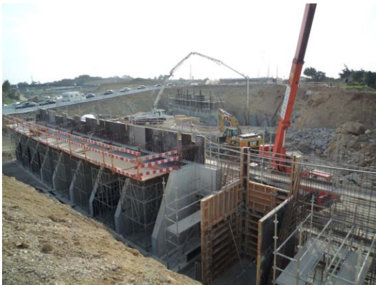
Montagem de cofragem dos gigantes no encontro E2.
