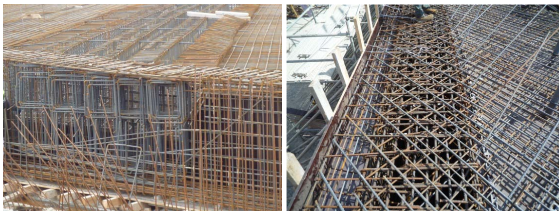
Figura 122 e 123: Armadura na viga carlinga dos encontros
