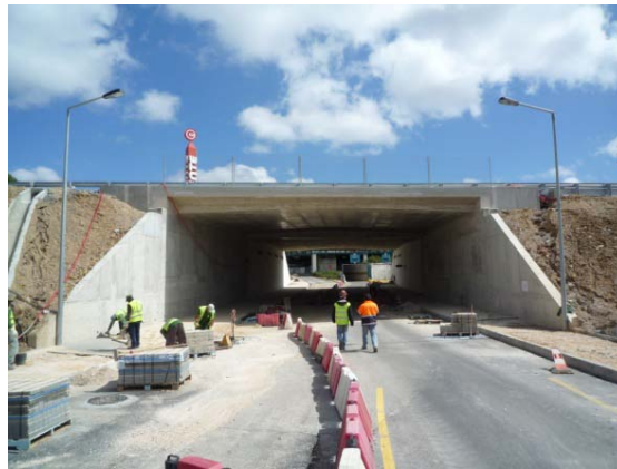
Figura 28: Passagem Inferior PI8B
