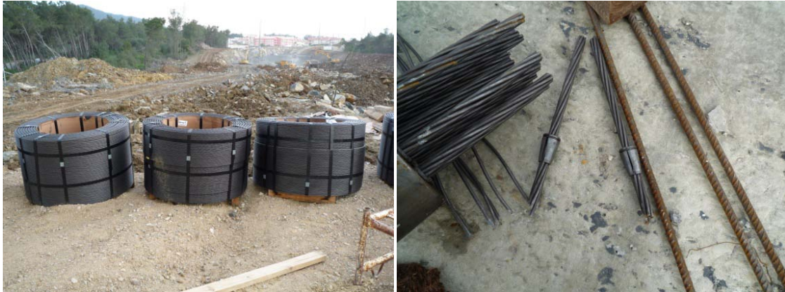
Figura 88 e 89: Cabos de pré-esforço e cunhas
