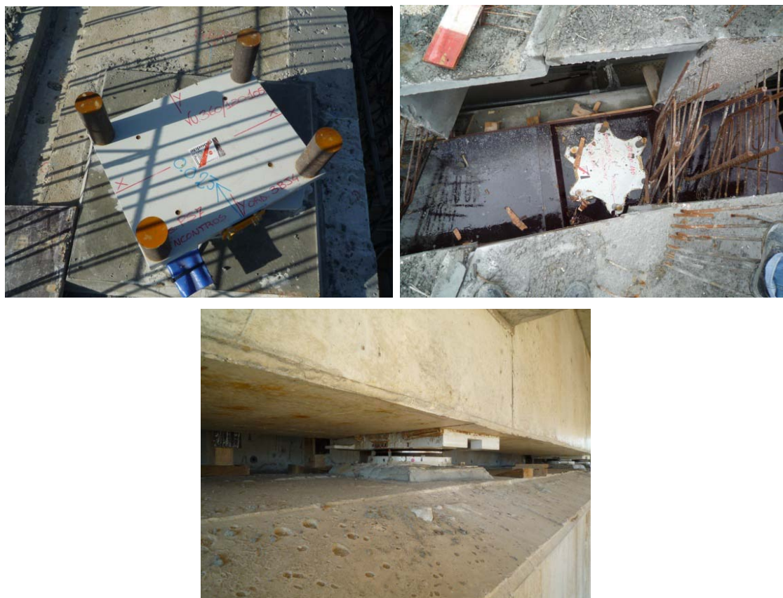
Figura 104, 105 e 106: Aparelhos de apoio e pernos de ligação ao tabuleiro
