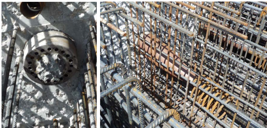
Figura 97 e 98: Cabeça de ancoragem selada do pré-esforço de continuidade e acopladores
