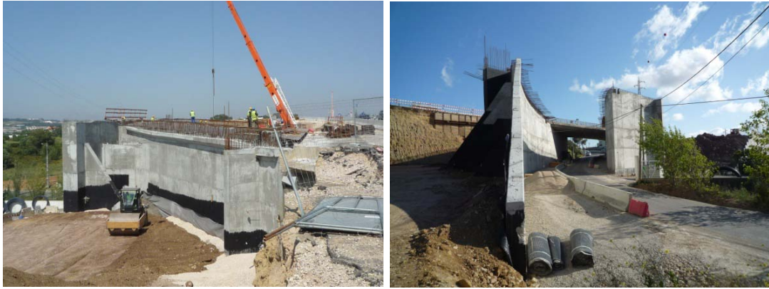
Figura 30 e 31: Passagem Inferior PI10
