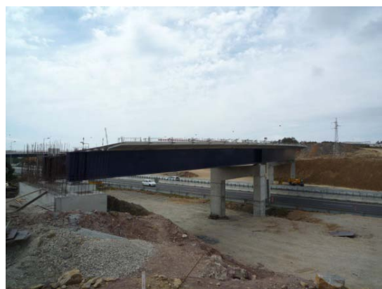
Figura 7: Passagem Superior mista sobre a A5
