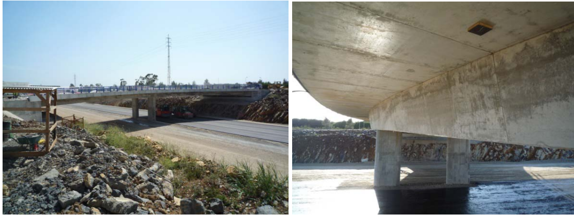
Figura 24 e 25: Passagem Superior PS7B
