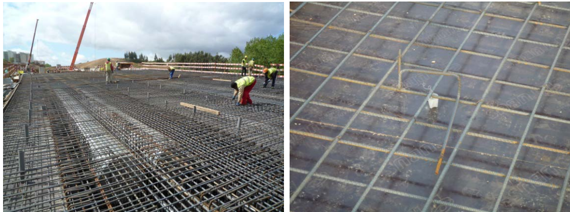
Figura 86 e 87: Armadura de um tabuleiro com vazamento a meio vão e espaçadores pré-fabricados
