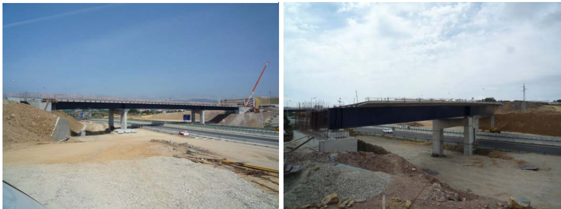
Figura 34 e 35: Passagem Superior PS12C
