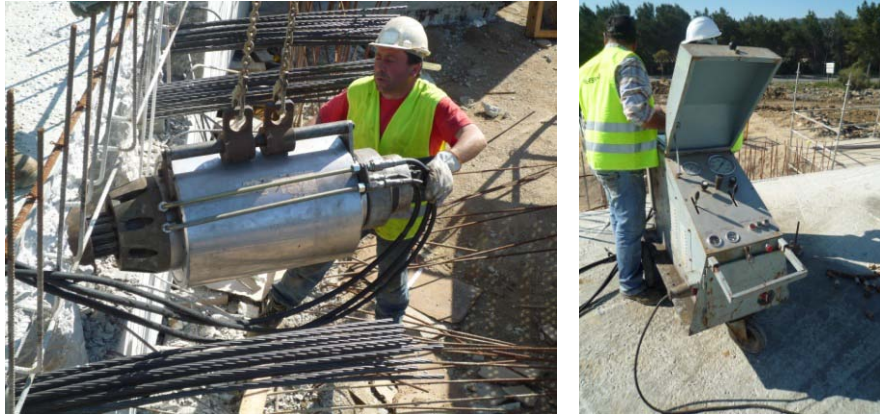
Figura 95 e 96: Aplicação de pré-esforço
