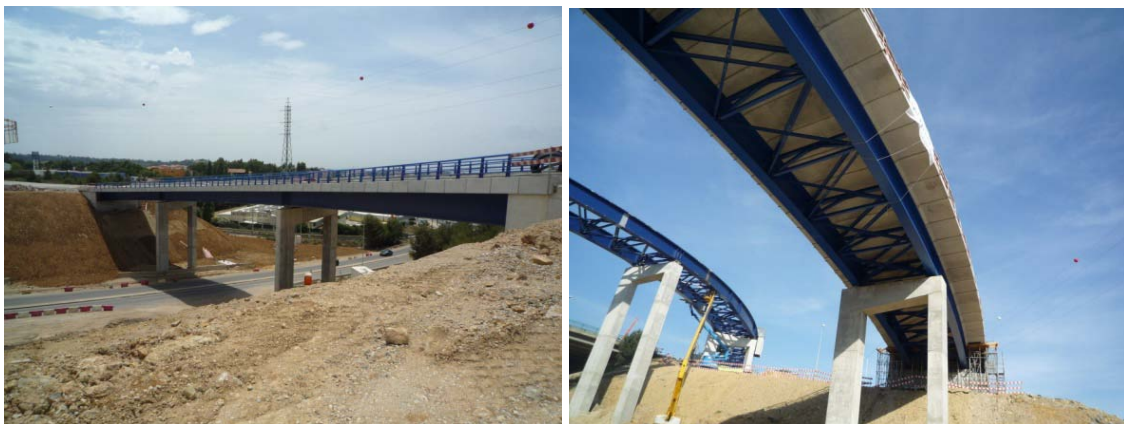
Figura 36 e 37: Passagem Superior PS12D
