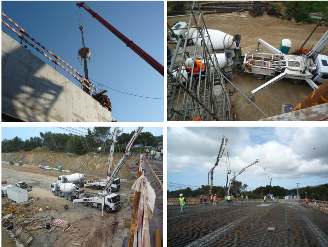
Figura 77, 78, 79 e 80: Betonagem com recurso a balde e auto-bomba
