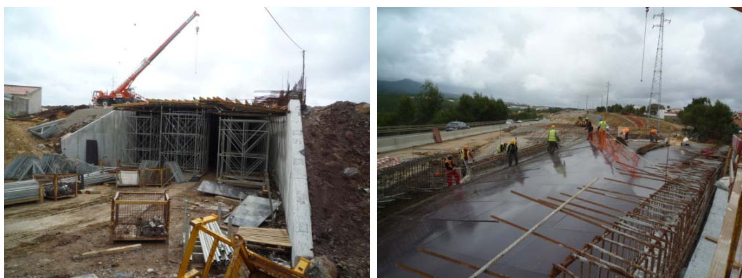
Figura 32 e 33: Passagem Inferior PI11
