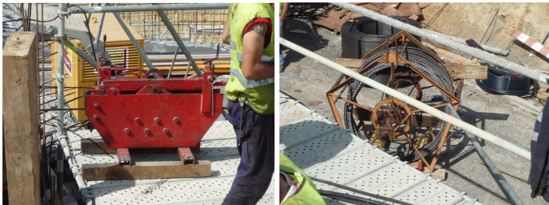
Figura 93 e 94: Máquina e cabos de pré-esforço
