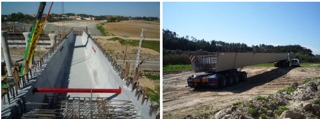
Figura 46 e 47: Vigas pré-fabricadas em U do Viaduto do Telhal
