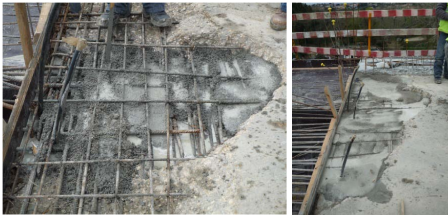
Figura 126 e 127: Microbetão aplicado na zona danificada
