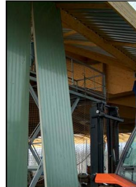
Fig. 8 – Aplicação dos painéis isotérmicos
