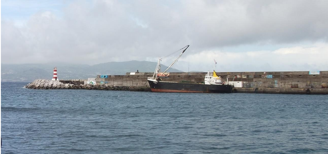
Figura 16 - Vista geral do intradorso do quebra-mar Norte (cedido por LNEC)
