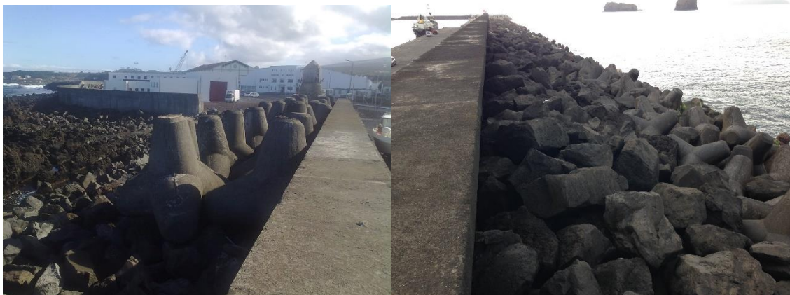
Figura 11 - Tetrápodes de reserva; Vista quebra-mar Norte exterior (cedido por LNEC, 2015)
