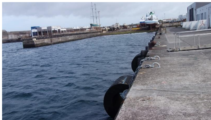
Figura 17 - Rampa do porto (cedido por LNEC)
