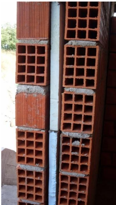
Fig. 213 Parede dupla exterior com respectivo isolamento térmico
