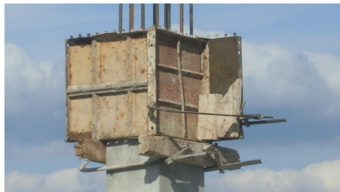
Figura 24 - Cofragens de Pilares
