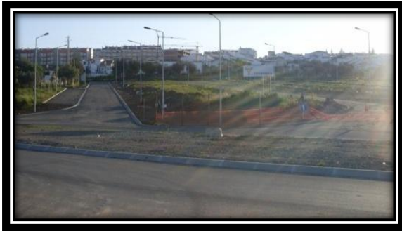
Fig.273 – Novo arruamento que estabelece a ligação entre os Bairros da Quinta Del Rei e o Bairro do Pelame - Beja
