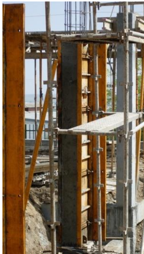
Fig. 159 - Descofragem dos pilares
