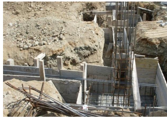
Fig. 130 - Armaduras de pilares e de sapatas
