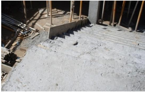
Fig. 191 – Descofragem dos degraus da escada
