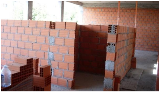
Fig. 224 – Parede interior Simples 15 (espessura 15 cm)
