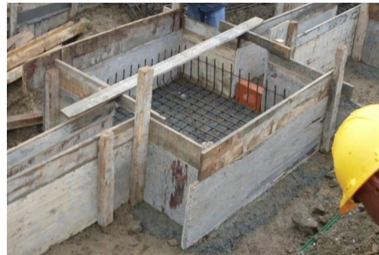
Fig.127 Armadura dentro da Cofragem
