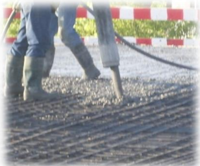
Fig. 175 – Betonagem da Laje com betão pronto
