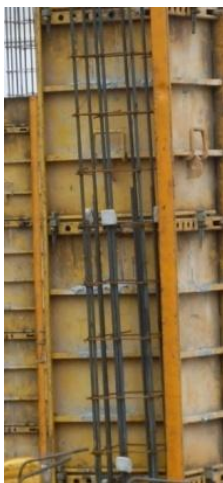
Fig. 152 - Cofragem de um pilar
