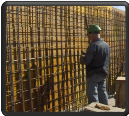
Fig.144 - Colocação de Armadura no fuste do muro
