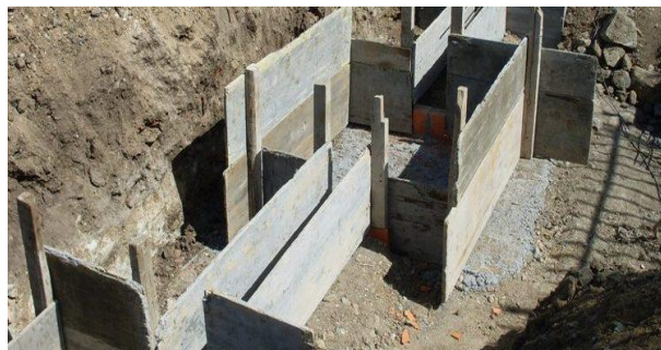
Fig.124 - Execução da cofragem em madeira
