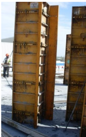
Figura 23 - Cofragens de Pilares
