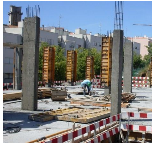
Fig. 160 - Descofragem dos pilares
