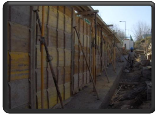
Fig.145 – Cofragem do fuste do muro
