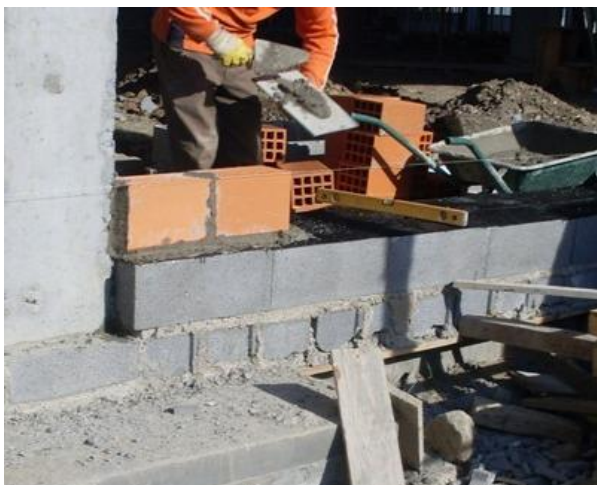
Fig. 210 – Assentamento e alinhamento da primeira fiada de tijolos
