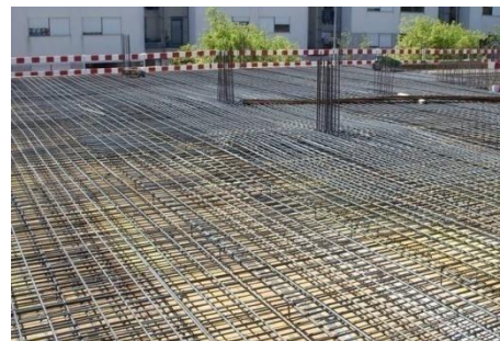
Fig. 172 – Armadura superior e inferior da laje do tecto do piso 0
