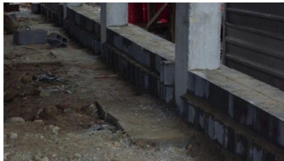
Fig. 206 – Blocos assentes para suporte da alvenaria
