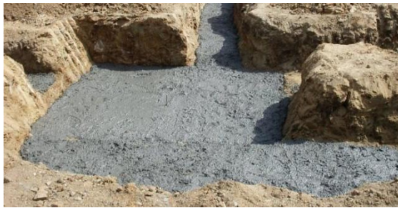
Fig.122 Betão de limpeza regularizado em sapata
