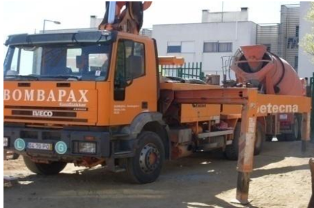
Fig.71 Camião betoneira a manobrar para verter o betão no camião bomba
