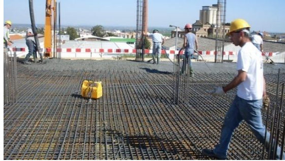
Fig. 174 – Verificação da existência de espaçadores ao longo da armadura da laje antes da betonagem
