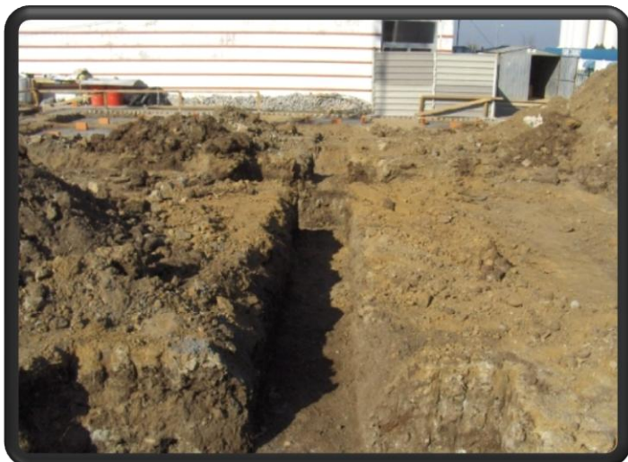
Fig. 115 – Vala aberta para sapatas e vigas de fundação
