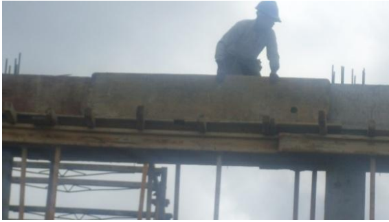
Figura 25- Cofragem de madeira para viga
