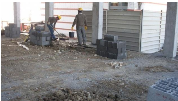
Fig. 202 – Limpeza das vigas de fundação para colocação dos blocos
