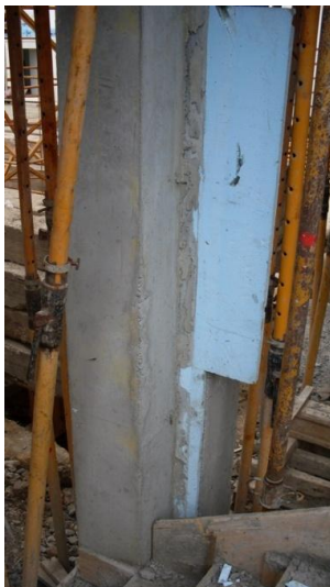
Fig. 230 - XPS nas juntas dos pilares
