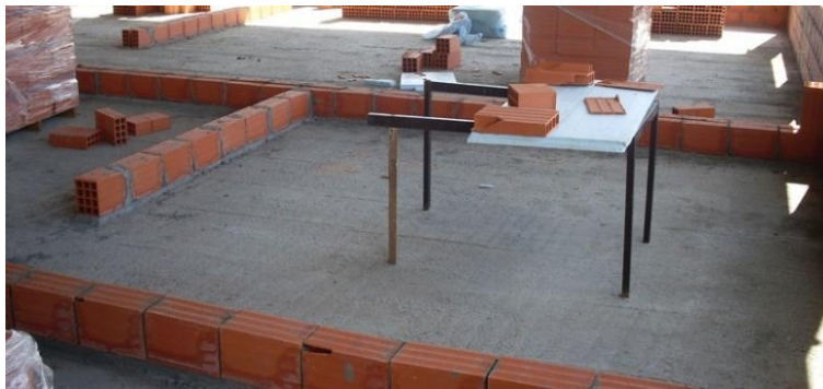
Fig. 219 – Pormenor de corte de tijolos para ajustes de topo
