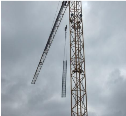
Fig. 265 - Armadura de Pilar em suspensão
