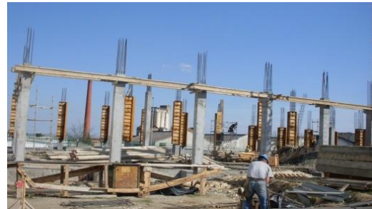
Fig. 162 – Cofragem de vigas
