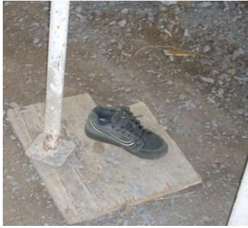
Fig. 263 - Deficiente arrumação do local de trabalho.
