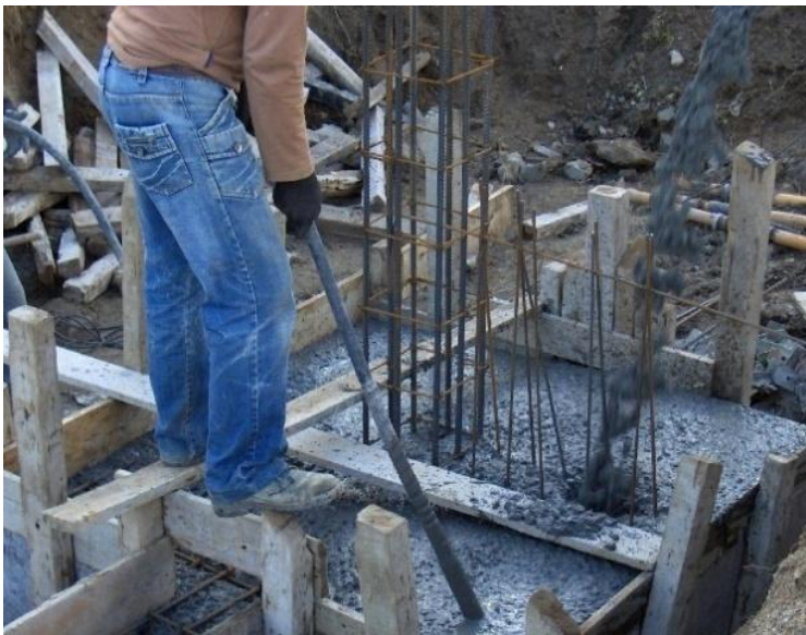
Fig.74 Betonagem e respectiva vibração do betão
