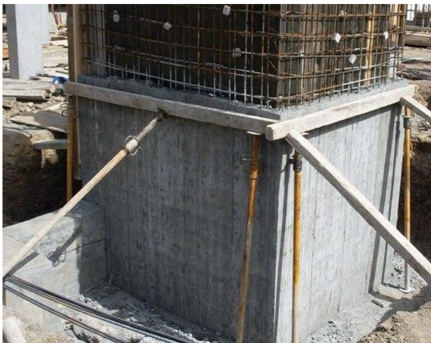
Fig. 200 – Betonagem já efectuada de uma parte da parede maciça
