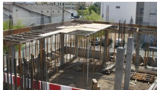
Fig.164 - Cofragem de viga e laje do tecto do piso 0
