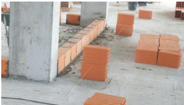
Fig. 215 – Início da execução das Paredes interiores
