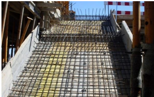
Fig.187 – Armadura de 2 lanços de escada
