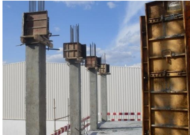
Fig. 154 – Cofragem dos Pilares
