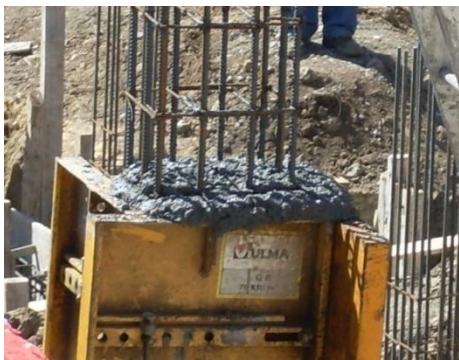
Fig. 155 – Pilar betonado
