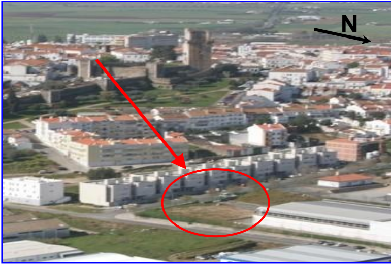
Fig. 3: Fotografia aérea do terreno onde o centro escolar vai ser construído
