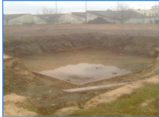
Fig. 99 - Preparação para a betonagem da base de fixação da grua
