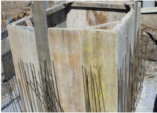
Fig. 197 – Cofragem interior da parede maciça
