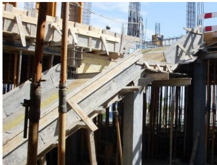
Fig. 182 – Cofragem da escada
