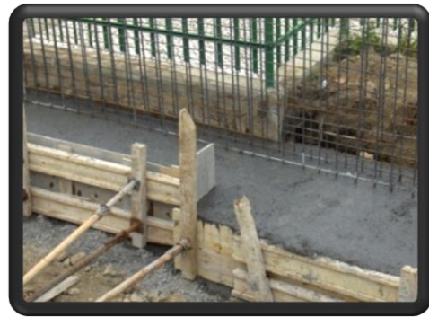
Fig.143 – Betonagem da sapata do Muro
