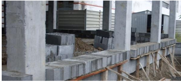
Fig. 204 – Assentamento a uma vez (de forma transversal) da primeira fiada de blocos
