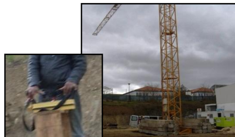
Fig.44 Grua Torre com 45 m de Lança
