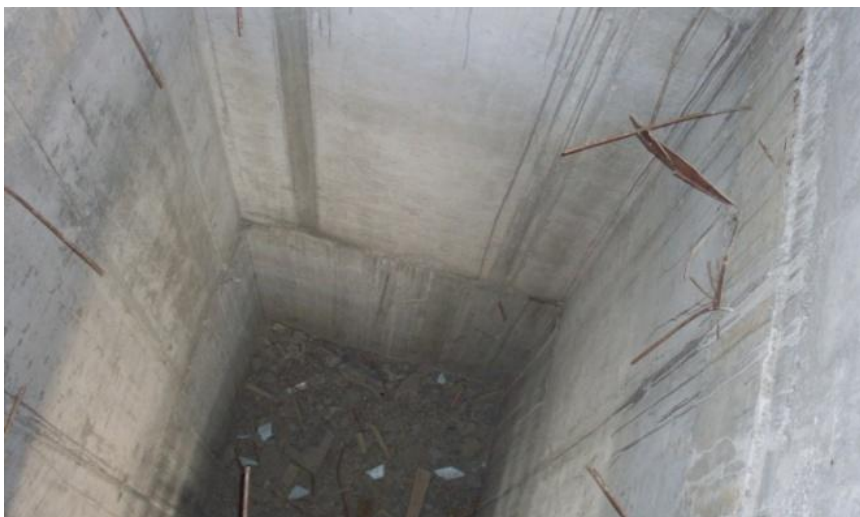
Fig. 201 – Parede maciça descofrada
