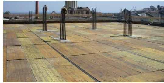
Fig. 166 – Tábuas de solho da cofragem da laje do tecto do piso 0
