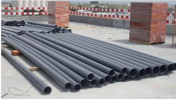
Figura 31 – Tubagem de PVC rígido para redes de drenagem
