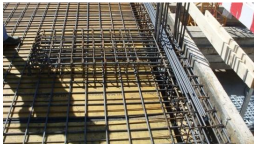
Fig. 169 – Armadura da laje e da viga com reforço de armadura de capitel junto ao pilar
