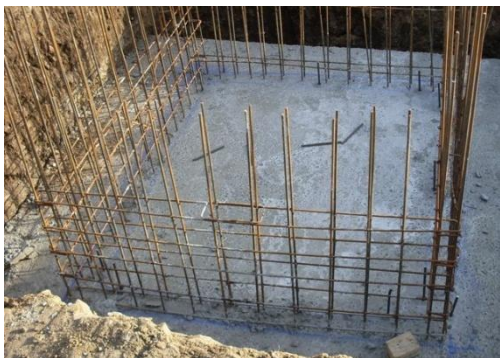
Fig. 194 – Armadura da Parede Maciça
