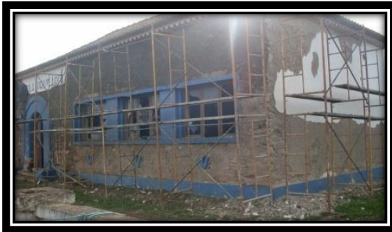
Fig.275 - Escola Primária de Vale de Russins
