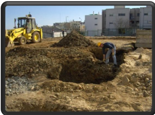
Fig. 113 – Início das Escavações para as fundações do edifício
