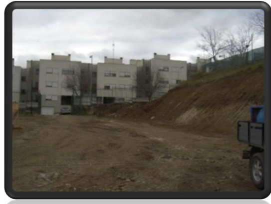
Fig. 108 – Zona Oeste já regularizada após a movimentação de terras
