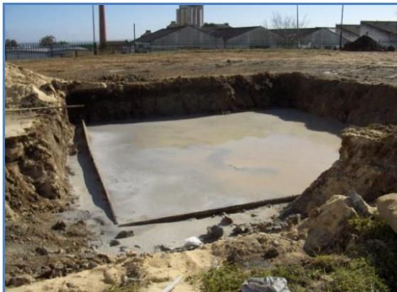
Fig. 100 - Base de fixação da grua betonada e nivelada
