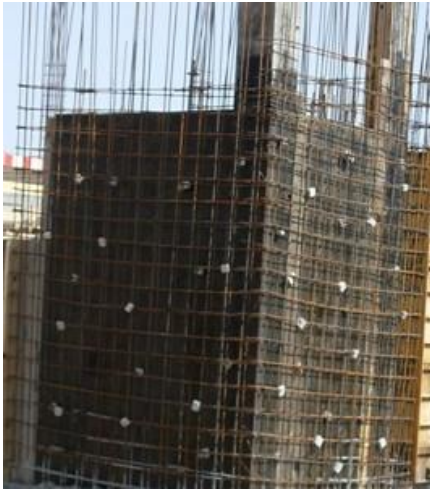
Fig. 196 – Armadura da Parede maciça e os respectivos espaçadores
