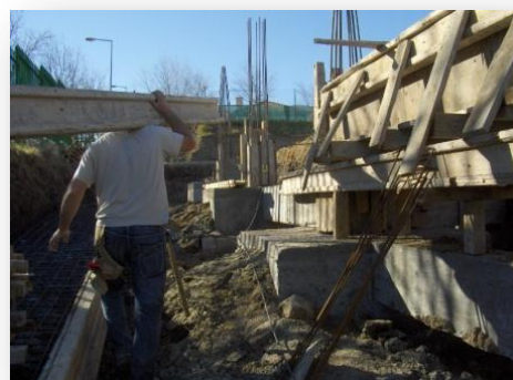
Fig. 260 - Trabalhador a transportar manualmente uma viga
