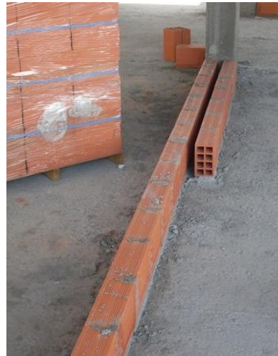
Fig. 218 Parede Interior Dupla
