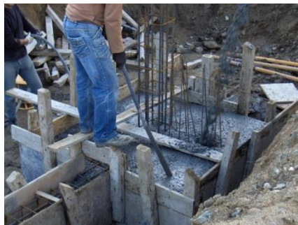
Fig. 133 – Betonagem de uma sapata e respectiva vibração
