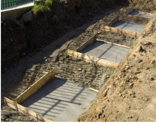
Fig.125 - Cofragem das sapatas com taipais de madeira
