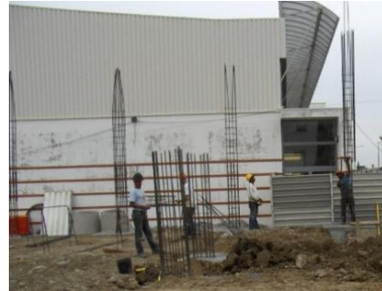
Fig. 150 – Pilares Armados no Piso 0
