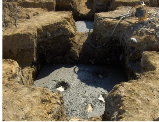
Fig.121 Betão de limpeza aplicado nas sapatas
