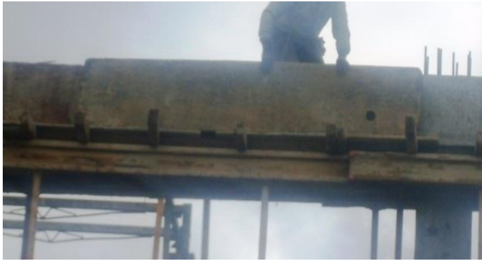
Fig.82 Cofragem de madeira aplicada numa viga
