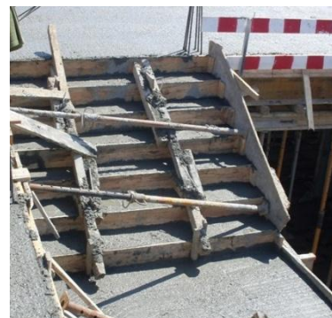
Fig. 190 - Betonagem da escada
