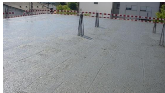
Fig. 178 – Laje betonada
