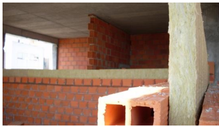
Fig. 228 - Lã de Rocha nas caixas-de-ar das paredes interiores
