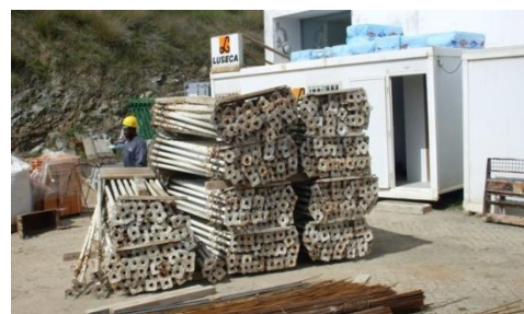
Figura 30 - Prumos Metálicos (extensores)
