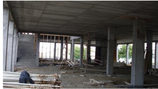
Fig. 181 – Retirada dos prumos de escoramento
