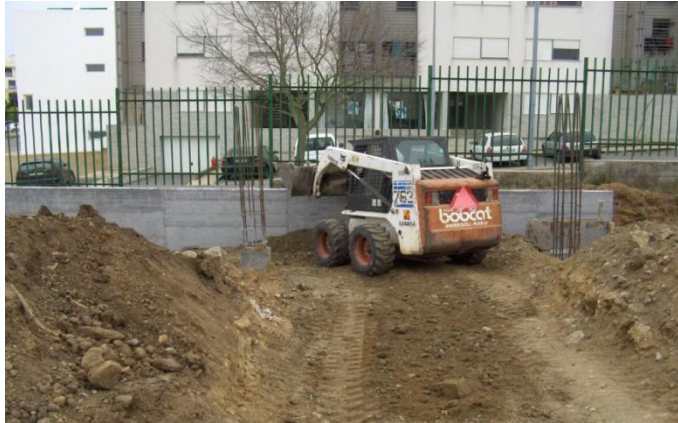
Fig. 137 – Aterro sobre as sapatas e vigas de fundação
