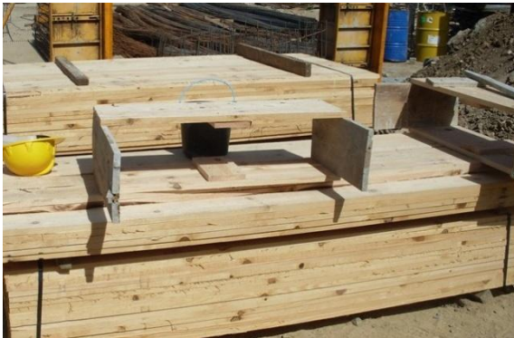
Figura 38 - Tábuas de Madeira para guardas de protecção
