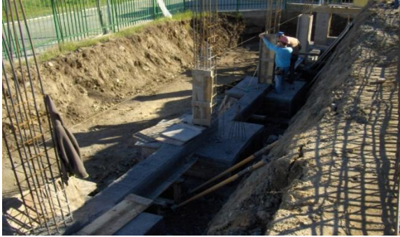
Fig. 136 – Descofragem das Sapatas e das vigas de fundação
