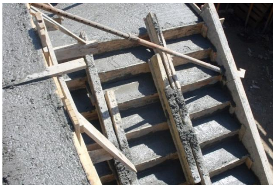
Fig. 189 – Betonagem da escada
