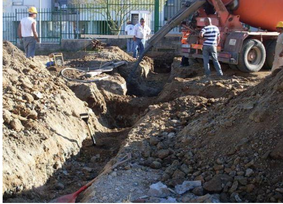
Fig.120 Camião a vazar betão para as sapatas
