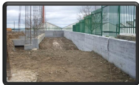
Fig.147- Aterro junto ao muro
