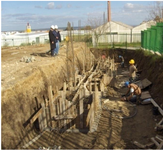
Fig.131 – Colocação de Armadura na sapata Desnivelada
