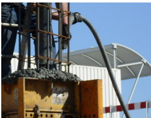
Fig. 157 – Vibração do betão durante a betonagem de um pilar
