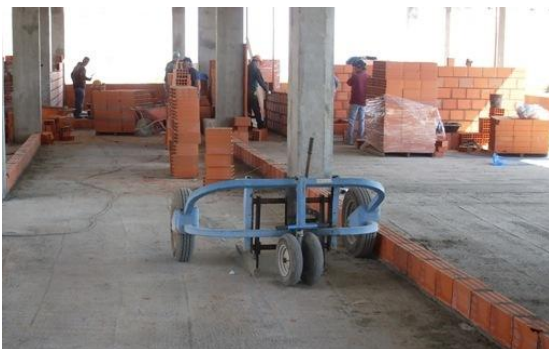
Fig. 220 – Primeira fiada de uma Parede interior simples
