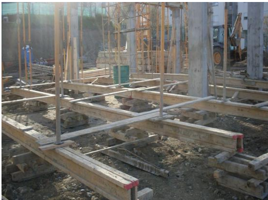
Figura 27- Barrotes e tábuas de solho e prumos Metálicos
