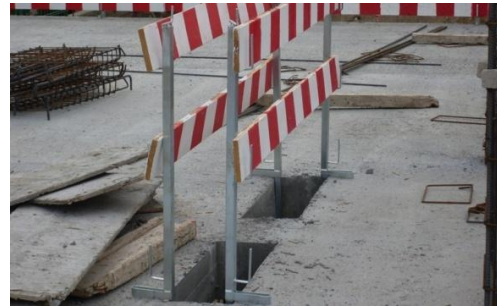
Figura 39- Grampos com as respectivas tábuas de madeira já pintadas para guardas de protecção
