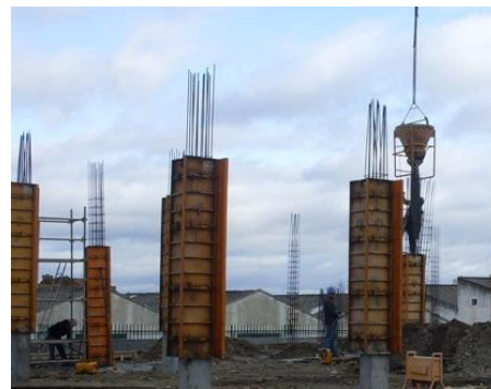
Fig. 156 – Betonagem dos pilares com balde e mangueira
