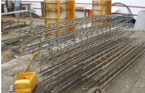
Fig. 149 – Armaduras de Pilares executadas em obra
