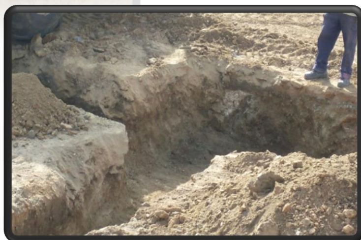
Fig. 116 – Vala aberta para sapata
