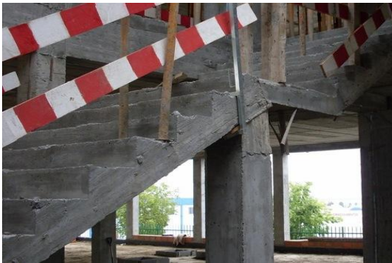
Fig. 193 – Escada já descofrada
