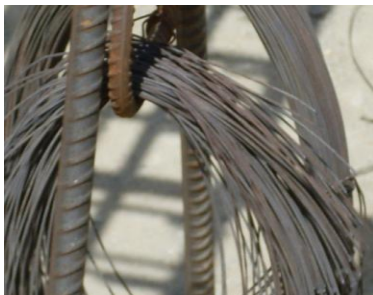
Figura 16 - Arame de aço recosido para atar armaduras
