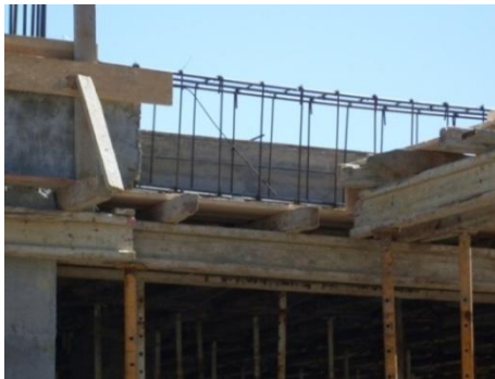
Fig. 167 – Armadura de uma viga
