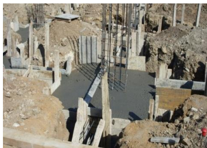
Fig. 134 – Sapata Betonada
