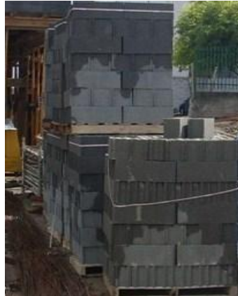
Figura 19- Blocos de cimento para se aplicarem sobre as vigas de fundação como suporte à alvenaria
