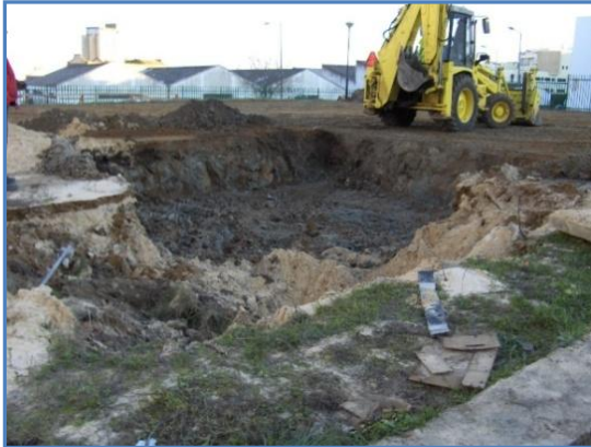
Fig. 98 - Escavação para a sapata da base de fixação da Grua
