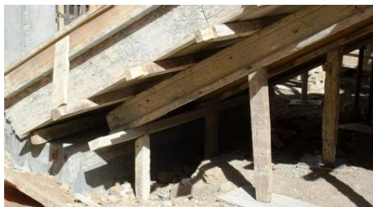
Fig. 184 – Cofragem da escada com prumos, vigas, barrotos, serrafões e tábuas de madeira
