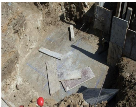
Fig.123 - Implantação de alinhamentos e eixos dos pilares
