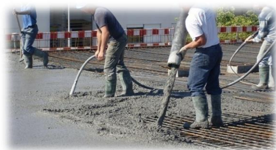
Fig. 176 – Operações conjuntas de betonagem, vibração e alisamento do betão
