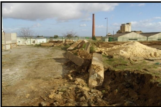
Fig.85 Demolição de Muro Existente em alvenaria de pedra
