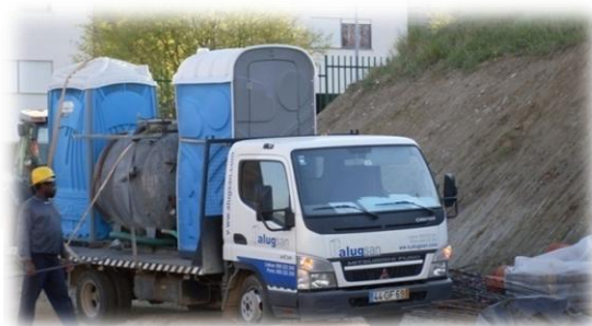
Fig. 246 – Limpeza das WC's do local de trabalho
