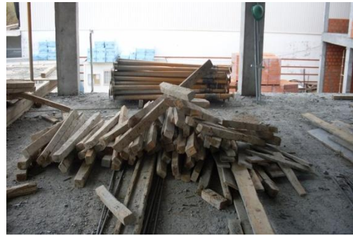
Figura 26 – Barrotes de madeira; prumos metálicos
