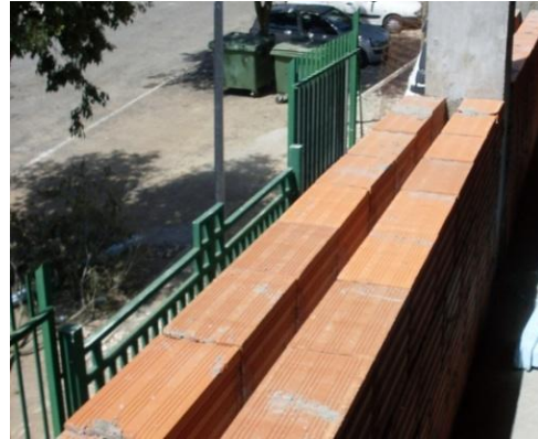
Fig. 212 – Parede dupla exterior
