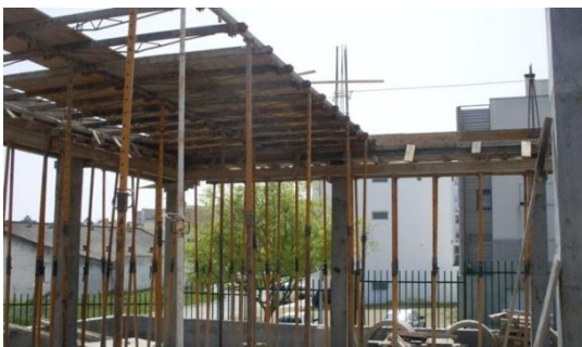
Figura 29 - Prumos metálicos ajustáveis e vigas metálicas extensíveis
