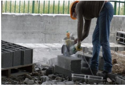
Fig. 203 – Corte dos blocos
