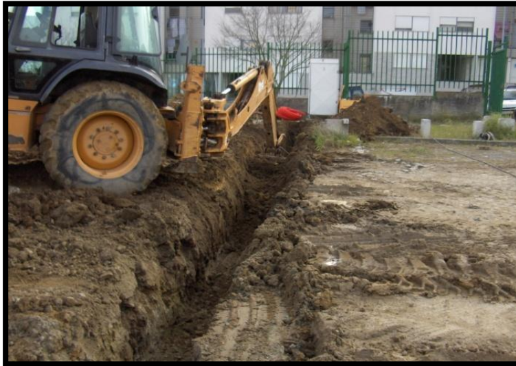
Fig.87 Abertura de valas para as redes provisórias
