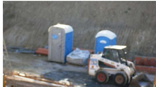
Fig.94 - Zona de depósito de materiais, equipamento e 2 WC's
