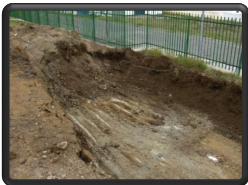
Fig. 110 – Escavação na zona Este para a fundação do muro de suporte
