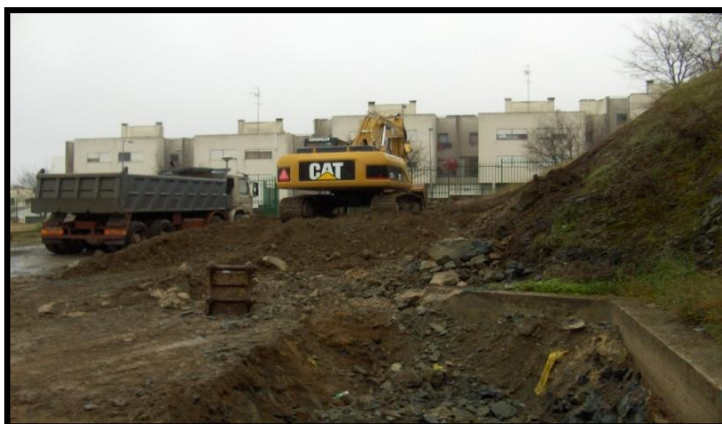
Fig.86 Carregamento de material resultante das demolições para transporte a vazadouro
