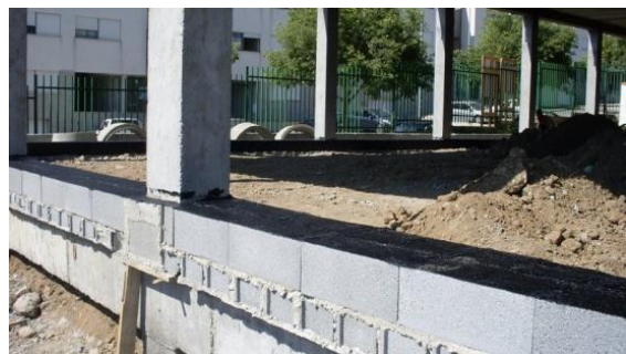
Fig. 208 – Impermeabilização completa em todo o perímetro do edifício
