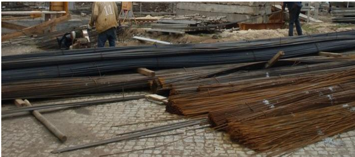
Fig.75 Armazenamento da armadura na obra
