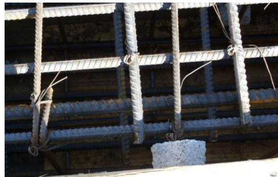
Fig. 168 – Armadura de uma viga com o respectivo espaçador
