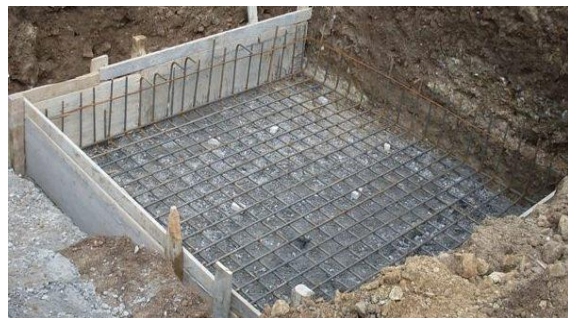
Fig. 195 – Armadura da sapata da caixa de elevador
