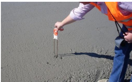
Fig. 177 – Uso de bitola no controlo de espessura da laje de 25 cm
