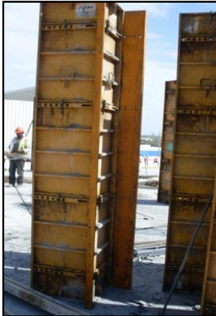
Fig.53 Conjunto de Cofragens para pilares
