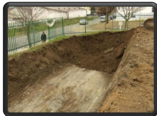
Fig. 111 – Escavação na zona Este para a fundação do muro de suporte
