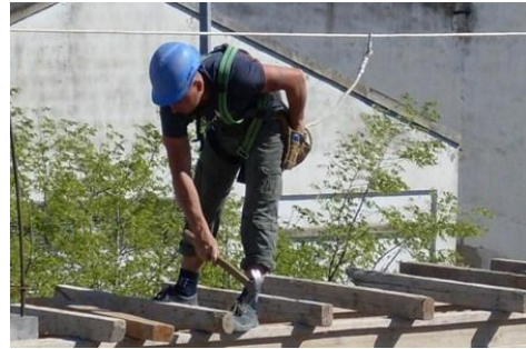
Fig. 244 – O trabalhador utiliza Capacete, Cinto de Segurança e arnês pois está a trabalhar em patamar elevado
