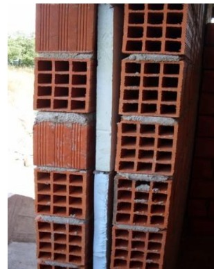
Fig. 231 - XPS nas caixas-de-ar das paredes exteriores
