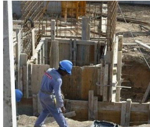
Fig. 198 – Cofragens interior e exterior da parede maciça
