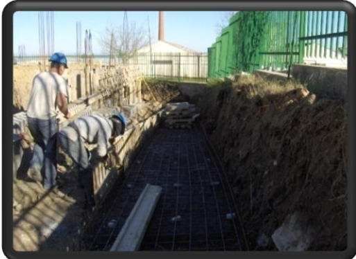
Fig. 140 – Cofragem da sapata do Muro
