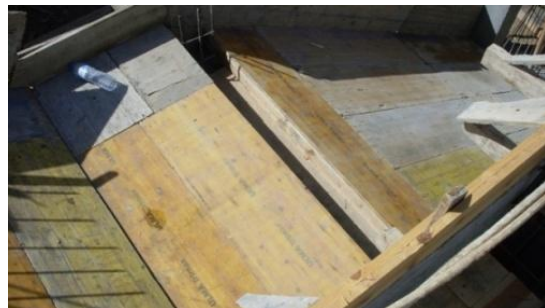
Fig. 183 - Cofragem da escada (tábuas de solho)
