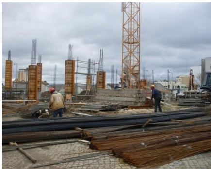
Figura 14- Varão A400 NR entre 6 e 12 mm e Arames de Aço recosido para betão
