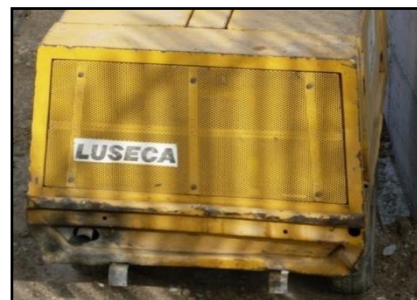
Fig.52 Gerador de energia eléctrica
