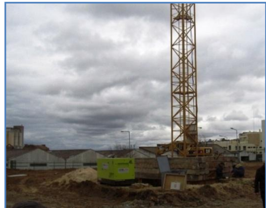
Fig. 101 - Montagem da grua
