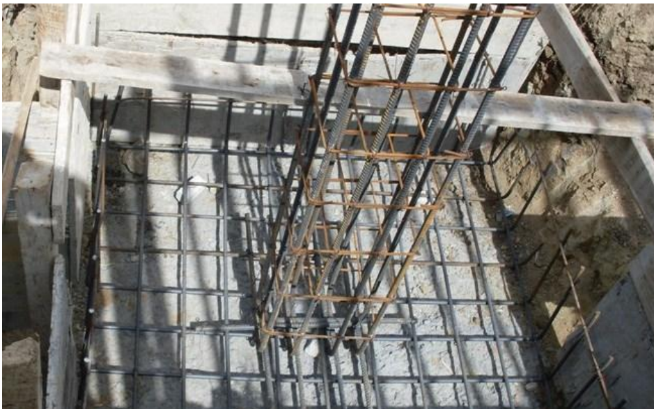
Fig. 148 – Armadura do pilar ligada à da sapata
