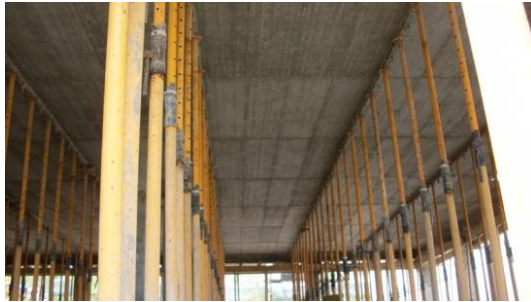
Fig. 180 – Retirada das tábuas de solho da cofragem da laje do tecto do piso 0 mantendo os prumos de escoramento
