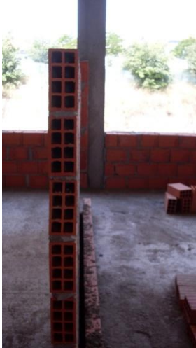
Fig. 222 – Execução da primeira fiada do 2º pano da parede interior dupla
