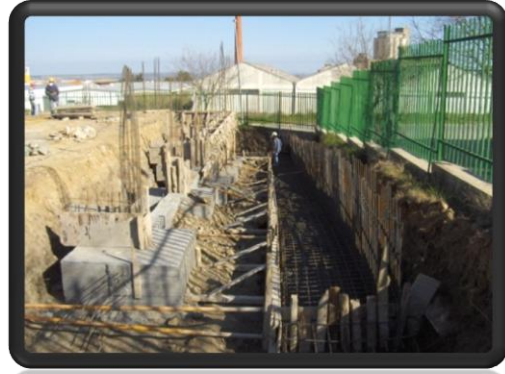
Fig. 141 - Colocação de armadura na sapata do muro
