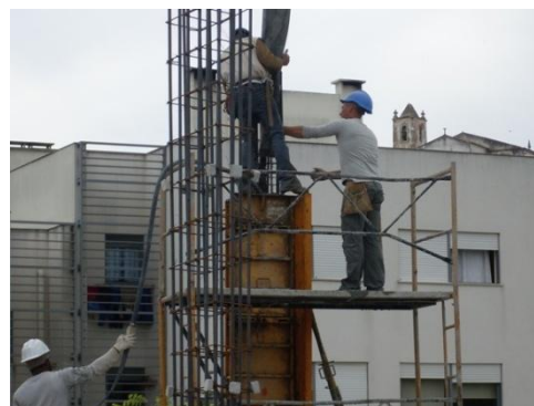
Fig. 158 – Betonagem de um pilar e plataforma de apoio anexa
