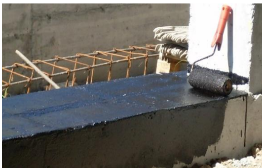
Fig. 207 – Impermeabilização
