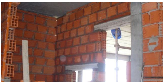
Fig. 226 – Vigotas pré moldadas para as vergas das portas e das janelas
