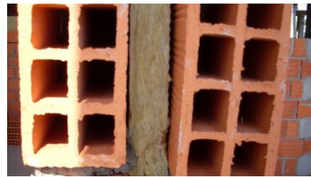
Fig. 229 - Lã de rocha nas caixas-de-ar das paredes interiores
