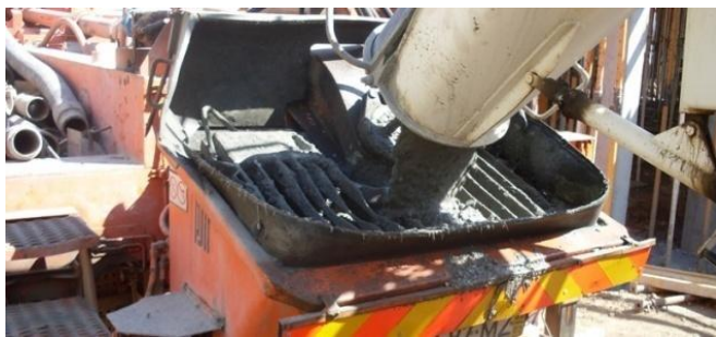
Fig.72 Recepção do betão na tremonha do camião bomba
