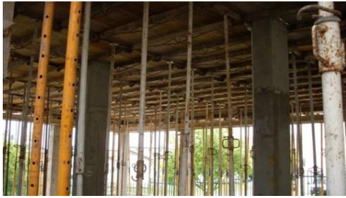
Fig. 25 – Escoramento da laje com prumos extensíveis espaçados 60 cm
