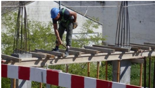
Fig. 161 – Carpinteiro munido de arnês de segurança a executar a cofragem de uma viga
