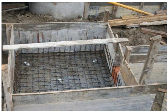
Fig. 80 Cofragem de madeira para sapata
