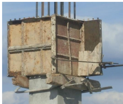
Fig. 81. Cofragem metálica aplicada em pilares
