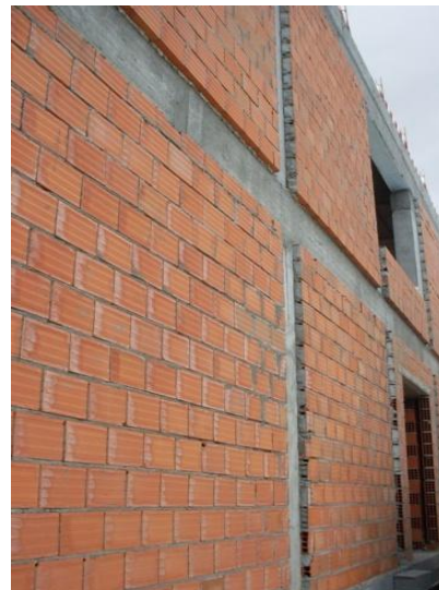
Fig. 214 – Paredes Exteriores já executadas
