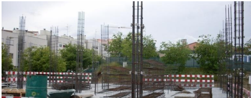
Fig. 151 - Pilares Armados no Piso 1
