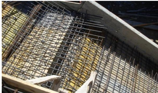
Fig. 188 - Armadura do patim da escada
