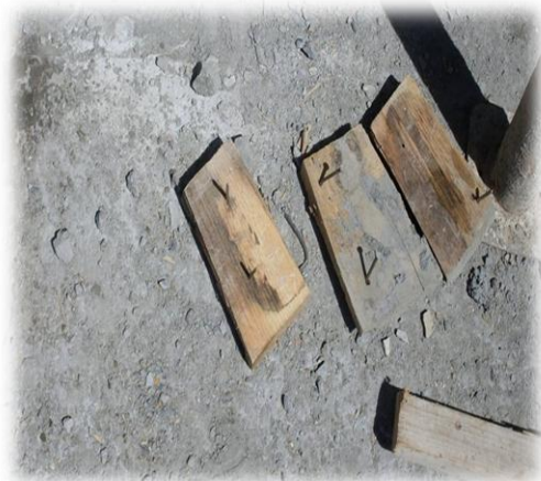
Fig. 262 – Tábuas no chão com pregos virados para cima.
