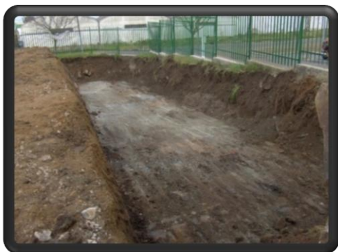
Fig. 138 - Preparação e limpeza do terreno
