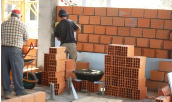
Fig. 211 – Execução das Paredes Exteriores
