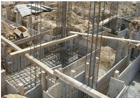
Fig. 129 - Armaduras de pilares e de sapatas
