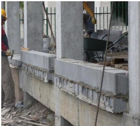
Fig. 205 – Assentamento da segunda e última fiada de blocos
