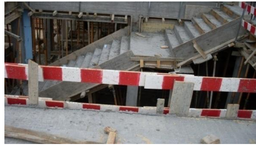
Fig. 192 - Descofragem dos degraus da escada
