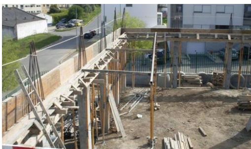
Fig. 163 – Cofragem de viga e início da cofragem da laje do tecto do piso 0
