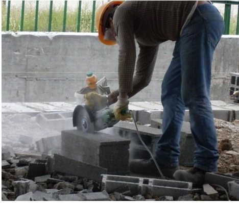
Fig. 243- Procedimento Correcto: Utilização de Capacete, Óculos, Botas e Luvas de Protecção.
