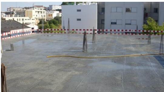
Fig. 179 – Rega da Laje algum tempo após a betonagem como medida de prevenção de secagem rápida (Cura do Betão)
