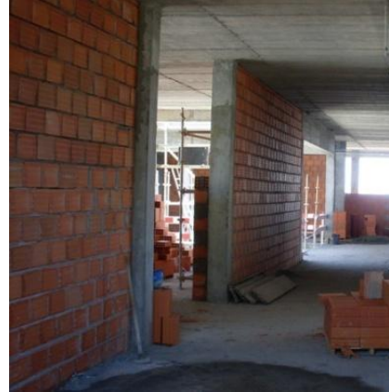
Fig. 223 – Parede interior simples 20 (espessura 20 cm)
