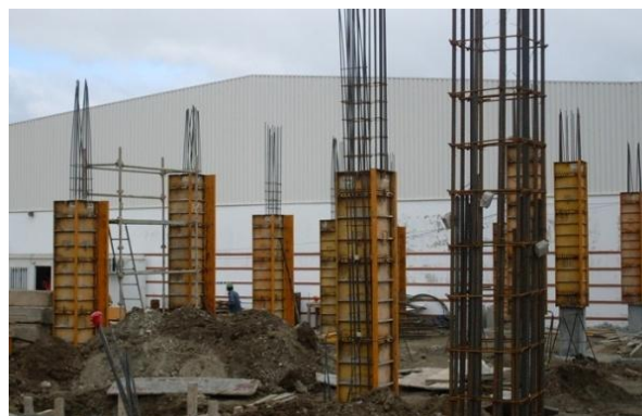
Fig. 153 – Cofragem dos pilares do piso 0 (térreo)
