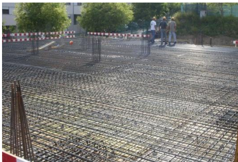
Fig. 171 – Armadura superior e inferior da laje do tecto do piso 0
