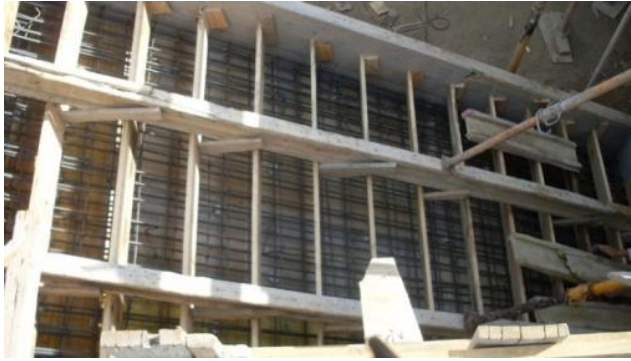
Fig. 186 – Escoramento da cofragem da escada após colocação da armadura
