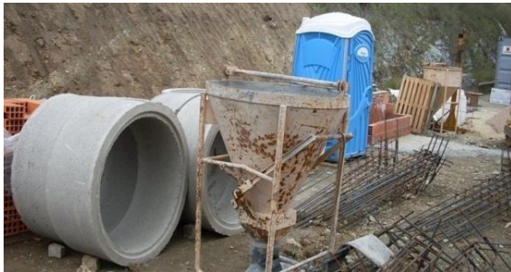
Fig.93 - Zona de depósito de materiais, algum pequeno equipamento e 1 WC
