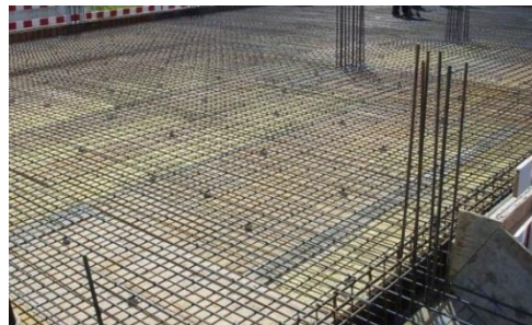
Fig. 170 – Armadura inferior da laje do tecto do piso 0, verificando-se os espaçadores que garantem o recobrimento
