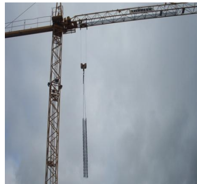
Fig. 266 - Armadura de Pilar em suspensão
