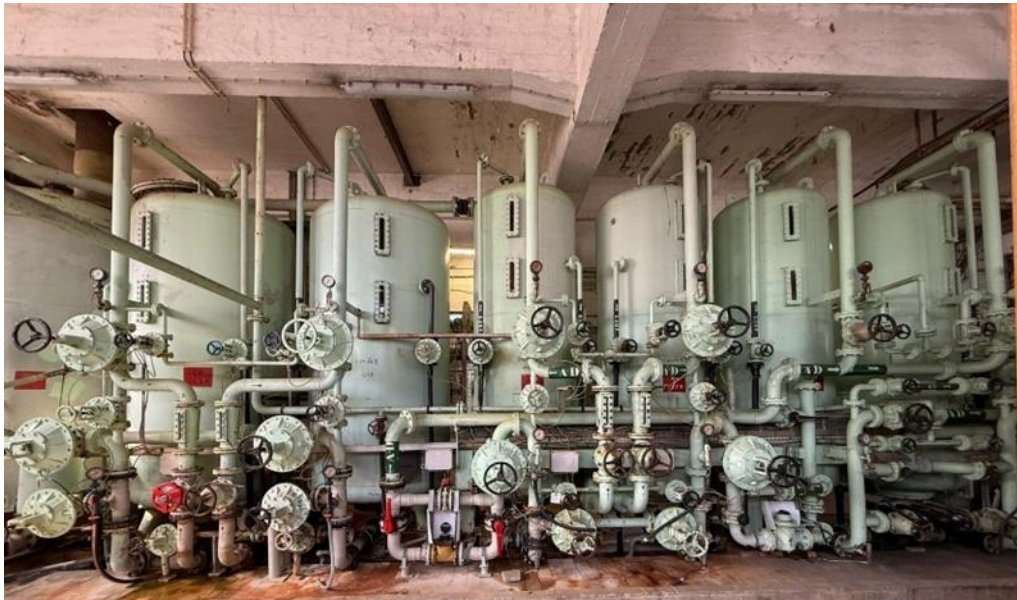
Figura 7 - Sistema de resinas de troca iónica presente na UFAA.
