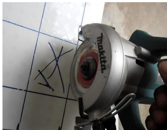
Figura 6-38 – Corte do elemento cerâmico com rebarbadora. [41]
