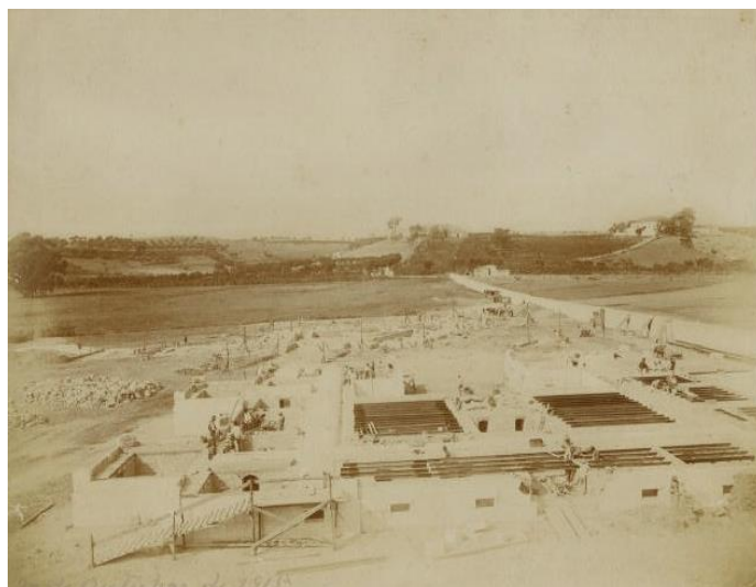
Figura 4-9 – Foto da construção da cave do edifício 24. [FONTE: CHPL]
