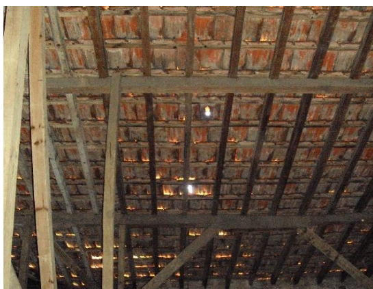
Figura 5-67 – Cobertura do pavilhão 24-A vista do interior. [FONTE: Autor]
