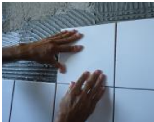
Figura 6-24 – Colocação do azulejo. [38]
