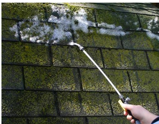
Figura 6-39 - Limpeza dos líquenes com aspersão. [42]
