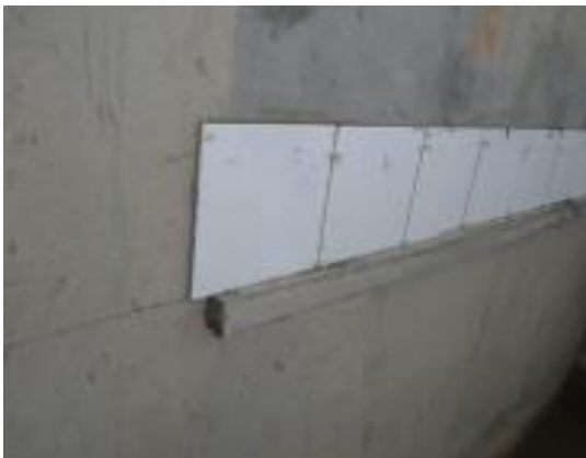
Figura 6-22 – Marcação da parede. [38]
