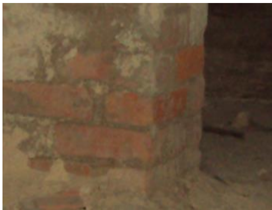
Figura 4-5 - Alvenaria de pedra à vista num pilar da cave. [FONTE: Autor]
