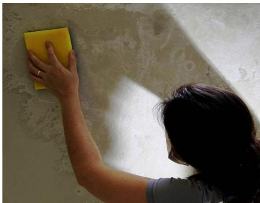
Figura 6-18- Limpeza de manchas de humidade com esponja. [37]
