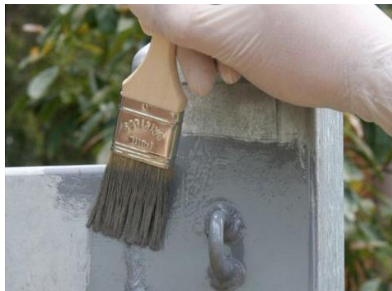
Figura 6-43 - Aplicação de produto antioxidante [43]
