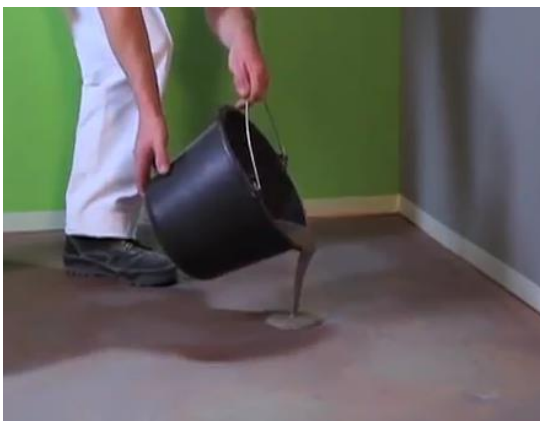
Figura 6-31- Aplicação da mistura no pavimento. [40]
