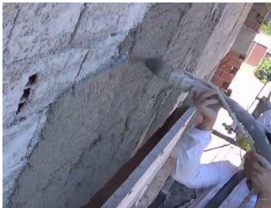
Figura 6-6 – Projeção do reboco [57]
