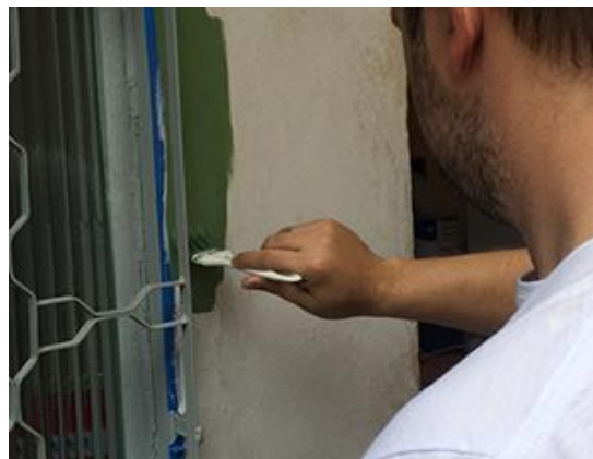
Figura 6-11 - Utilização da trincha em pormenores da janela. [31]
