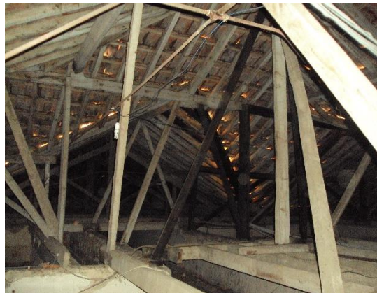
Figura 4-12 - Cobertura do pavilhão 24-A [FONTE: Autor]
