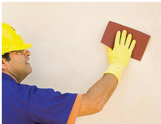
Figura 6-9 - Remoção de excessos e imperfeições com uma lixa [28]
