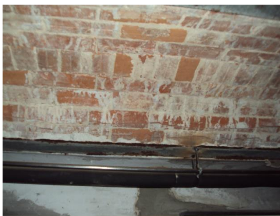
Figura 4-7 - Abóbodas de alvenaria apoiadas nas vigas metálicas na cave. [FONTE: Autor]
