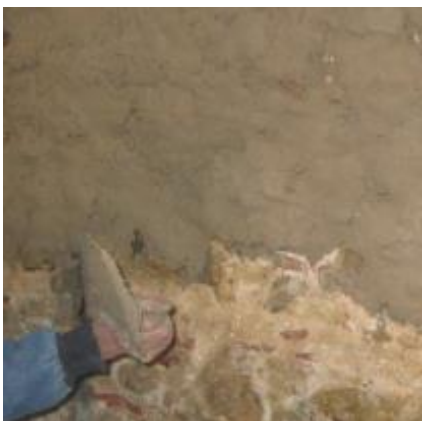
Figura 6-2 - Aplicação da argamassa de consolidação [23]
