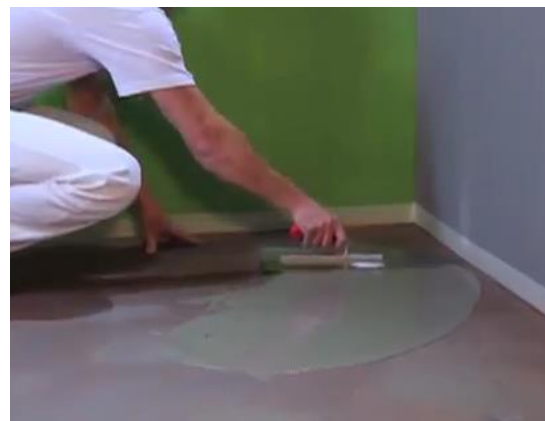
Figura 6-32 - Espalhamento da mistura com a pá de alisar. [40]
