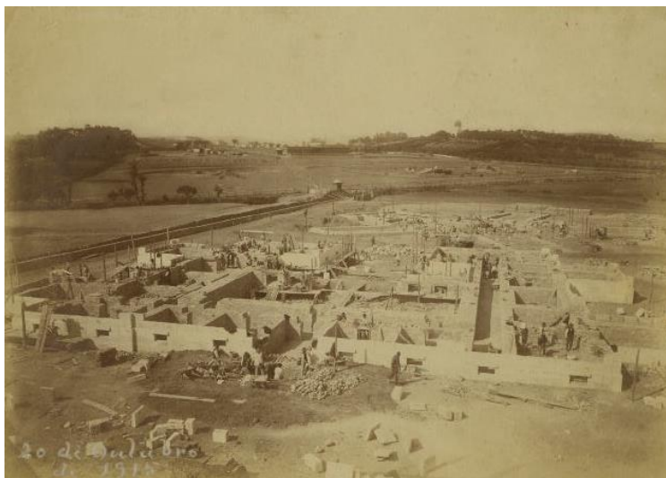
Figura 4-1 - Construção do edifício 24-A [FONTE:CHPL]
