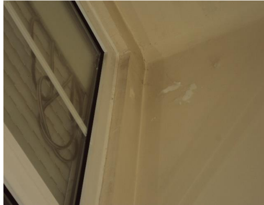
Figura 5-64- Janela do quarto 19 [FONTE: Autor]
