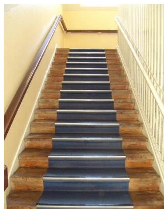
Figura 4-14 - Escada de acesso ao piso 1. [FONTE: Autor]
