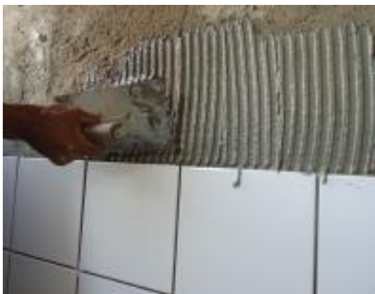
Figura 6-23 - Aplicação do cimento cola. [38]
