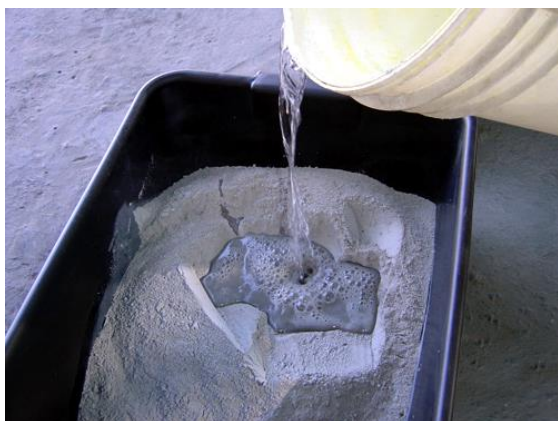
Figura 6-33 – Mistura da argamassa [41]
