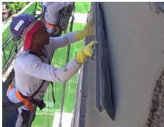
Figura 6-7 – “Sarrafamento” do reboco [57]
