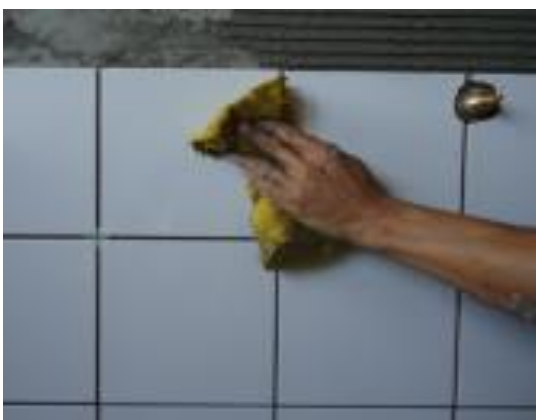
Figura 6-27 - -Limpeza do elemento azulejo. [38]
