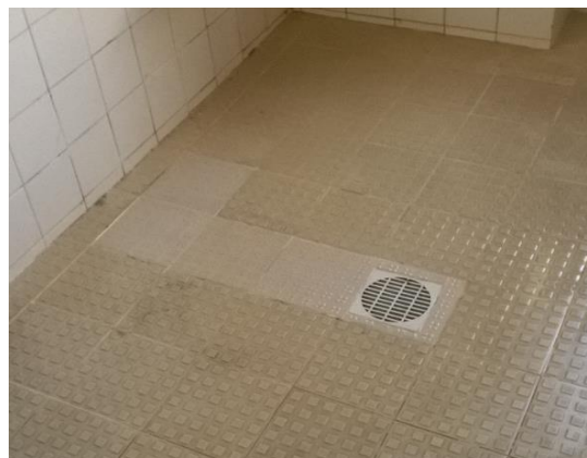
Figura 5-19 – Intervenção nos Chuveiros da casa de banho 35, piso 1 [FONTE: Autor]
