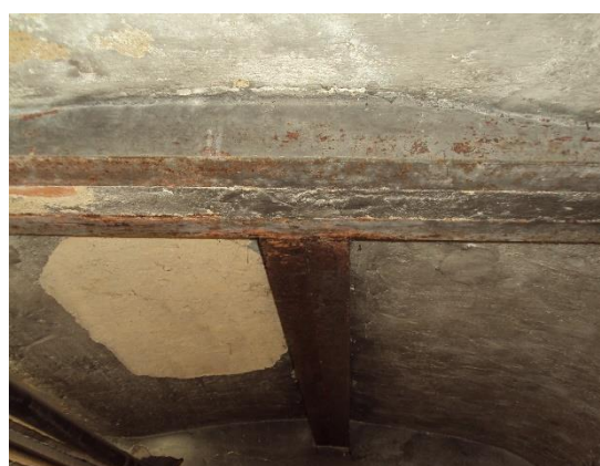
Figura 4-8 - Vigas metálicas em I na cave [FONTE: Autor]
