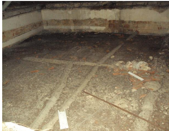
Figura 4-11 - Pavimento do piso da cobertura. [FONTE: Autor]
