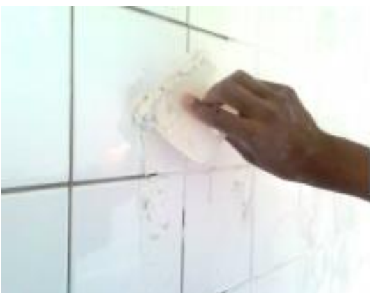
Figura 6-28 – Colocação de Betume entre azulejo. [38]
