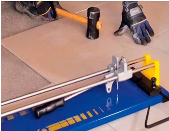
Figura 6-36 – Assentamento da peça cerâmica com maço. [41]
