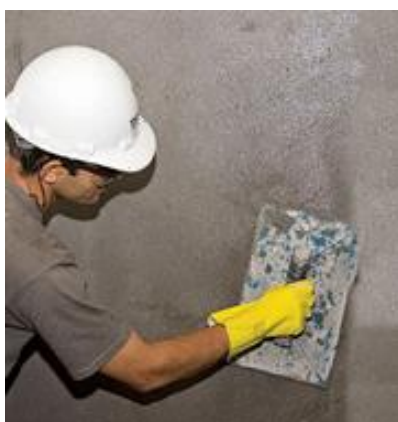
Figura 6-8 – Talochamento e acabamento do reboco [24]
