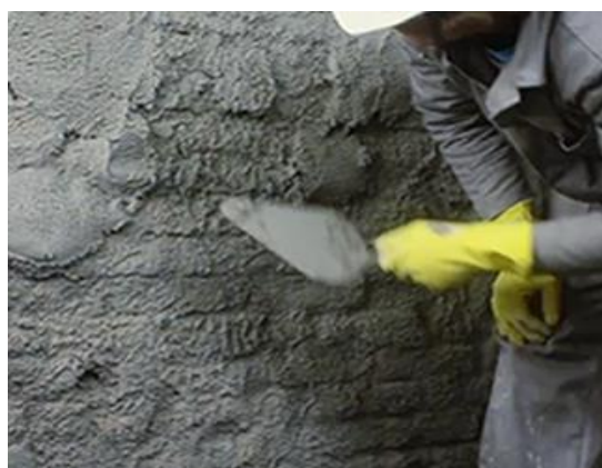
Figura 6-46 - Aplicação do reboco desumidificante. [53]
