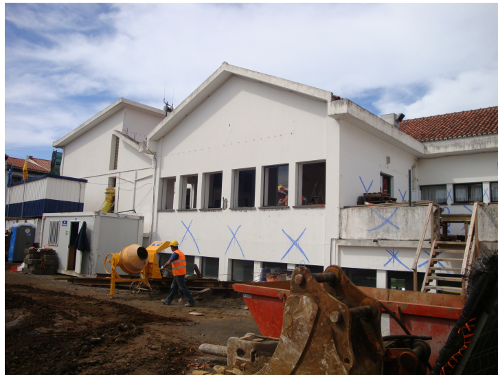
Fig. 2.3 – Zona tardo do edifício antes da demolição
