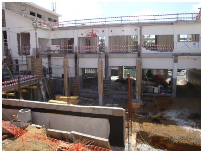
Fig. 2.7 – Escavação para ampliação das garagens
