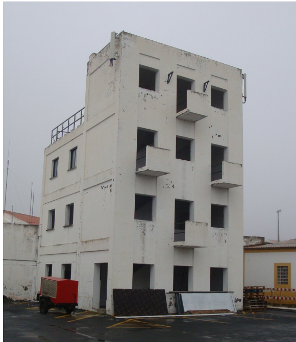
Fig. 2.5 – Torre de treinos antes da demolição
