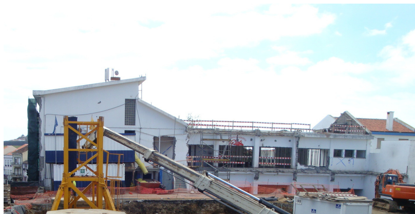
Fig. 2.4 – Zona tardo do edifício após a demolição
