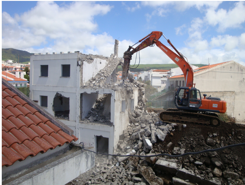
Fig. 3.8 – Demolições com maquinaria pesada
