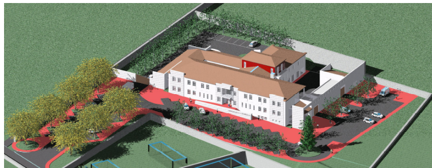
Fig. 2.8 – Vista aérea Nordeste/Sudoeste
