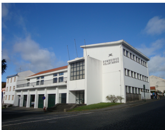
Fig. 3.9 – Edifício existente inicialmente
