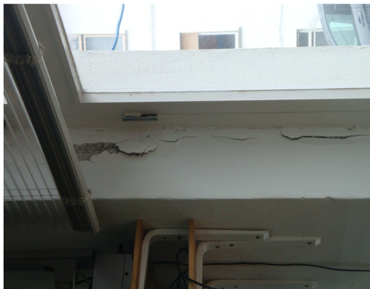
Fig. 4.4 – Levantamento de estrutura vizinha
