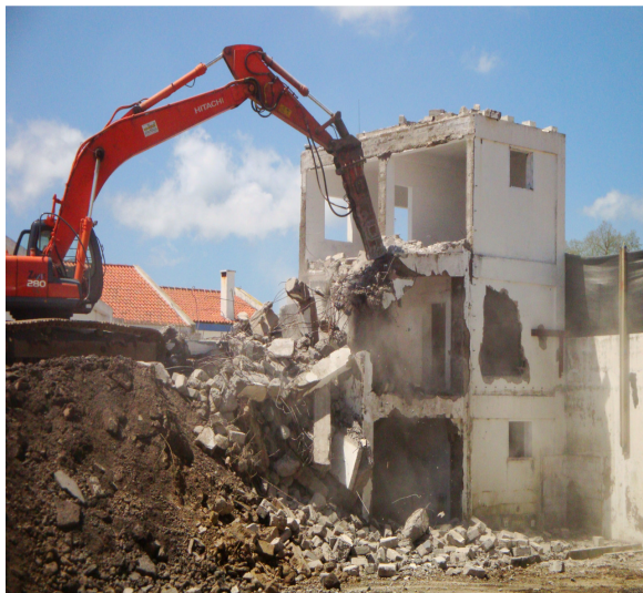
Fig. 2.6 – Torre de treinos após a demolição
