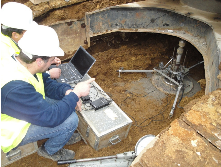
Fig. 3.7 – Execução de ensaio de carga em placa
