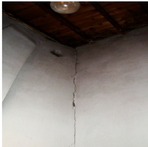
Fig. 4.5 – Levantamento de estrutura vizinha
