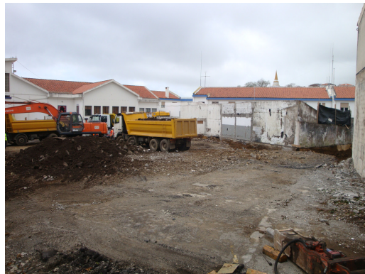
Fig. 3.12 – Demolição da zona interior
