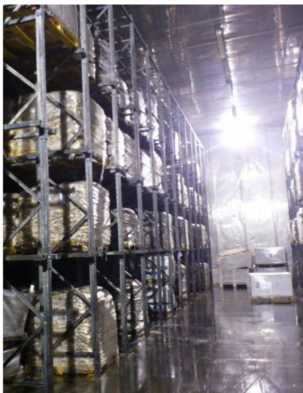
Figura V.4.: Estantes de armazenamento de bacalhau – Câmara frigorífica de maturação.
