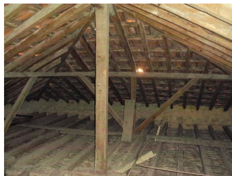
Figura 11. Estrutura de madeira, da cobertura [Fonte: Autora]
