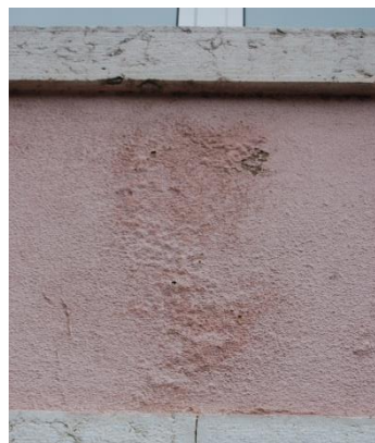
Figura 11. Empolamentos da pintura (cripto-florescências) [Fonte: Autora, Data: 03-02-2017]
