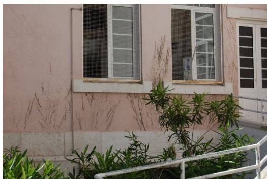
Figura 21. Vestígios de vegetação na Fachada Posterior (orientada a Noroeste) [Fonte: Autora, Data:18-05-2016]
