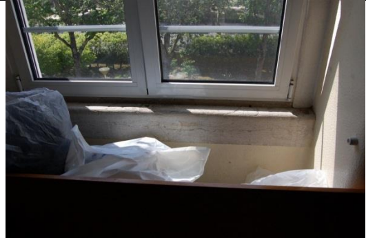
Figura 186. Fracturação do peitoril [Fonte: Autora, Data: 30-05-2016]
