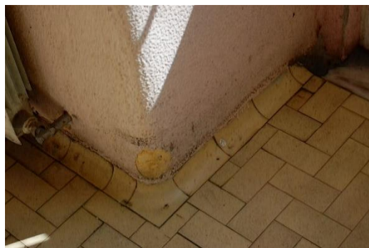
Figura 20. Desgaste natural, do ladrilho cerâmico [Fonte: Autora]
