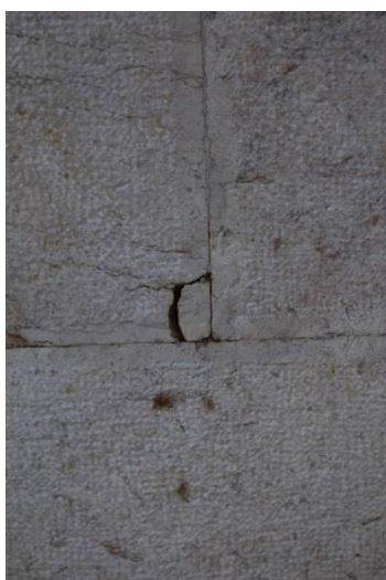
Figura 136. Destaque de fragmentos, perto das juntas [Fonte: Autora, Data: 01-09-2016]
