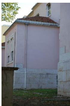
Figura 12. Tubo de queda na Fachada Lateral Nascente [Fonte: Autora]
