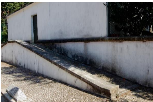
Figura 8. Acesso ao tardoz do Edifício [Fonte: Autora]
