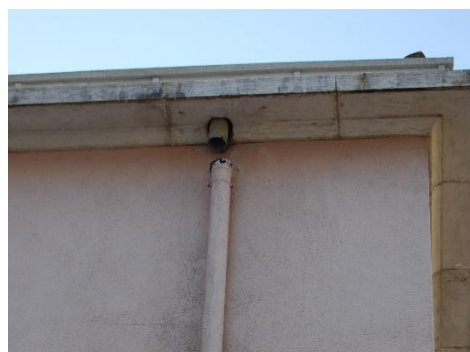
Figura 13. Tubo de queda separado do bocal [Fonte: Autora]
