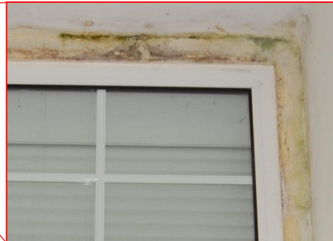
Figura 70. Pormenor da Colonização Biológica [Fonte: Autora, Data: 19-05-2016]
