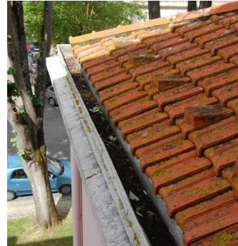
Figura 133. Telhas sobrepostas [Fonte: Autora, Data: 25-06-2016]
