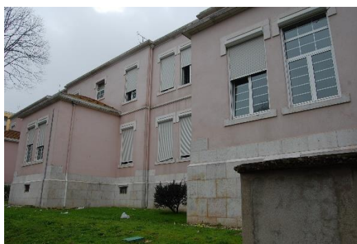
Figura 5. Vista da Fachada lateral Nascente [Fonte: Autora]
