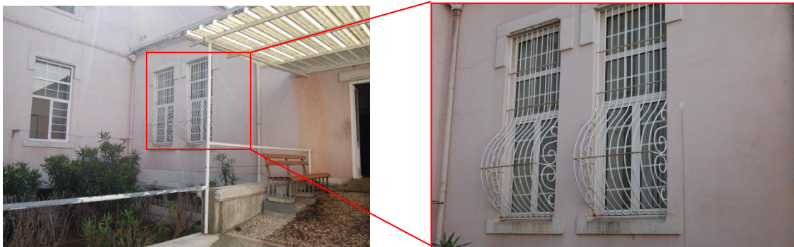
Figura 188. Gradeamento das Janelas do R/C em ferro, na fachada posterior [Fonte: Autora, Data:31-05-2016]
