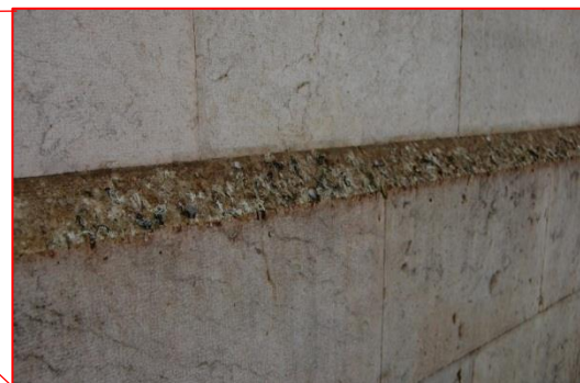
Figura 147. Pormenorização da deposição de guanos [Fonte: Autora, Data:01-09-2016]
