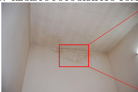
Figura 112. Aparecimento de eflorescências e Cripto florescências, no quarto n° 33 [Fonte: Autora, Data: 30-05-2016]
