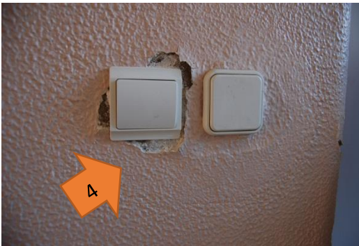
Figura 49. Aparecimento de cripto-eflorescências e eflorescências junto dos interruptores [Fonte: Autora, Data: 19-05-2016]
