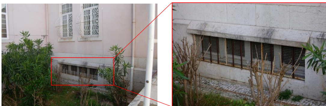
Figura 189. Gradeamento das Janelas da Cave em ferro, na fachada posterior [Fonte: Autora, Data: 31-05-2016]
