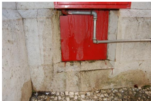
Figura 168. Deposição superficial de substâncias exógenas, com cor de cinza, em zonas da cornija. [Fonte: Autora, Data: 18-05-2016]
