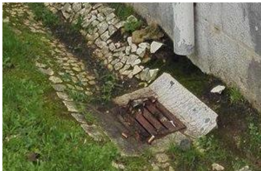
Figura 204. Sarjeta entupida [Fonte: Autora, Data: 03-02-2017]
