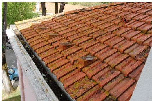
Figura 10. Revestimento da cobertura, em telha de Marselha [Fonte: Autora]
