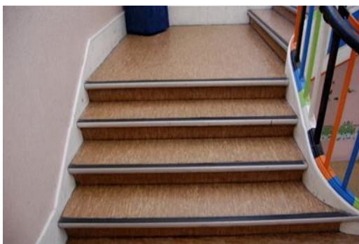
Figura 28. Lanço de escadas em bom estado [Fonte: Autora]
