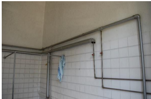
Figura 21. Rede de abastecimento de água [Fonte: Autora]
