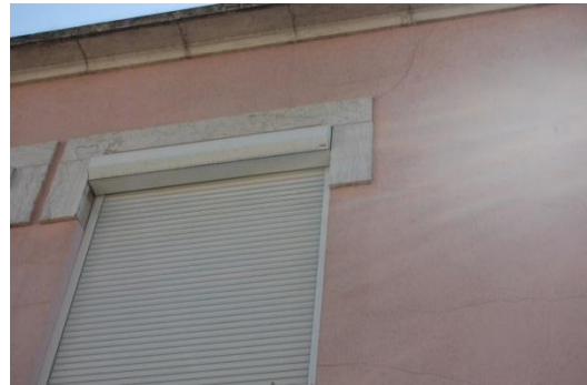
Figura 160. Deposição superficial de substâncias exógenas, com cor de cinza, em zonas da cornija.
