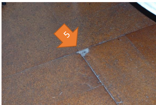
Figura 86. Esmagamento ou lascagem dos rebordos, são movimentos diferenciais que resultam da compressão nos ladrilhos em cortiça, Quarto nº33, 1ºAndar [Fonte: Autora, Data: 30-05-2016]
