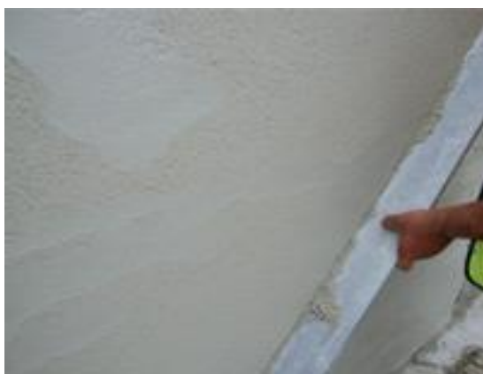
Figura 115--Superfície a ser raspada por régua metálica para a desempenar preparando a parede para o próximo revestimento. Fonte: https://www.weber.com.pt/webercal-sane.html
