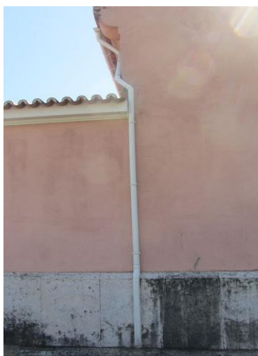
Figura 41- Tubo de descarga junto à fachada principal. Fonte: Autor, setembro 2017.
