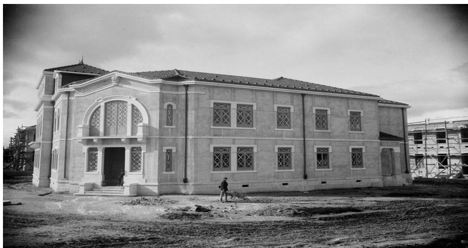
Figura 7- Hospital Júlio de Matos em construção. Fonte: http://restosdecoleccion.blogspot.pt/2014/06/hospital-julio-de-matos.html
