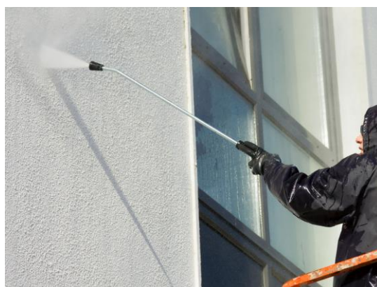
Figura 113- Limpeza de paramento com jato de água.
