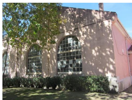
Figura 14- Fachada tardez. Fonte: Autor, setembro 2017.
