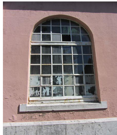
Figura 27- Vão de janela, evidenciando o arco na região superior. Fonte: Autor, setembro 2017.
