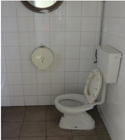
Figura 23- Revestimento paramento instalação sanitária. Fonte: Autor, setembro 2017.
