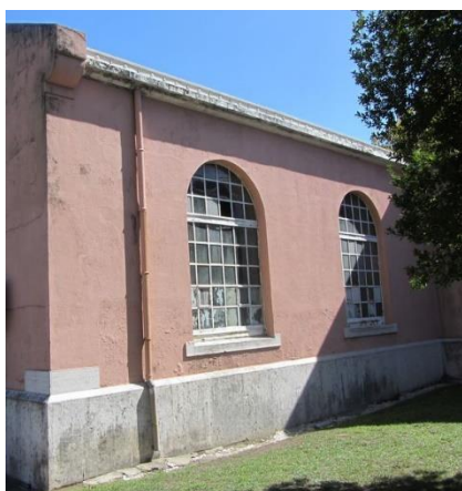
Figura 15- Fachada lateral direita. Fonte: Autor, setembro 2017.
