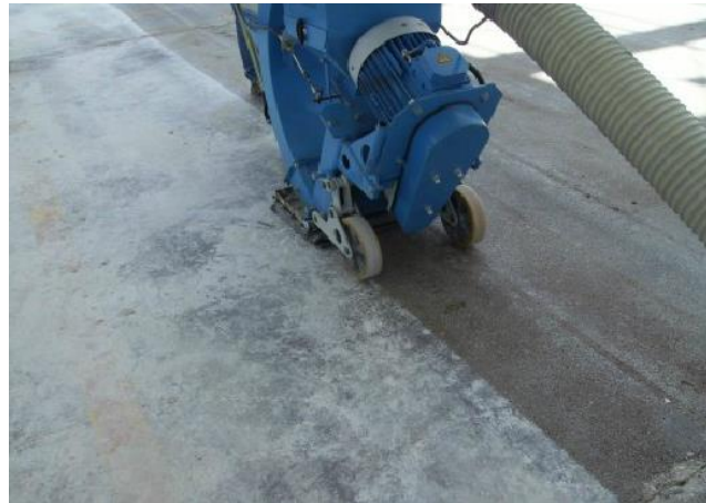
Figura 129- Granalhagem de betonilha. Fonte: http://www.lusogranalhagem.pt/galeria-fotos.html
