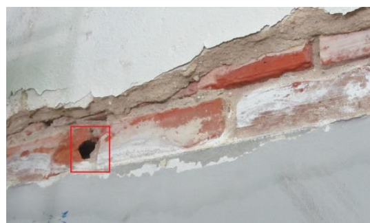
Figura 18- Identificação do tipo de tijolo usado na construção das paredes. Fonte: Autor, setembro 2017.
