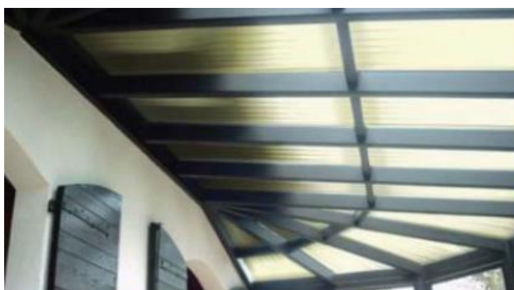
Figura 121- Placas de policarbonato alveolar montadas numa cobertura. Fonte: http://www.plexicril.com/produtos/policarbonatos/policarbonato-alveolar/thermopanel/
