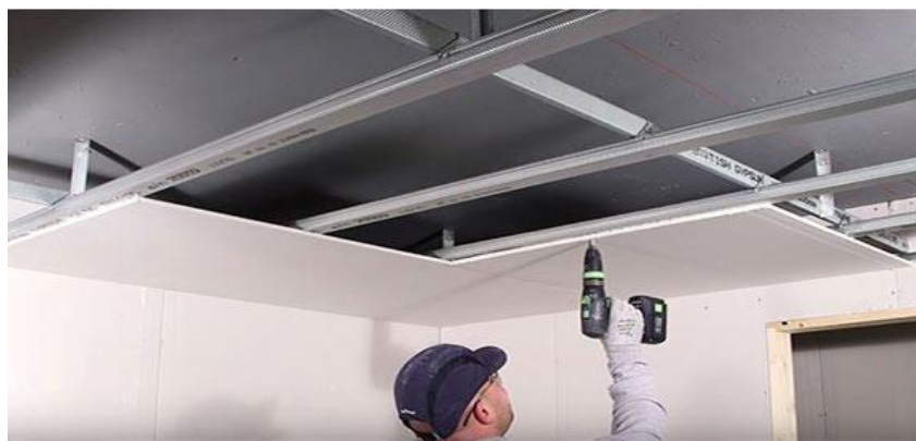
Figura 128- Colocação das placas de gesso cartonado com a estrutura montada. Fonte: http://www.josina.pt/placas-de-gesso-e-acessorios/
