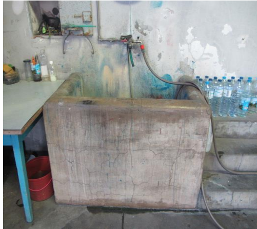
Figura 30-Tanque situado junto da entrada do edifício. Fonte: Autor, setembro 2017.
