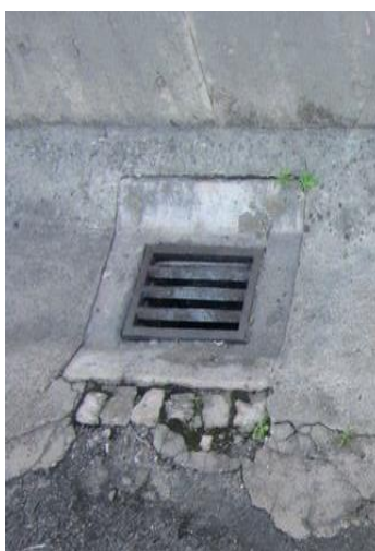
Figura 43- Caixa de visita junto à fachada principal. Fonte: Autor, setembro 2017.
