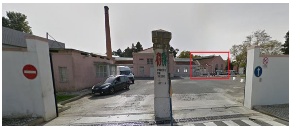
Figura 6-Identificação do edifício 31-A, garagem, na parte sudeste do complexo hospitalar, junto à saída para a Rua das Murtas. Fonte: Google Maps, setembro 2017.
