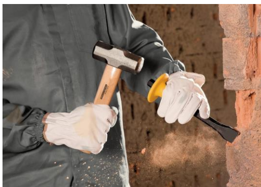
Figura 112- Remoção manual de material degradado. Fonte: http://www.tramontina.com.br/p/42700108-83-talhadeira-sextavada-8
