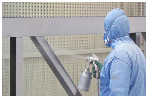
Figura 120- Pintura de estrutura metálica com pistola airless . Fonte: http://www.februce.com.br/servicos/pintura-airless
