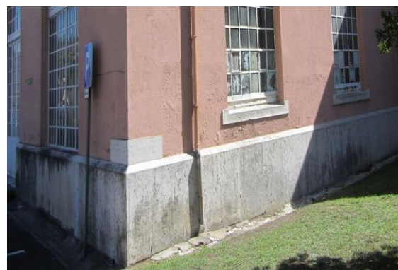
Figura 22- Revestimento de soco de lioz em todas as fachadas. Fonte: Autor, setembro 2017.
