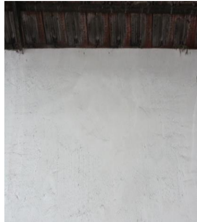
Figura 24- Revestimento paramento interior. Fonte: Autor, setembro 2017.
