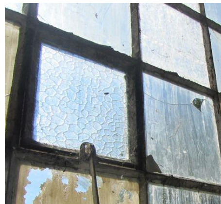
Figura 47- Diferentes vidros no mesmo vão de janela. Fonte: Autor, setembro 2017.
