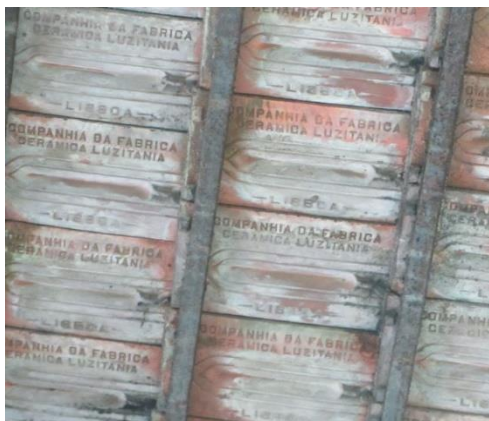
Figura 39- Telha marselha vista do interior do edifício. Fonte: Autor, setembro 2017.
