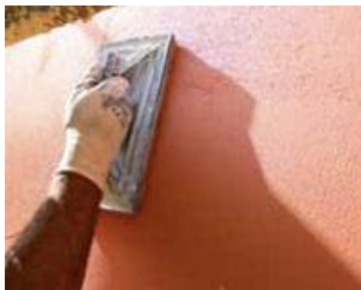
Figura 114-Alisamento da superfície por talocha, antes de ser areada por esponja. Fonte: https://www.weber.com.pt/webercal-decor.html
