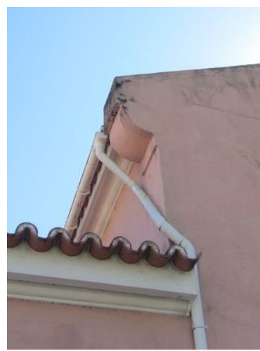
Figura 42- Pormenor do algeroz junto à fachada principal. Fonte: Autor, setembro 2017.
