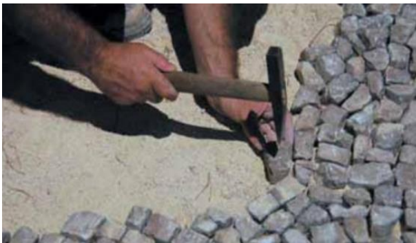
Figura 124- Assentamento de calçada. Fonte:[37]
