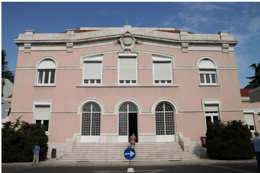
Figura 1-Fachada do edifício de entrada do complexo hospitalar. Fonte: http://restosdecoleccion.blogspot.pt/2014/06/hospital-julio-de-matos.html
