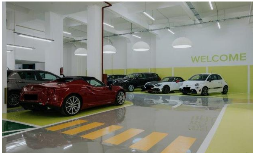
Figura 132- Aspeto final do revestimento Sikafloor 264. Fonte: Autor, novembro 2017.
