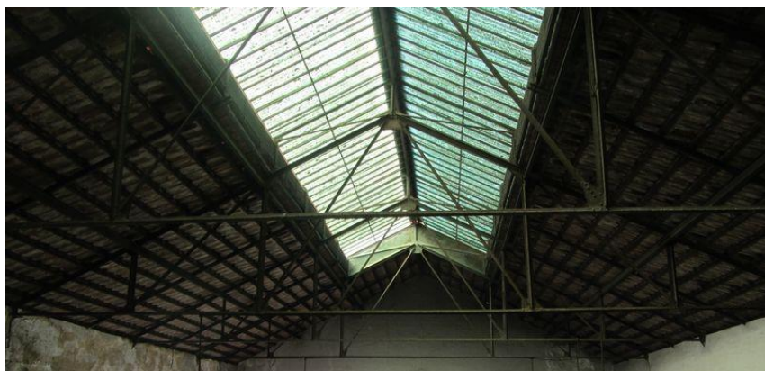
Figura 38- Revestimento do lanernim. Fonte: Autor, setembro 2017.
