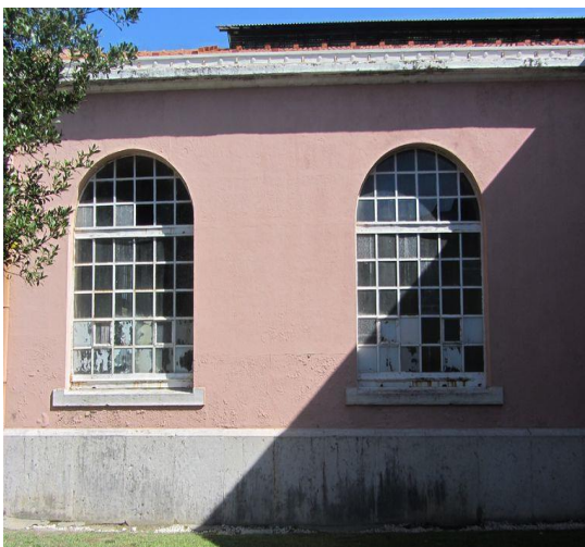
Figura 25- Fachada lateral direita com 2 vãos de janela. Fonte: Autor, setembro 2017.
