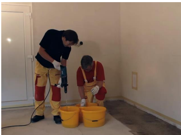
Figura 131- Preparação do primário através de misturadora. Fonte: https://www.youtube.com/watch?v=qsywd4z5NWA
