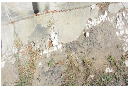
Figura 92—Presença de sujidades no canal de drenagem. (terra, areia, entre outros). Fonte: Autor, outubro 2017.
