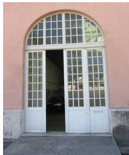
Figura 26- Vão de porta do edifício 31-A. Fonte: Autor, setembro 2017.
