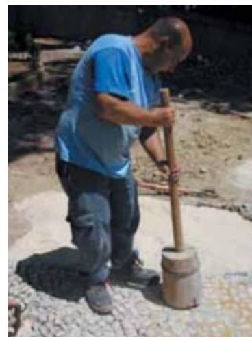
Figura 125- Compactação tradicional da calçada com um maço. Fonte:[37]
