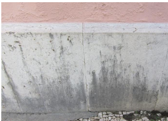
Figura 21- Pormenor da pedra de lioz com acabamento bujardado. Fonte: Autor, setembro 2017.
