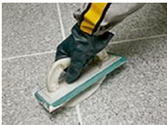
Figura 116- Betumação de juntas. Fonte: https://www.weber.com.pt/webercolor-epoxy.html
