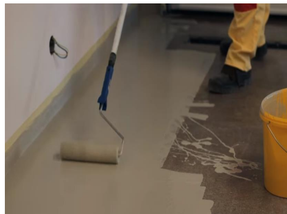
Figura 130- Aplicação do revestimento através de rolo de pelo médio. Fonte: https://www.youtube.com/watch?v=qsywd4z5NWA
