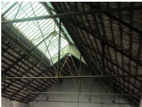
Figura 81-Estrutura da cobertura. Fonte: Autor, outubro 2017.
