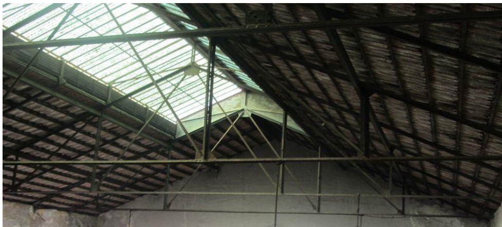
Figura 33- Cobertura do edifício 31-A. Fonte: Autor, setembro 2017.
