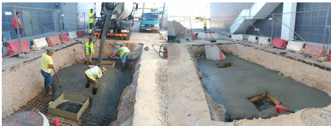
Figura 36 - Betonagem da laje superior
