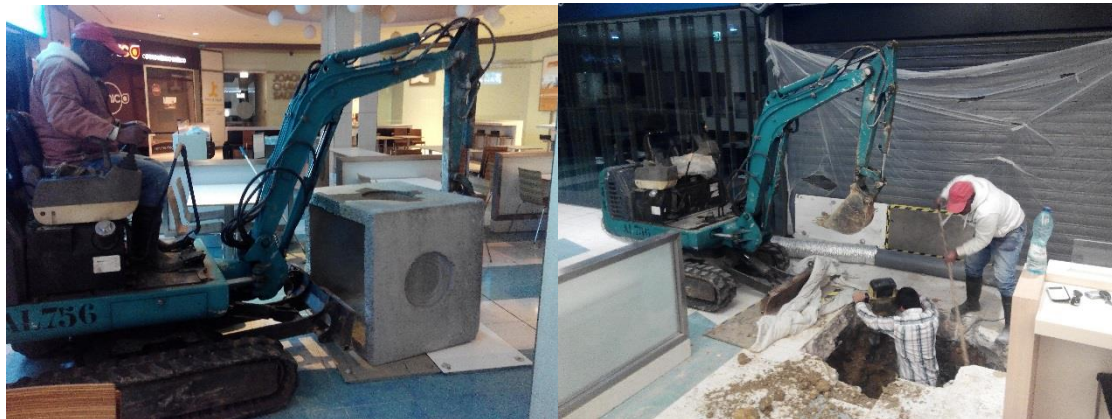
Figura 18 - Assentamento de caixas de visita
