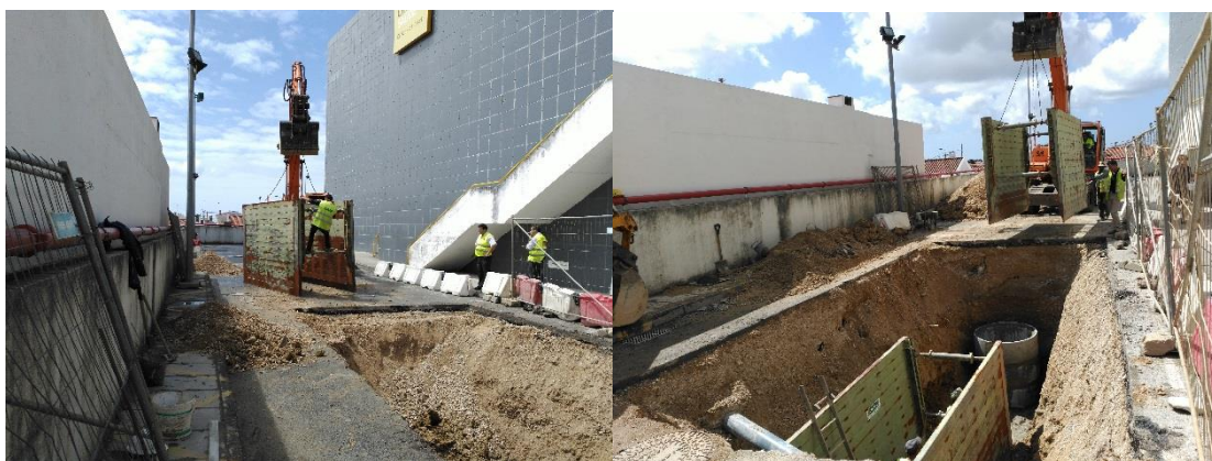
Figura 31 - Entivação da vala
