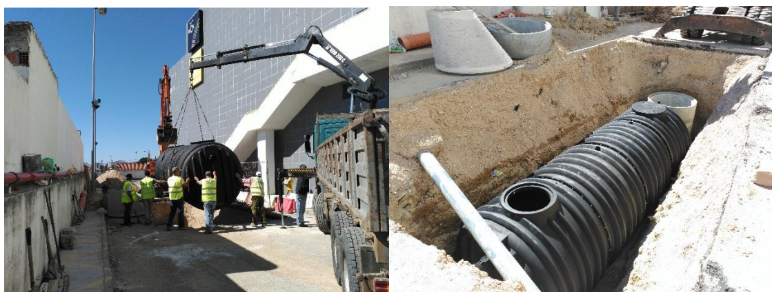
Figura 34 - Instalação do separador de gorduras
