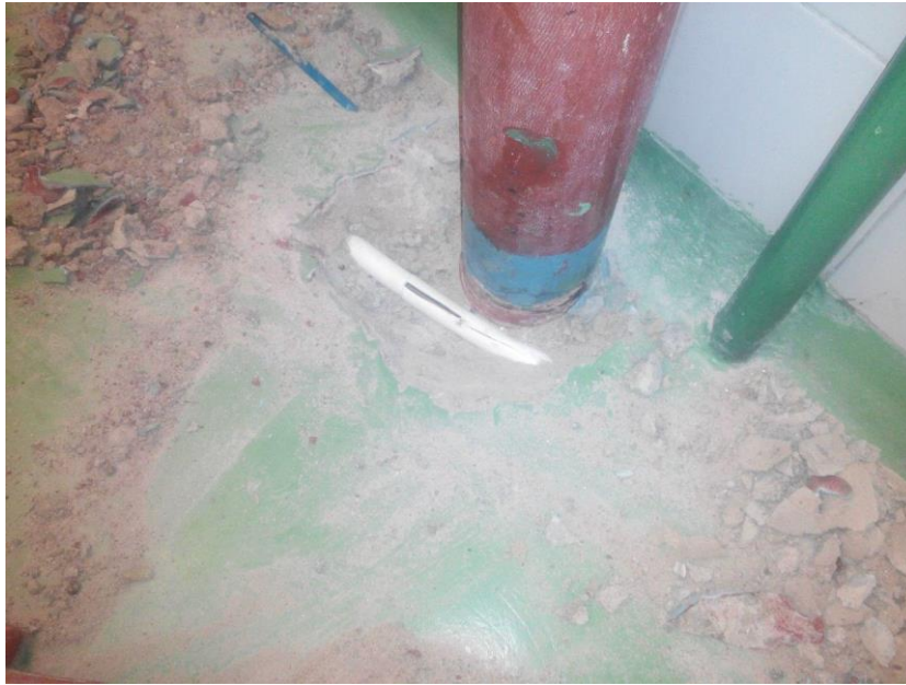
Figura 10 - Localização da tubagem de gás
