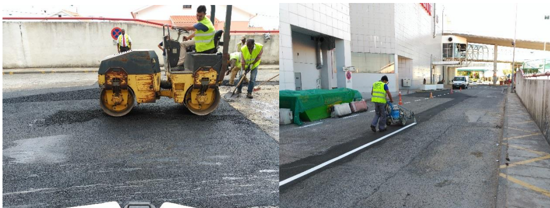
Figura 38 - Pavimentação e marcações rodoviárias
