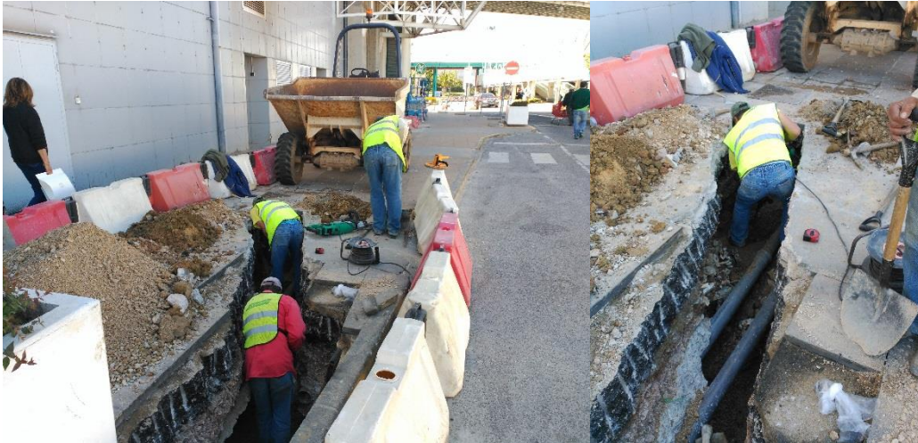
Figura 28 - Abertura de vala em passeio
