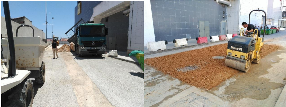
Figura 37 - Enchimento e compactação camada final
