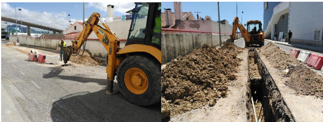
Figura 29 - Abertura de valas com meios mecânicos
