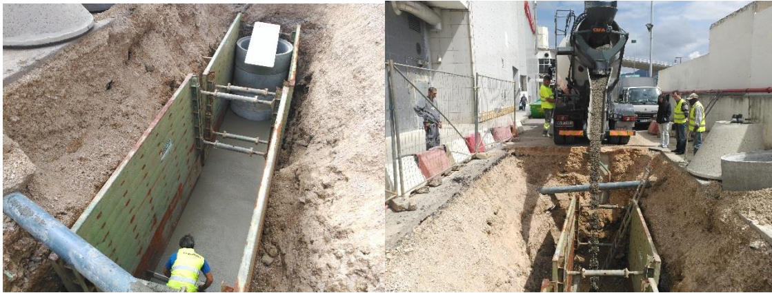
Figura 33 - Betonagem da laje de fundo
