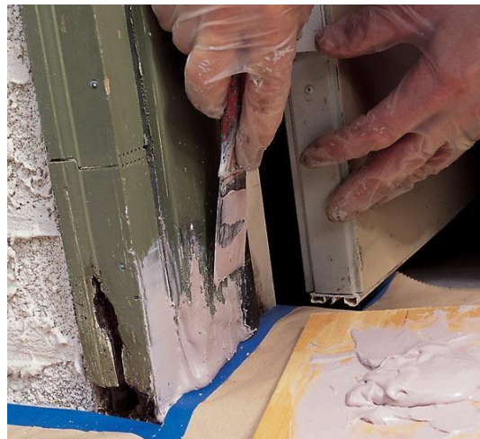
Figura 109 – Aplicação de massa de enchimento na porta de Madeira
