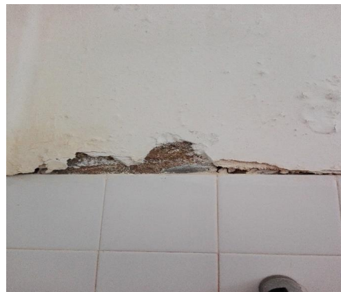
Figura 16 – Revestimento das paredes das instalações sanitárias
