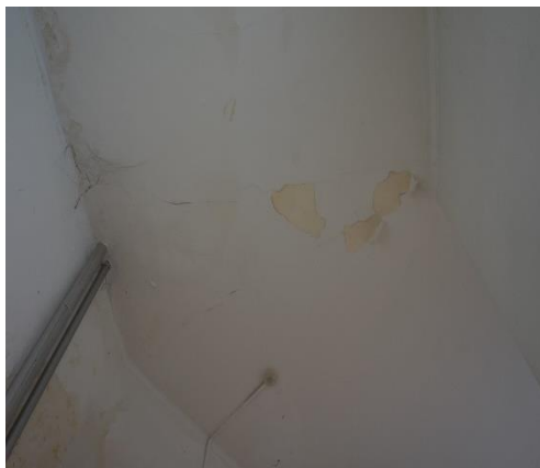
Figura 49 – Descasque da pintura no teto
