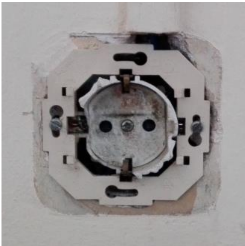
Figura 70 – Desencaixe do espelho da tomada elétrica
