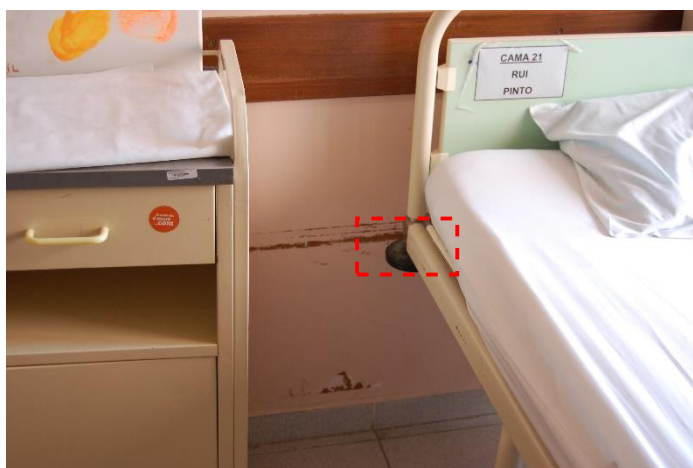
Figura 32 – Exemplo do desgaste do reboco nos quartos
