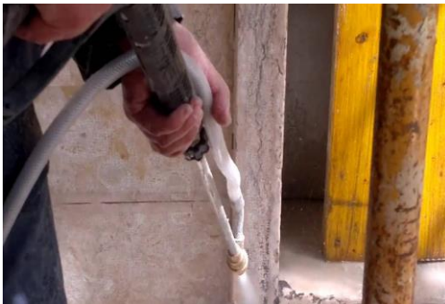
Figura 111 – Aplicação de um jato de água na pedra
