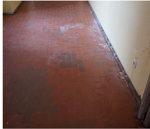
Figura 45 – Reparação dos empolamentos do pavimento
