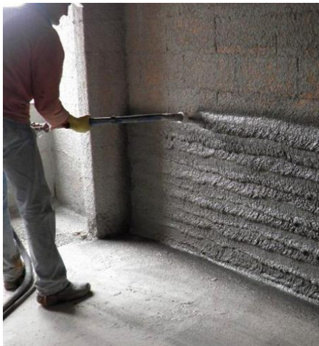
Figura 95 – Aplicação do salpico e reboco projetado
