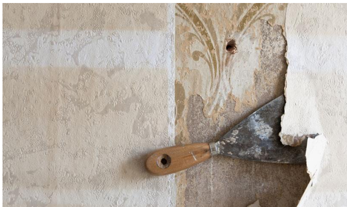
Figura 106 - Remoção da camada de tinta deteriorada
