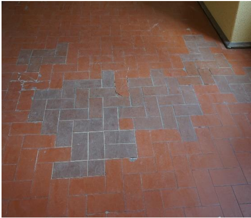
Figura 44 – Reparação dos empolamentos do pavimento
