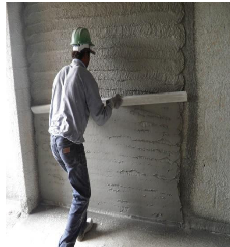
Figura 96 – Sarrafar o reboco com régua
