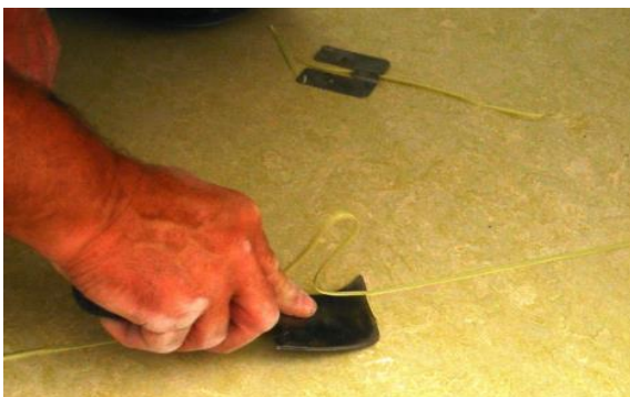
Figura 104 – Remoção do cordão de soldar em excesso aplicado [Gabriel, 2011]
