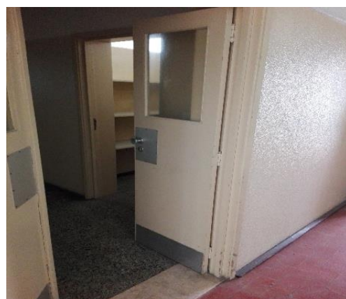
Figura 10 – Portas interiores em madeira
