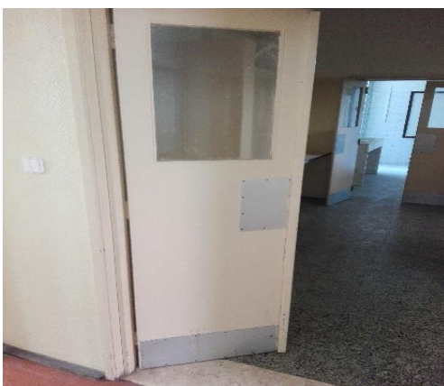
Figura 9 – Portas interiores em madeira
