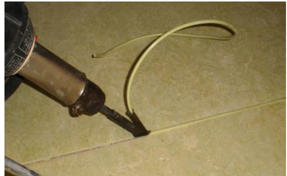
Figura 103- Aplicação do cordão de soldar com pistola de ar quente [Gabriel, 2011]
