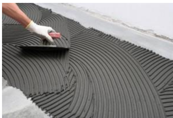
Figura 99 – Aplicação de cimento cola com um pente de Ladrilhador
