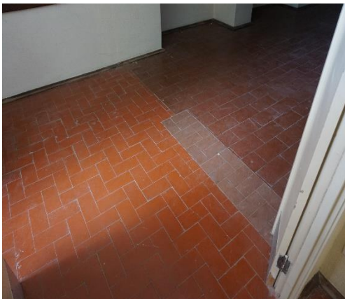
Figura 42 – Reparação dos empolamentos do pavimento
