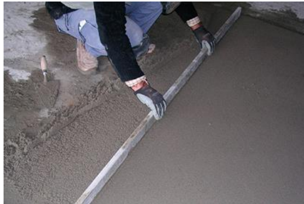
Figura 98 – Aplicação de betonilha no pavimento [Secil Argamassas – Betonilha, 2016]
