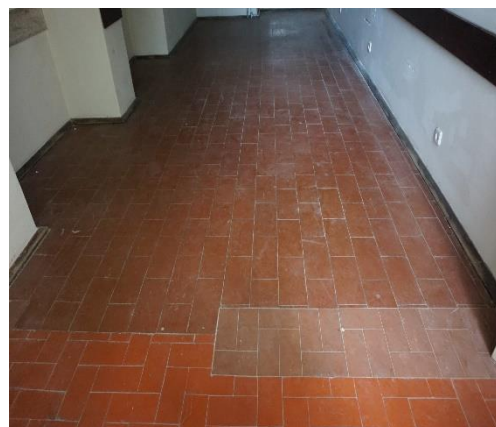
Figura 43 – Reparação dos empolamentos do pavimento
