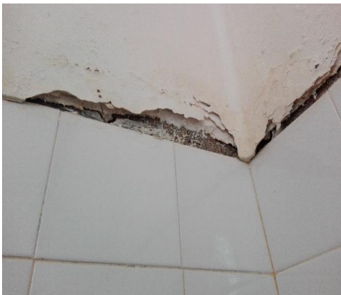
Figura 15 – Revestimento das paredes das instalações sanitárias
