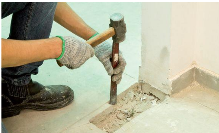
Figura 97 – Remoção do mosaico do pavimento
