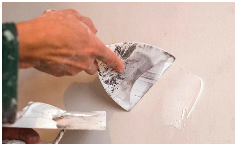
Figura 107 – Betumagem das superfícies para receber pintura [Sousa/UOL, n.d.]
