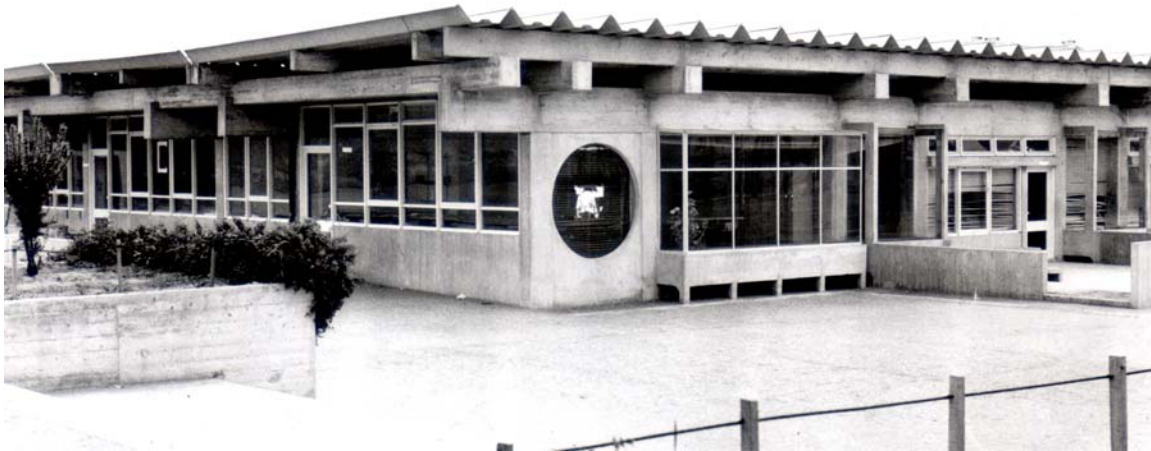
Figura 3-Solução de cobertura ventilada, num edifício escolar
