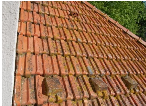
Figura 3.1 - Revestimento em telha marselha [JC, NQ].
