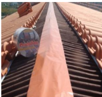
Figura 4.3 - Fita asfáltica autoadesiva na cumeeira [30].
