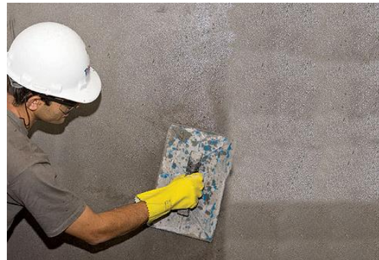
Figura 4.12 - Alisamento do reboco [35].
