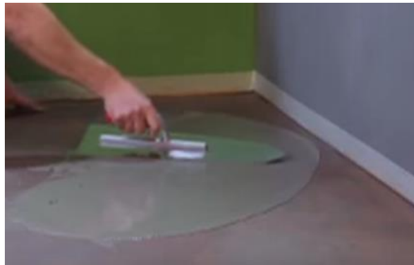
Figura 4.18 – Nivelamento e alisamento da superfície [43].
