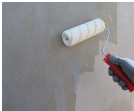
Figura 4.13 - Aplicação de primário [36].
