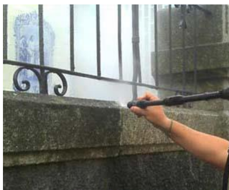
Figura 4.15 - Aplicação de jato de água [38].
