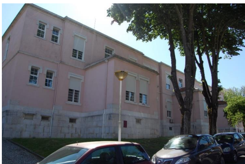
Figura 2.9 - Fachada poente orientada segundo Sudoeste [JC, NQ].
