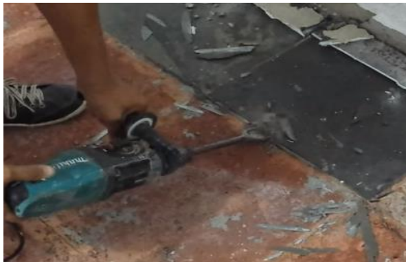
Figura 4.16 – Remoção do pavimento [42].
