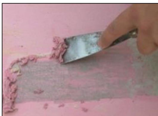
Figura 4.36 - Remoção da tinta com decapante [58].
