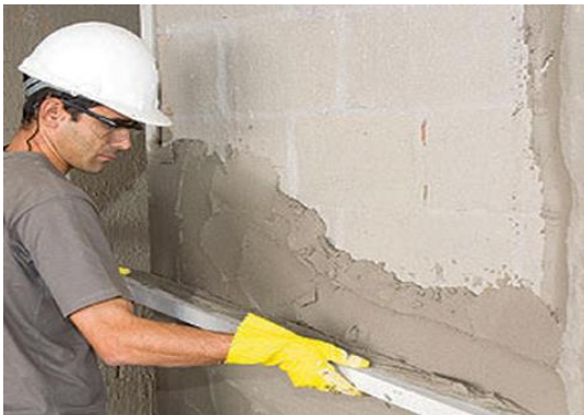
Figura 4.11 - Regularização do reboco [35].
