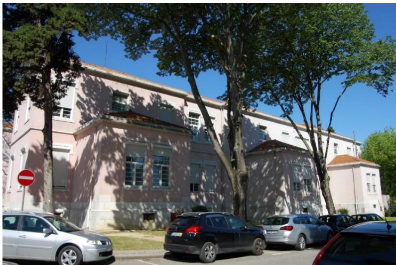
Figura 2.7 - Fachada nascente orientada segundo Nordeste [JC, NQ].
