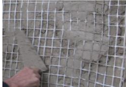
Figura 4.9 - Aplicação da rede em fibra de vidro [33].
