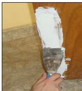
Figura 4.37 - Aplicação de massa para madeira [59].
