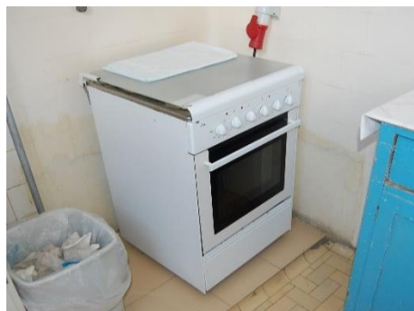
Figura 3.51 - Destacamento dos azulejos na Copa do piso 1 [JC, NQ].
