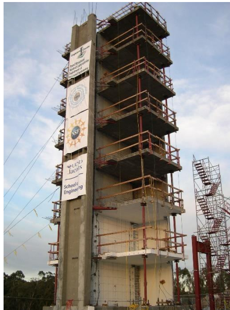
Figura 2.3 - Subestrutura, com paredes resistentes de betão armado, de um edifício de 7 andares ensaiado na plataforma sísmica exterior da UCSD. Adaptado de (Moaveni et al., 2011).
