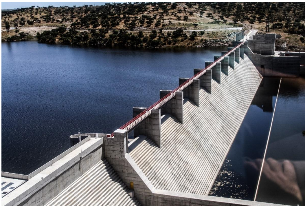
Figura 2.18 Barragem de Pedrógão (Barragem gravidade em BCC).
