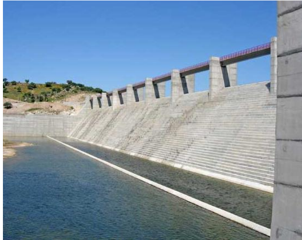
Figura 2.1 Barragem de Pedrógão (Barragem gravidade), situada no distrito de Beja, que tem como principais finalidades a produção de energia elétrica e a rega.
