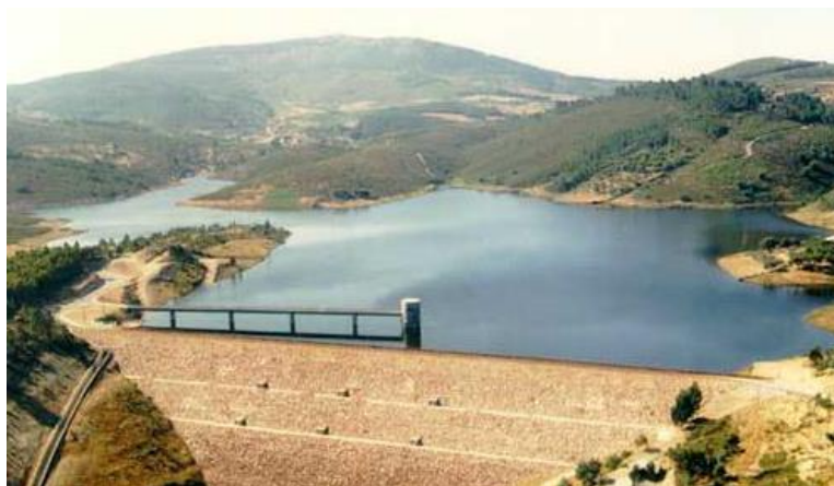
Figura 2.3 Barragem da Apartadura no distrito de Portalegre (barragem de enrocamento).
