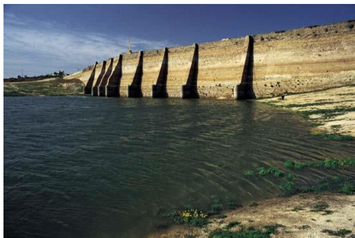
Figura 2.9 Barragem de Proserpina , em Espanha (vista do paramento de montante).
