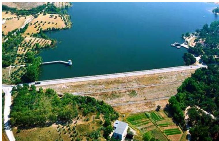
Figura 2.2 Barragem de Montargil, situada no distrito de Portalegre (barragem em aterro de terra).
