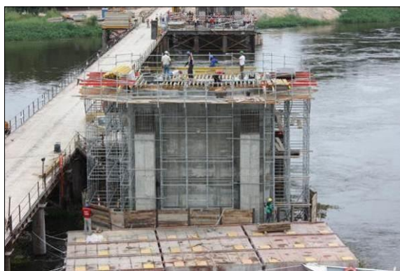
FIGURA 132 - MONTAGEM DA COFRAGEM DE FUNDO
