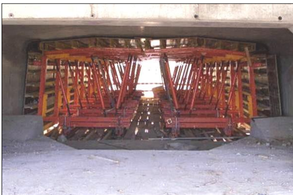
FIGURA 117 – MÓDULOS DESLIZANTES DA COFRAGEM INFERIOR
