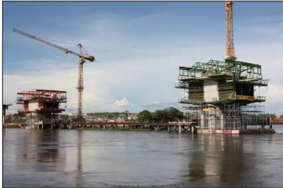
FIGURA 144 - INCREMENTO ESTRUTURAL DA PONTE
