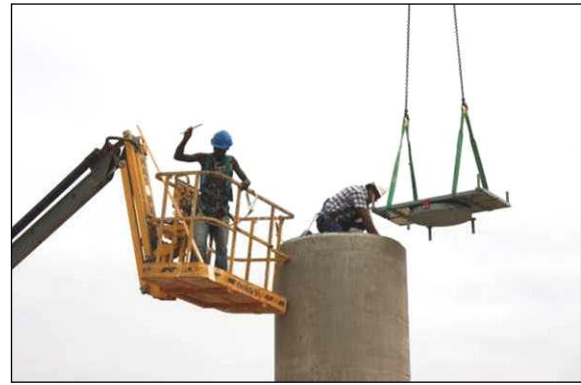
FIGURA 158 - MONTAGEM DE APARELHO DE APOIO EM PILAR DO VIADUTO
