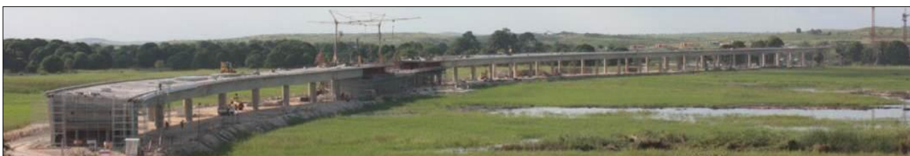
FIGURA 125 - EXECUÇÃO DO FECHO DO VIADUTO SUL, LOCALIZADO NO TRAMO P34/P35, ENTRE O 1/5 VÃO DOS TRAMOS ADJACENTES
