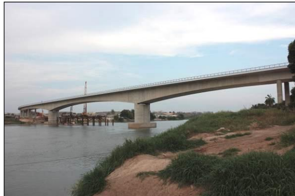
FIGURA 147 - INCREMENTO ESTRUTURAL DA PONTE
