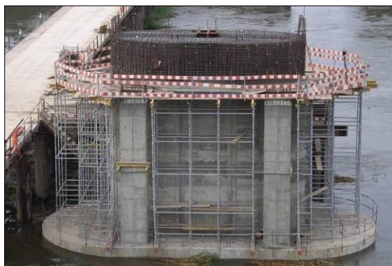
FIGURA 109 - ARMADURA DO CAPITEL CONCLUÍDA
