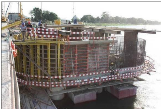
FIGURA 84 – MONTAGEM DA COFRAGEM DAS PAREDES. ARMADURAS
