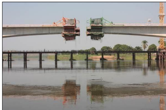
FIGURA 149 - VISTA SOBRE VÃO CENTRAL
