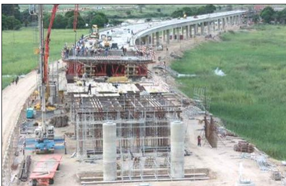
FIGURA 119 - VISTA SOBRE A FRENTE DE CIMBRA DESCONTÍNUO EM FASE DE BETONAGEM
