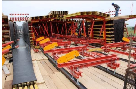
FIGURA 116 – MONTAGEM DOS MÓDULOS DE COFRAGEM DESLIZANTE
