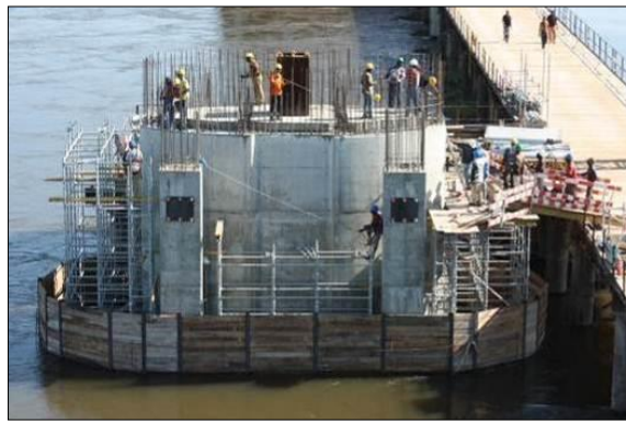
FIGURA 108 - PRÉ-LAJES COLOCADAS E NEGATIVO PARA ACEDER AO INTERIOR DO PILAR
