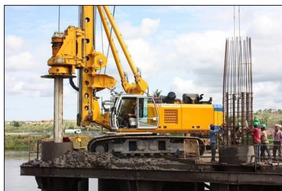
FIGURA 72 - FURAÇÃO E COLOCAÇÃO DE ARMADURA
