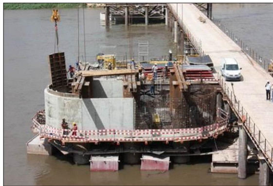
FIGURA 85 – DESCOFRAGEM DAS PAREDES DA ENSECADDEIRA
