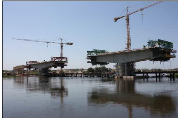
FIGURA 145 - INCREMENTO ESTRUTURAL DA PONTE
