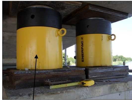
FIGURA 35 - MACACOS HIDRÁULICOS SOBRE CADA PILAR PROVISÓRIO NA FASE 2
