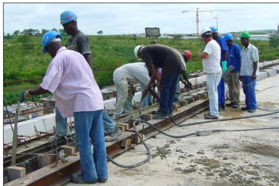
FIGURA 168 - BETONAGEM DE LANCIL
