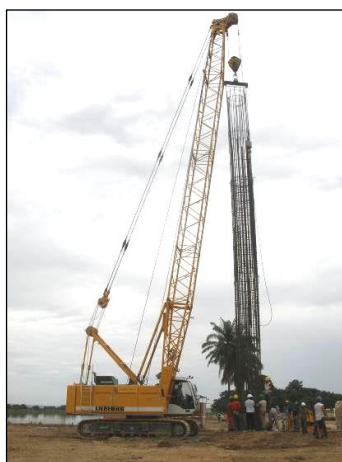
FIGURA 64 - COLOCAÇÃO DE ARMADURA
