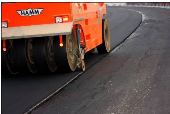
FIGURA 155 - EXECUÇÃO DE JUNTA A QUENTE
