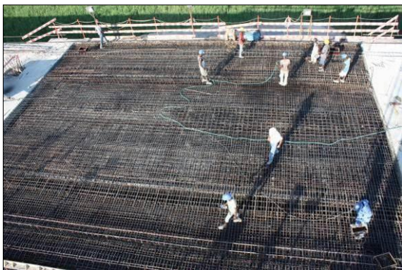
FIGURA 123 – BETONAGEM DO TRAMO DE FECHO DO VIADUTO
