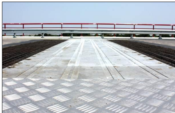
FIGURA 162 – JUNTA DE DILATAÇÃO DO PILAR P20
