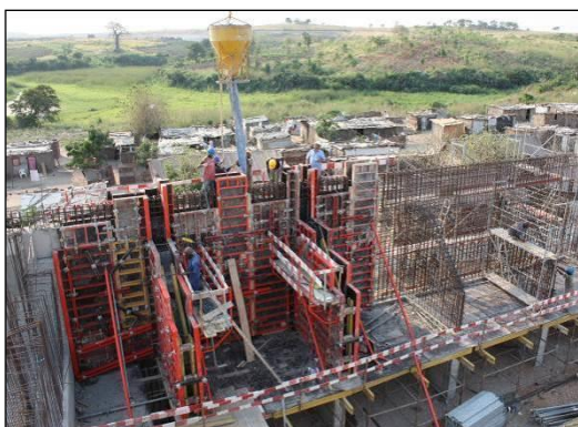
FIGURA 100 - BETONAGEM DE PAREDES DO E1 COM BALDE
