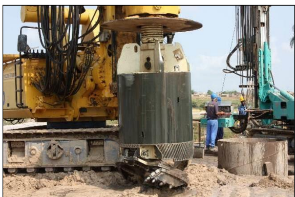
FIGURA 62 - EQUIPAMENTO DE FURAÇÃO E TUBO GUIA
