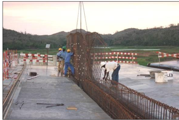
FIGURA 122 - COLOCAÇÃO DA ARMADURA DAS VIGAS DO VIADUTO COM APOIO DE GRUA AUTOMONTANTE
