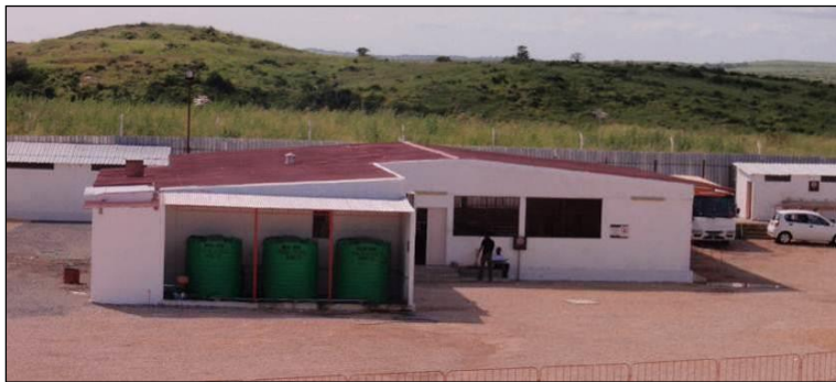
FIGURA 190 - REFEITÓRIO, SANITÁRIOS E BALNEÁRIOS
