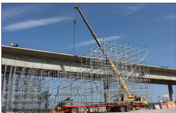
FIGURA 126 - TRANSPORTE DE UM MÓDULO DE CIMBRE TIPO CUPLOCK , EVITANDO DESMONTAGENS DESNECESSÁRIAS E MOROSAS.
