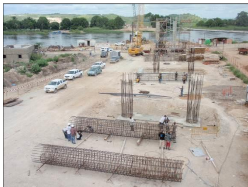
FIGURA 111 - PRÉ-FABRICAÇÃO DE ARMADURAS DOS PILARES
