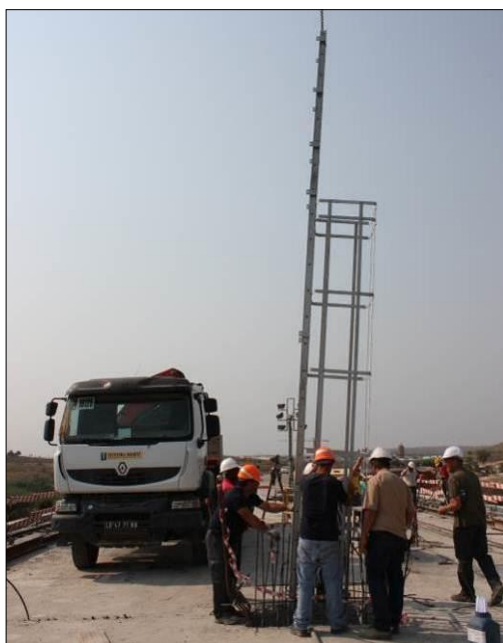
FIGURA 165 - MONTAGEM DA ESCADA DE ACESSO
