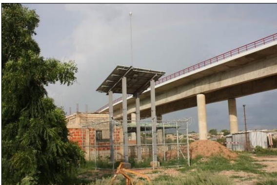
FIGURA 184 - ESTAÇÃO METEOROLÓGICA E PAINÉIS SOLARES
