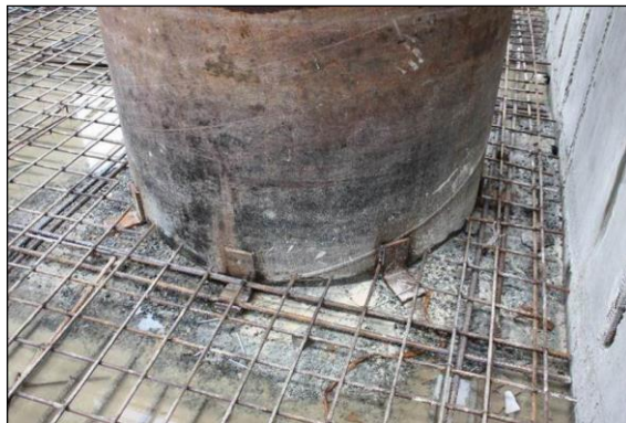
FIGURA 91 - ARMADURA DA LAJE DE FUNDO E LPN150 SOLDADOS
