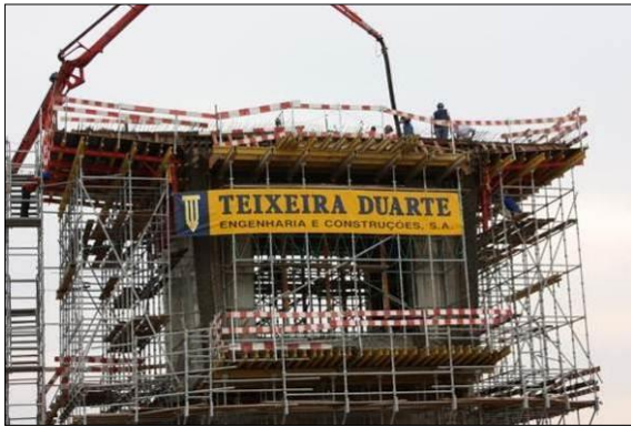
FIGURA 136 - BETONAGEM DA LAJE SUPERIOR
