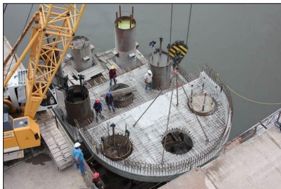
FIGURA 80 - COLOCAÇÃO DAS LAJES PRÉ-FABRICADAS
