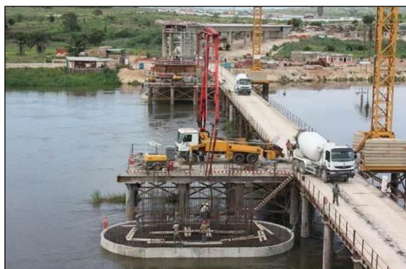
FIGURA 95 - BETONAGEM DO MACIÇO DE ENCABEÇAMENTO
