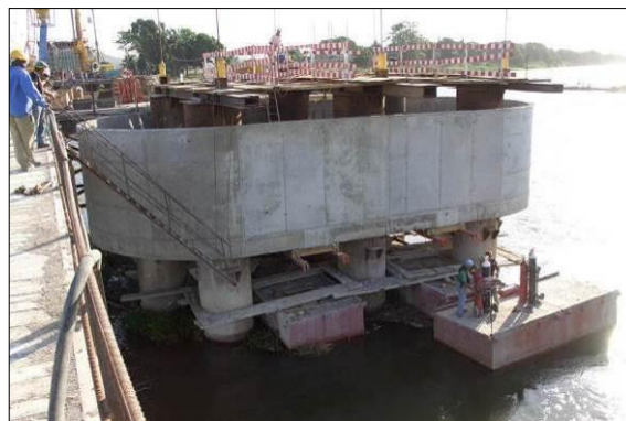
FIGURA 86 - PAREDES DA ENSECADDEIRA EXECUTADAS
