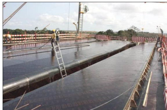
FIGURA 118 – ASPETO DA COFRAGEM CONCLUÍDA
