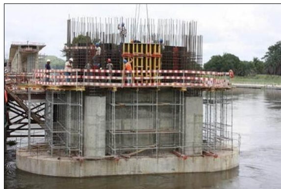
FIGURA 106 - COFRAGEM DA 3ª ELEVAÇÃO
