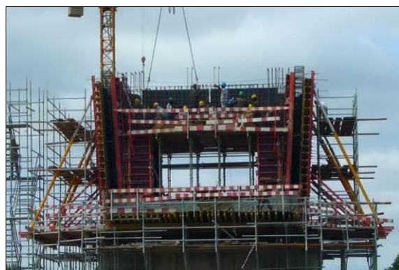
FIGURA 134 - COFRAGEM DAS PAREDES E SEPTOS
