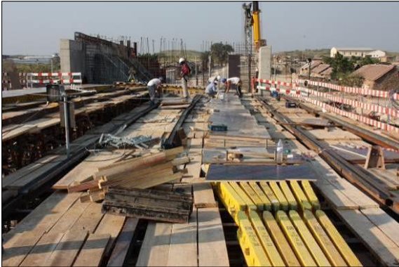
FIGURA 115 - COFRAGEM DOS FUNDOS DE VIGA
