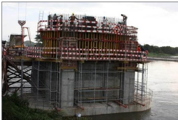
FIGURA 107 - 3ª ELEVÇÃO CONCLUÍDA
