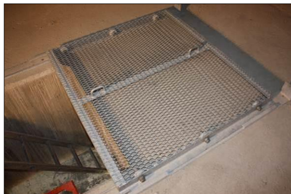
FIGURA 164 – ALÇAPÃO DE ACESSO AO INTERIOR DOS PILARES DA PONTE
