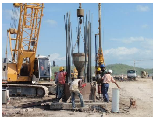
FIGURA 63 - BETONAGEM DE ESTACA
