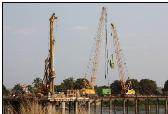
FIGURA 70 – VISTA GERAL SOBRE A FRENTE DO PILAR P8
