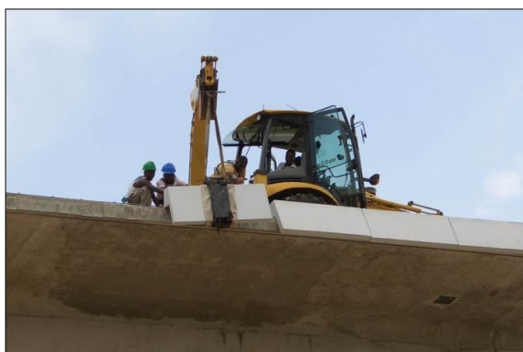
FIGURA 167- COLOCAÇÃO DAS VIGAS DE BORDADURA
