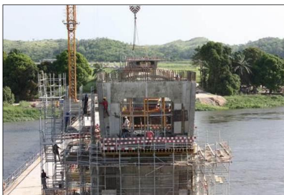
FIGURA 135 – DESCOFRAGEM DAS PAREDES CONCLUÍDA
