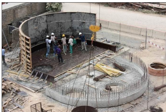
FIGURA 79 - EXECUÇÃO DAS PRÉ-LAJES EM ESTALEIRO
