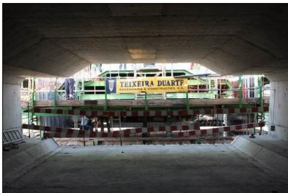
FIGURA 148 - VISTA INTERIOR DA VIGA-CAIXÃO SOBRE A CONSOLA OPOSTA
