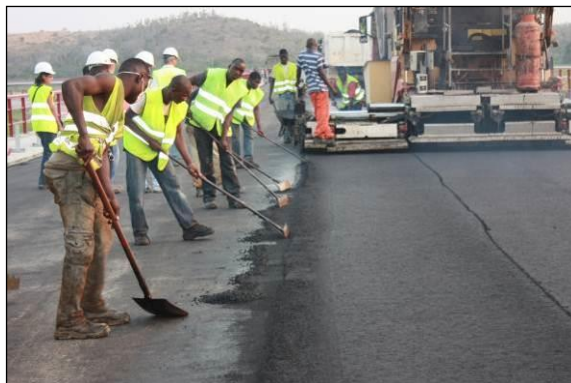
FIGURA 154 - ESPALHAMENTO DA CAMADA DE DESGASTE
