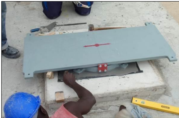
FIGURA 159 - SELAGEM DE APARELHO DE APOIO ENCONTRO E1 COM ARGAMASSA DE RETRAÇÃO COMPENSADA
