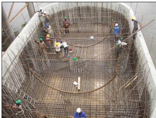
FIGURA 93 - MONTAGEM DE ARMADURA E SELAS DE APOIO AO SISTEMA DE EQUILÍBRIO
