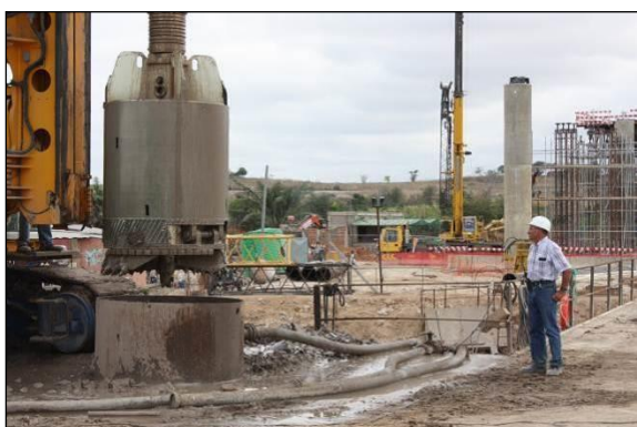
FIGURA 71 – FURAÇÃO NO INTERIOR DOS TUBOS
