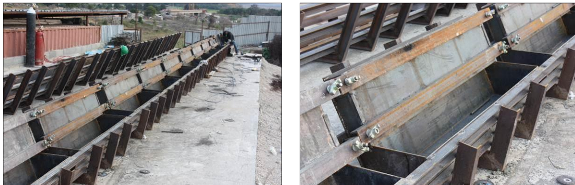
FIGURA 166 - MOLDES DE FABRICO EM SÉRIE DE VIGAS DE BORDADURA
