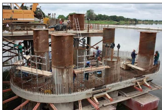
FIGURA 82 - EXECUÇÃO DAS VIGAS DE SOLIDARIZAÇÃO DAS PRÉ-LAJES E PROLONGAMENTO DOS TUBOS DAS ESTACAS
