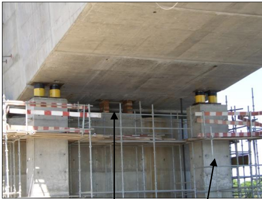
FIGURA 34 - PILARES PROVISÓRIOS DE APOIO AO SISTEMA DE EQUILÍBRIO NA FASE 2
