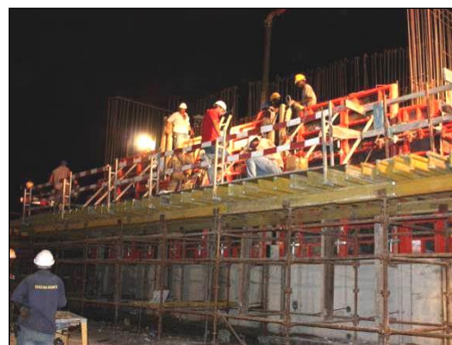
FIGURA 101 - BETONAGEM DE VIGA ESTRIBO DO E1 COM BOMBA
