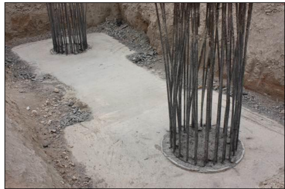
FIGURA 75 - ESTACAS SANEADAS E BETÃO DE LIMPEZA
