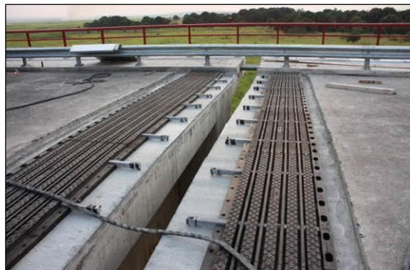
FIGURA 161 – MONTAGEM DA JUNTA DE DILATAÇÃO DO PILAR DE JUNTA P20
