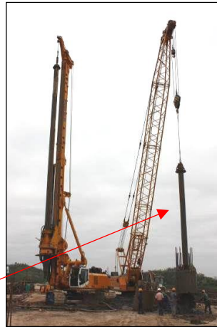
FIGURA 66 - FURAÇÃO COM RECURSO A PERLONGA NAS ESTACAS MAIS PROFUNDAS POR EXCEDER A CAPACIDADE MÁXIMA DE PERFURAÇÃO DO BATE ESTACAS
