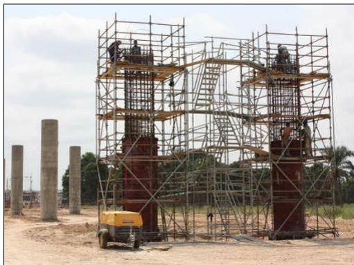
FIGURA 113 - BETONAGEM DE PAREDES DO E1 COM BALDE
