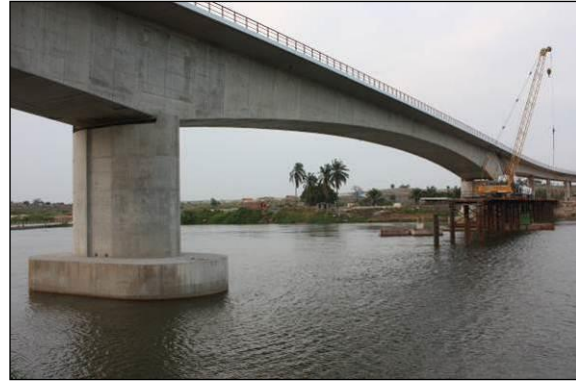
FIGURA 151 - VISTA GERAL E DESMONTAGEM DO JETTY
