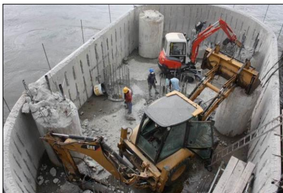
FIGURA 92 - SANEAMENTO DAS ESTACAS
