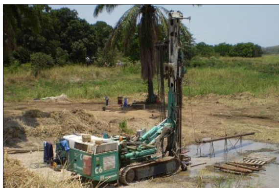
FIGURA 201 - CAMPANHA DE SONDAGENS
