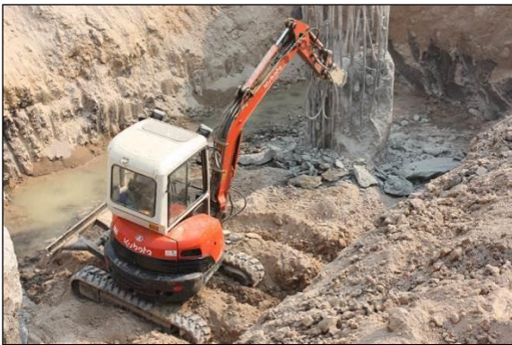
FIGURA 74 - SANEAMENTO DAS ESTACAS DO VIADUTO
