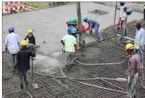
FIGURA 124 – BETONAGEM COM AUTOBOMBA
