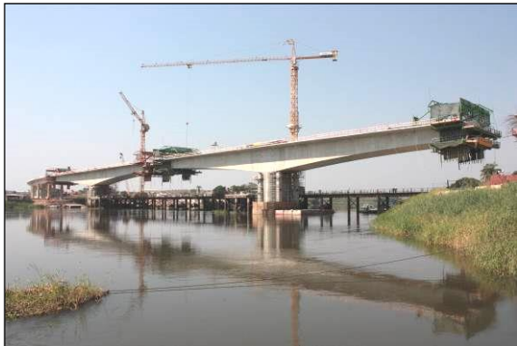
FIGURA 146 - INCREMENTO ESTRUTURAL DA PONTE
