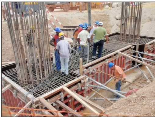
FIGURA 76 - BETONAGEM DE LINTEL COM RECURSO A AUTOBOMBA
