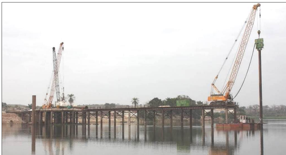
FIGURA 59 - FOTOGRAFIA GERAL DE EXECUÇÃO DO JETTY
