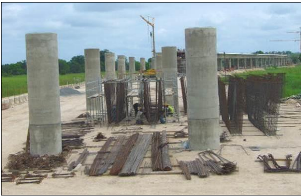
FIGURA 121 - PRÉ-FABRICAÇÃO DA ARMADURA DAS VIGAS
