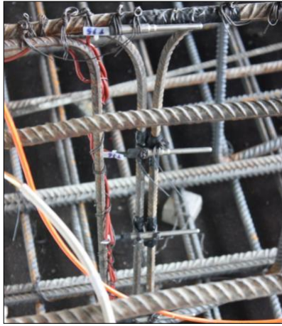
FIGURA 180 - TERMÓMETROS NO INTERIOR DO BETÃO
