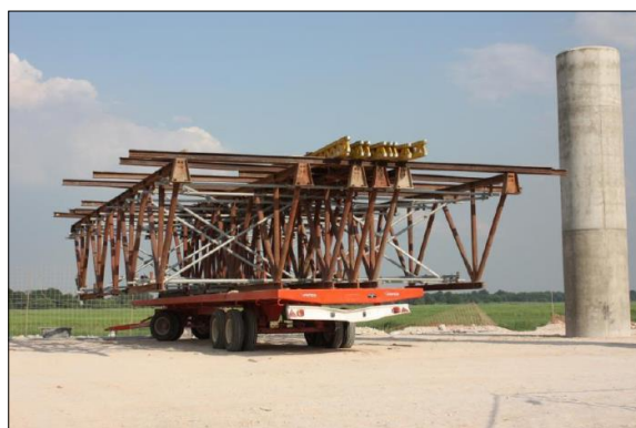
FIGURA 127 - TRANSPORTE DE UM MÓDULO DE ASNAS PARA INÍCIO, EVITANDO DESMONTAGENS DESNECESSÁRIAS E MOROSAS
