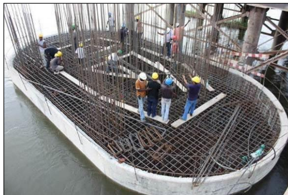
FIGURA 94 - MONTAGEM DA ARMADURA DE CONTINUIDADE DOS PILARES
