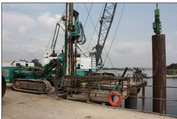
FIGURA 67 – VIBRO CRAVAÇÃO DO ENCAMISAMENTO PERDIDO DAS ESTACAS DOS PILARES DO RIO E EXECUÇÃO DE SONDAGENS
