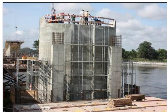
FIGURA 110 - PILAR CONCLUÍDO E 1ª FASE DOS PILARES PROVISÓRIOS CONCLUÍDOS
