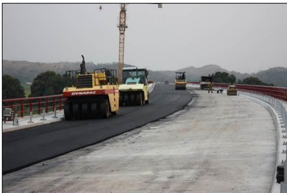
FIGURA 153 – COMPACTAÇÃO DA CAMADA DE DESGASTE
