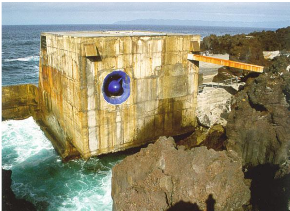
Figura 2.4 – Protótipo de aproveitamento da energia das ondas tipo CAO, Pico – Açores [11]
