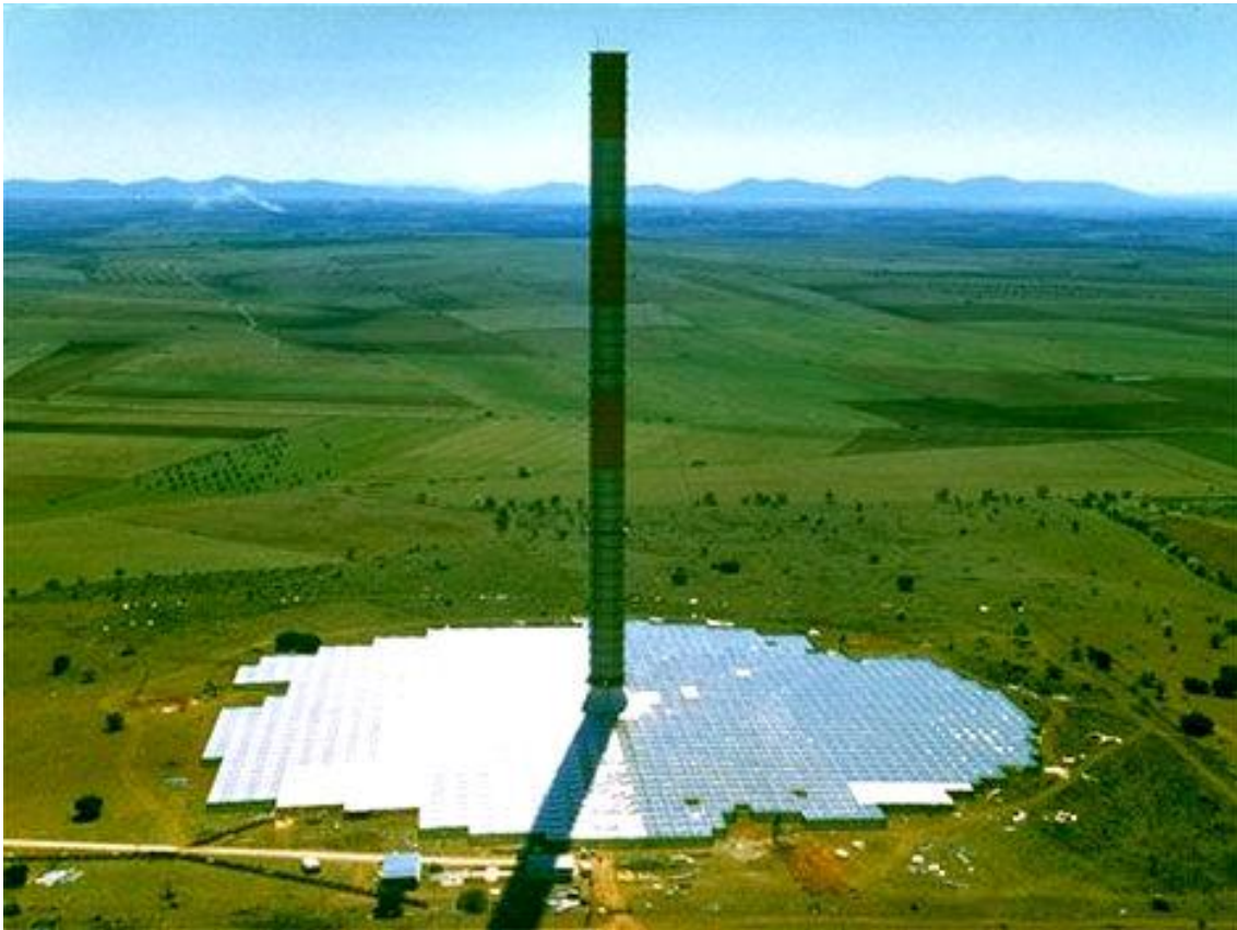
Figura 2.2 – Torre solar de convecção piloto de pequena escala (50 kW), Manzanares - Espanha. [6]
