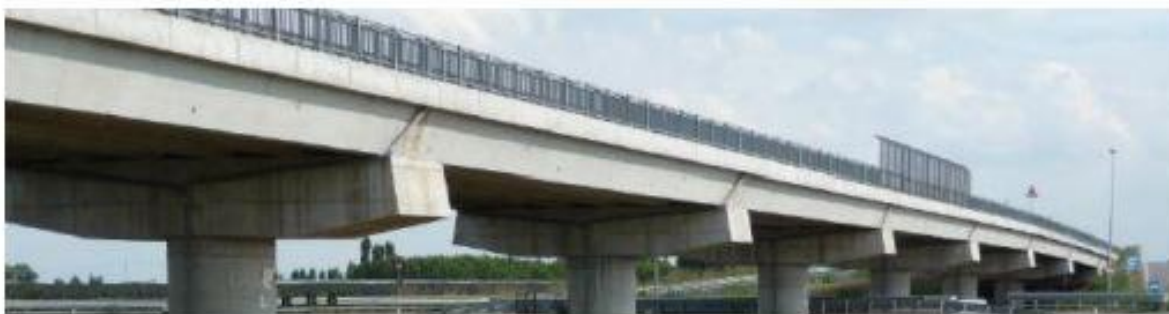
Figura 6 - Ponte em Isola della Scala, Itália [59]
