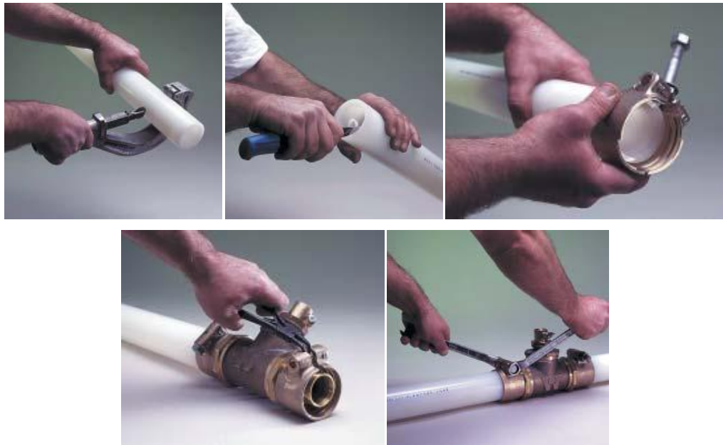
Fig. 43 – Montagem de PE-X utilizando abraçadeiras metálicas [45]
