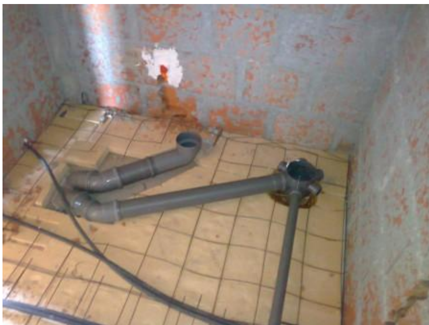
Fig. 66 - Instalação de tubos de PVC-U
