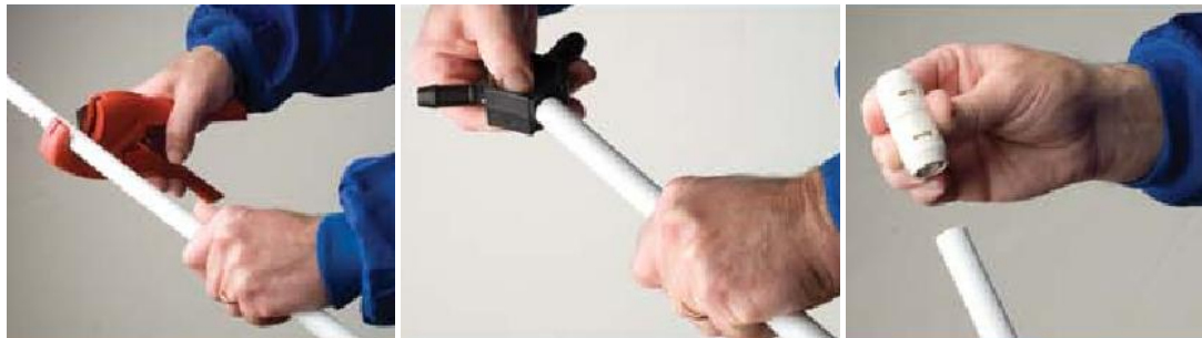
Fig. 44 – Montagem de PE-X utilizando acessórios de conexão rápida [46]
