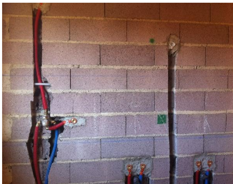
Fig. 38 – Instalação de tubos PE-X
