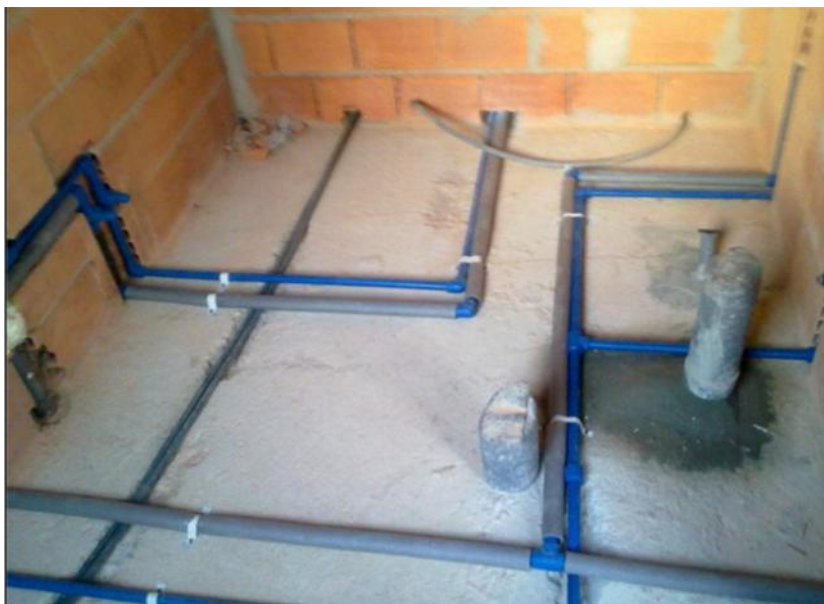
Fig. 46 - Instalação de tubos de polipropileno
