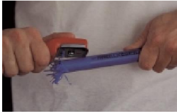
Fig. 55 – Raspagem do tubo de polipropileno com raspador [53]
