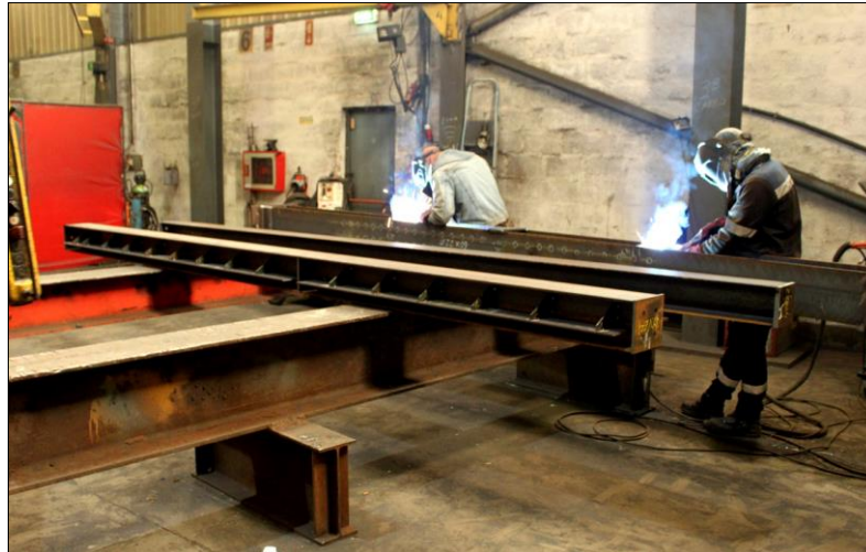
Figura 71 – Soldadura MAG/FF realizada nas Instalações da Metaloviana
