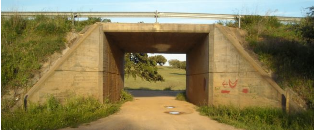
Figura 3 – Passagem Agrícola, Fonte: Edgar Cardoso Laboratório de Estruturas
