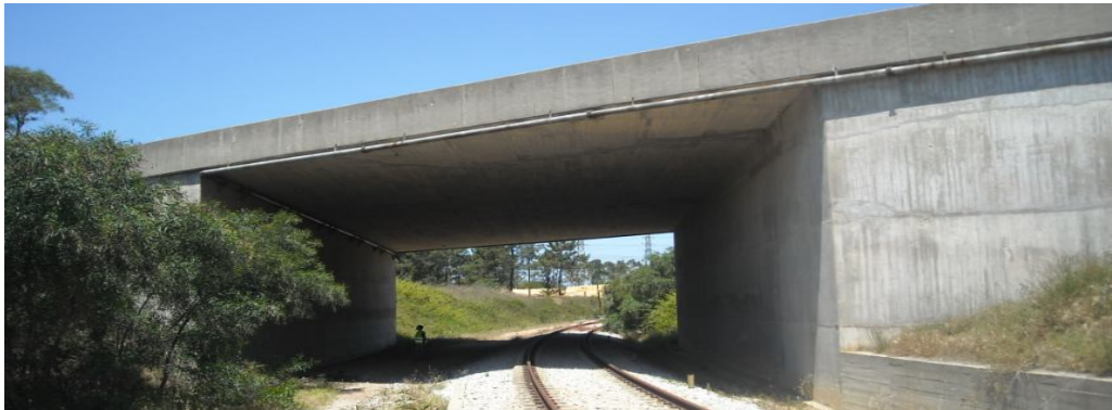
Figura 23- Foto da obra de arte, aquando do levantamento, Fonte: Edgar Cardoso Laboratório de Estruturas
