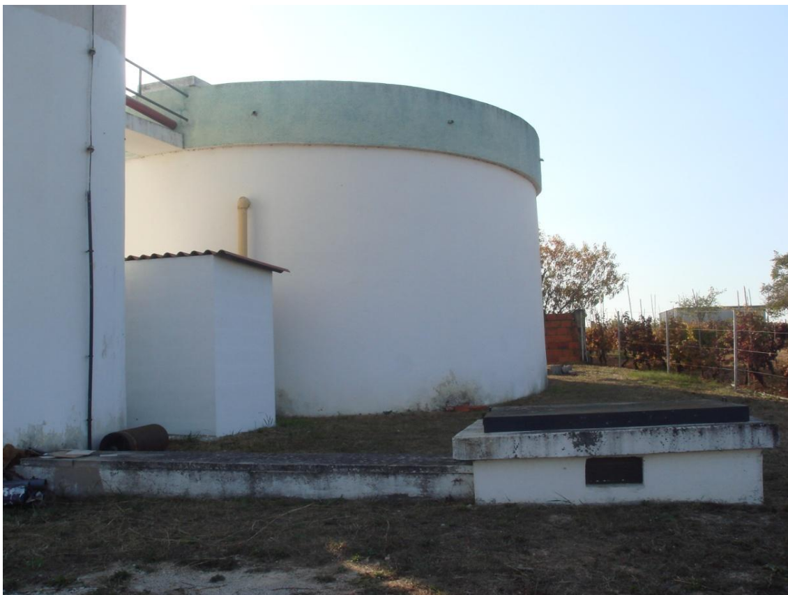
Figura A 3 - Reservatório do sistema de abastecimento de Albergaria – Arquivo da A.S.
