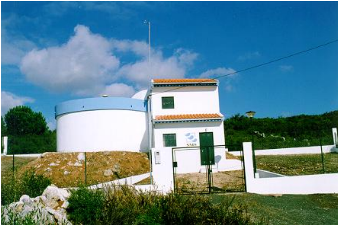
Figura A 4 - Reservatório do sistema de abastecimento de Alcanede – Arquivo da A.S.
