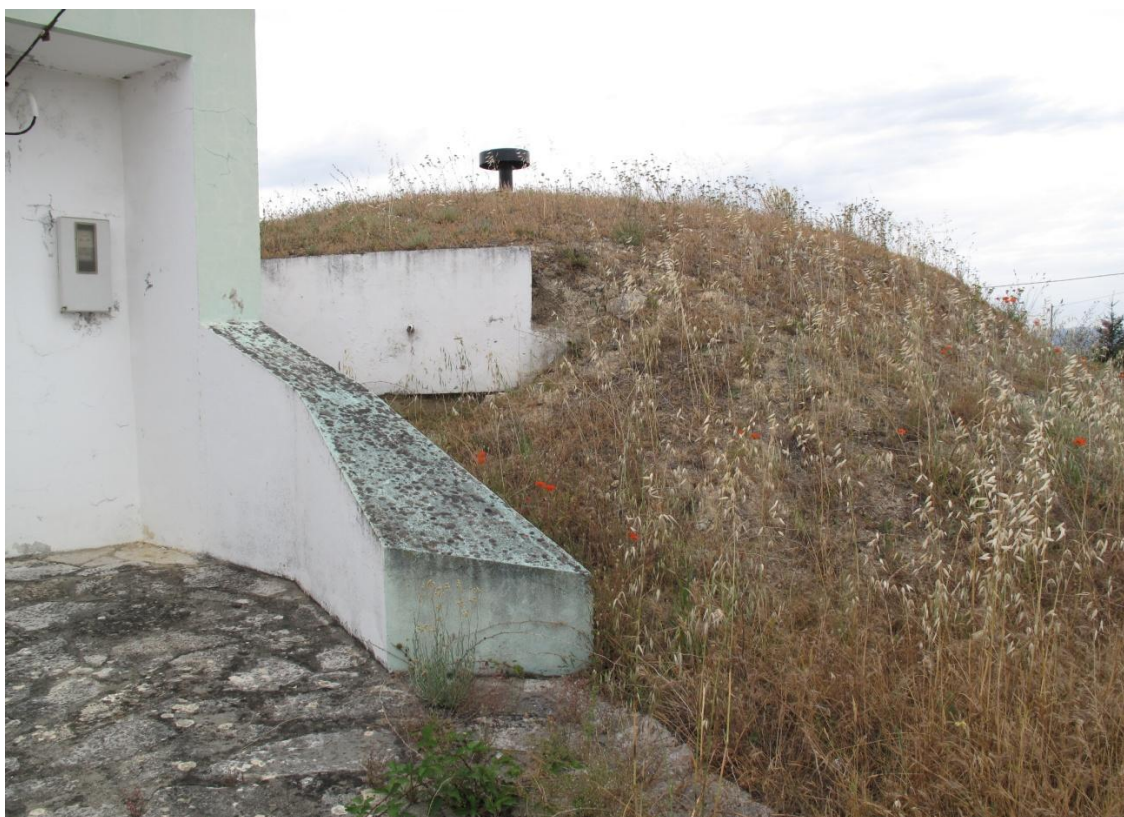
Figura A 21 - Reservatório enterrado da Marinheira – Arquivo da A.S.
