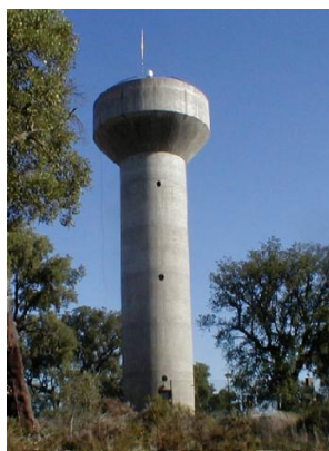
Figura A 9 - Reservatório elevado do sistema de abastecimento de Casével – Arquivo da A.S.
