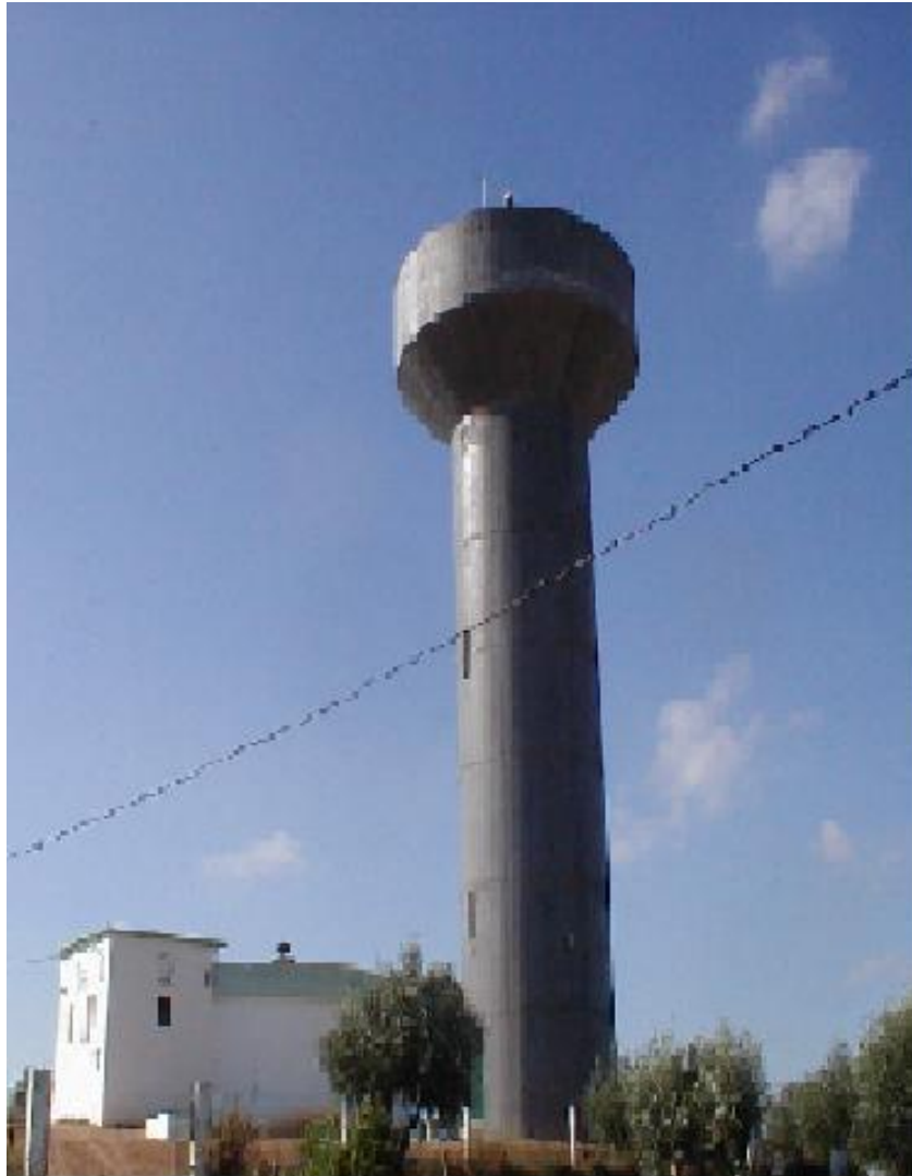
Figura A 16 - Reservatório elevado do sistema de abastecimento de Romeira – Arquivo da A.S.
