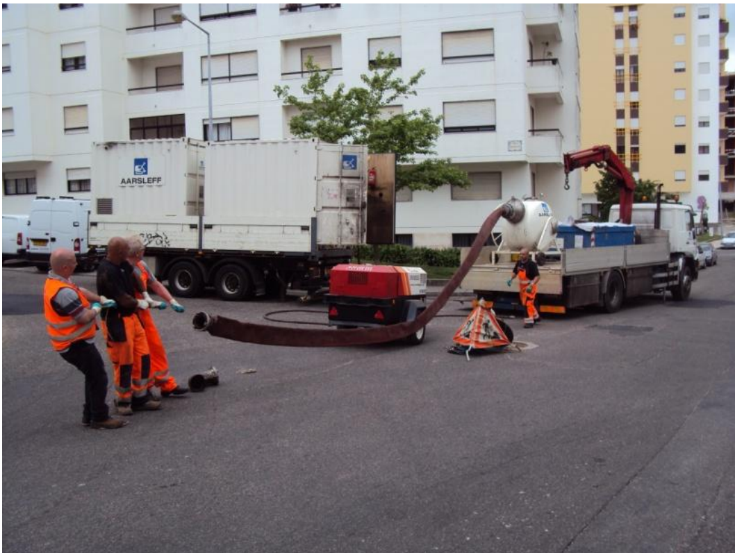
Figura E 6 - Equipa de trabalho a puxar o revestimento através da mangeira de inversão especial – Arquivo Pessoal
