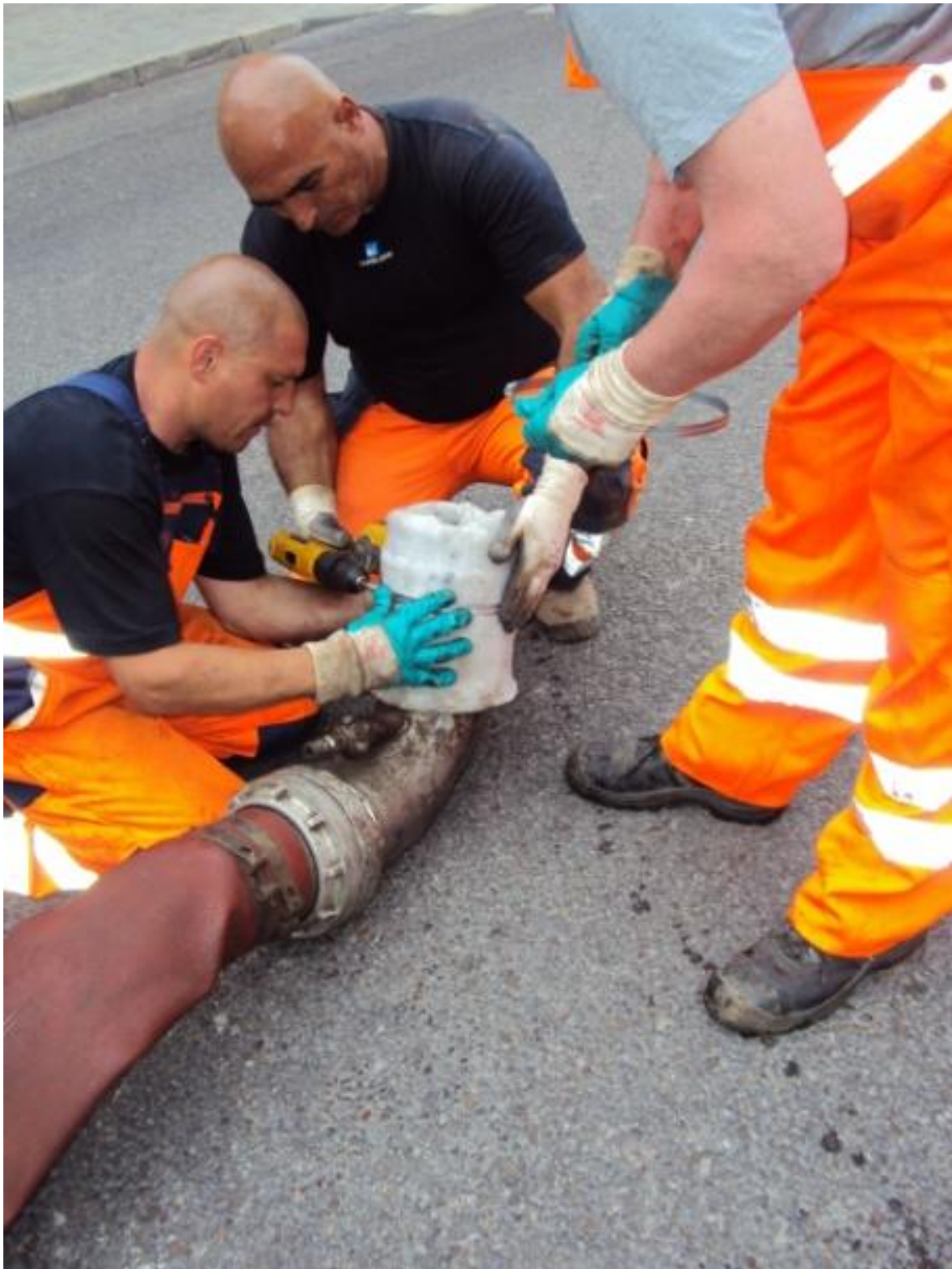
Figura E 7 - Fixação da ponta do revestimento na mangueira – Arquivo Pessoal
