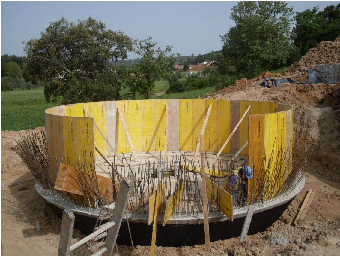
Figura C 3 - Execução de cofragem do decantador secundário – Arquivo Pessoal
