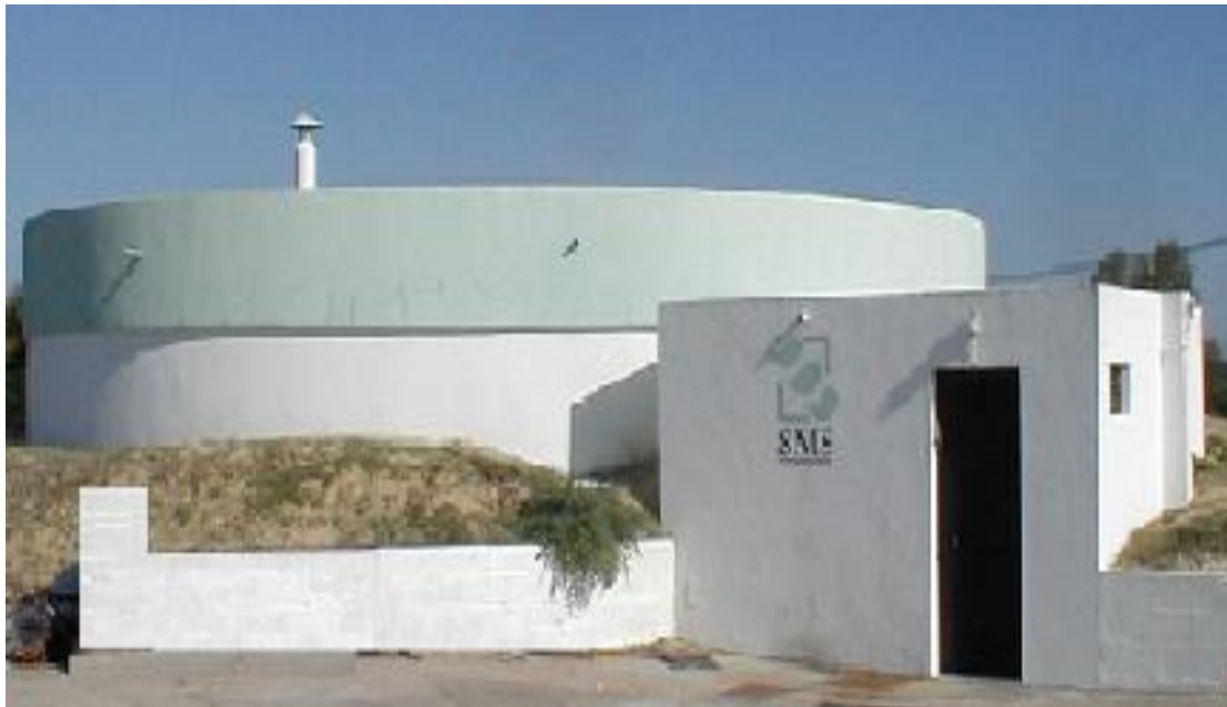
Figura A 10 - Reservatório do sistema de abastecimento de Casével – Arquivo da A.S.
