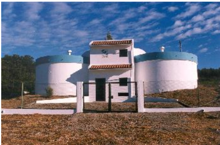
Figura A 7 - Reservatório do sistema de abastecimento de Amiais de Baixo – Arquivo da A.S.
