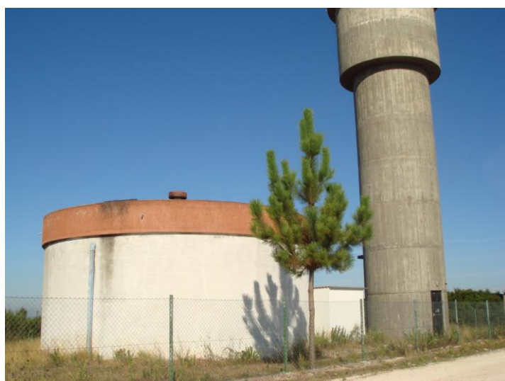
Figura A 1 – Reservatório apoiado e elevado do sistema de abastecimento de Abitureiras – Arquivo da A.S.
