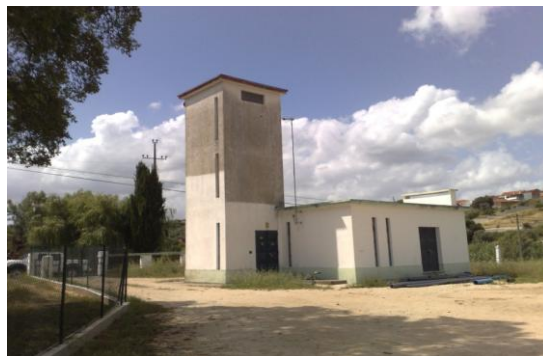
Figura A 8 - Estação elevatória do sistema de abastecimento de Arneiro das Milhariças – Arquivo da A.S.
