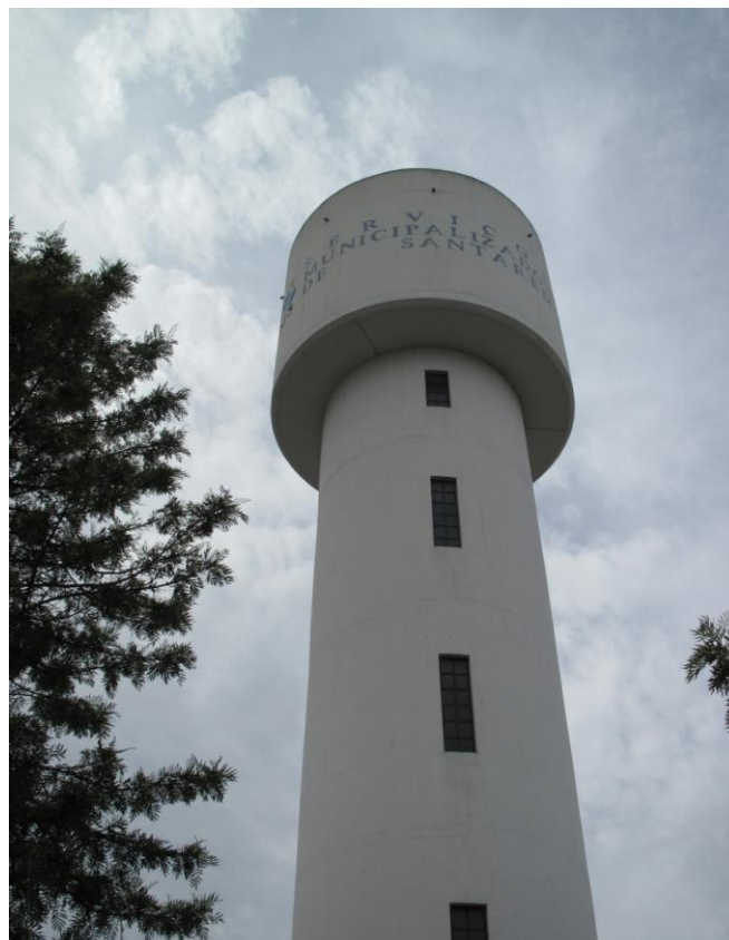
Figura A 14 - Reservatório elevado do sistema de abastecimento de Pombalinho – Arquivo da A.S.
