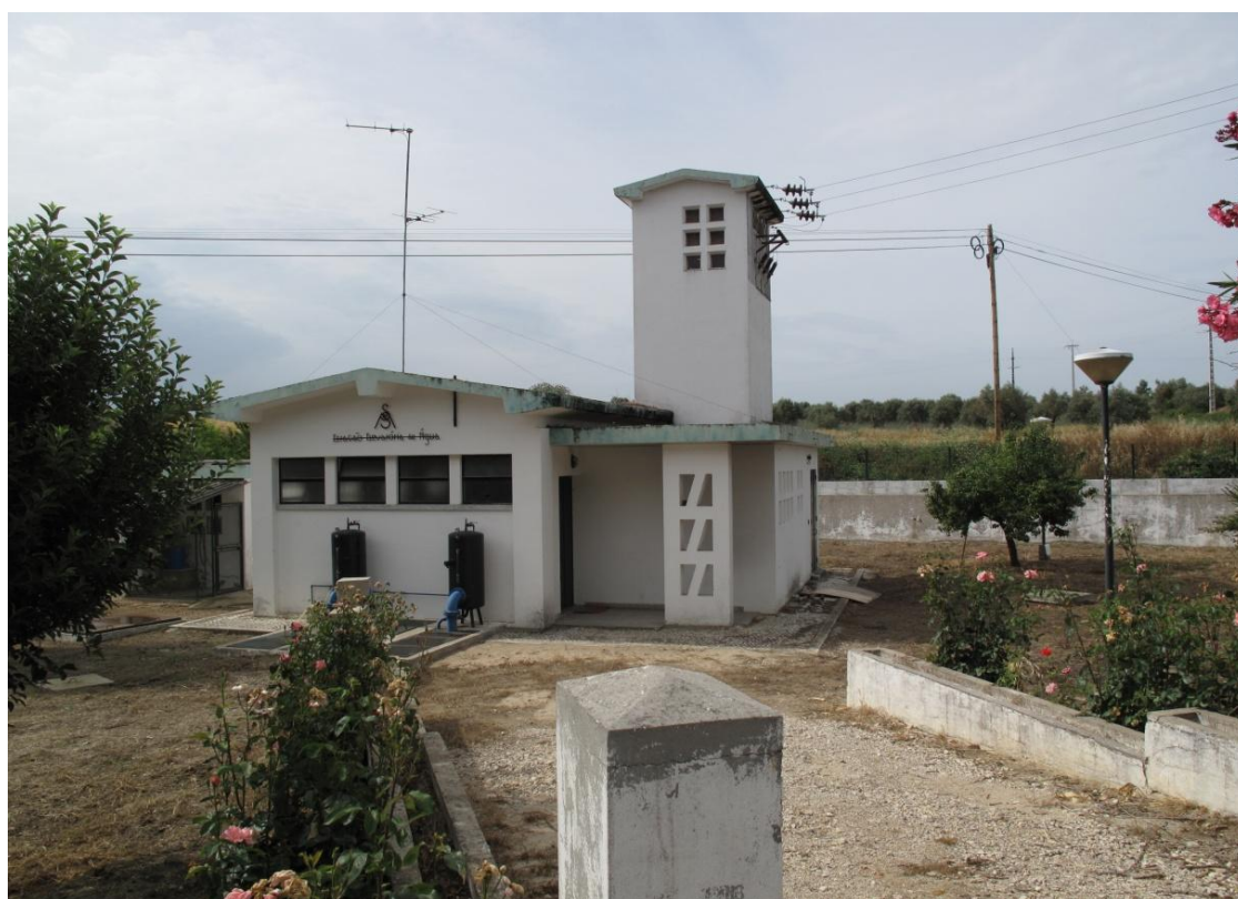
Figura A 5 - Estação elevatória do sistema de abastecimento de Alcanhões – Arquivo da A.S.
