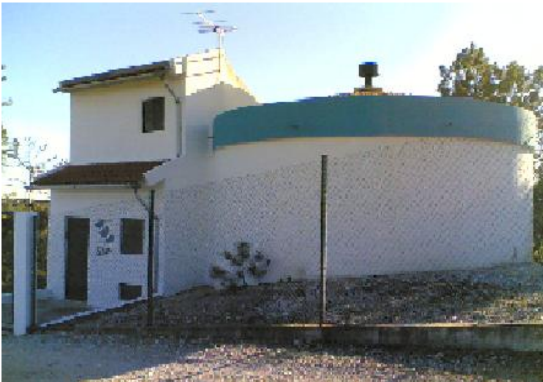
Figura A 2 - Reservatório do sistema de sbastecimento de Abrã – Arquivo da A.S.
