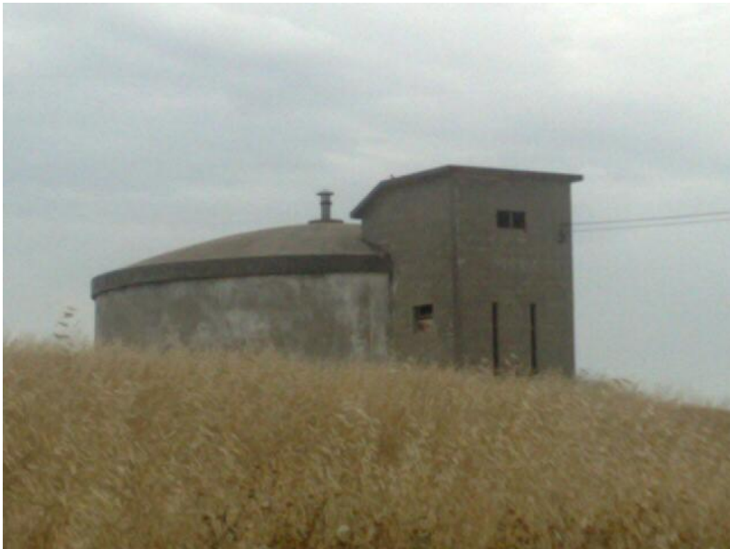
Figura A 22 - Reservatório do sistema de abastecimento de Várzea – Arquivo da A.S.
