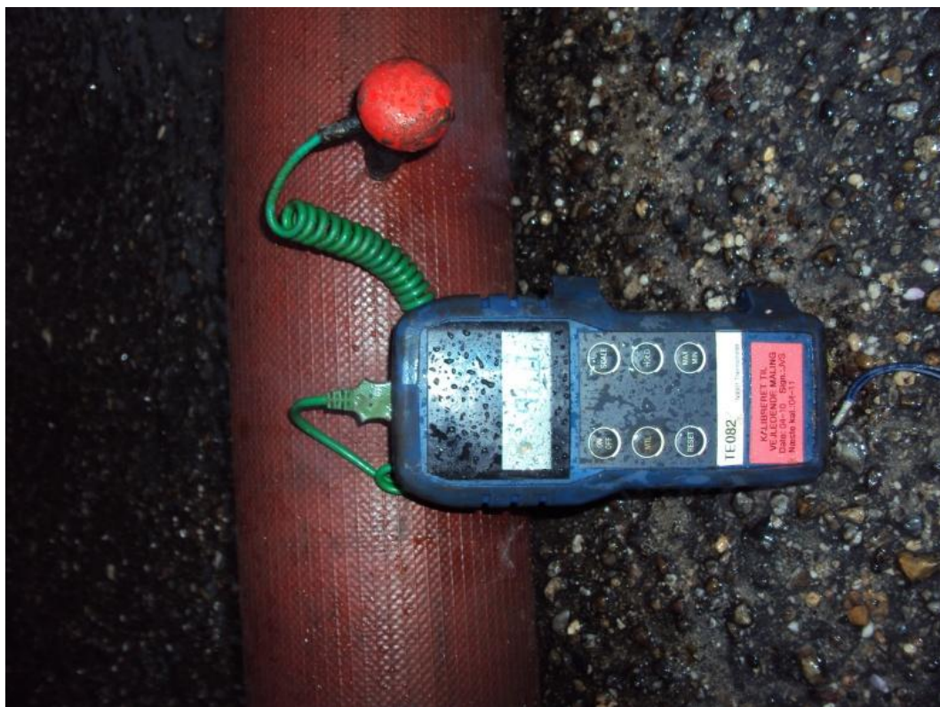
Figura E 12 - Mostrador electrónico da temperatura no interior do colector durante a fase de cura do revestimento – Arquivo Pessoal
