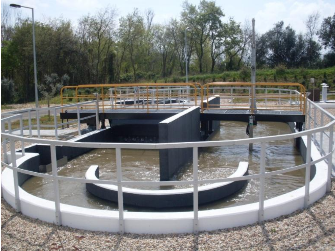
Figura 3.1 - Vala de oxidação – Arquivo Pessoal
