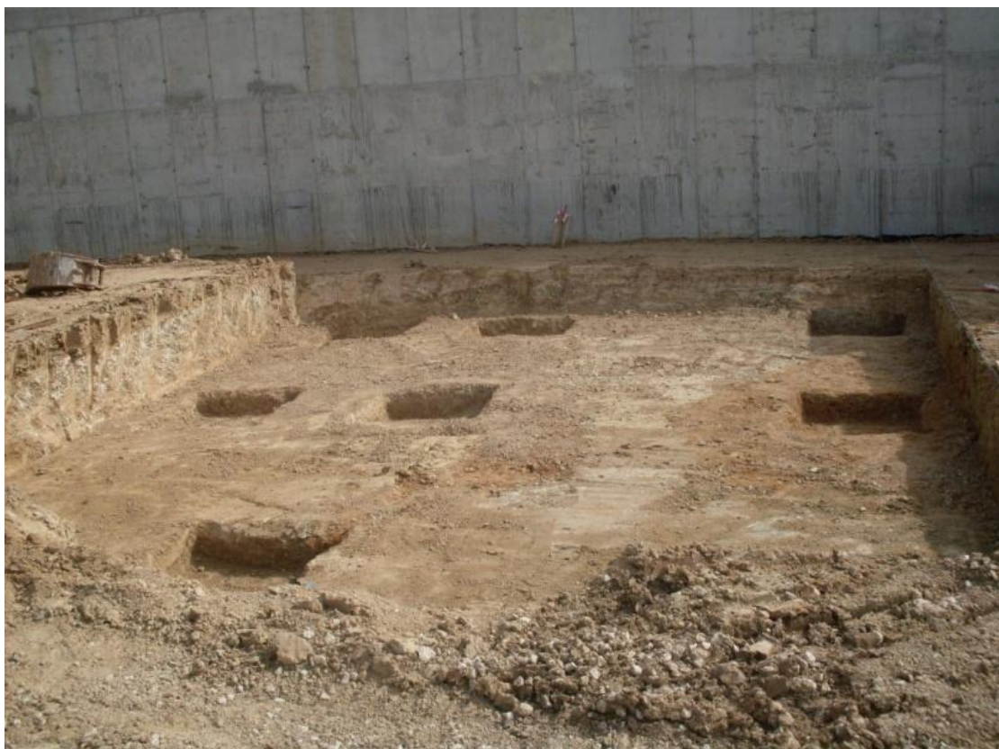
Figura 3.3 - Fundações do edifício de exploração – Arquivo Pessoal
