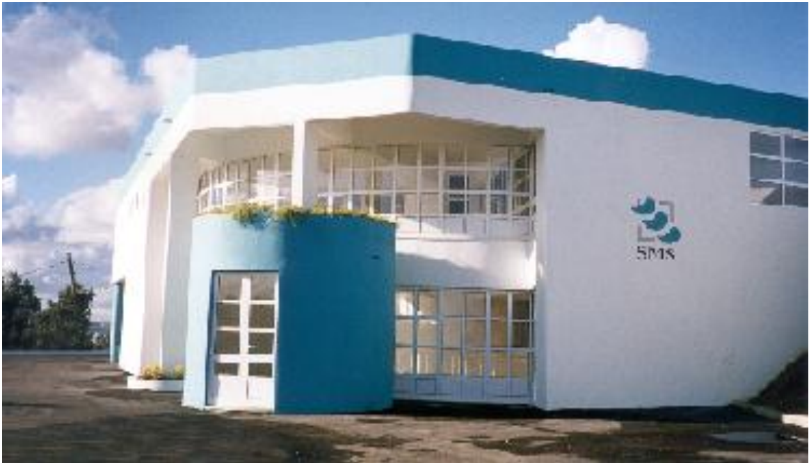
Figura A 18 - Reservatório e estação de telegestão de Santa Catarina (Santarém) – Arquivo da A.S.
