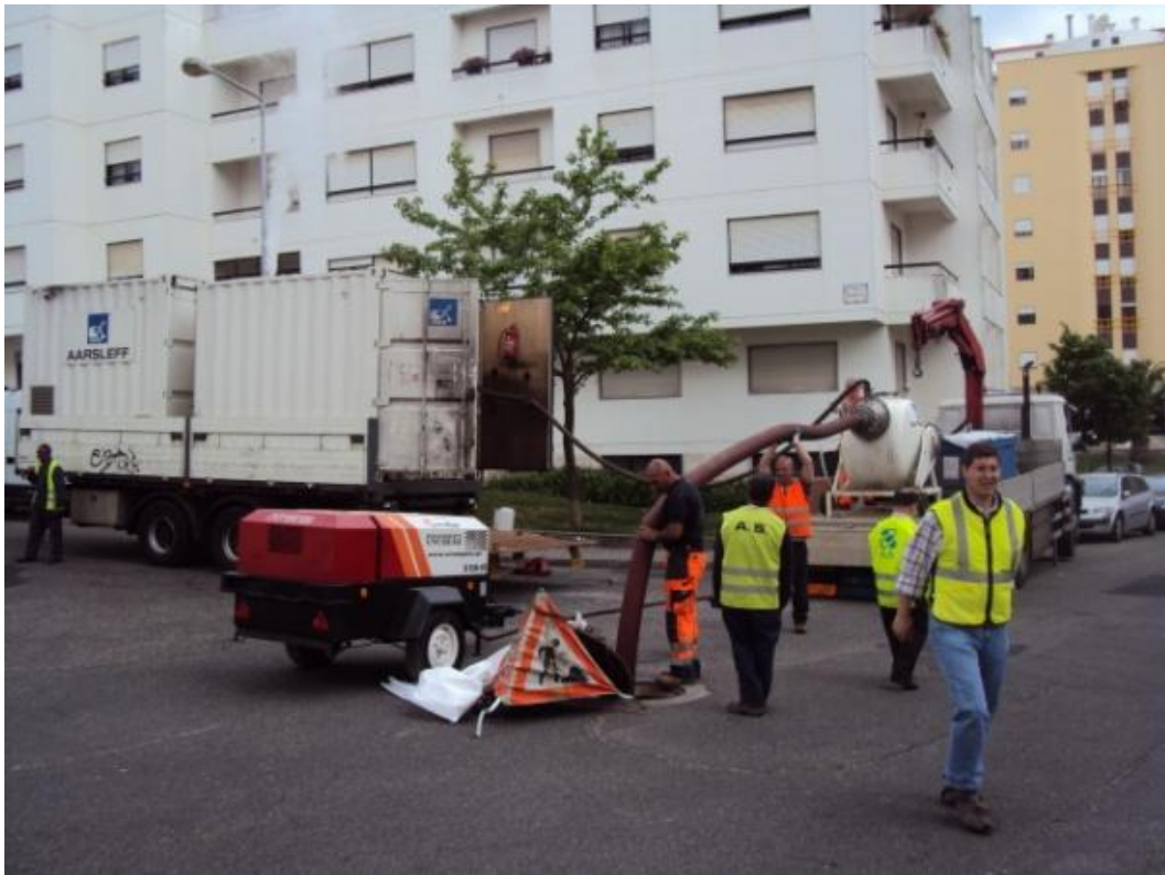
Figura E 8 - Colocação da mangueira de inversão especial – Arquivo Pessoal
