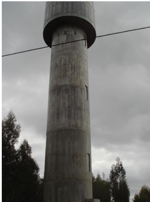
Figura A 6 - Reservatório elevado Mata 4 – Arquivo da A.S.
