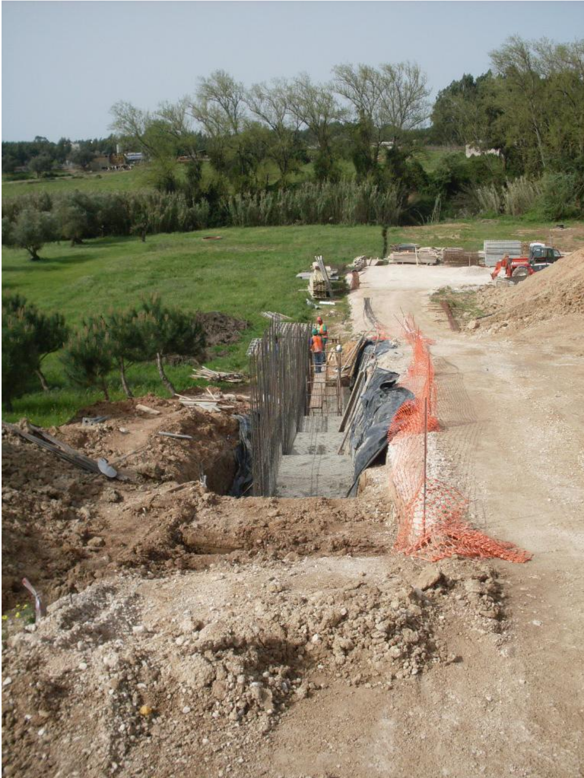
Figura C 2 - Armação de ferro para muro de suporte – Arquivo Pessoal
