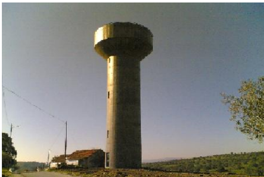
Figura A 11 - Reservatório elevado do sistema de abastecimento de Gançaria – Arquivo da A.S.
