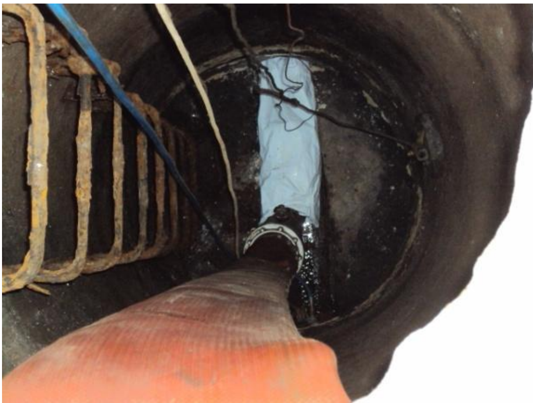
Figura E 9 - Mangueira de inversão especial inserida na manga guia – Arquivo Pessoal
