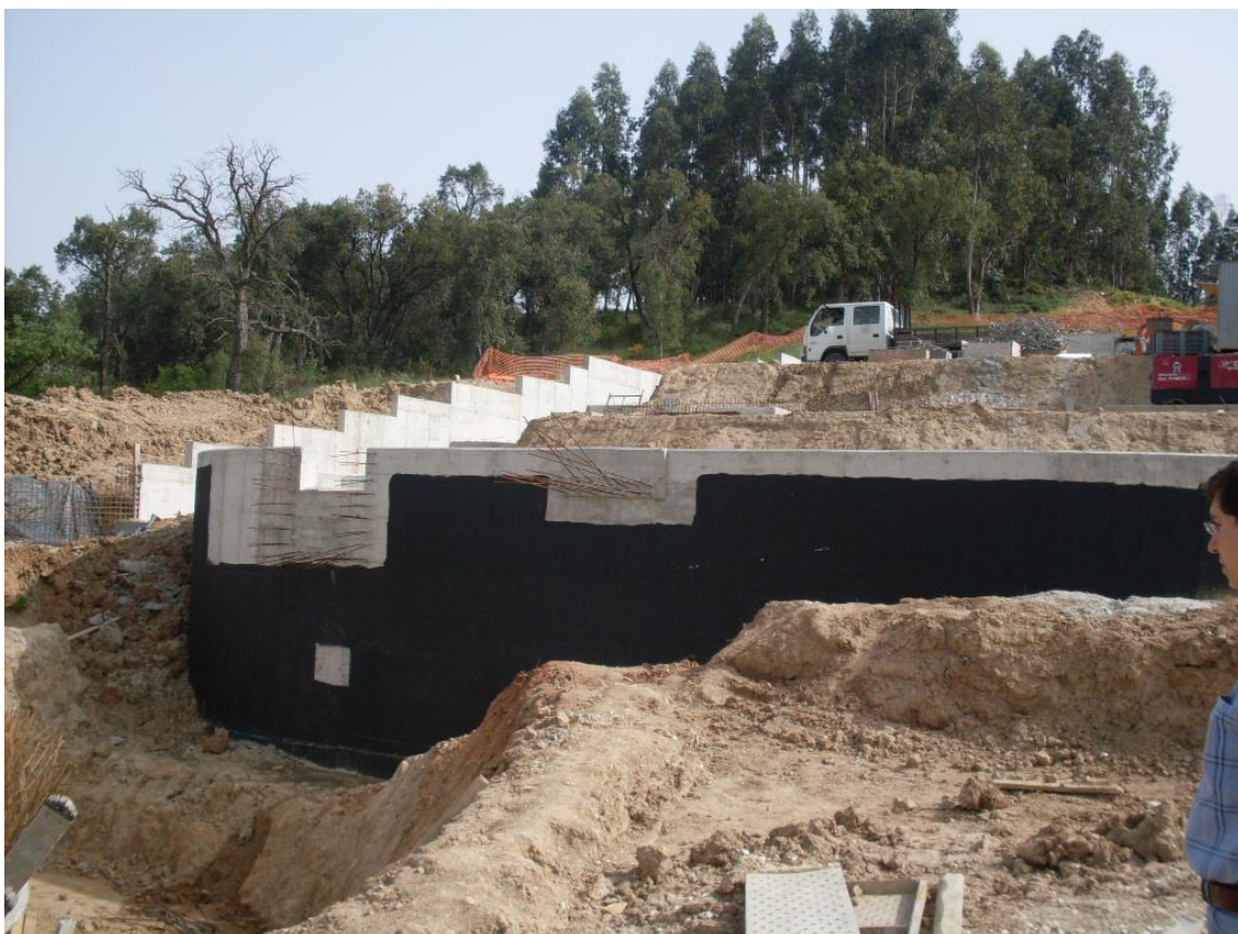
Figura C 4 - Vista da construção por patamares da ETAR de Alcanede – Arquivo Pessoal
