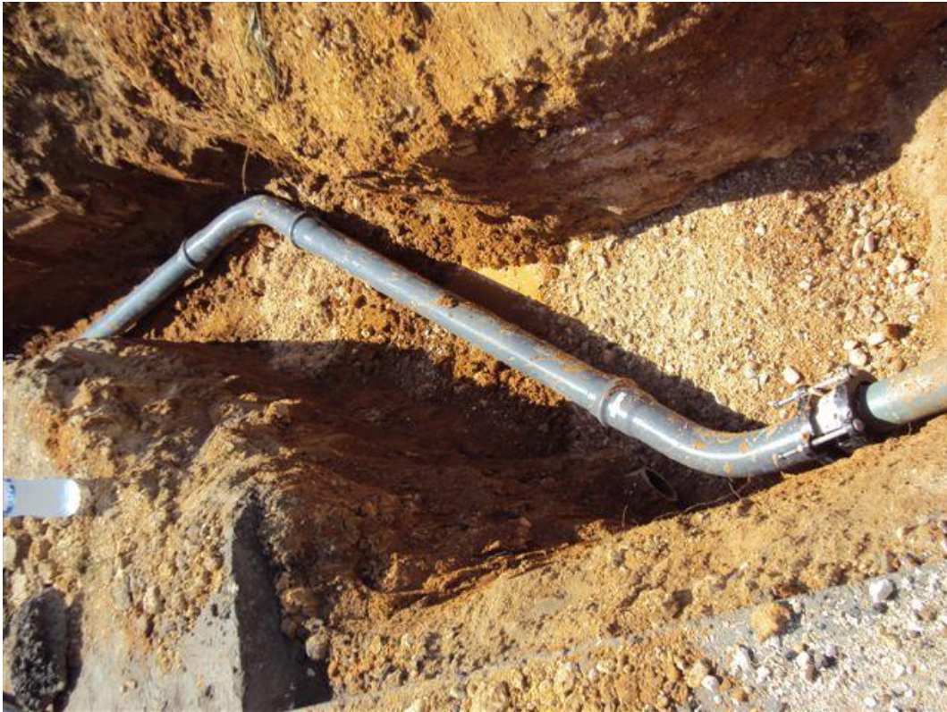
Figura D 1 – Vala aberta para instalação da VRP (Casais da Charneca) – Arquivo Pessoal
