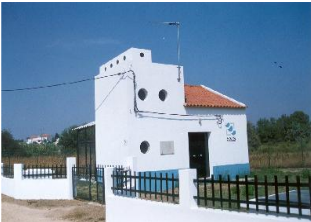
Figura A 20 - Reservatório do sistema de abastecimento de Tremês – Arquivo da A.S.
