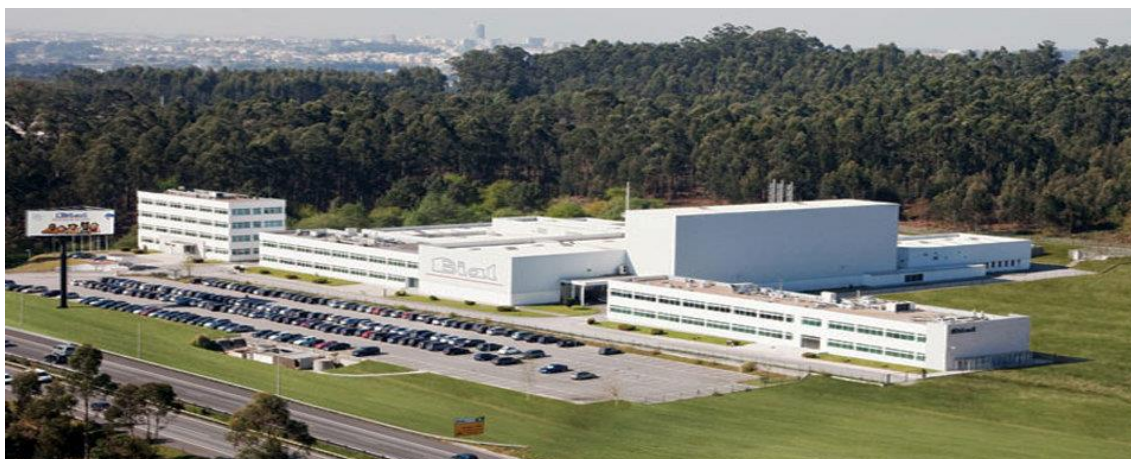
Figura 9 - Instalações dos laboratórios da BIAL
