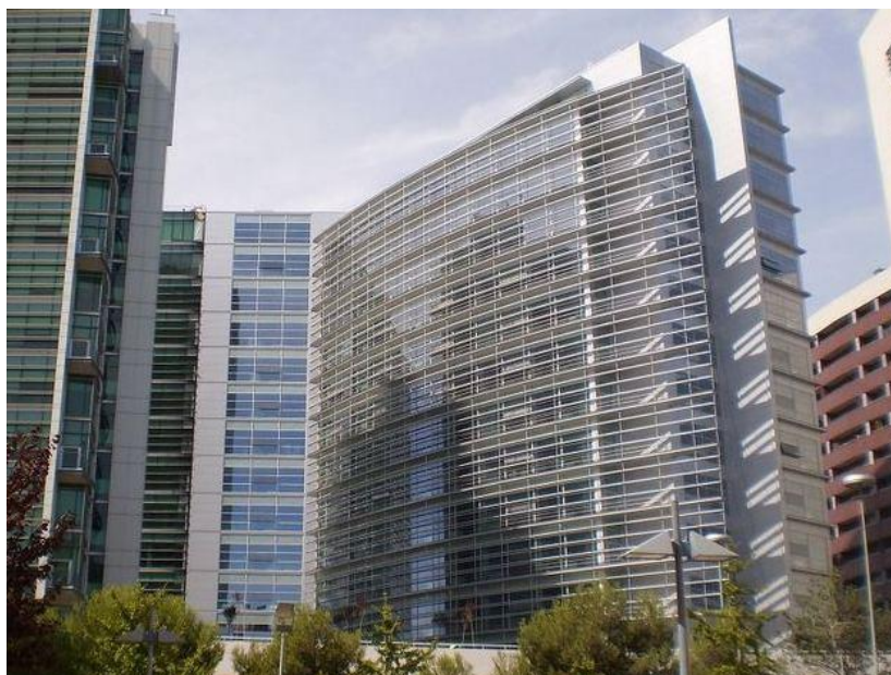
Figura 7 - Edifício báltico - Parque das nações
