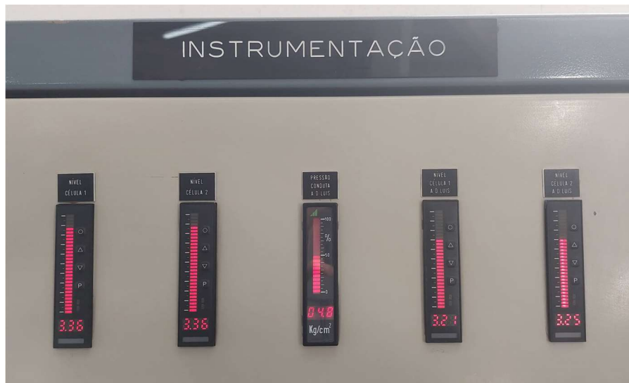
Figura 126 – Indicadores de nível e de pressão (Res. Madeiras 22AGO2023 10h36m)
