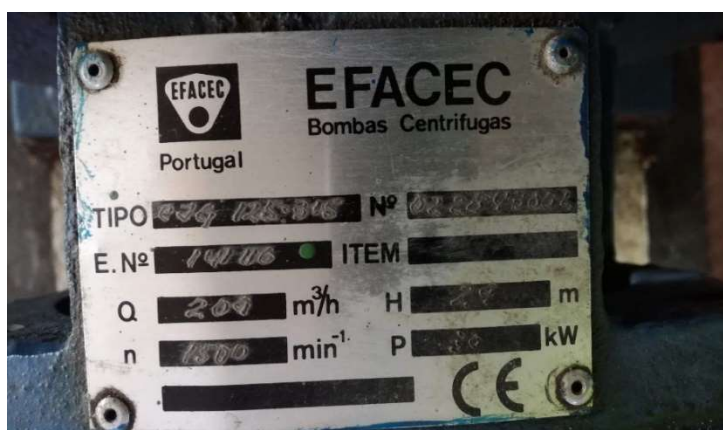
Figura 111 – Chapa de características da bomba do grupo 2 de elevação para Soudos da EE Curvaceiras
