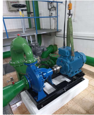
Figura 75 - Processo de alinhamento
