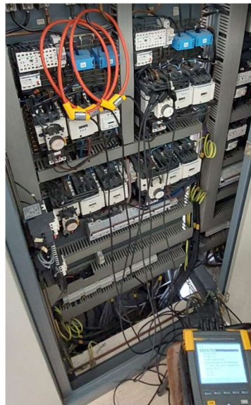
Figura 99 – Sensores de corrente, sensores de pressão e analisador de energia Fluke 438 II
