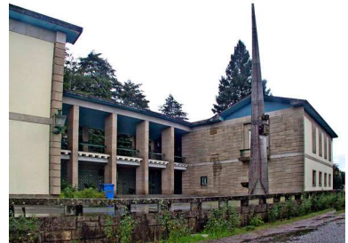
Amarante (Penafiel / Porto) Arq. Januário Godinho de Almeida Inaugurado em 12/04/1964 Cobertura inclinada
