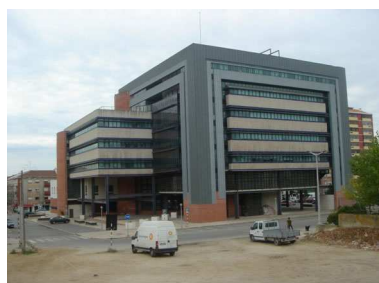
Barreiro (Barreiro / Lisboa) Arq. Jorge Silva 17/01/2000 Cobertura plana
