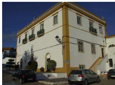
Avis (Portalegre / Évora) Edifício Adaptado
