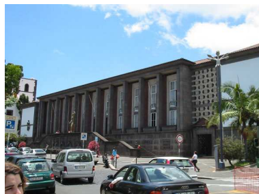
Funchal (Funchal / Lisboa) Arq. Januário Godinho de Almeida Inaugurado em 17/07/1962 Cobertura inclinada
