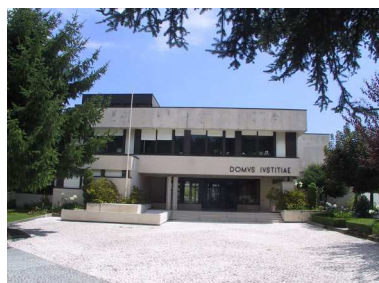
Baião (Penafiel / Porto) Arq. Agostinho Ricca Inaugurado em 07/09/1991 Cobertura inclinada
