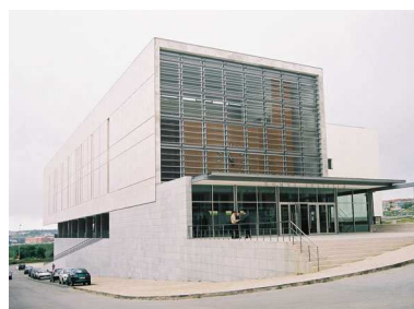
Almada (Almada / Lisboa) Arq. Paulo Cirne Concluído em 05/11/2003 Cobertura plana
