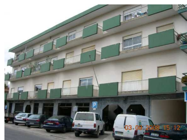
Ferreira do Zêzere (Tomar / Coimbra) Edifício adaptado
