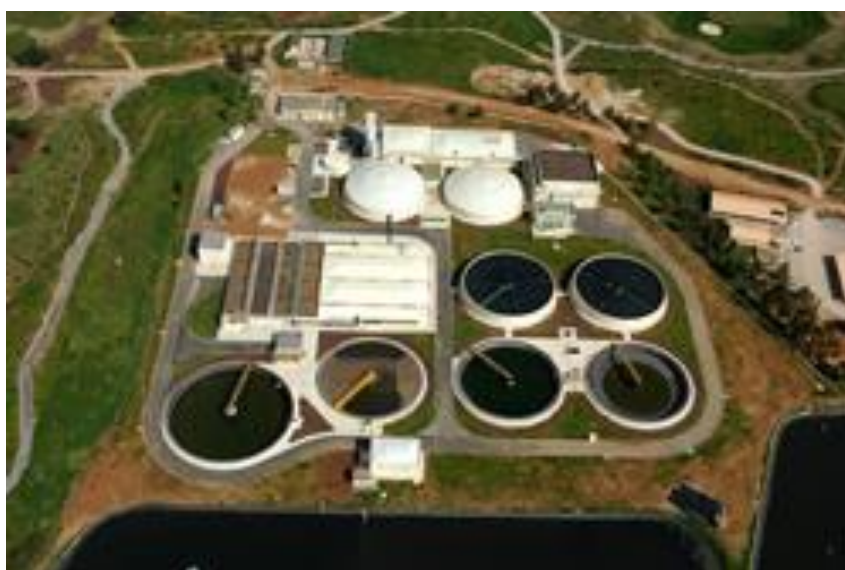
Figura 2.16 – ETAR de Vilamoura com caudal máximo previsto para futura reutilização para rega de campo de golfe e espaços públicos de 12 500 m 3 /dia. (fonte: Águas do Algarve, 2013).
