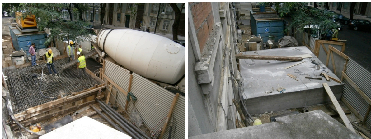
Fig. 3.24 | Betonagem(a) Sapata para base da grua concluída (b)
