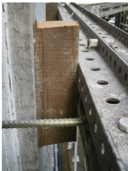
Fig. 3.33 | Barrotos para evitar o contato com a parede de fachada
