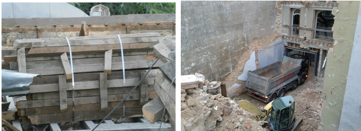
Fig. 3.50 | armazenamento de vigas de madeira (a) remoção de entulho (b)
