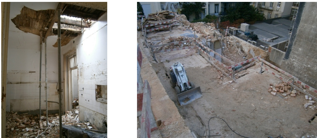
Fig. 3.44 | escoramento do pavimento (a) delimitação do perímetro de trabalho (b)
