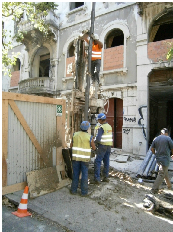
Fig. 3.16 | Colocação das microestacas
