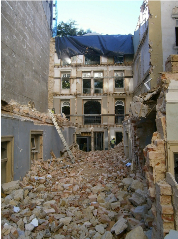
II. DEMOLIÇÕES NO Nº4 PRATICAMENTE CONCLUÍDAS
