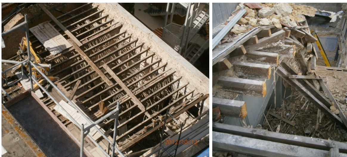
Fig. 3.48 | Vigas de cobertura do edifício N°4 (a) vigas serradas (b)
