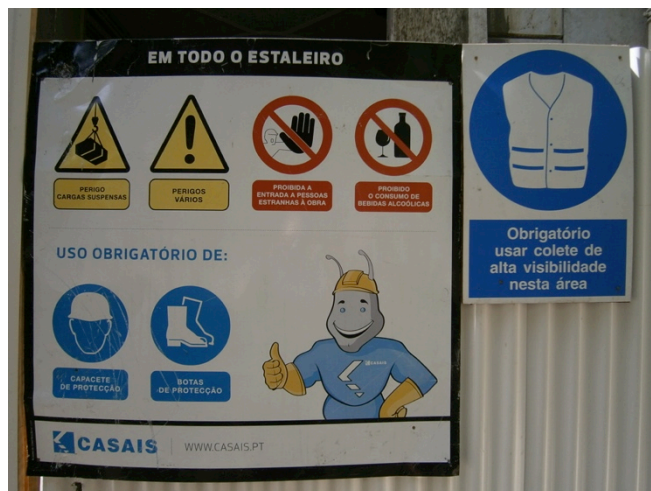
Fig. 3.3 | Cumprimento de regras de segurança dentro do estaleiro
