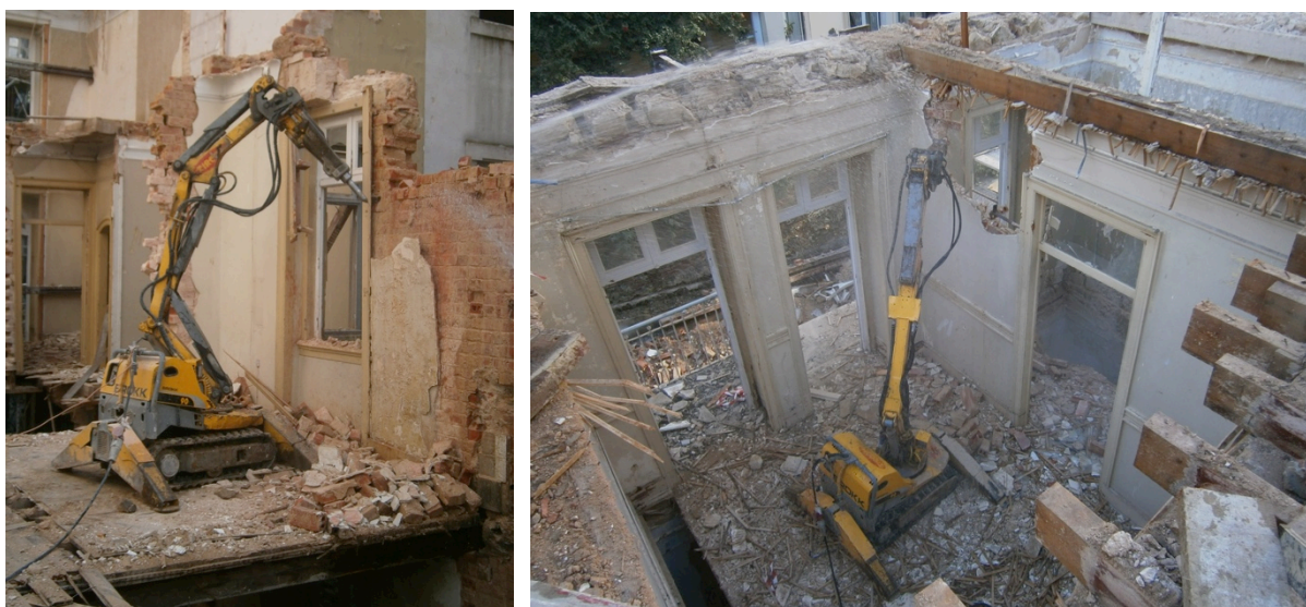
Fig. 3.49 | Destruição das paredes com “mini” giratória
