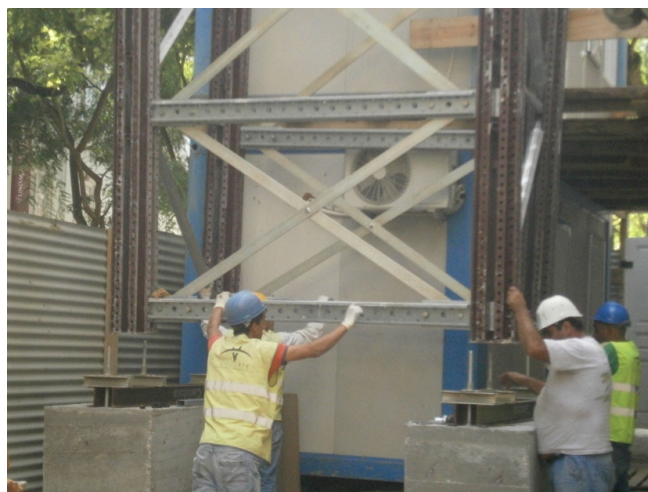
Fig. 3.31 | Colocação da primeira secção do pórtico
