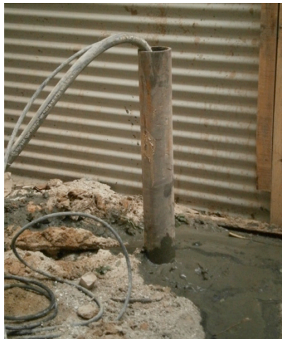
Fig. 3.18 | Injeção da calda de cimento
