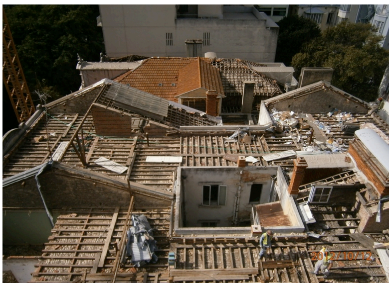
Fig. 3.45 | Início dos trabalhos de demolição
