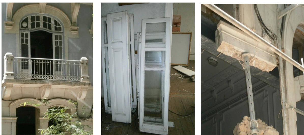
Fig. 3.46 | Portadas de madeira a preservar (a) e (b) remoção de padieiras de cantaria (c)
