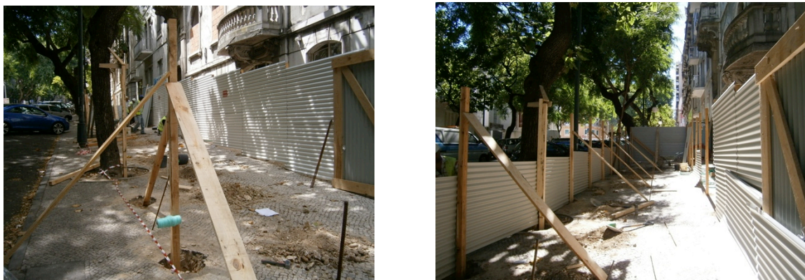
Fig. 3.2 | Colocação dos prumos (a) colocação das chapas (b)
