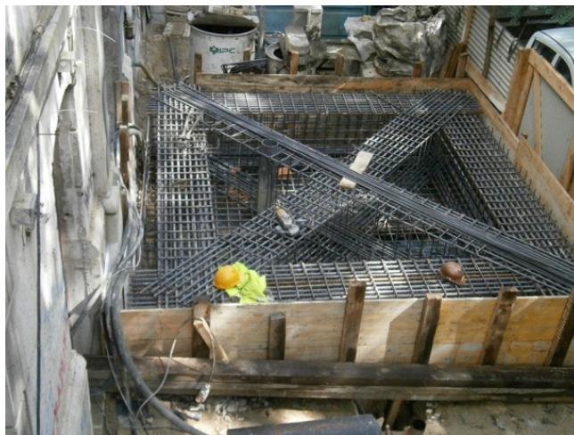
Fig. 3.23 | Armaduras colocadas para a base da grua
