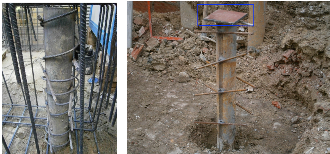
Fig. 3.28 | Microestaca com as hélice soldada (a) Chapa para distribuição de tensões (b)
