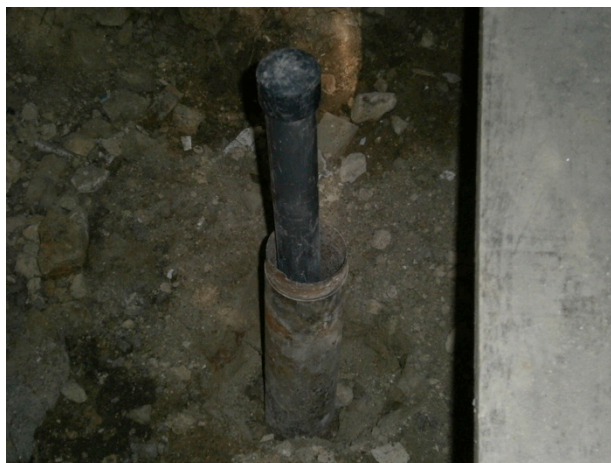
Fig. 3.9 | Furo de sondagem onde foi instalado 1 piezómetro
