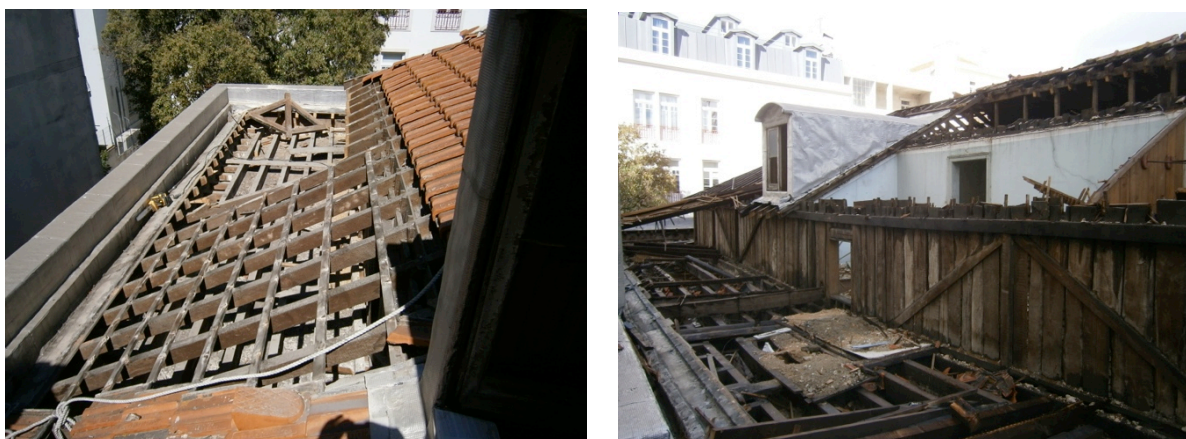
Fig. 3.47 | Remoção da cobertura (a) estrutura de madeira (b)
