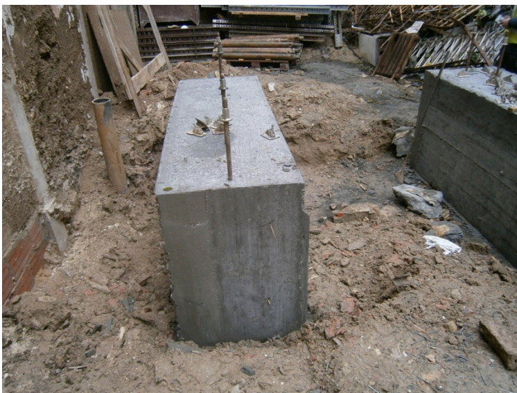
III. MACIÇOS DE TARDOZ CONCLUÍDOS
