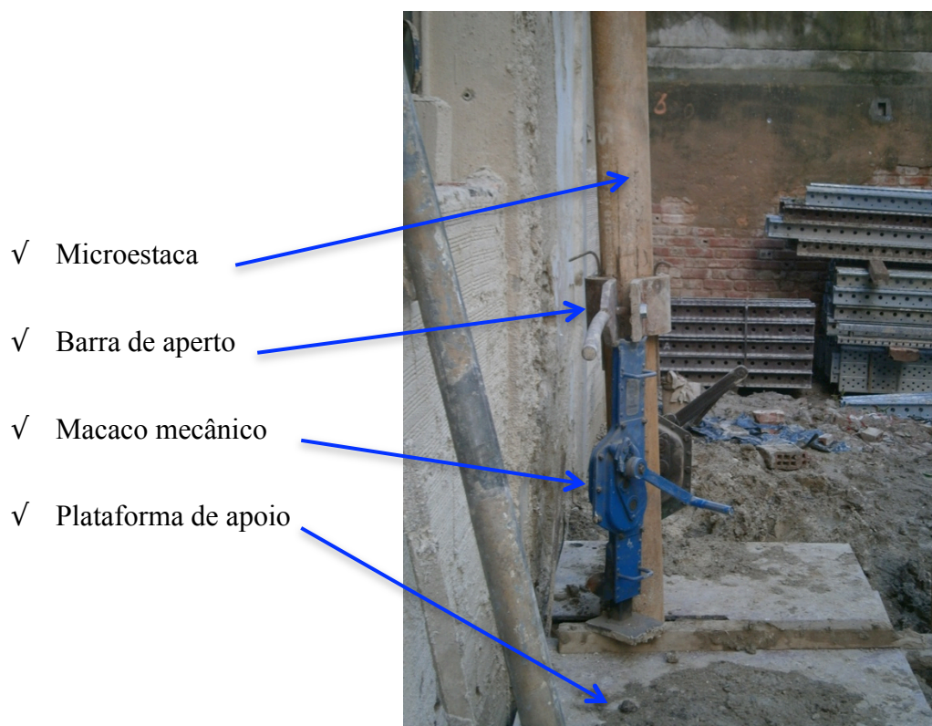
Fig. 3.20 | Macaco mecânico para remoção da microestaca
