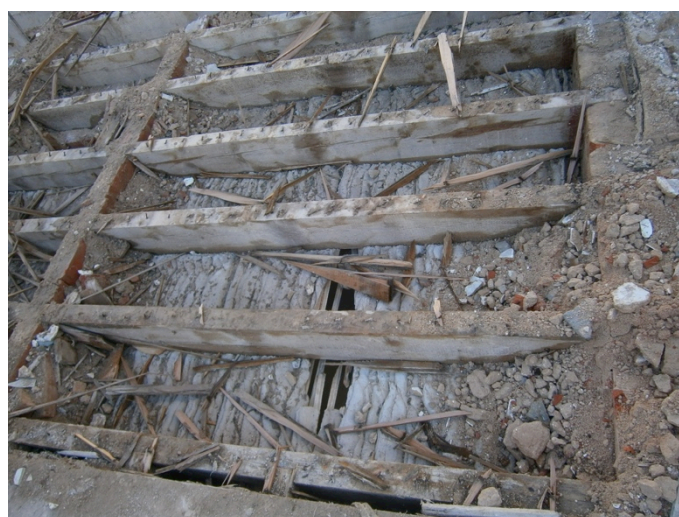
Fig. 3.41 | Vigas em madeira
