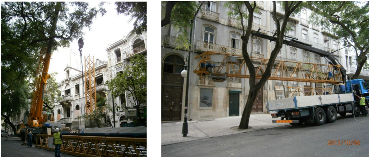
Fig. 3.25 | Grua telescópica (a) Camião com grua (b)
